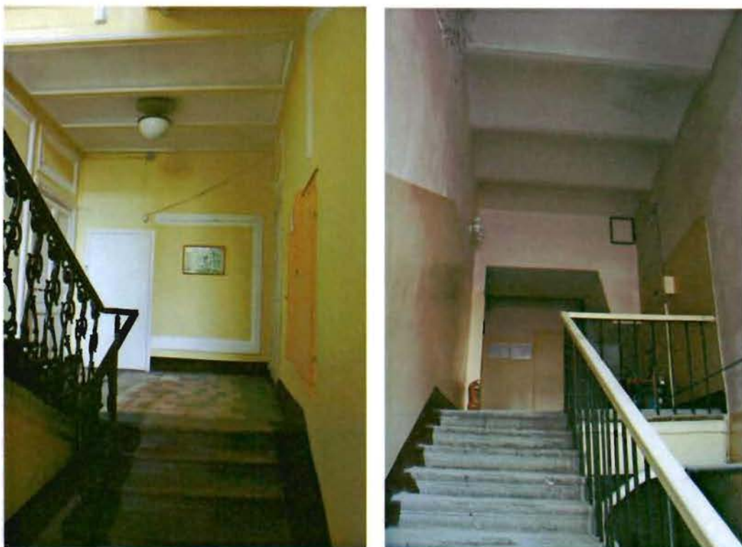
Фото №6, 7. Лестничные марши.
