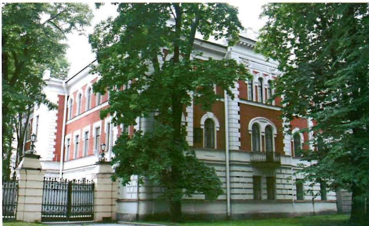
Фото №1. Вид со стороны Московского проспекта.
