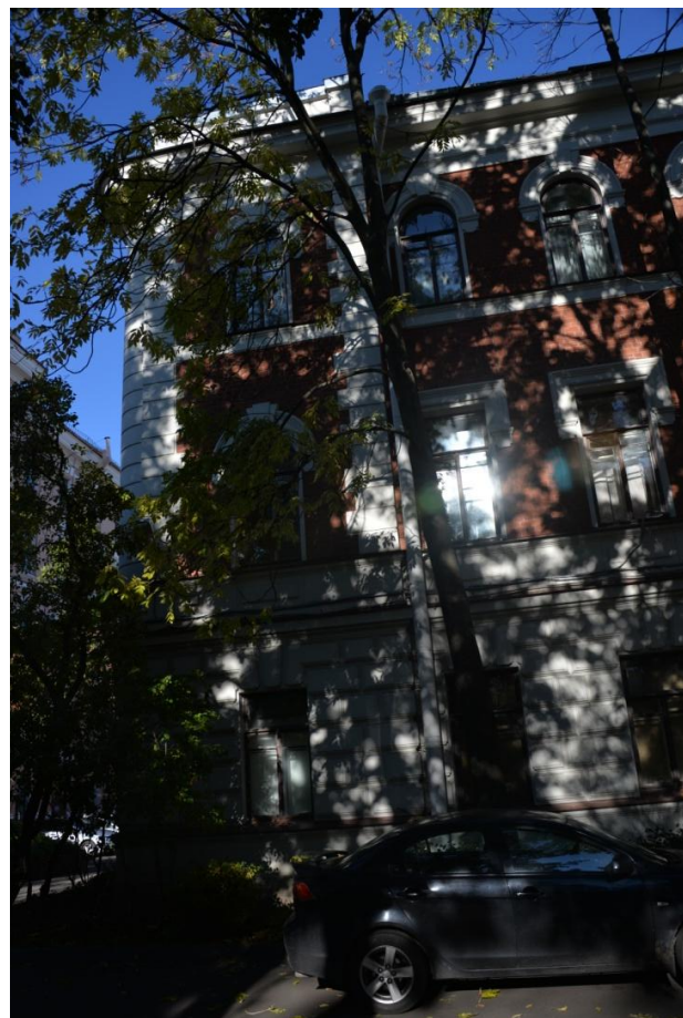
4. Фрагмент южного фасада объекта культурного наследия федерального значения «Жилой дом палаты мер и весов. Здесь в 1897-1907 гг. жил и работал химик Менделеев Д.И.»
