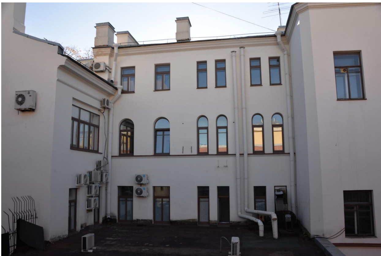
9. Фрагмент северного фасада объекта культурного наследия федерального значения «Жилой дом палаты мер и весов. Здесь в 1897-1907 гг. жил и работал химик Менделеев Д.И.»
