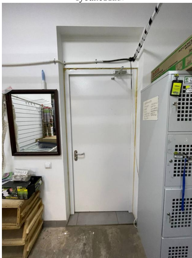
Фото 26. Интерьер пом. 5-Н выявленного объекта культурного наследия «Дом В.Г. и О.М. Чубаковых»
