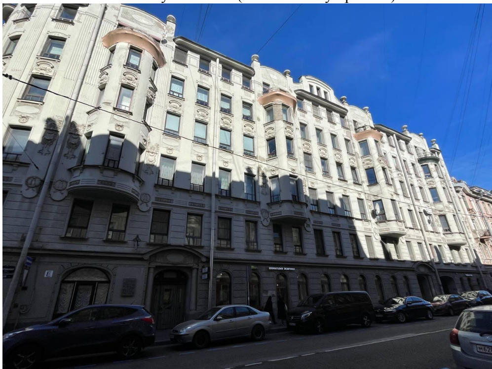
Фото 2. Фрагмент лицевого фасада выявленного объекта культурного наследия «Дом В.Г. и О.М. Чубаковых» (по Большому пр. П.С.)
