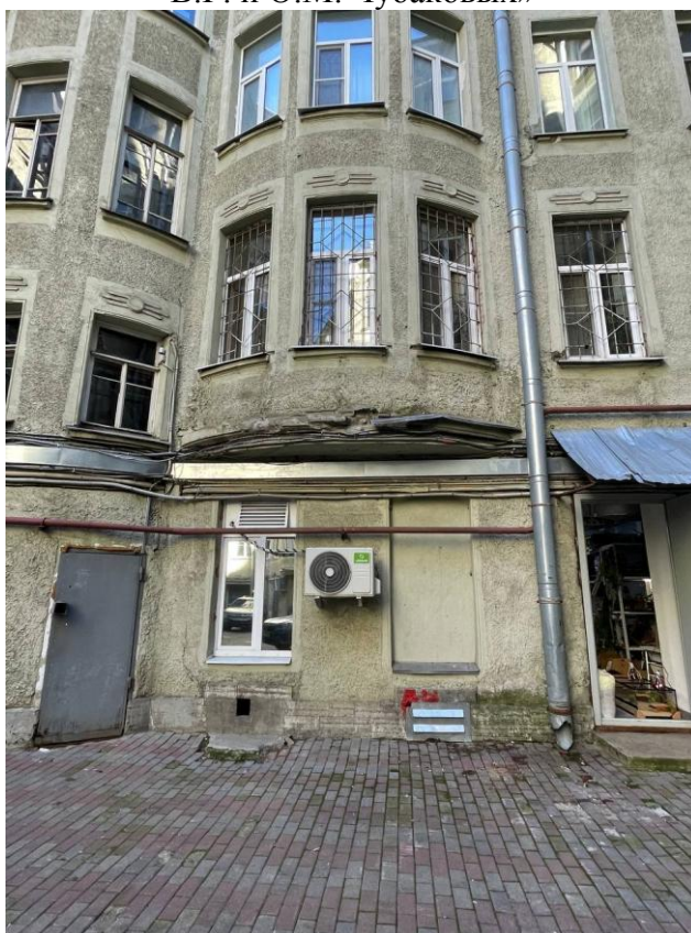
Фото 4. Фрагмент дворового фасада выявленного объекта культурного наследия «Дом В.Г. и О.М. Чубаковых»
