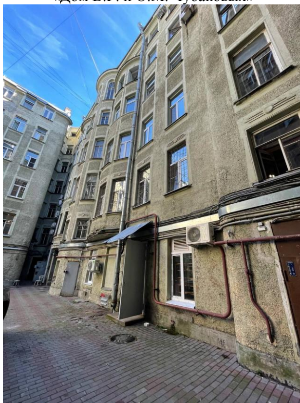
Фото 6. Фрагмент дворового фасада выявленного объекта культурного наследия «Дом В.Г. и О.М. Чубаковых»
