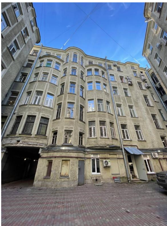
Фото 3. Фрагмент дворового фасада выявленного объекта культурного наследия «Дом В.Г. и О.М. Чубаковых»
