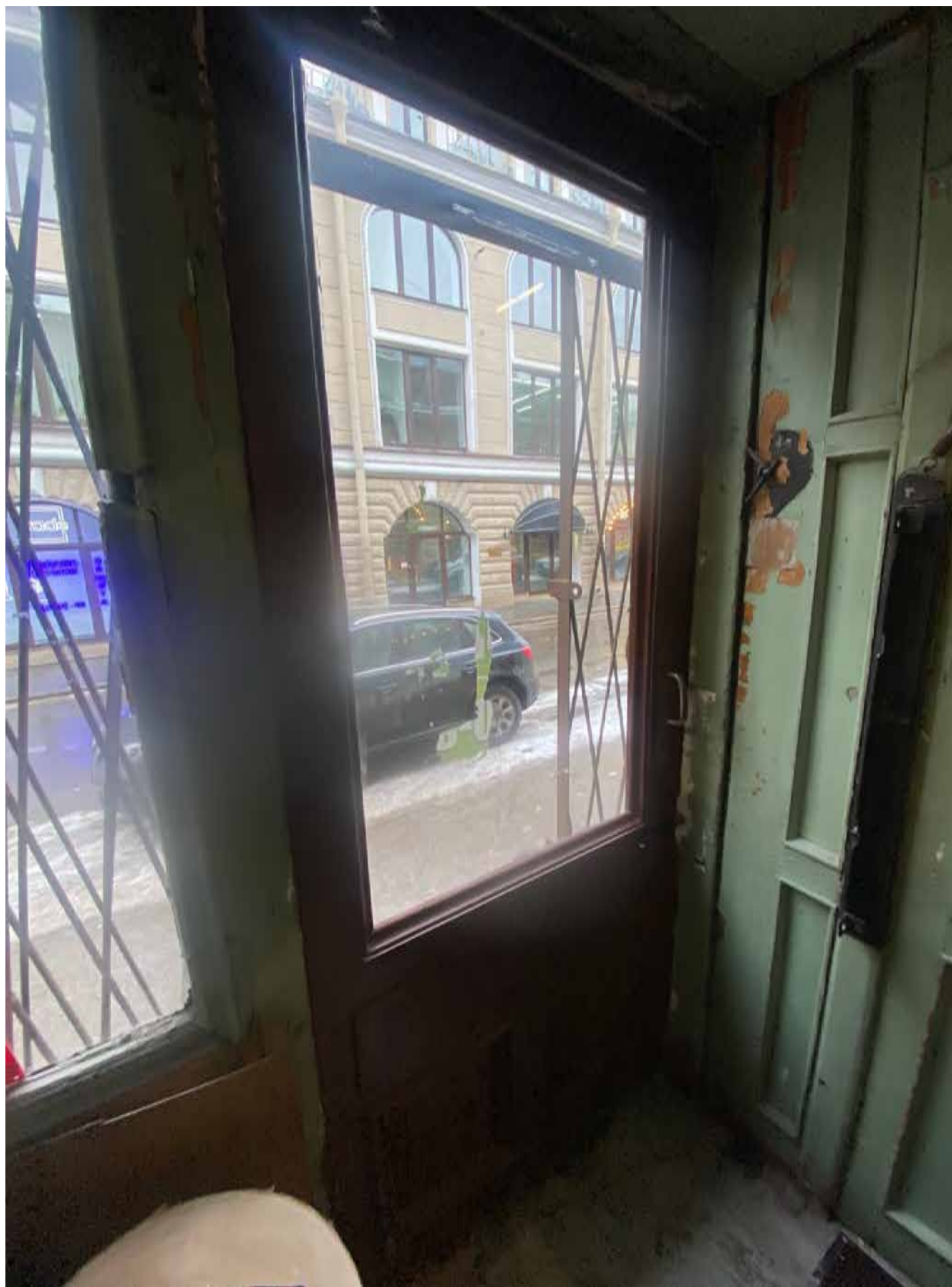
3. Вид на входную дверь в помещение;
