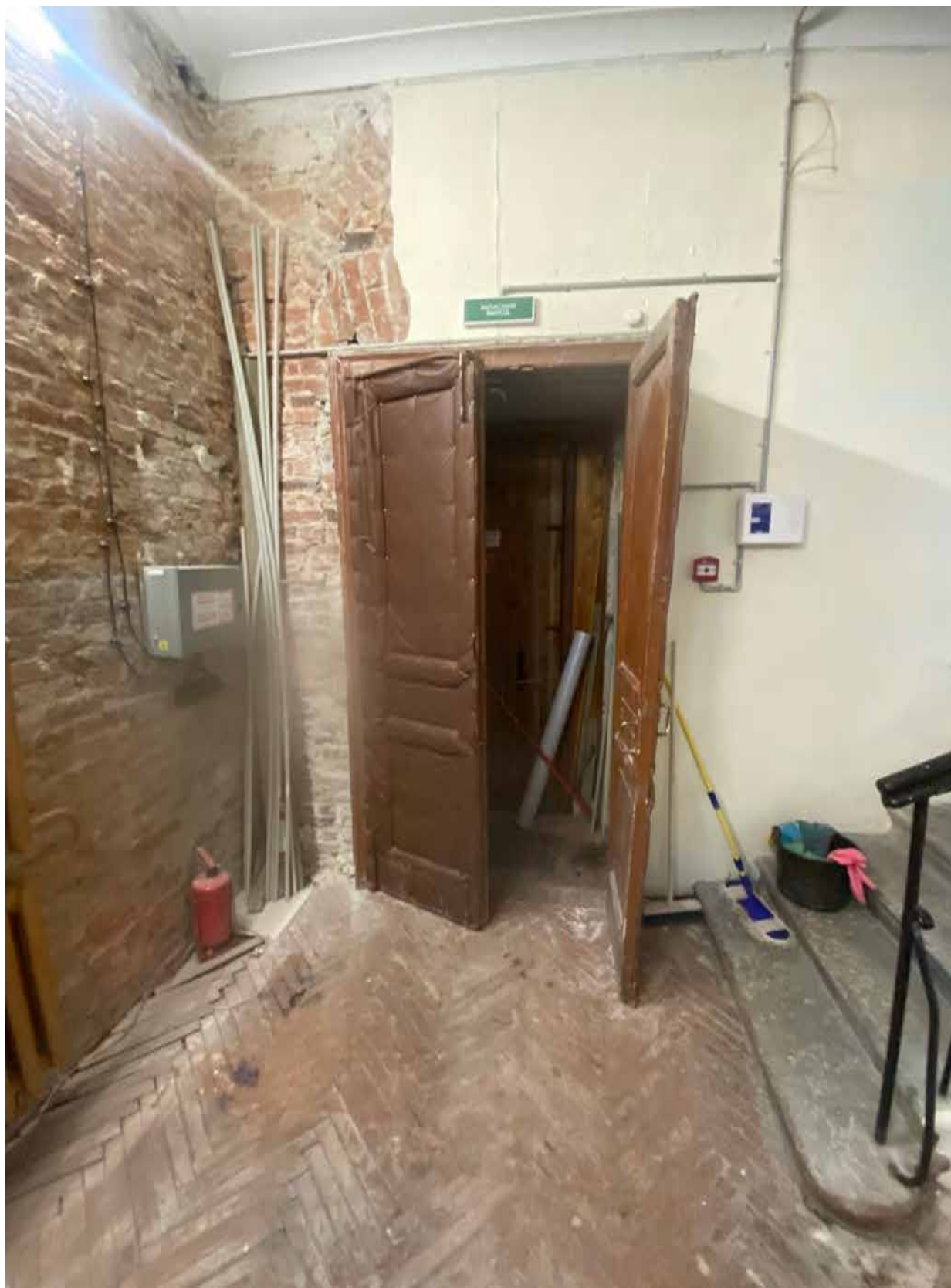
10. Вид на входную дверь в помещение 17-Н;
