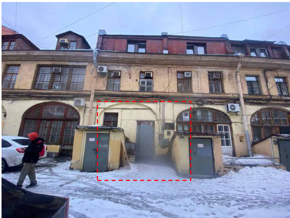
2. Вид на дворовой фасад объекта культурного наследия «Железо-Красочные ряды», входящего в состав объекта культурного наследия «Малый Гостиный Двор», расположенного по адресу: Санкт-Петербург, Банковский переулок, дом 3, литера Б (Санкт-Петербург, Банковский переулок 3; Москательный переулок, 2-4);
