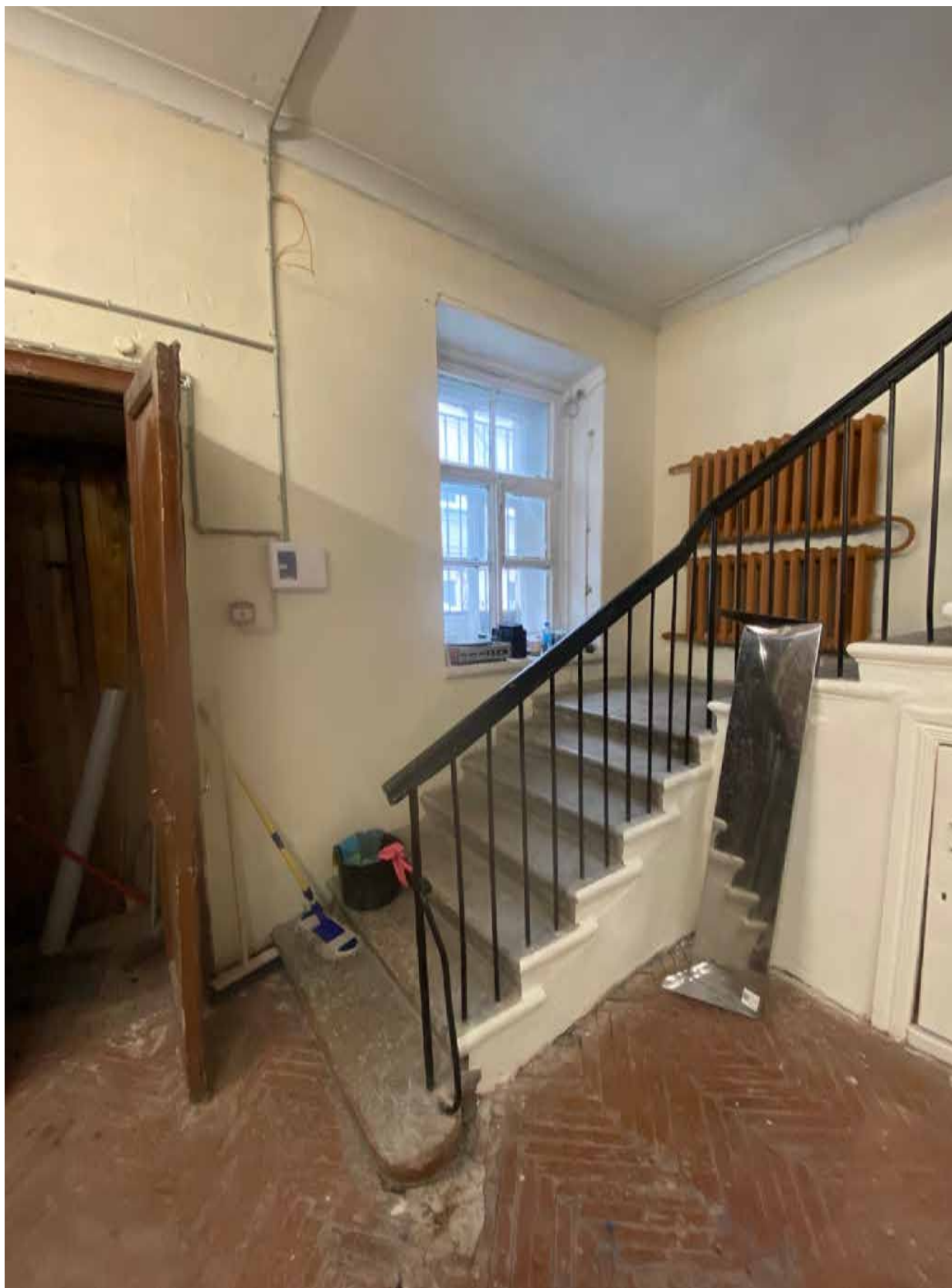
11.Фрагмент интерьера кабинета (помещение 3/37.4);
