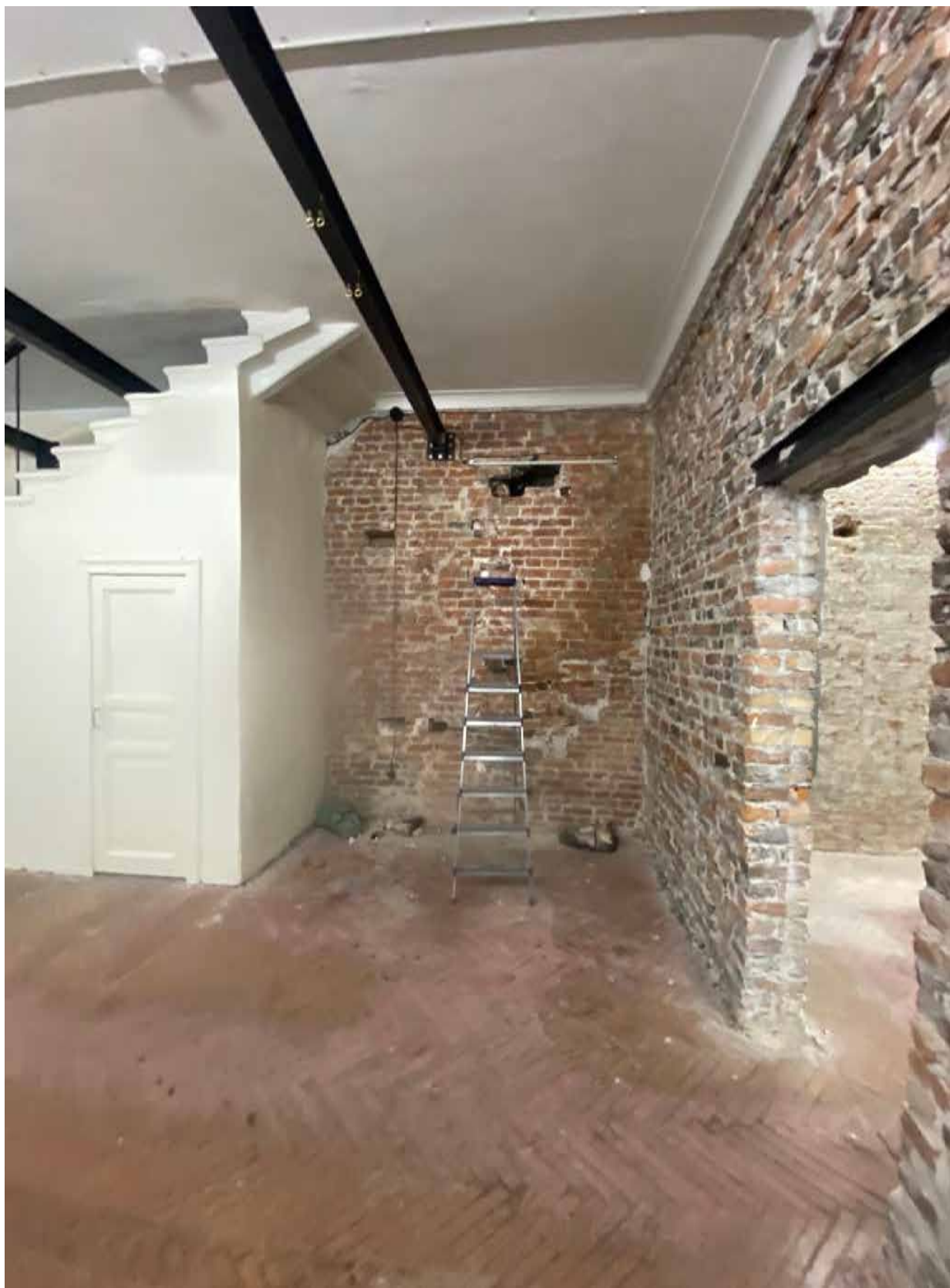
9. Фрагмент интерьера кабинета (помещение 3/37.4);
