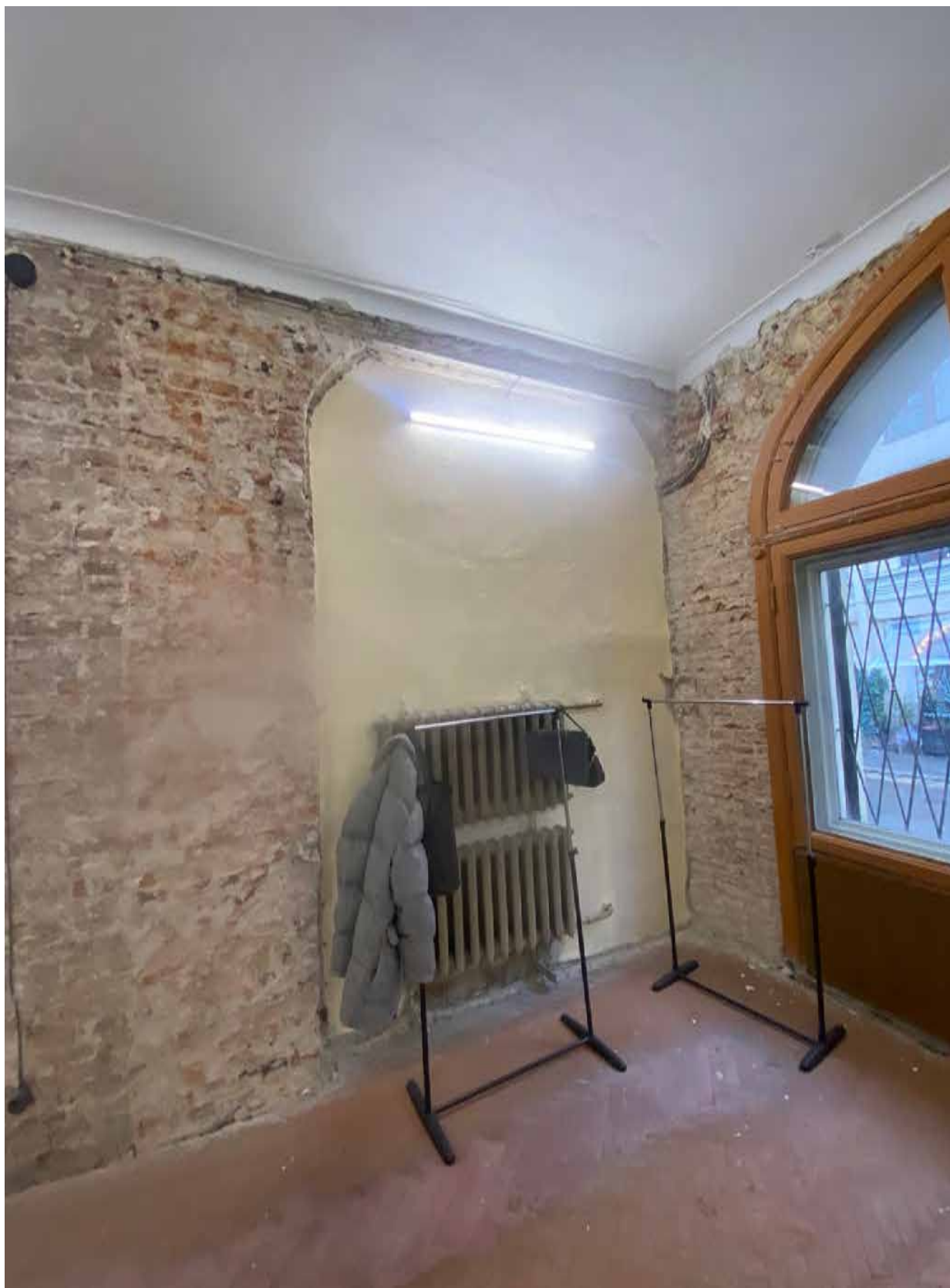
7. Фрагмент интерьера торгового зала (помещение 2/29.1);
