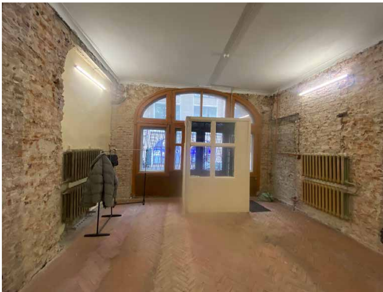
6. Фрагмент интерьера торгового зала (помещение 2/29.1);
