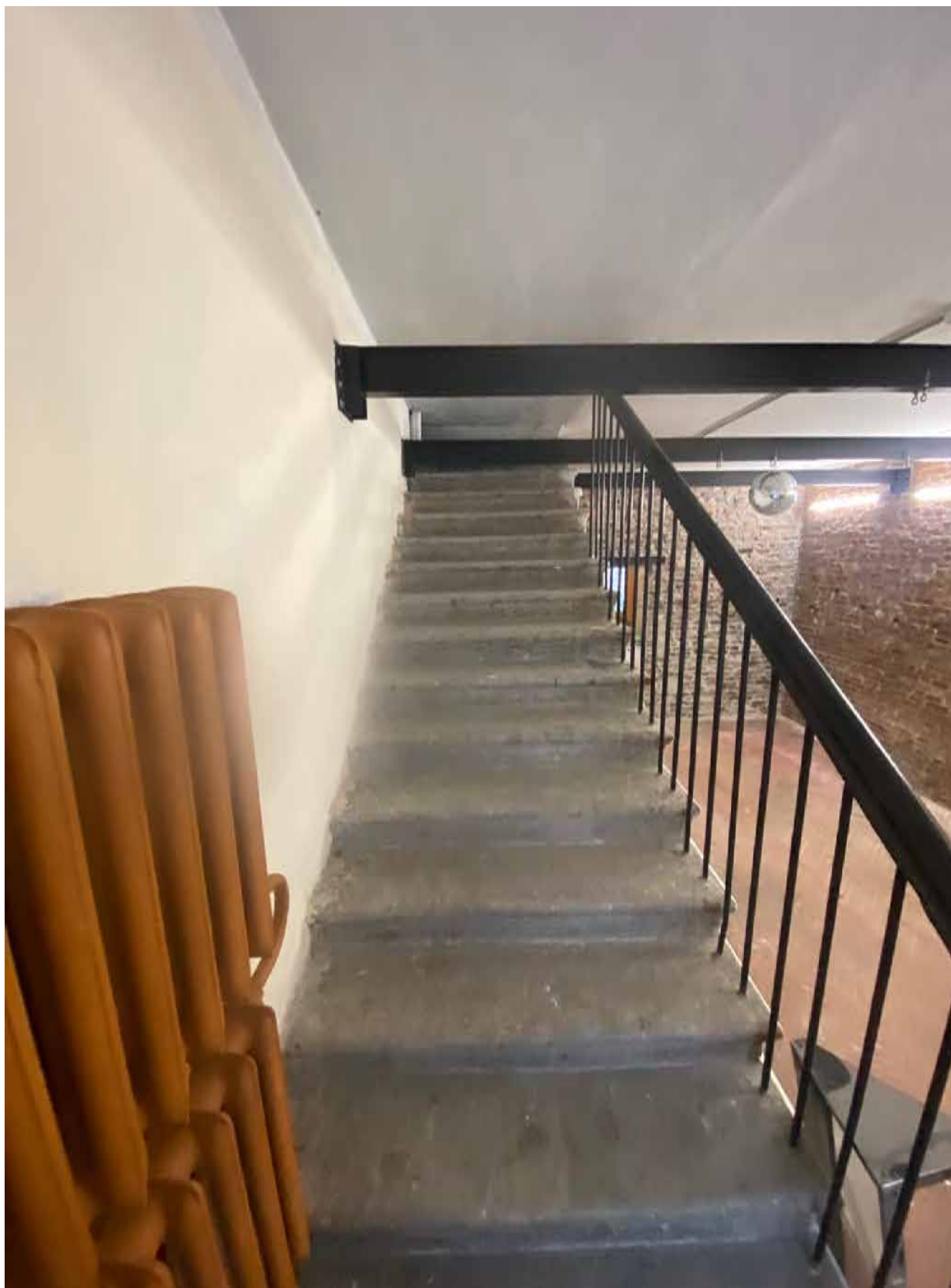
13. Вид на лестницу;
