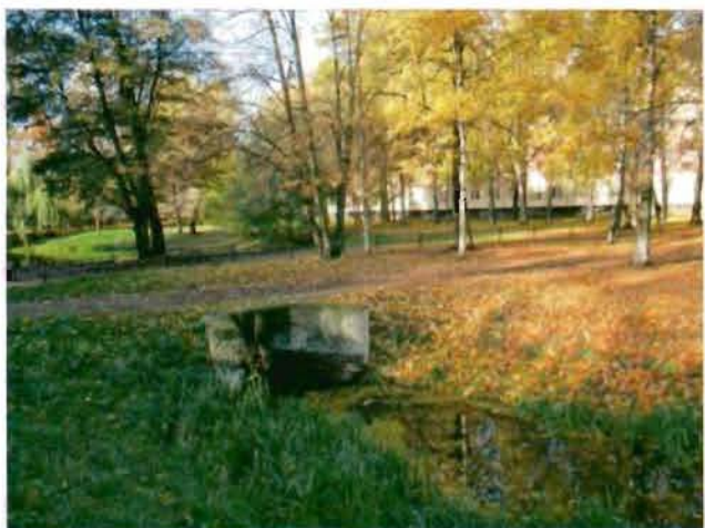
9. Оголовок водовыпуска под пешеходной дорожкой в западной части круглого пруда
