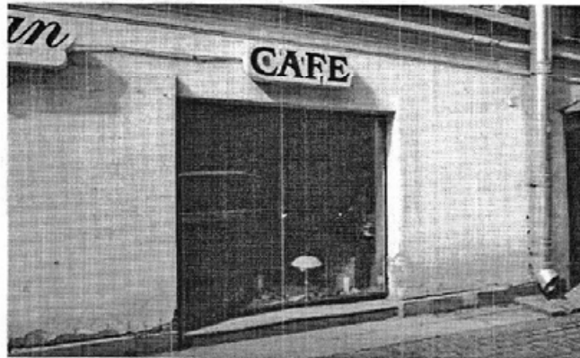
Фрагменты цокольного этажа лицевого фасада. Съемка 24.04.2012г. К.С. Евтеев
