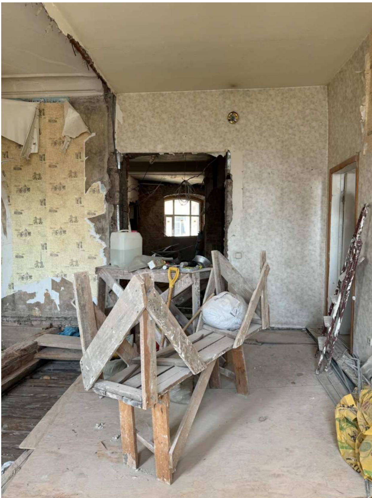
Фото 27. Вид на помещение квартиры № 81 объекта культурного наследия.
