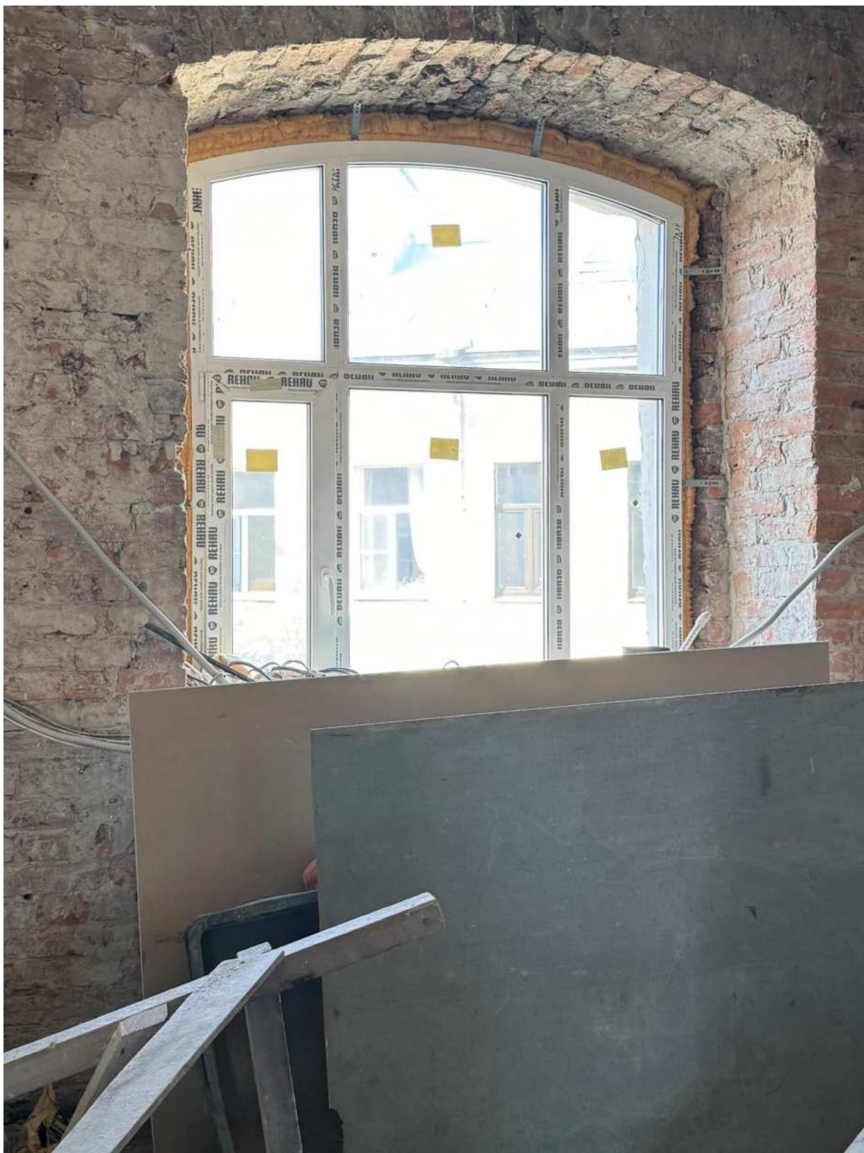
Фото 14. Вид на оконное заполнение квартиры № 81 объекта культурного наследия.
