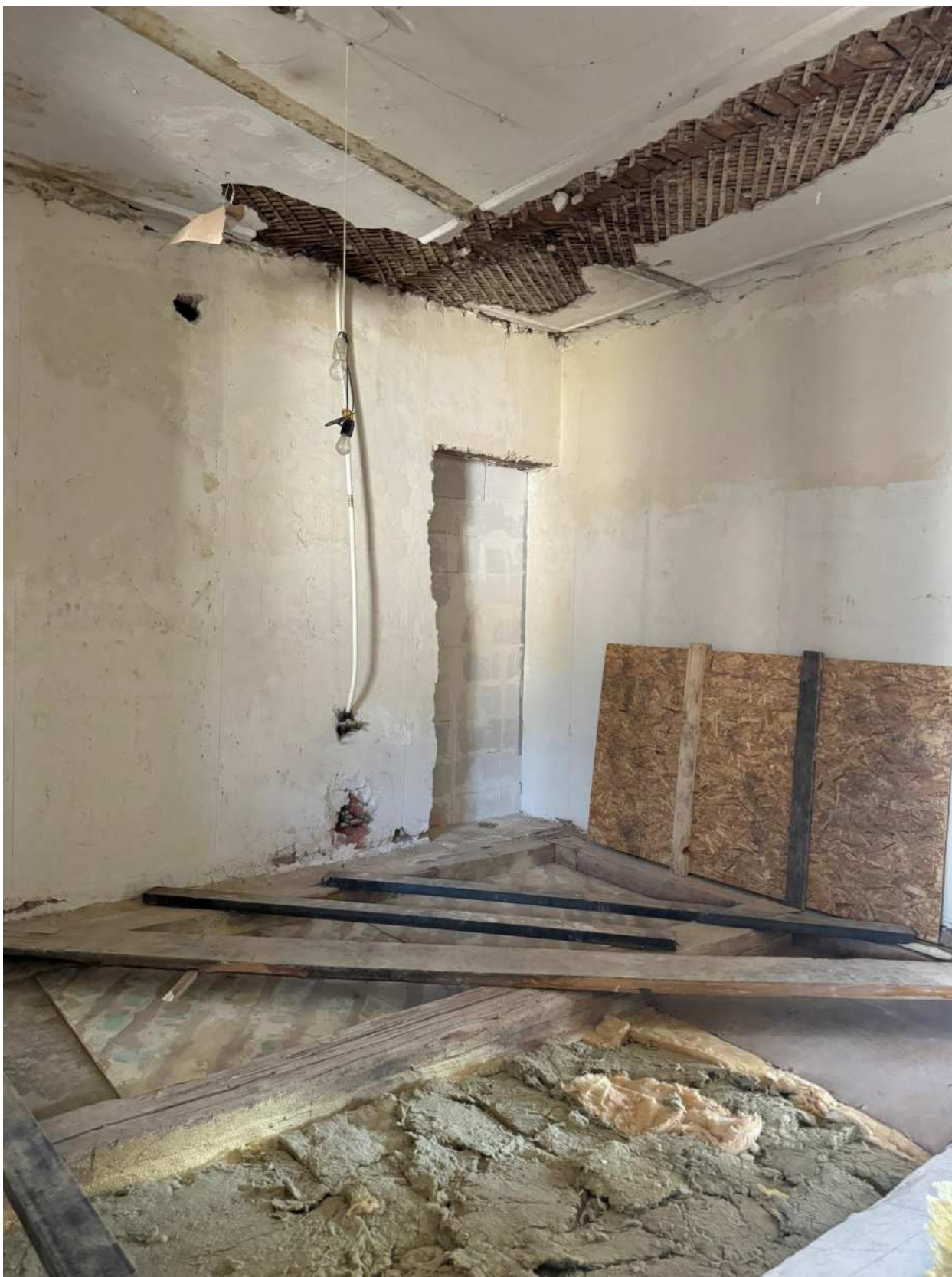
Фото 17. Вид на помещение квартиры № 81 объекта культурного наследия.
