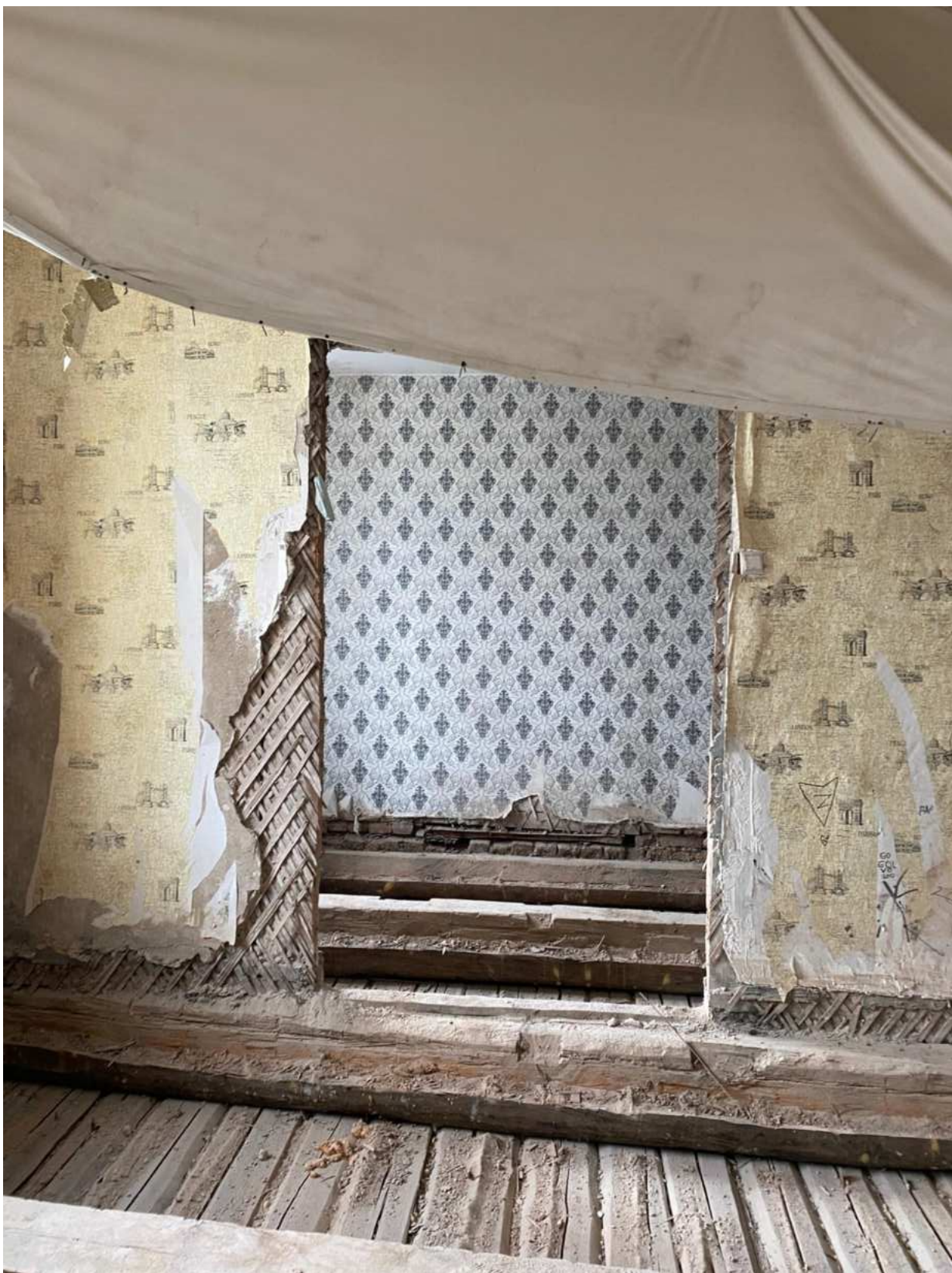
Фото 28. Вид на помещение квартиры № 81 объекта культурного наследия.
