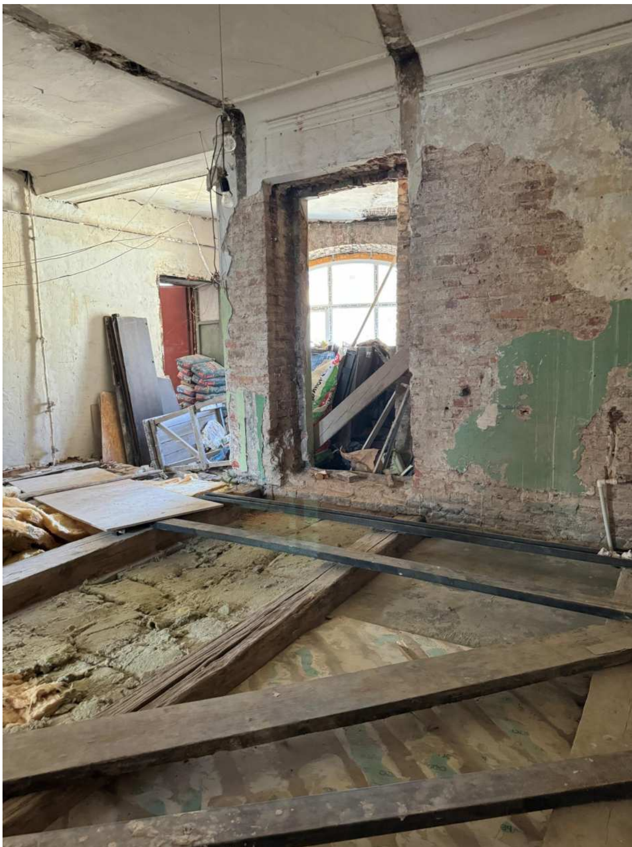
Фото 32. Вид на помещение квартиры № 81 объекта культурного наследия.
