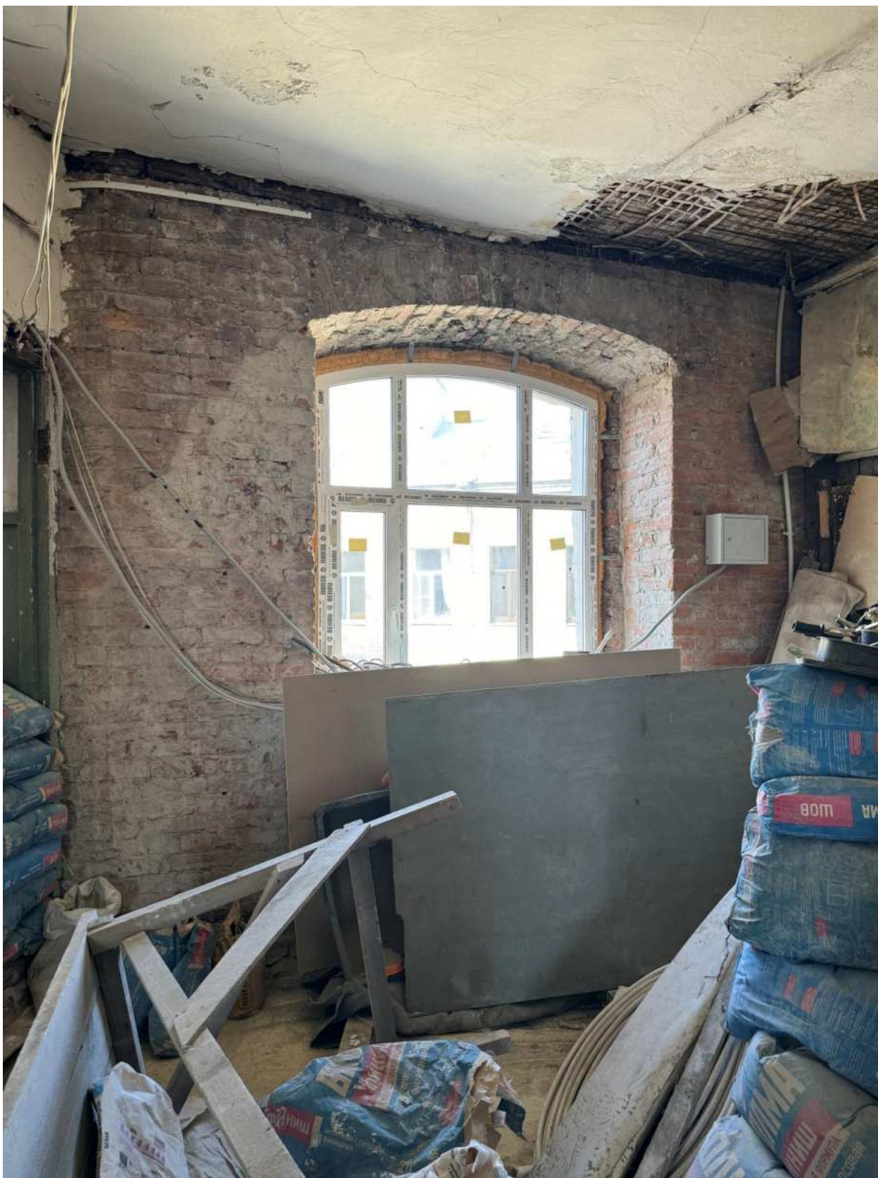
Фото 20. Вид на помещение квартиры № 81 объекта культурного наследия.
