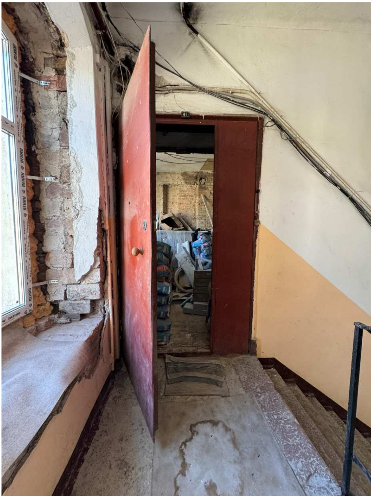
Фото 12. Входное дверное заполнение, ведущее в квартиру № 81, объекта культурного наследия.
