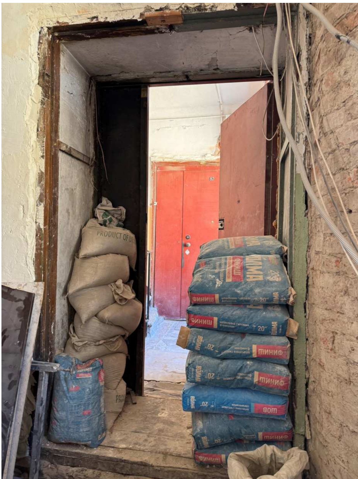
Фото 15. Вид на дверное заполнение квартиры № 81 объекта культурного наследия.
