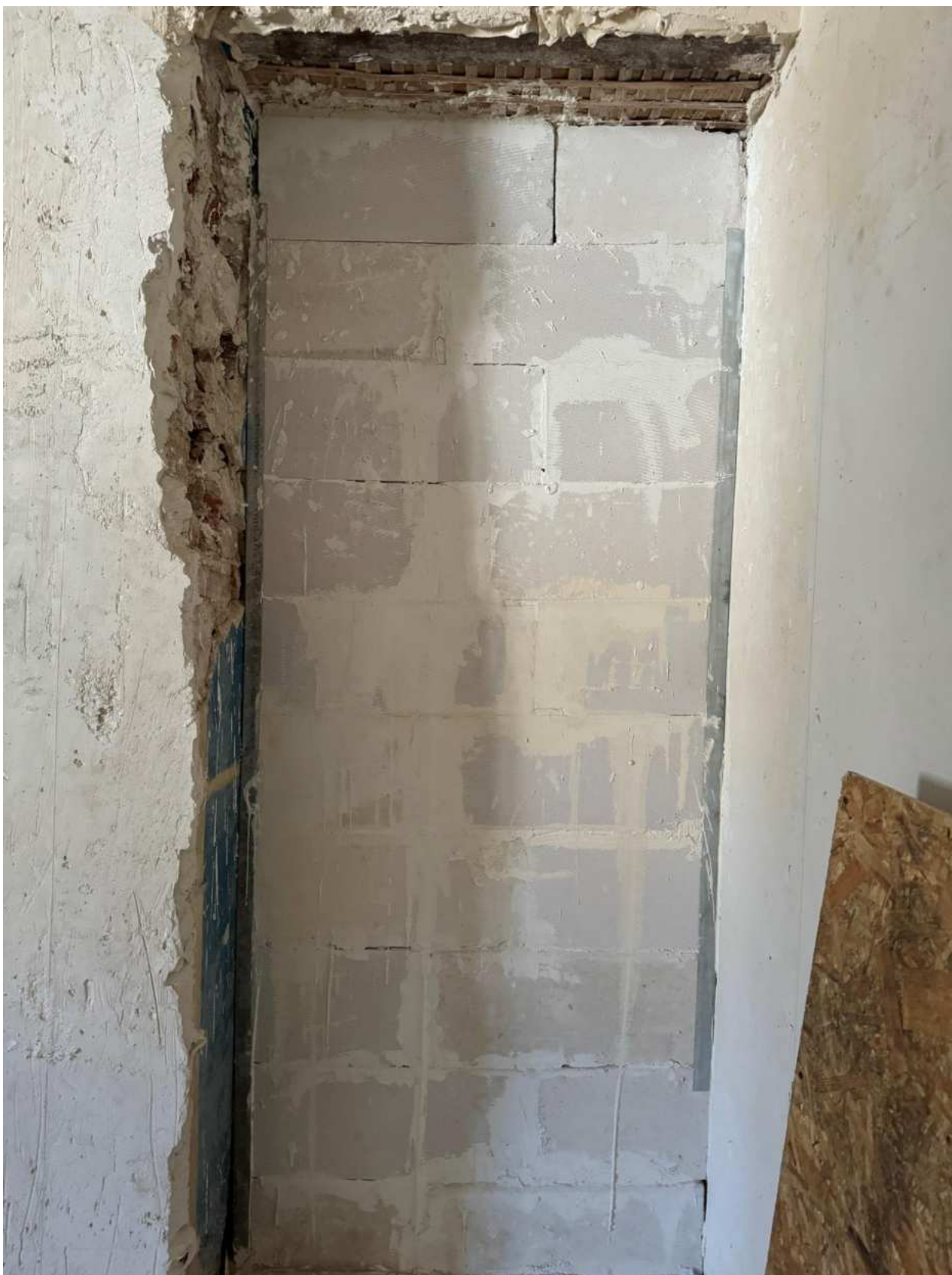
Фото 31. Вид на помещение квартиры № 81 объекта культурного наследия.
