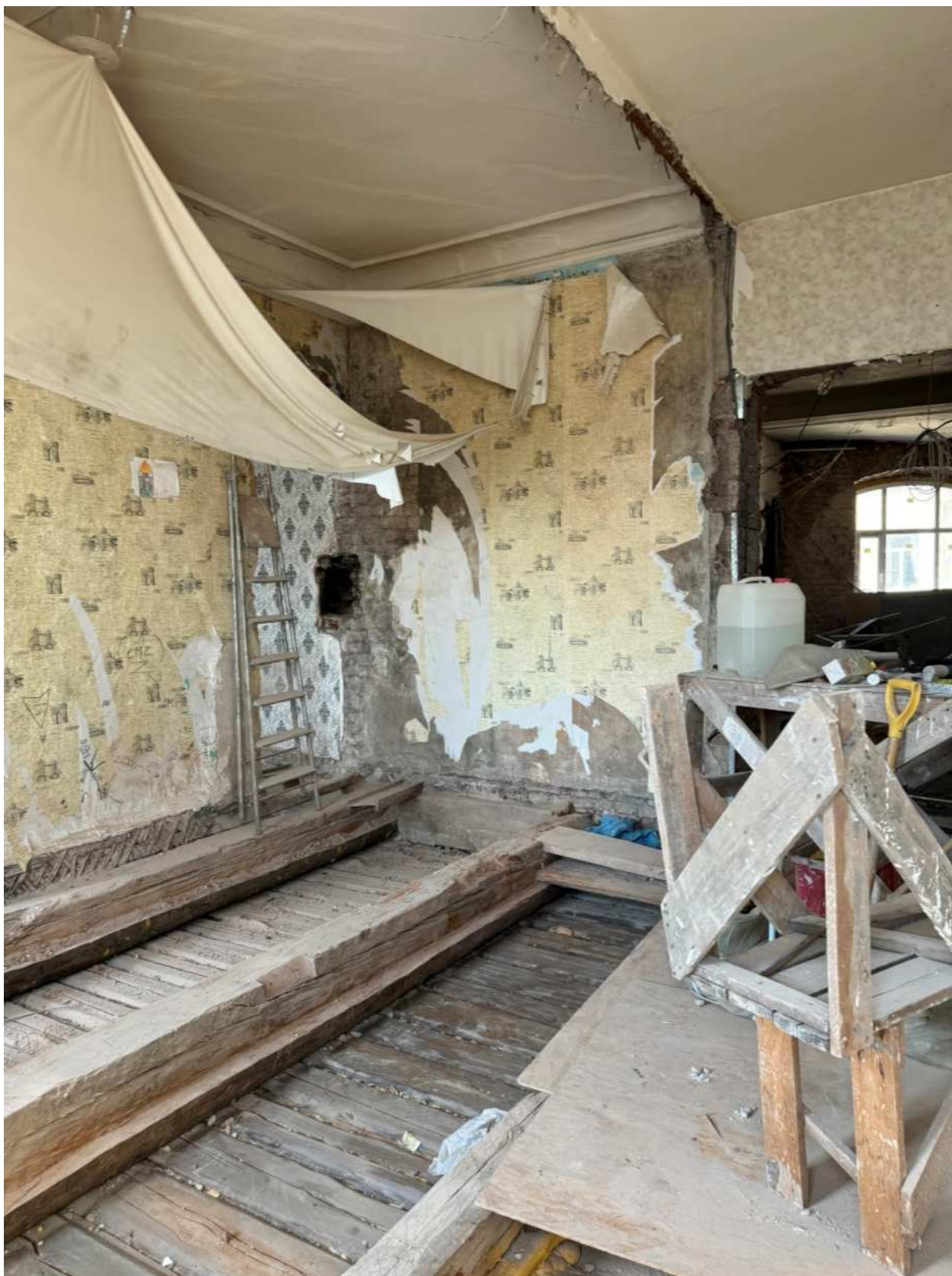
Фото 26. Вид на помещение квартиры № 81 объекта культурного наследия.
