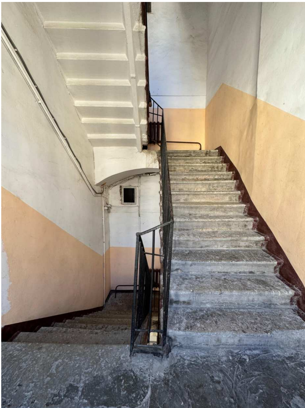
Фото 11. Общий вид лестницы, ведущей в квартиру № 81, объекта культурного наследия.
