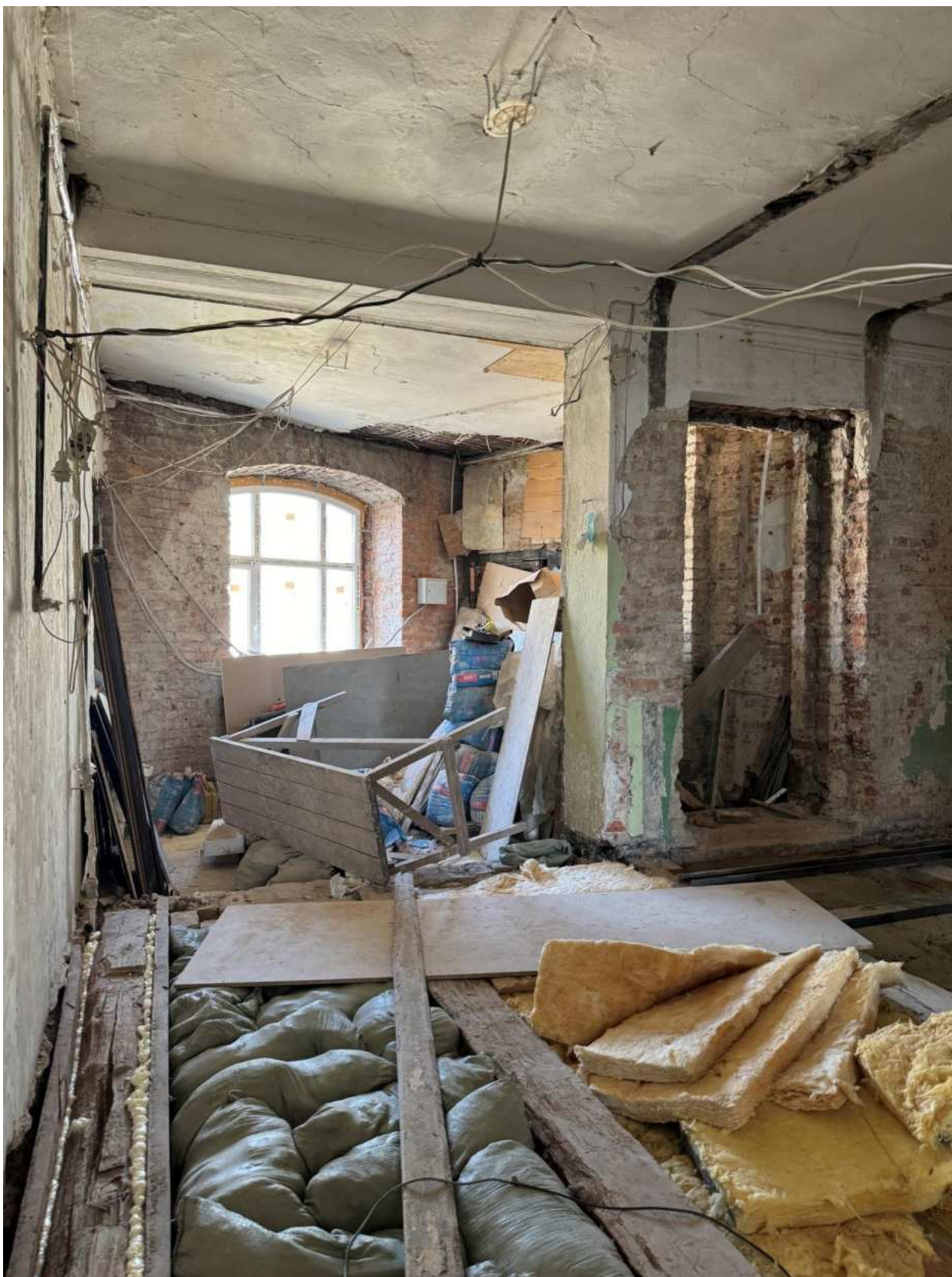
Фото 35. Вид на помещение квартиры № 81 объекта культурного наследия.
