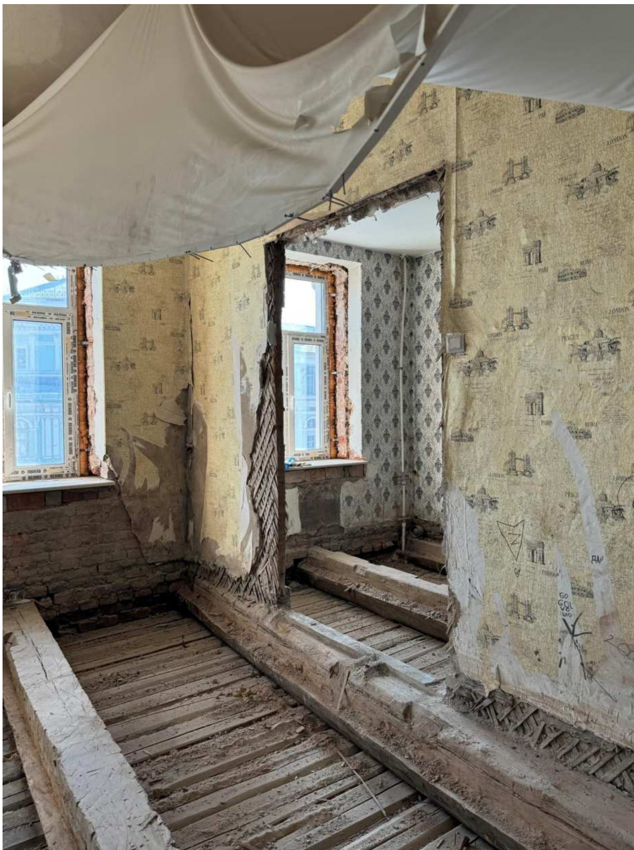
Фото 24. Вид на помещение квартиры № 81 объекта культурного наследия.
