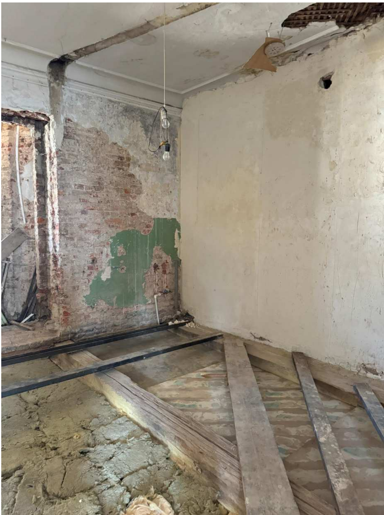
Фото 36. Вид на помещение квартиры № 81 объекта культурного наследия.
