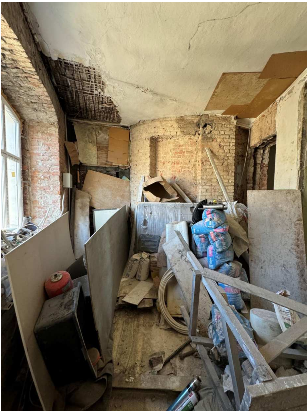
Фото 13. Вид на помещение квартиры № 81 объекта культурного наследия.
