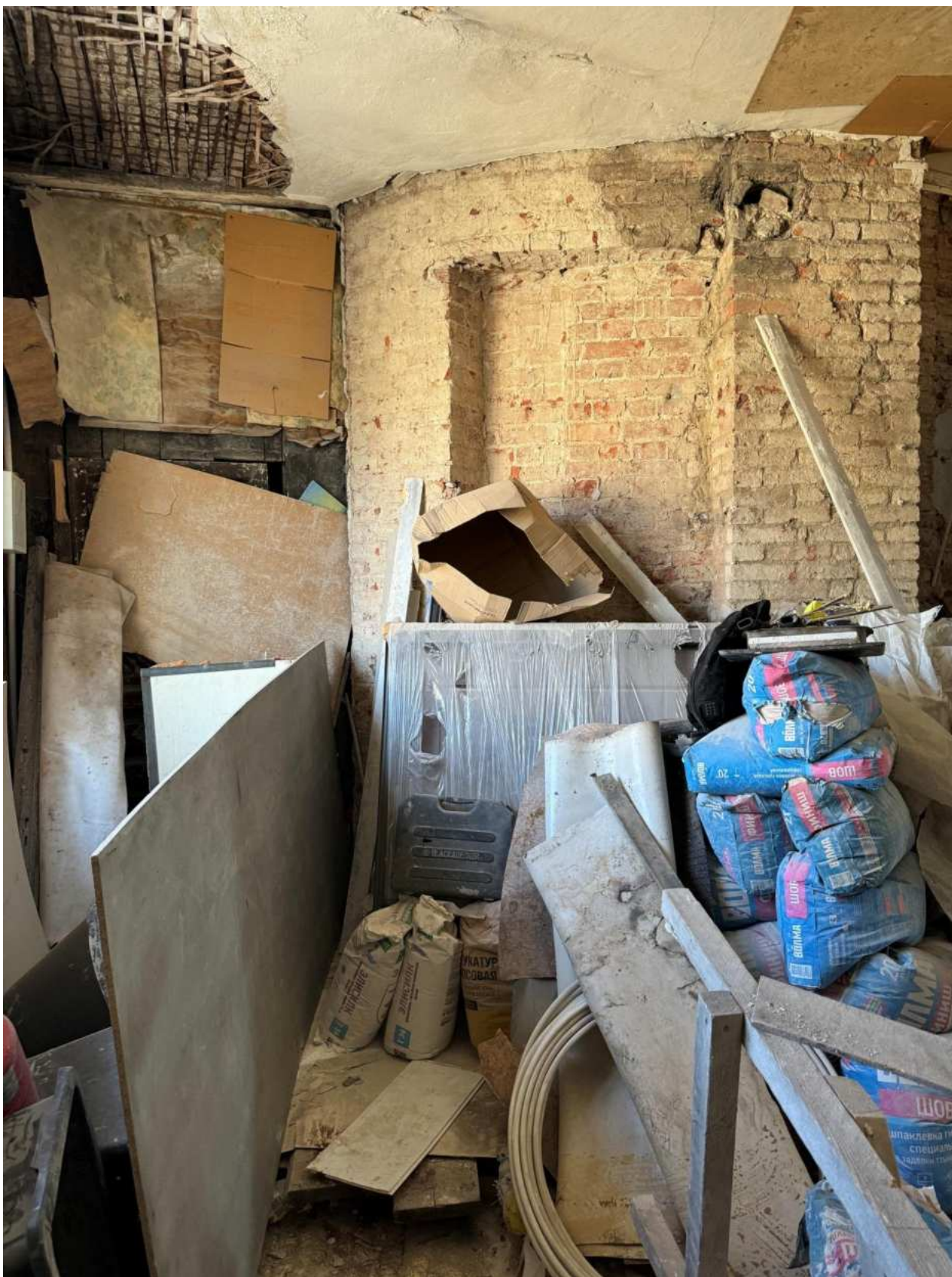
Фото 21. Вид на помещение квартиры № 81 объекта культурного наследия.
