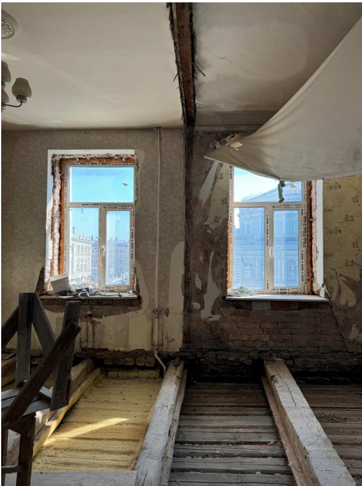
Фото 25. Вид на помещение квартиры № 81 объекта культурного наследия.
