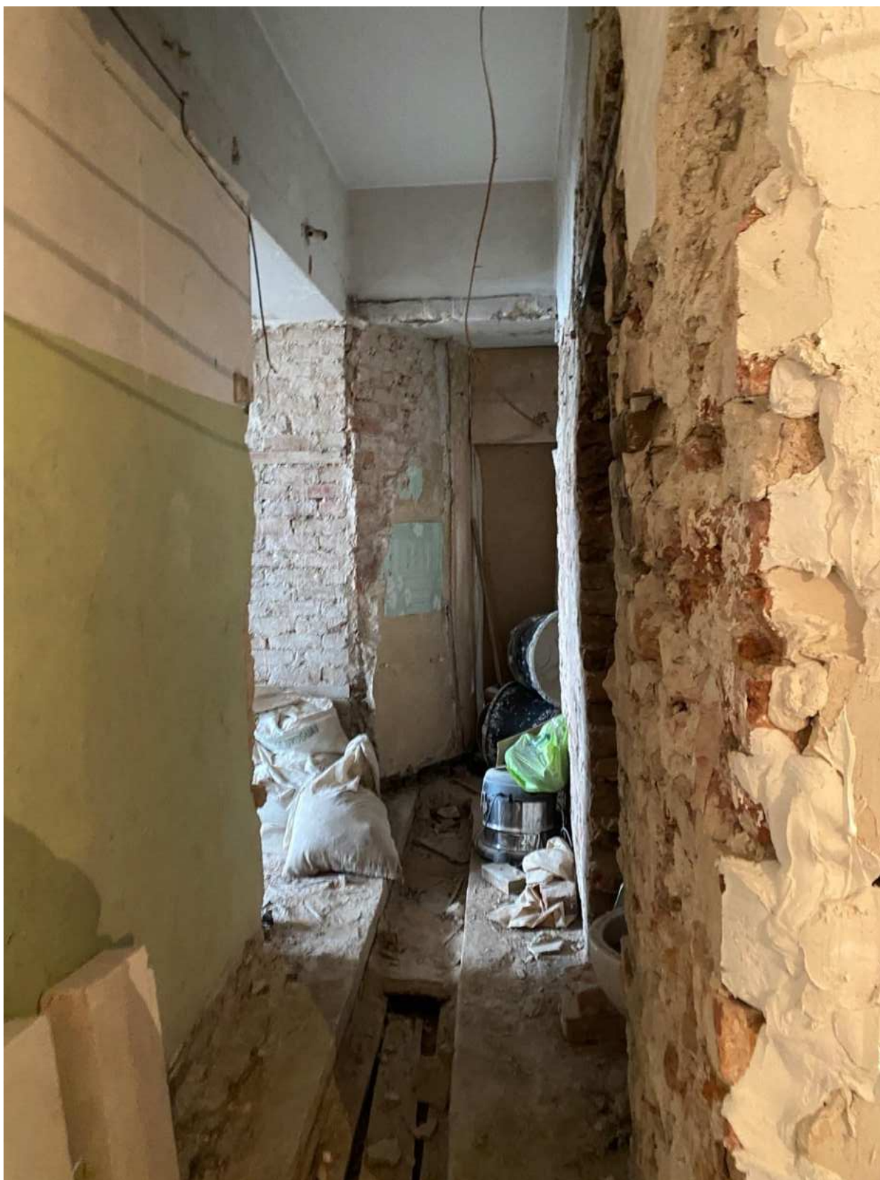
Фото 22. Вид на помещение квартиры № 81 объекта культурного наследия.
