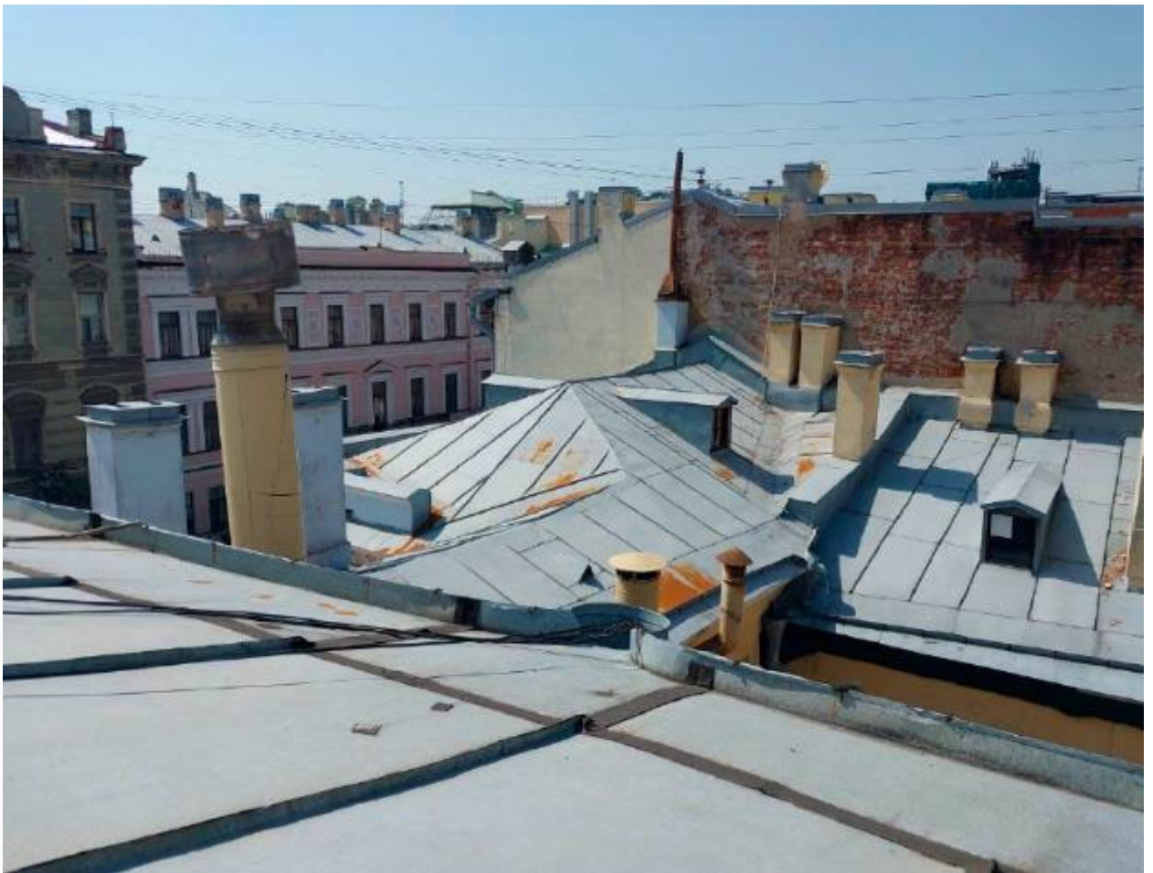
20. Кровля объекта культурного наследия федерального значения «Дом Демидова П.Н. (Гагариной В.Ф.)», расположенного по адресу: г. Санкт-Петербург, Большая Морская ул., д. 45, литера А. Фрагмент. 02.10.2024
