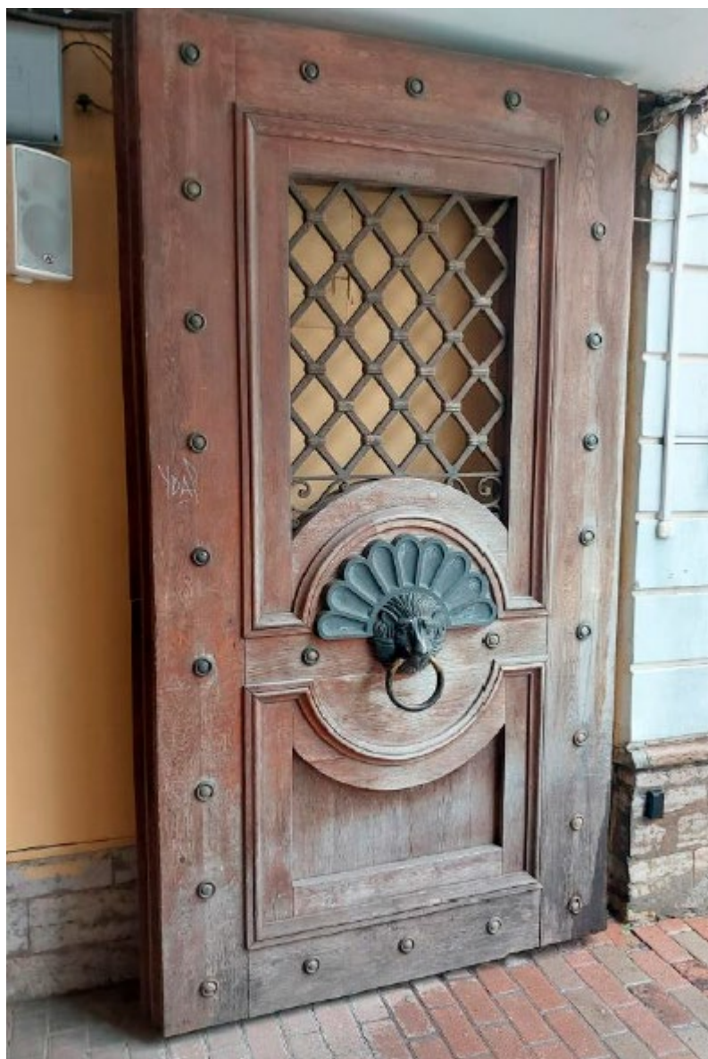
13. Створка ворот юго-восточного лицевого фасада объекта культурного наследия федерального значения «Дом Демидова П.Н. (Гагариной В.Ф.)», расположенного по адресу: г. Санкт-Петербург, Большая Морская ул., д. 45, литера А. Фрагмент. 02.10.2024
