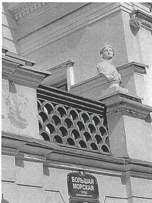
4. Восточный лицевой фасад объекта культурного наследия
