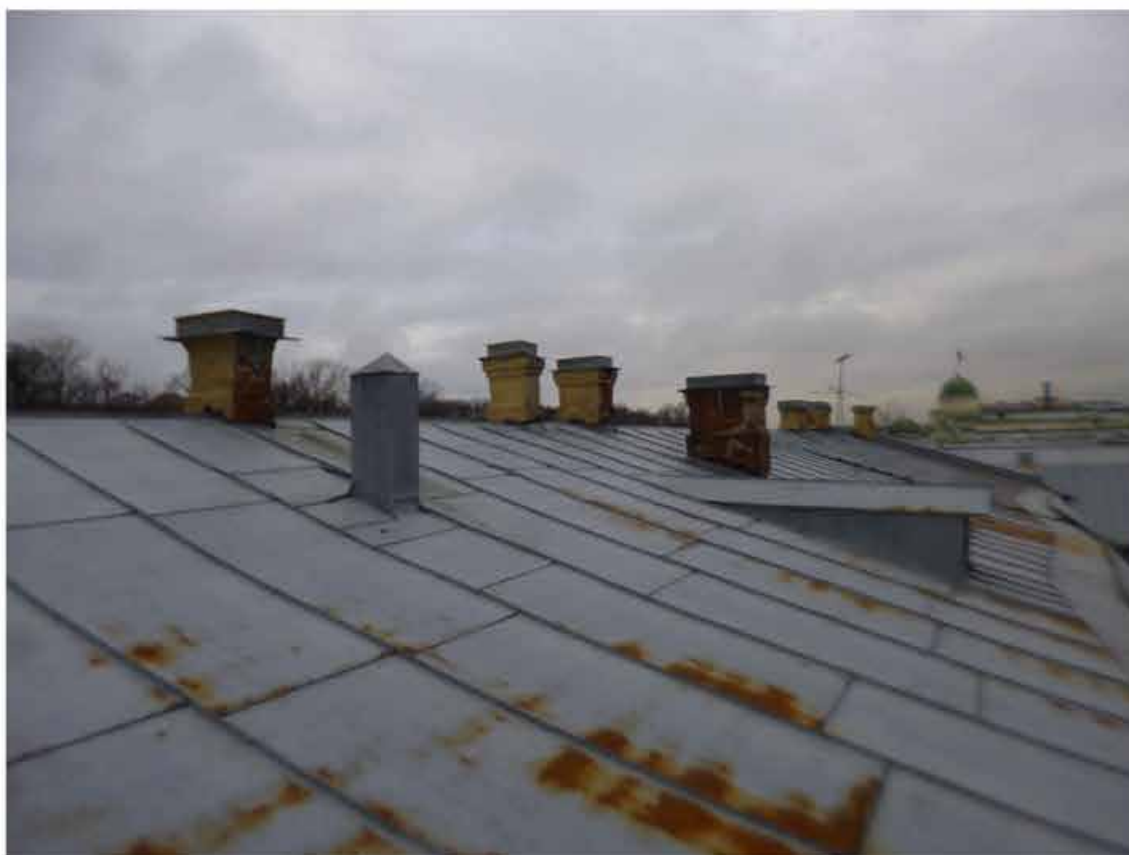
141. Объект культурного наследия федерального значения «Музей сельскохозяйственный». Кровля. Общий вид в осях Б-В. 09.09.2024 г.
