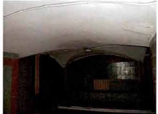
6. Подвальное Помещение лицевого корпуса со стороны наб. р. Фонтанки
