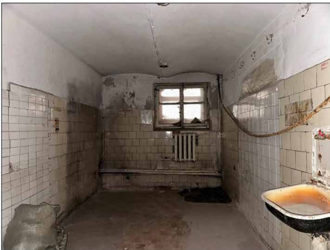
116. Объект культурного наследия федерального значения «Музей сельскохозяйственный». Подвал, помещение № 223 (45-Н). 09.09.2024 г.
