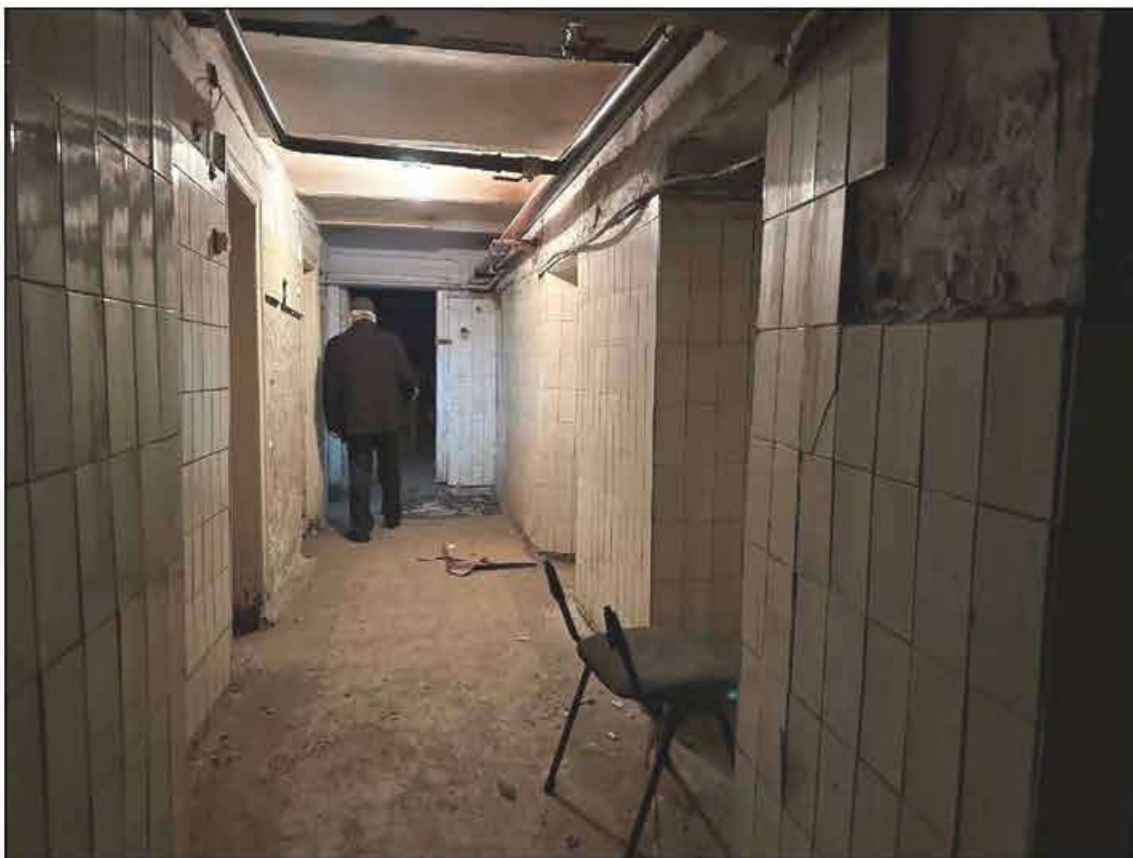
117. Объект культурного наследия федерального значения «Музей сельскохозяйственный». Подвал, помещение № 224 (45-Н). 09.09.2024 г.
