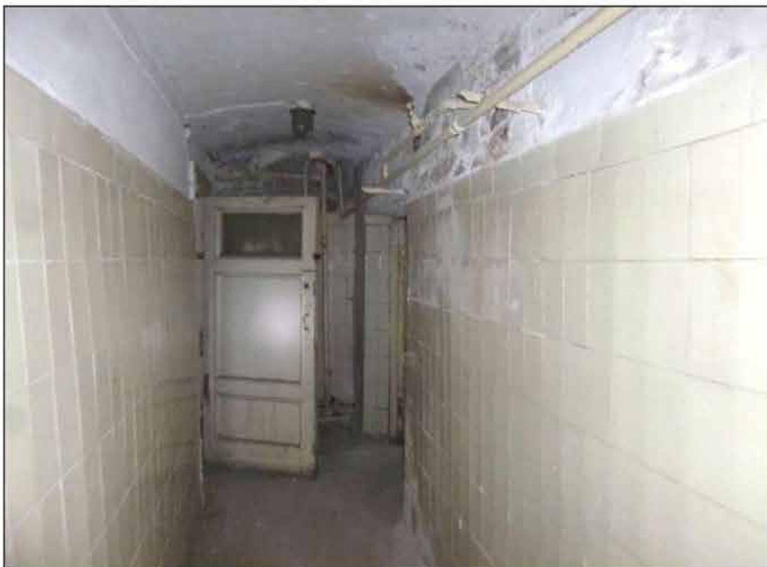
120. Объект культурного наследия федерального значения «Музей сельскохозяйственный». Подвал, помещение № 231 (45-Н). Вход в помещение № 229 (45-Н). Выход на лестницу 6-ЛК (помещения №№ 4, 5). 09.09.2024 г.
