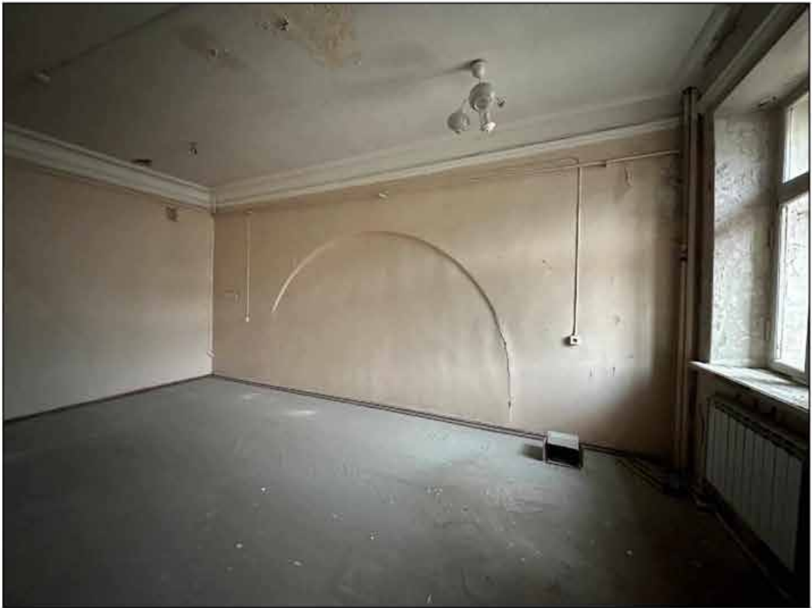
66. Объект культурного наследия федерального значения «Музей сельскохозяйственный». 2-й этаж, северо-западная часть помещения № 9 (51-Н). 09.09.2024 г.
