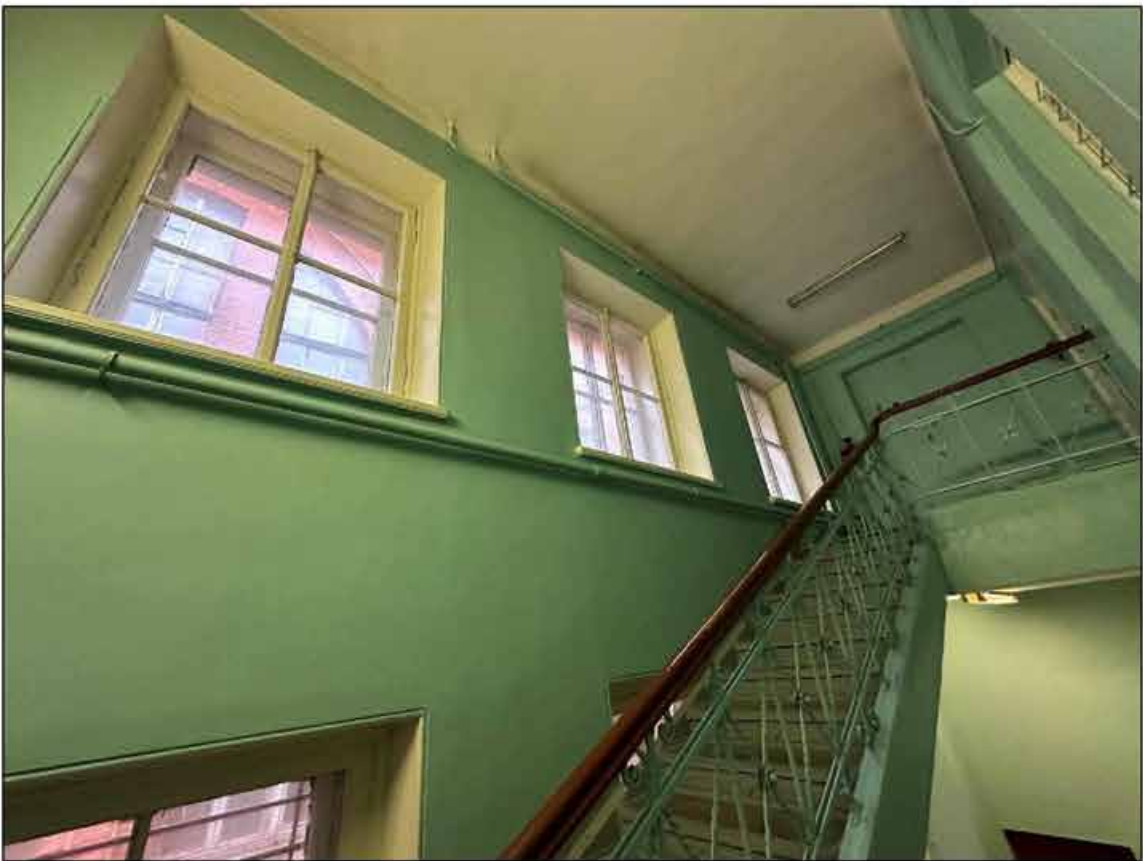
45. Объект культурного наследия федерального значения «Музей сельскохозяйственный». 2-й этаж, двухмаршевая лестница (помещение № 128 (45-Н)). Оконные проемы. 09.09.2024 г.
