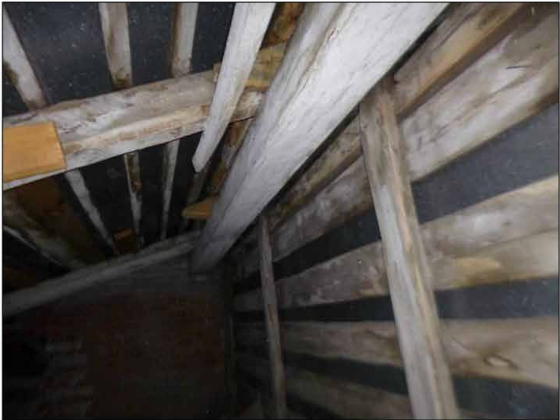
134. Объект культурного наследия федерального значения «Музей сельскохозяйственный». Чердак. Деревянный каркас и обшивка металлом в осях 3-4/Б-В. 09.09.2024 г.
