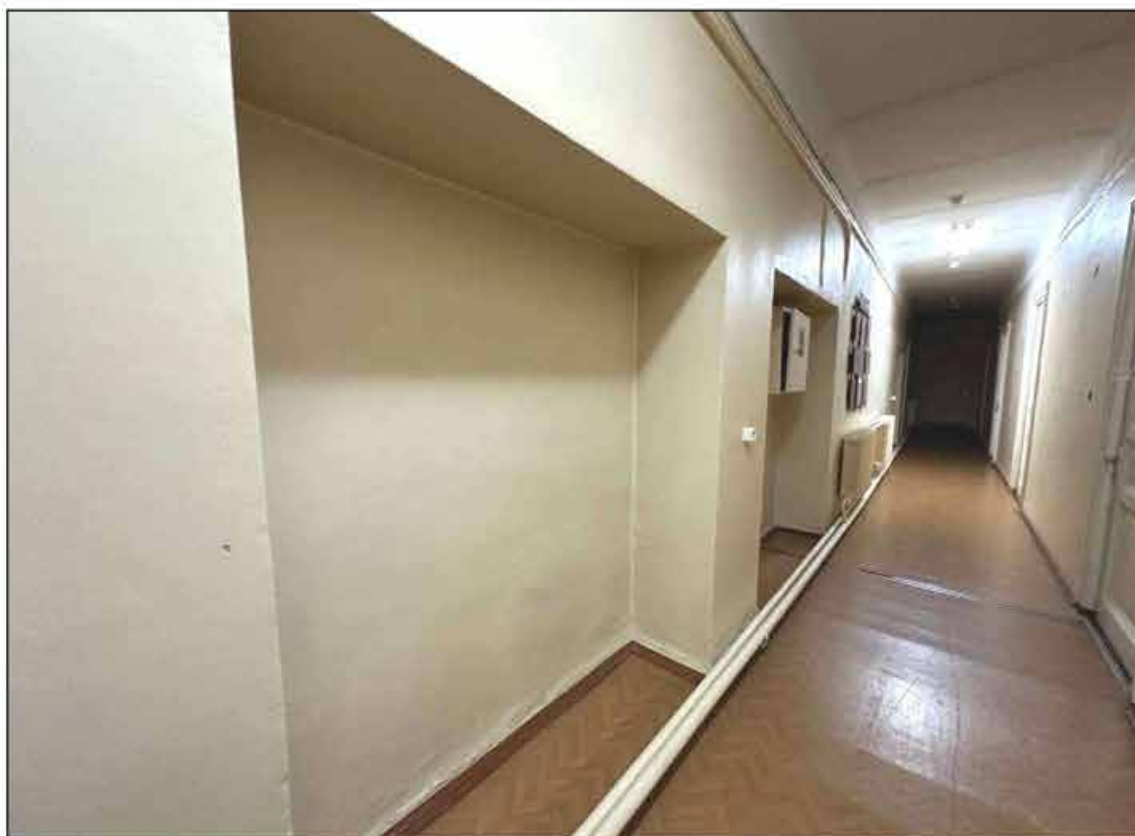
88. Объект культурного наследия федерального значения «Музей сельскохозяйственный». 3-й этаж, коридор (помещение № 10 (52-Н)). Вид от помещения № 14 (52-Н). 09.09.2024 г.
