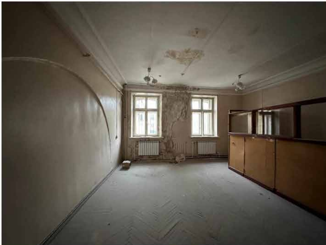
65. Объект культурного наследия федерального значения «Музей сельскохозяйственный». 2-й этаж, оконные проемы в восточной части помещения № 9 (51-Н). 09.09.2024 г.
