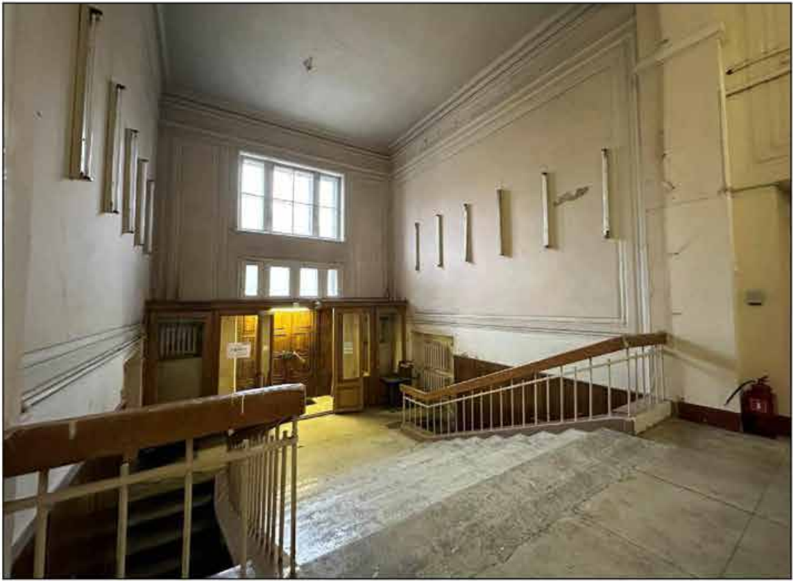
8. Объект культурного наследия федерального значения «Музей сельскохозяйственный». 1-й этаж, трехмаршевая лестница и тамбур в вестибюле центрального входа лицевого корпуса по набережной реки Фонтанки (помещение № 52 (45-Н)). 09.09.2024 г.
