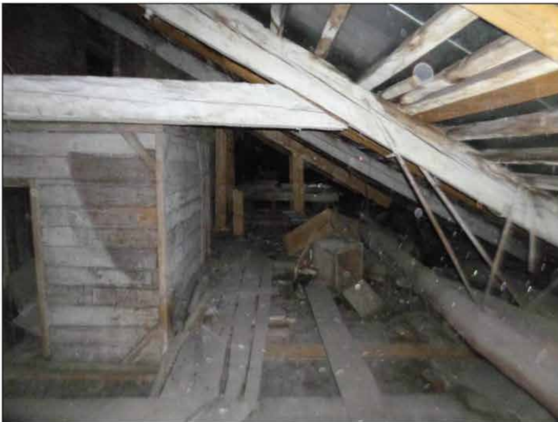
129. Объект культурного наследия федерального значения «Музей сельскохозяйственный». Чердак в осях 2-3/А-Б. 09.09.2024 г.
