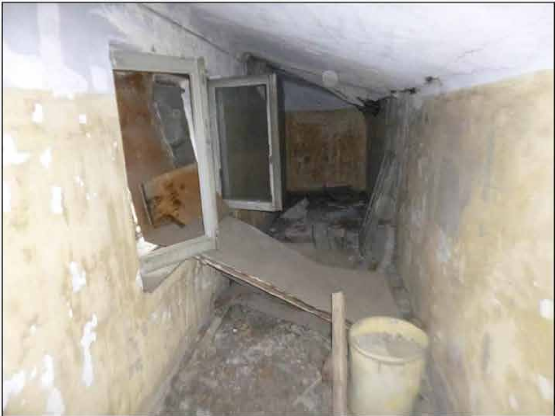
133. Объект культурного наследия федерального значения «Музей сельскохозяйственный». Чердак в осях 1-2/Б-В. 09.09.2024 г.
