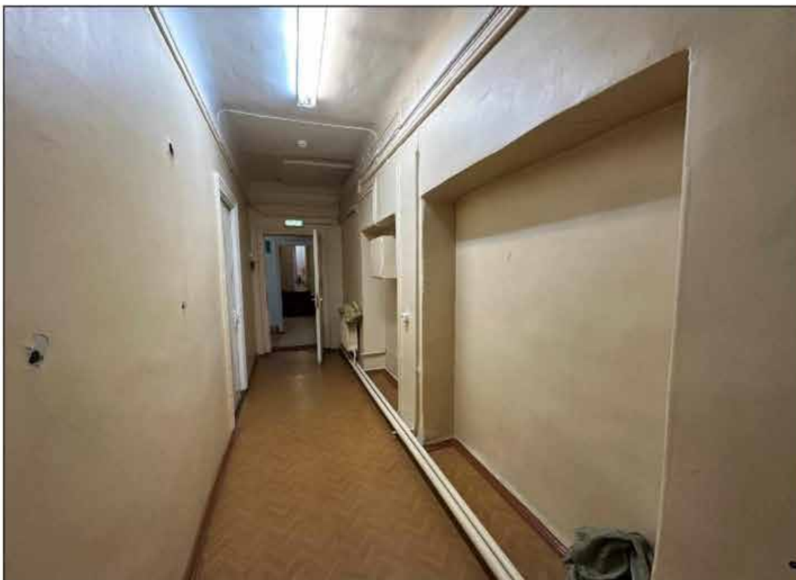
87. Объект культурного наследия федерального значения «Музей сельскохозяйственный». 3-й этаж, коридор (помещение № 10 (52-Н)). Выход в помещение № 1 (52-Н). 09.09.2024 г.
