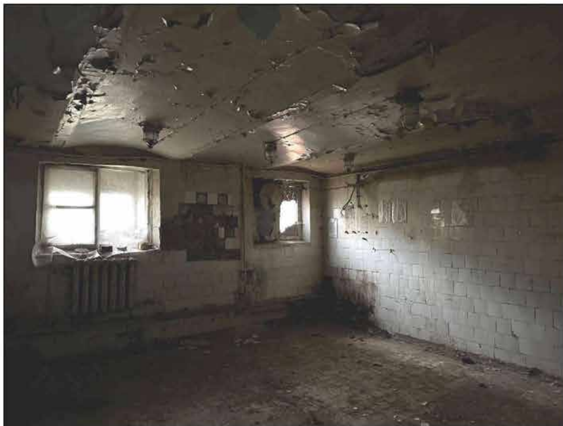
111. Объект культурного наследия федерального значения «Музей сельскохозяйственный». Подвал, помещение № 219 (45-Н). 09.09.2024 г.
