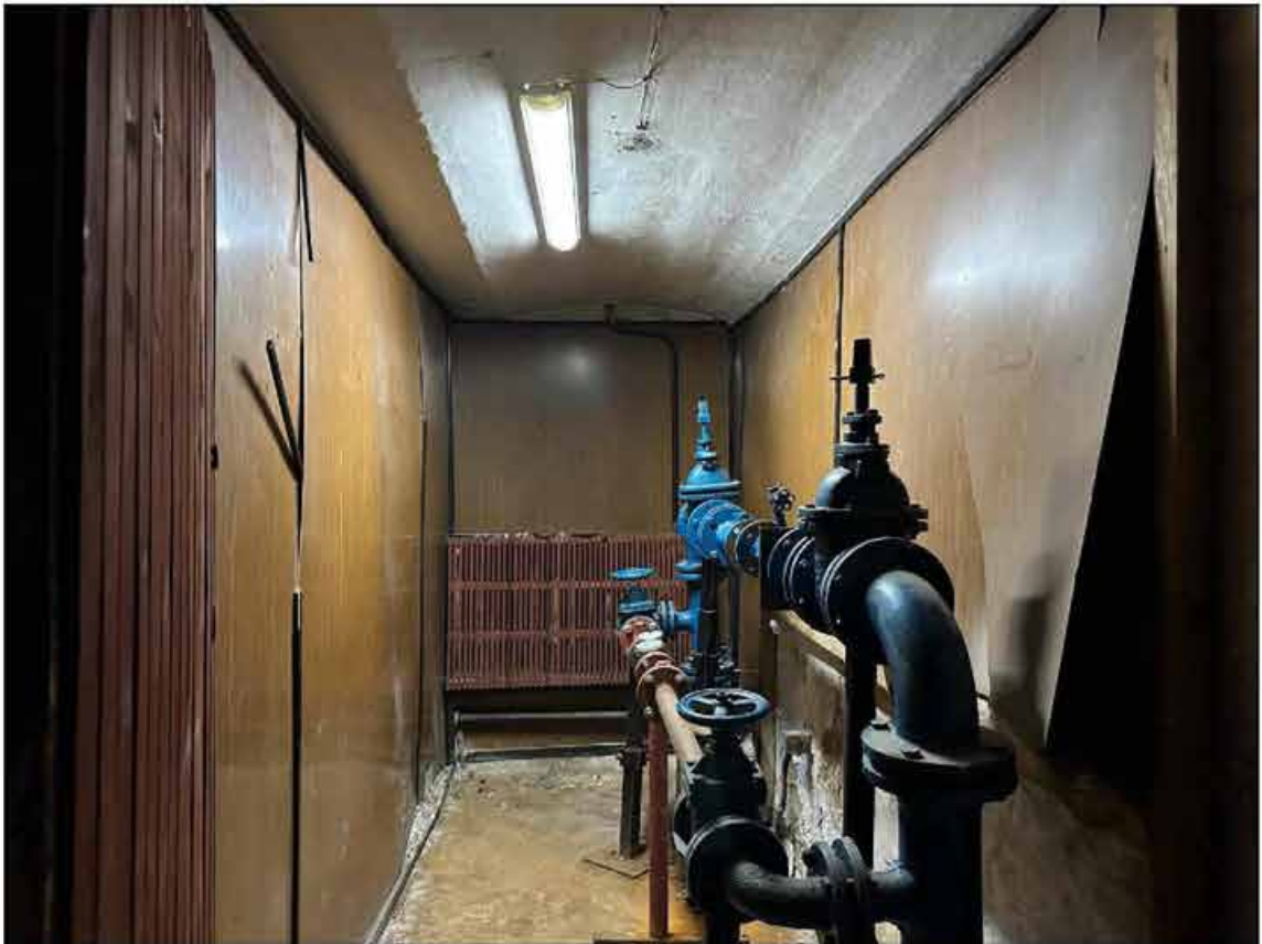
107. Объект культурного наследия федерального значения «Музей сельскохозяйственный». Подвал, помещение № 210 (45-Н). 09.09.2024 г.
