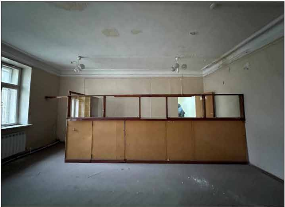
67. Объект культурного наследия федерального значения «Музей сельскохозяйственный».
