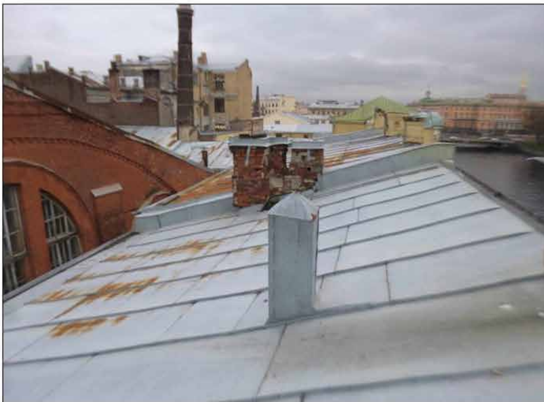
140. Объект культурного наследия федерального значения «Музей сельскохозяйственный». Кровля. Общий вид в осях Б-В. 09.09.2024 г.
