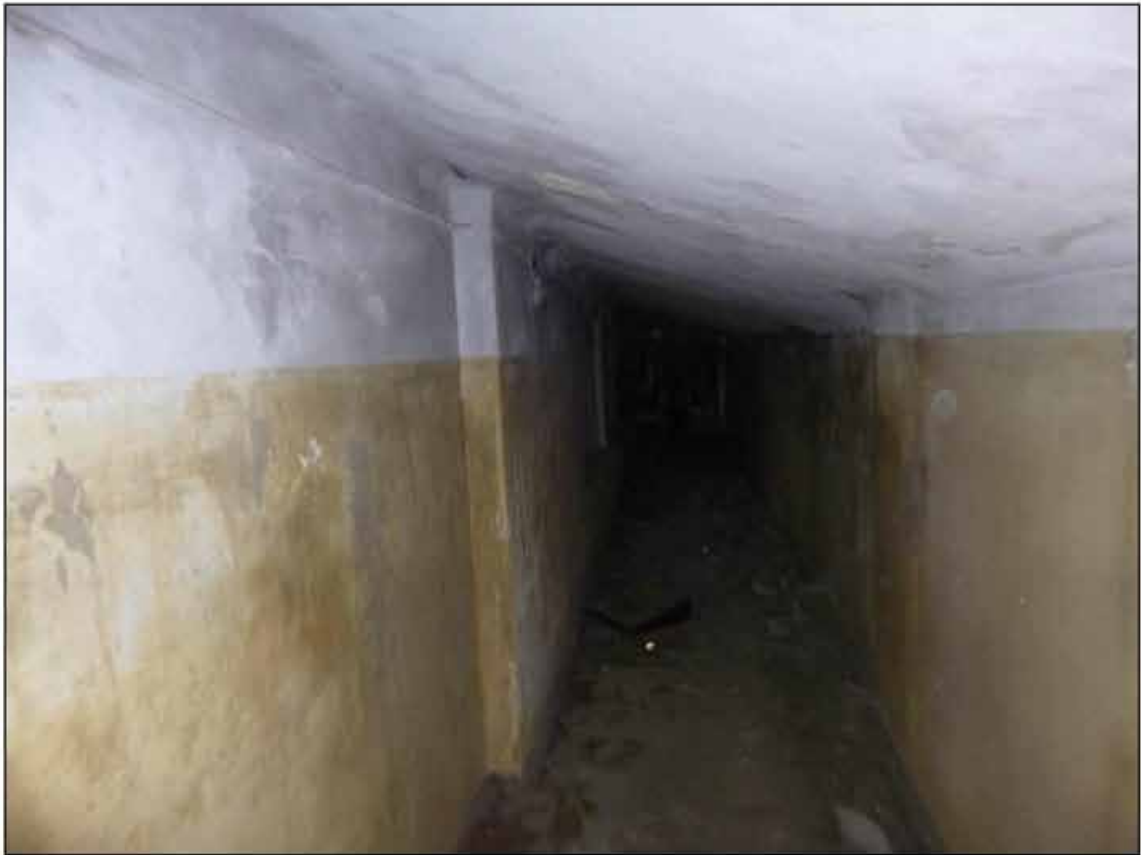
132. Объект культурного наследия федерального значения «Музей сельскохозяйственный». Чердак в осях 1-3/Б-В. 09.09.2024 г.
