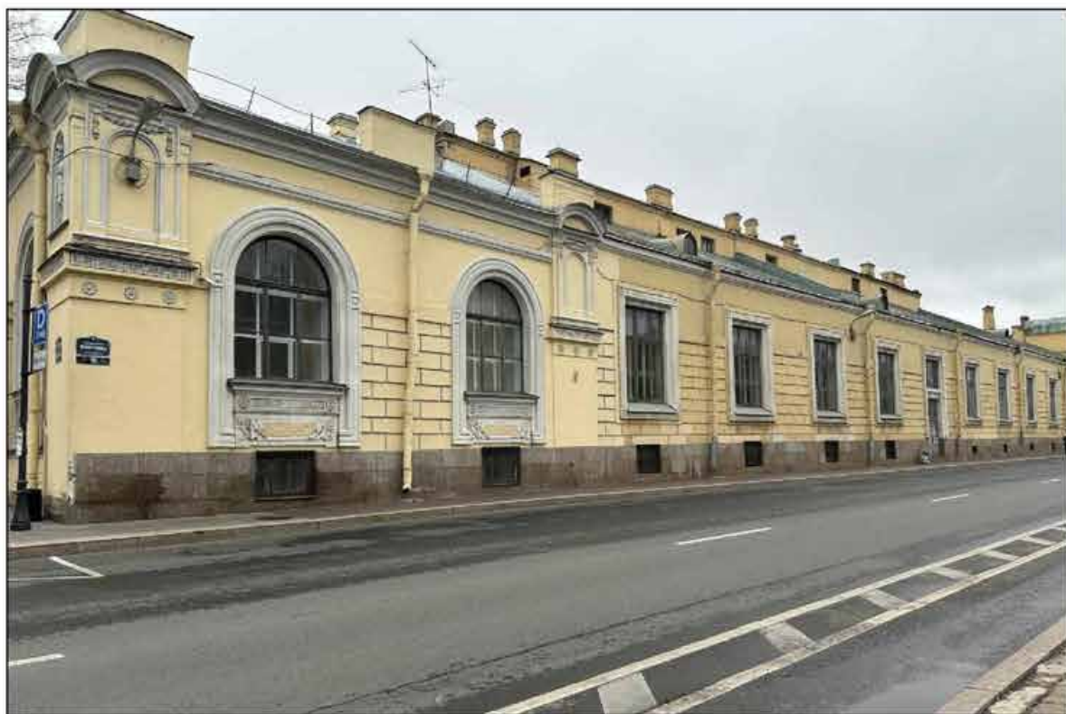
3. Объект культурного наследия федерального значения «Музей сельскохозяйственный».
