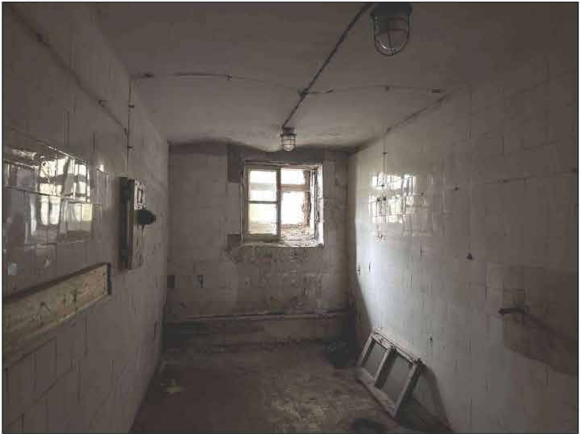
114. Объект культурного наследия федерального значения «Музей сельскохозяйственный». Подвал, помещение № 221 (45-Н). 09.09.2024 г.
