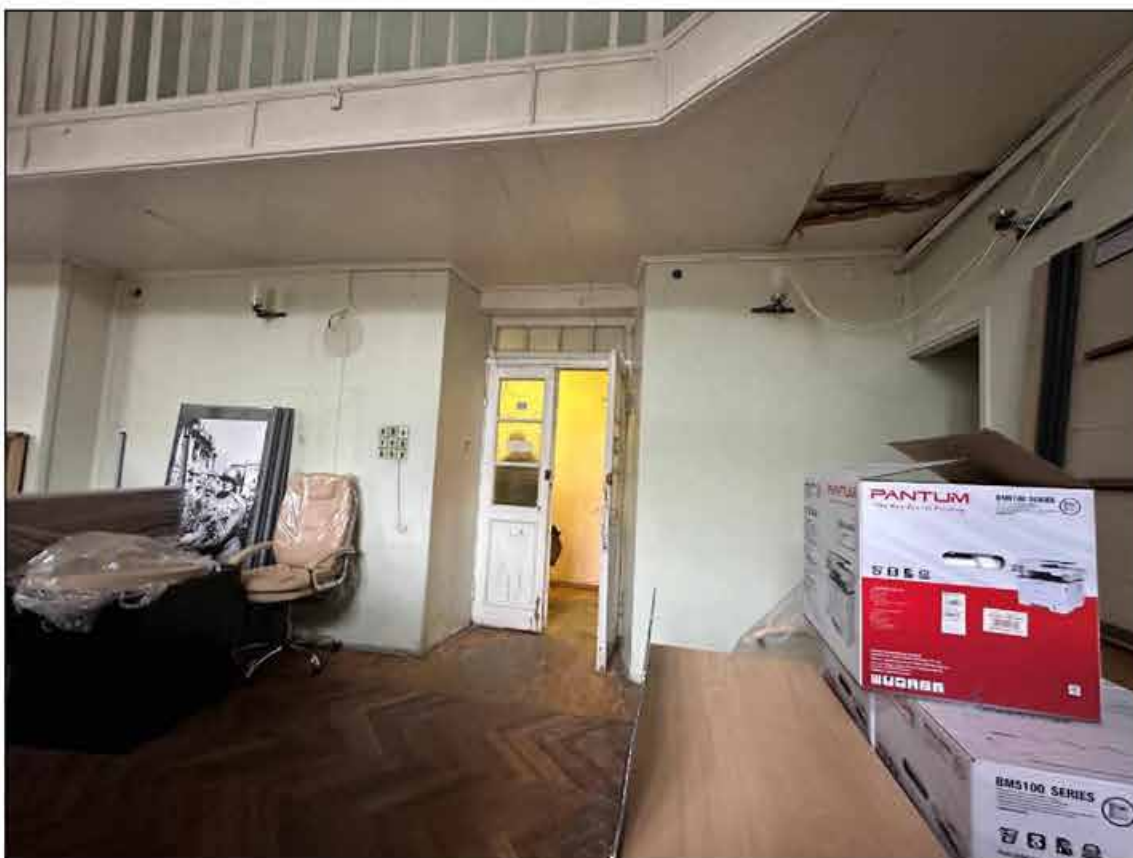
28. Объект культурного наследия федерального значения «Музей сельскохозяйственный». 1-й этаж, южная часть помещения № 54 (45-Н), выход в коридор (помещение № 61) 09.09.2024 г.
