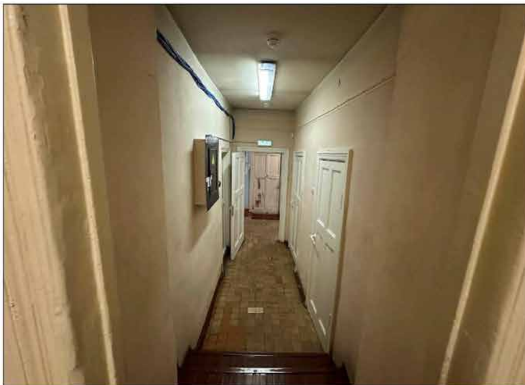
73. Объект культурного наследия федерального значения «Музей сельскохозяйственный». 3-й этаж, коридор (помещение № 2 (52-Н)). Входы в помещения №№ 3 и 4 (52-Н). Выход в помещение № 1 (52-Н). 09.09.2024 г.
