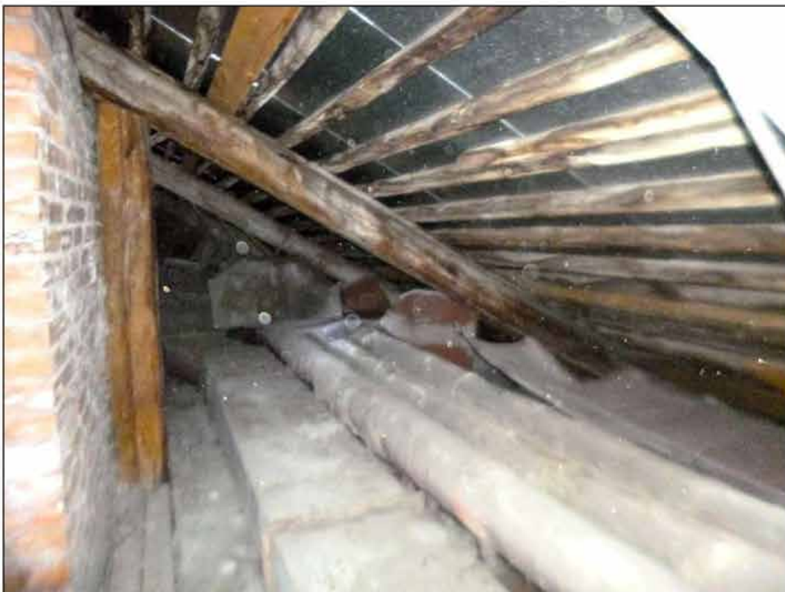
128. Объект культурного наследия федерального значения «Музей сельскохозяйственный». Чердак в осях 1-2/А-Б. 09.09.2024 г.
