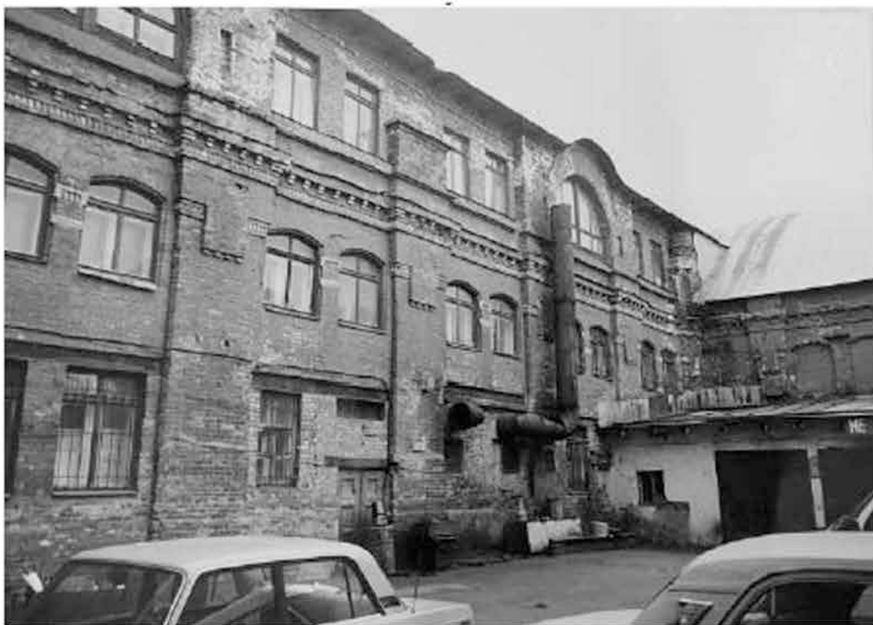
Илл. 43. Соляной городок. Сельскохозяйственный музей. Фрагмент дворового фасада, вид с северо-востока. Архив КГИОП. Паспорт памятника «Соляной городок. Сельскохозяйственный музей». № 880. Инв. 849 п. 1998 г.
