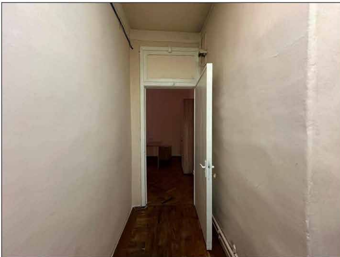
75. Объект культурного наследия федерального значения «Музей сельскохозяйственный». 3-й этаж, коридор (помещение № 9 (52-Н)). Вход в помещение № 8 (52-Н).. 09.09.2024 г.
