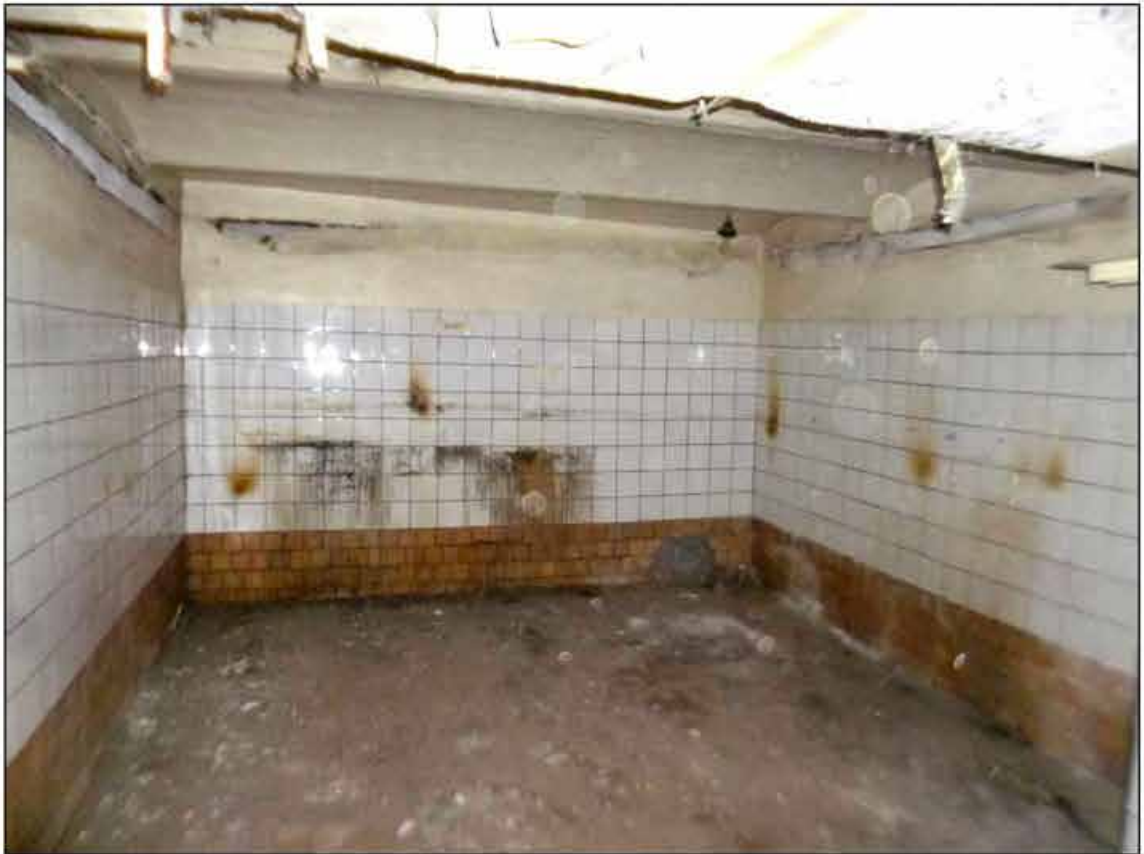
109. Объект культурного наследия федерального значения «Музей сельскохозяйственный». Подвал, помещение № 214 (45-Н). 09.09.2024 г.
