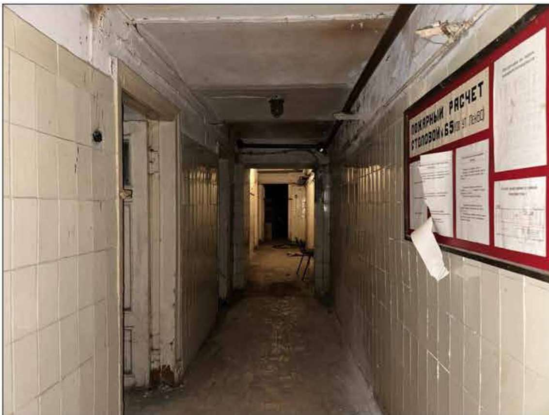
113. Объект культурного наследия федерального значения «Музей сельскохозяйственный». Подвал, помещение № 220 (45-Н). 09.09.2024 г.
