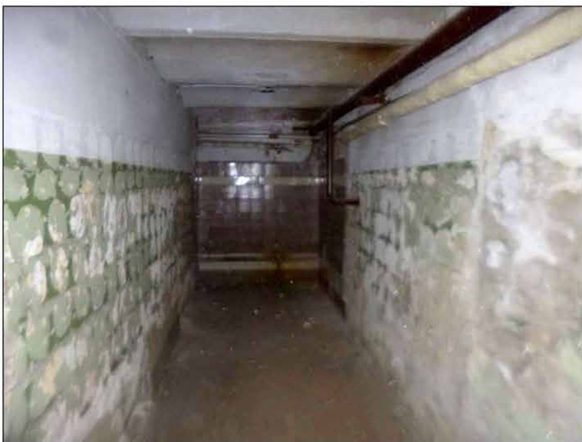
119. Объект культурного наследия федерального значения «Музей сельскохозяйственный». Подвал, помещение № 230 (45-Н). 09.09.2024 г.
