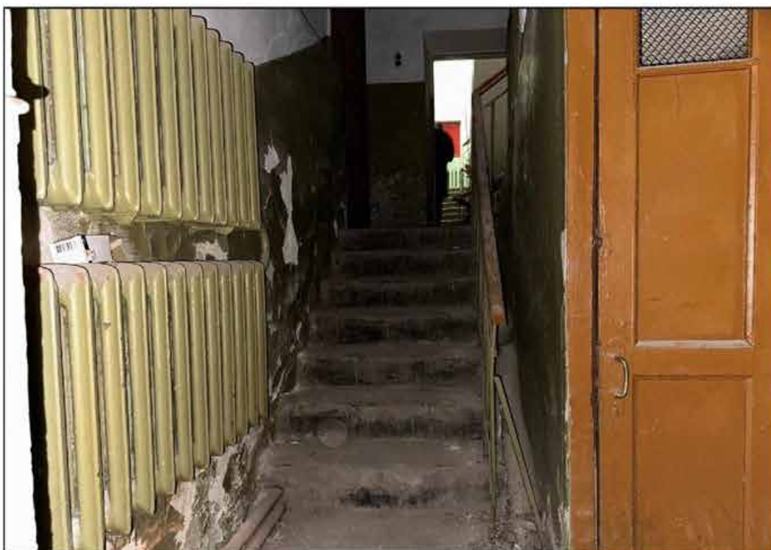
121. Объект культурного наследия федерального значения «Музей сельскохозяйственный». Подвал, лестница 6-ЛК (помещение № 4). 09.09.2024 г.
