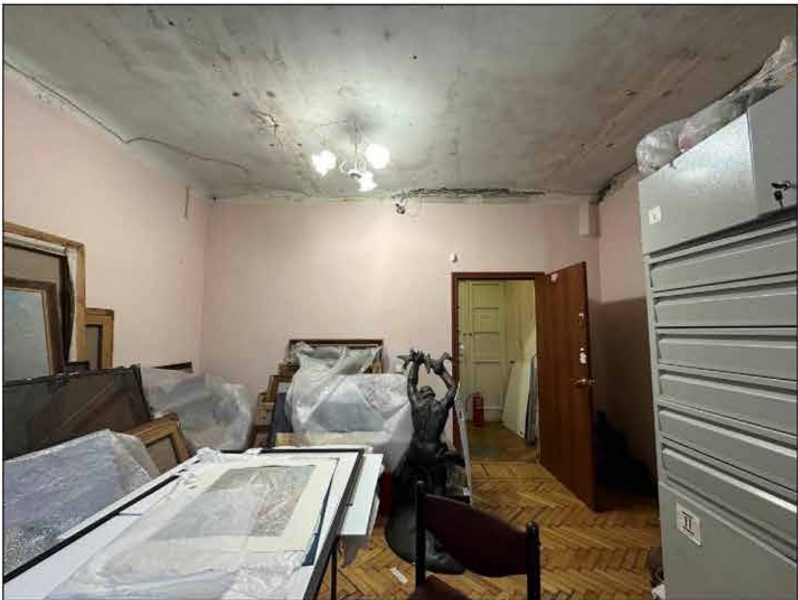
37. Объект культурного наследия федерального значения «Музей сельскохозяйственный». 1-й этаж, помещения № 60 (45-Н). Выход в коридор (помещение № 61). 09.09.2024 г.
