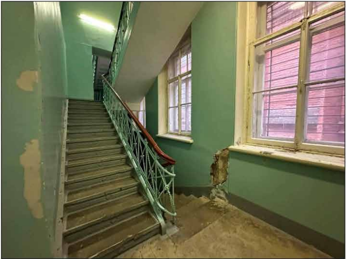
16. Объект культурного наследия федерального значения «Музей сельскохозяйственный». 1-й этаж, двухмаршевая лестница (помещение № 51(45-Н)). 09.09.2024 г.
