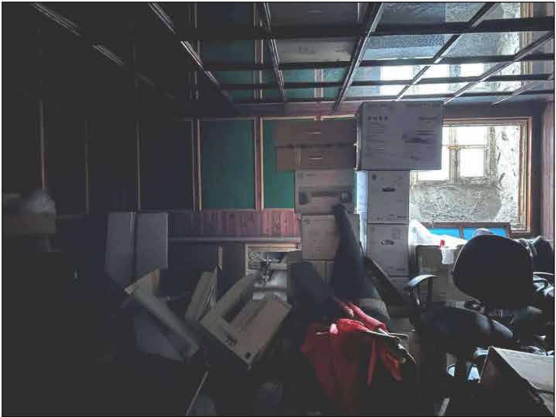
106. Объект культурного наследия федерального значения «Музей сельскохозяйственный». Подвал, помещение № 209 (45-Н). 09.09.2024 г.
