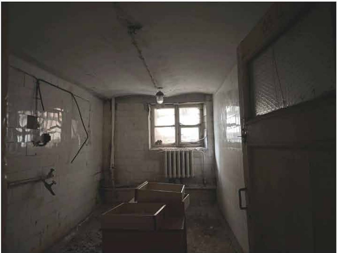
115. Объект культурного наследия федерального значения «Музей сельскохозяйственный». Подвал, помещение № 222 (45-Н). 09.09.2024 г.
