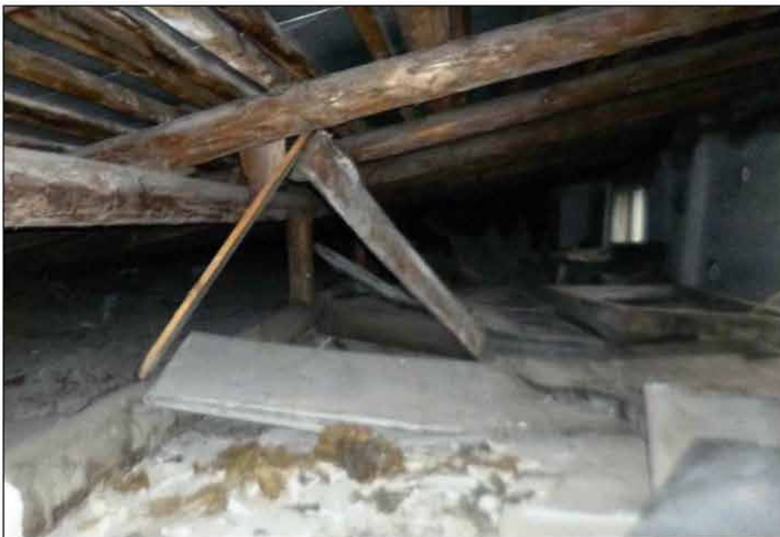
136. Объект культурного наследия федерального значения «Музей сельскохозяйственный». Чердак в осях 4-6/Б-В. 09.09.2024 г.
