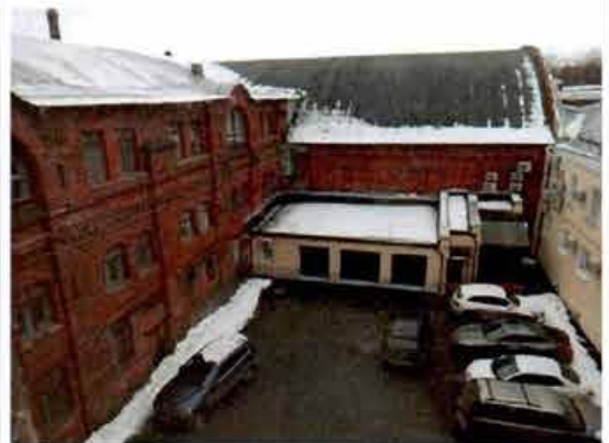
10. Северо-западные фасады дворового корпуса
