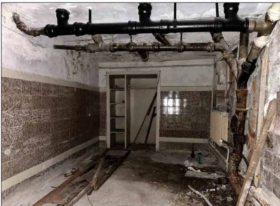
118. Объект культурного наследия федерального значения «Музей сельскохозяйственный». Подвал, помещение № 229 (45-Н). 09.09.2024 г.
