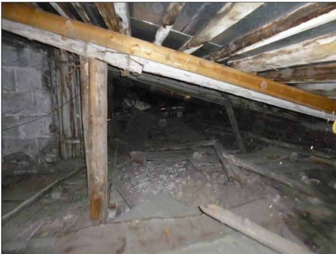
131. Объект культурного наследия федерального значения «Музей сельскохозяйственный». Чердак в осях 1-4/Б-В. 09.09.2024 г.
