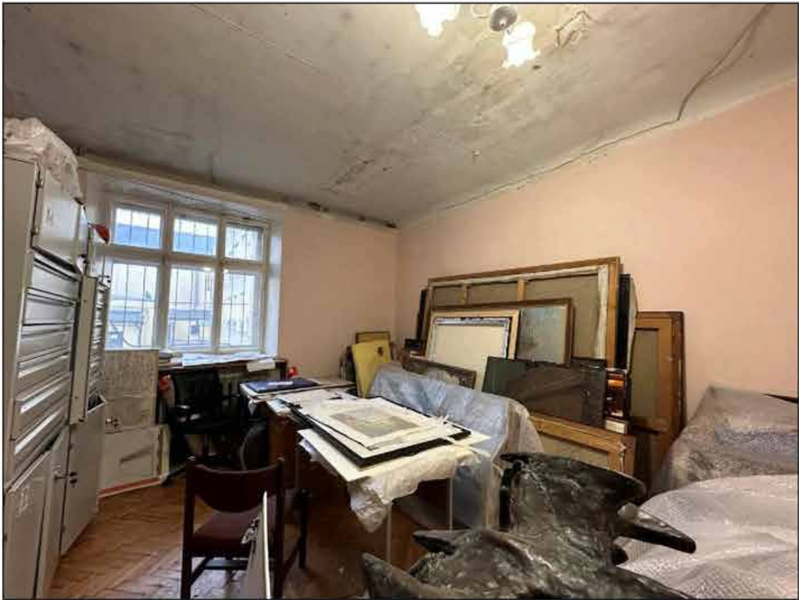
36. Объект культурного наследия федерального значения «Музей сельскохозяйственный». 1-й этаж, помещения № 60 (45-Н). 09.09.2024 г.
