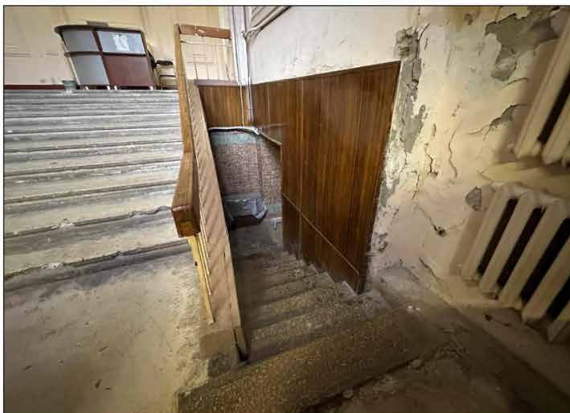
11. Объект культурного наследия федерального значения «Музей сельскохозяйственный». 1-й этаж, вестибюль центрального входа лицевого корпуса по набережной реки Фонтанки (помещение № 52 (45-Н)). Узкий лестничный марш трехмаршевой лестницы в подвал. 09.09.2024 г.
