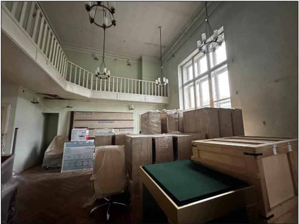
24. Объект культурного наследия федерального значения «Музей сельскохозяйственный». 1-й этаж, южная часть помещения № 54 (45-Н). 09.09.2024 г.
