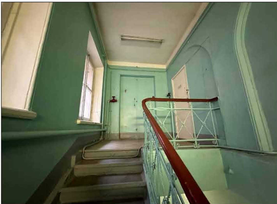
46. Объект культурного наследия федерального значения «Музей сельскохозяйственный». 2-й этаж, лестничная площадка двухмаршевой лестницы (помещение № 128 (45-Н)). Входы в помещения №№ 129-131 (45-Н) и 132-137 (45-Н). 09.09.2024 г.
