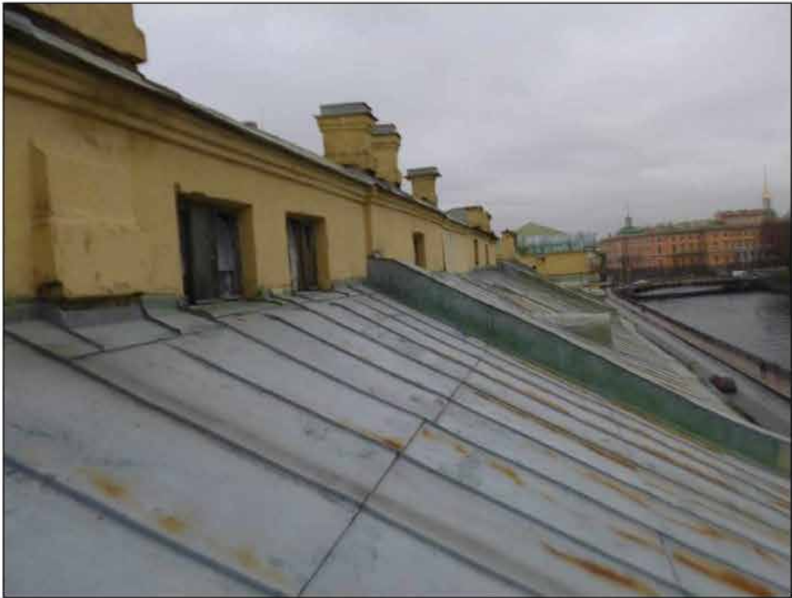
138. Объект культурного наследия федерального значения «Музей сельскохозяйственный». Кровля. Общий вид в осях А-Б. 09.09.2024 г.
