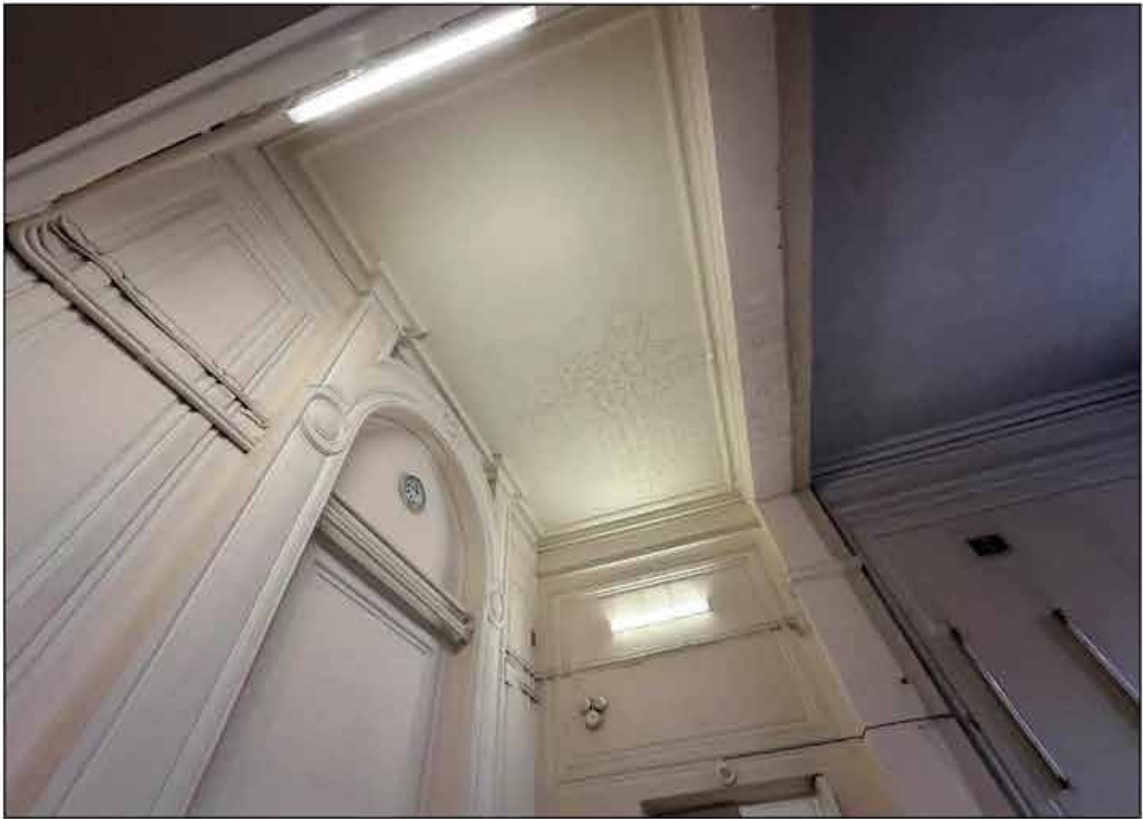
14. Объект культурного наследия федерального значения «Музей сельскохозяйственный». 1-й этаж, вестибюль центрального входа лицевого корпуса по набережной реки Фонтанки (помещение № 52 (45-Н)). Декоративная отделка стен и потолка. 09.09.2024 г.
