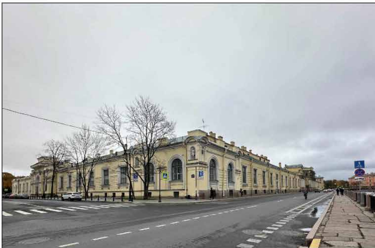
1. Объект культурного наследия федерального значения «Музей сельскохозяйственный». Общий вид лицевых корпусов по набережной реки Фонтанки и Гангутской улице. Вид на юго-восток от перекрестка набережной реки Фонтанки и Гангутской улицы. 09.09.2024 г.
