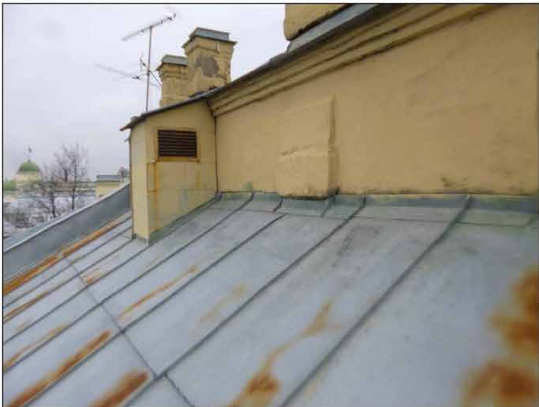
139. Объект культурного наследия федерального значения «Музей сельскохозяйственный». Кровля. Шахта вентиляции в осях 1-2/А-Б. 09.09.2024 г.
