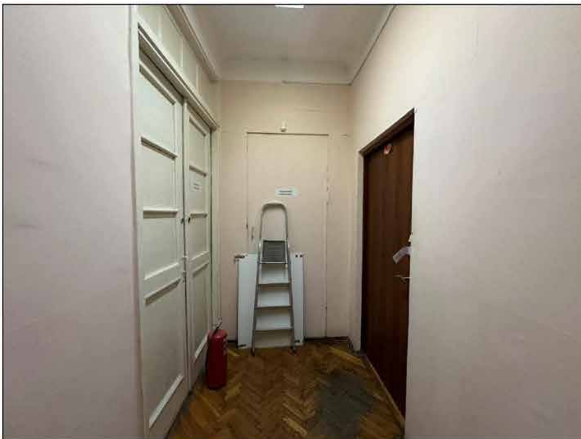
21. Объект культурного наследия федерального значения «Музей сельскохозяйственный». 1-й этаж, коридор (помещение № 61 (45-Н)). Входы в помещения №№ 54, 58 и 60 (45-Н)). 09.09.2024 г.
