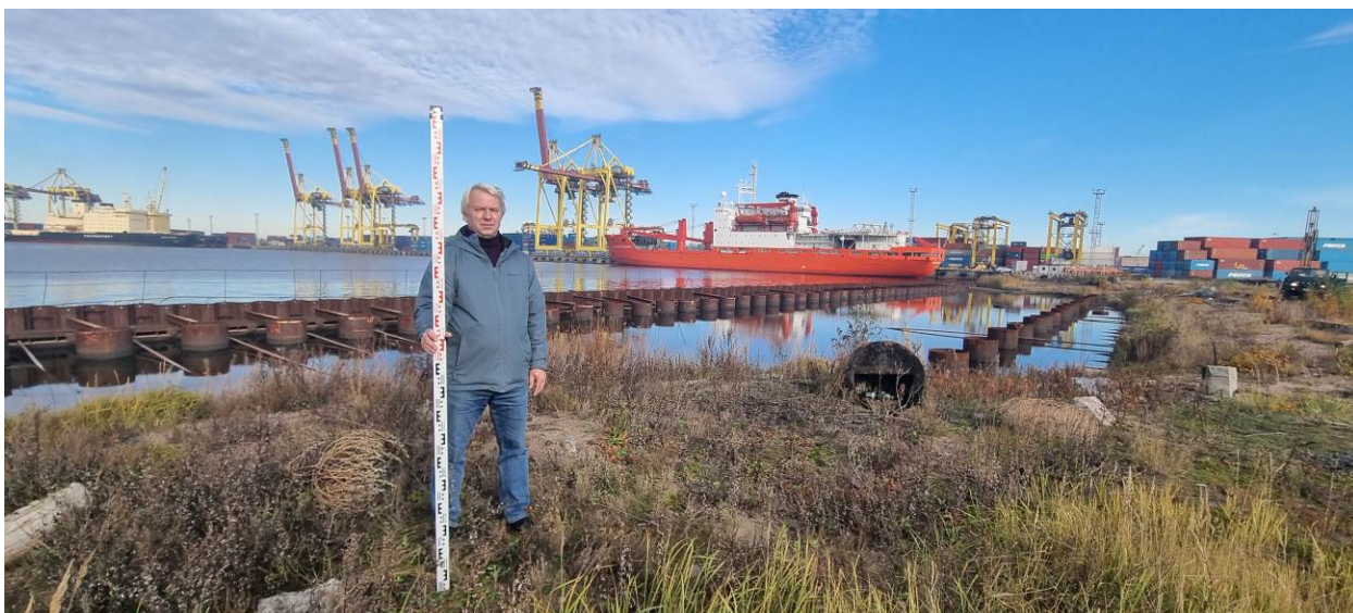
Рис. 17. Угольная гавань-2024. Точка фотофиксации 1. Северо-западная часть обследуемой территории. Вид с ЮЗ
