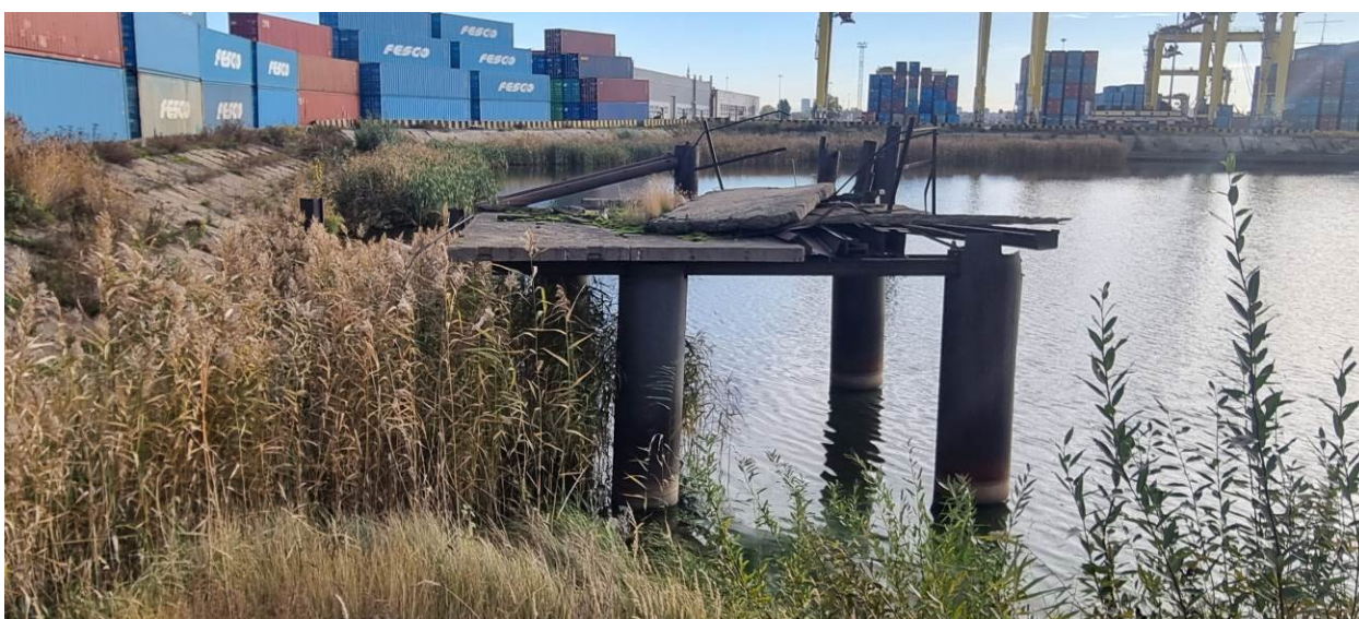
Рис. 31. Угольная гавань-2024. Точка фотофиксации 7. Северо-восточная часть обследуемой территории. Причалные конструкции 1970-х гг. Вид с СЗ
