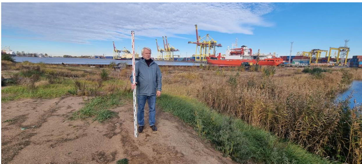
Рис. 44. Угольная гавань-2024. Точка фотофиксации 17. Северо-западная часть обследуемой территории. Вид с Ю
