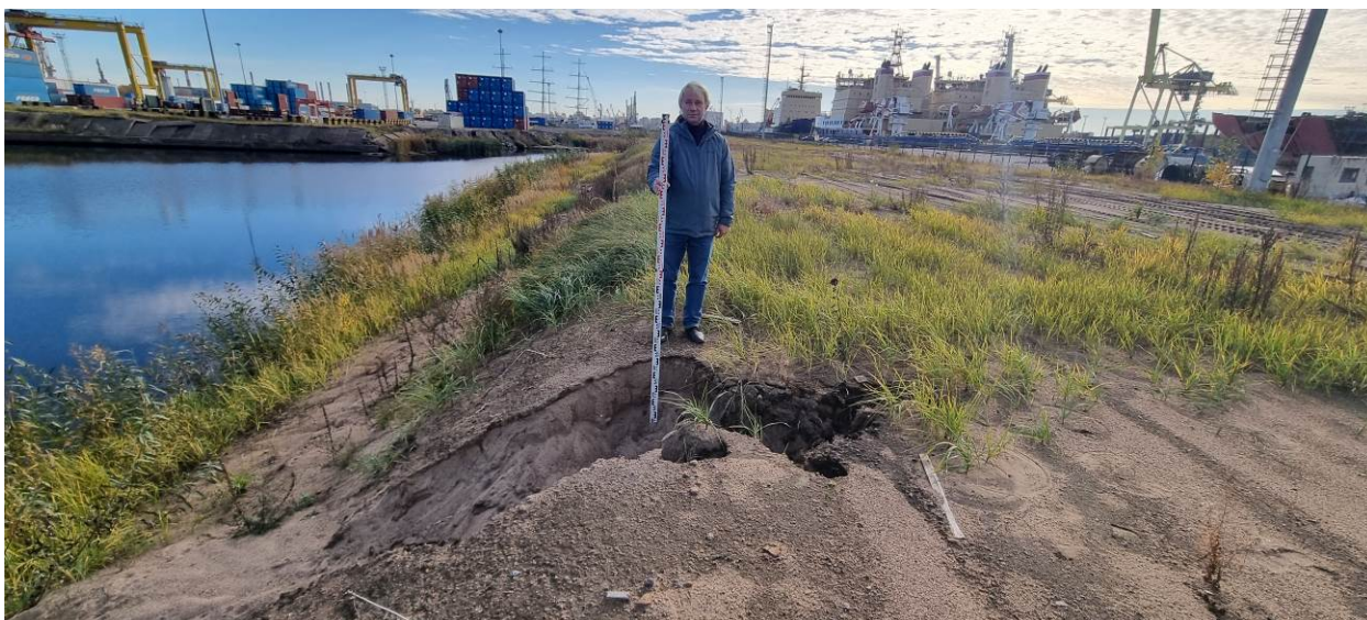
Рис. 54. Угольная гавань-2024. Точка фотофиксации 20. Западная часть обследуемой территории. Вид с СЗ
