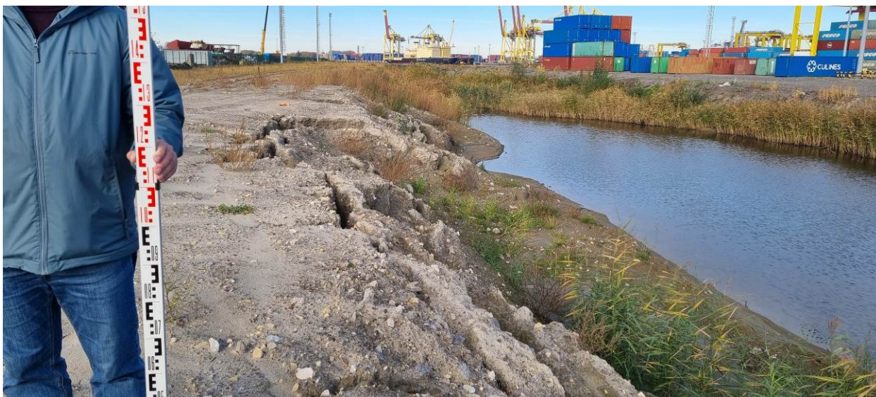
Рис. 68. Угольная гавань-2024. Точка фотофиксации 26. Юго-западная часть обследуемой территории. Западный берег южного водоема. Вид с Ю
