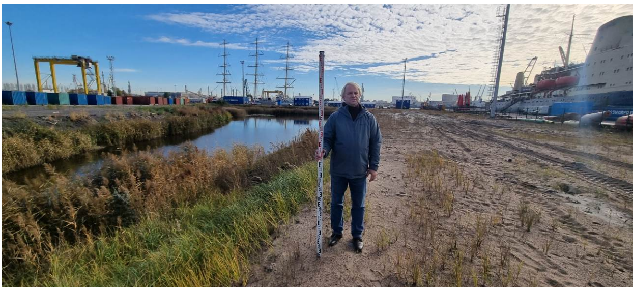
Рис. 64. Угольная гавань-2024. Точка фотофиксации 24. Юго-западная часть обследуемой территории. Вид с СЗ
