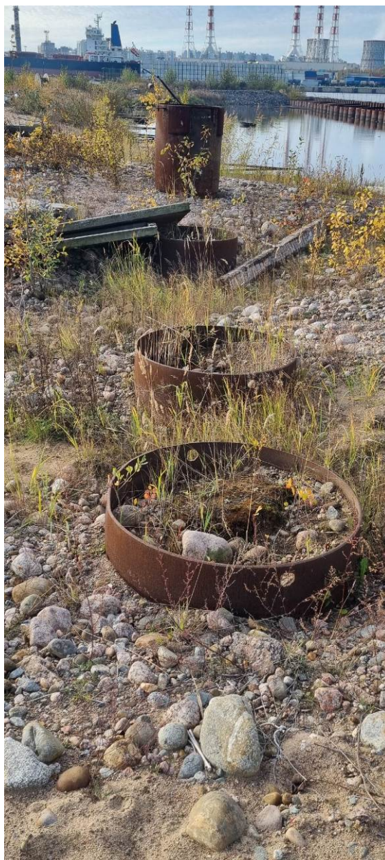
Рис. 37. Угольная гавань-2024. Точка фотофиксации 13. Северная часть обследуемой территории. Конструкции берегоукрепления. Вид с СВ
