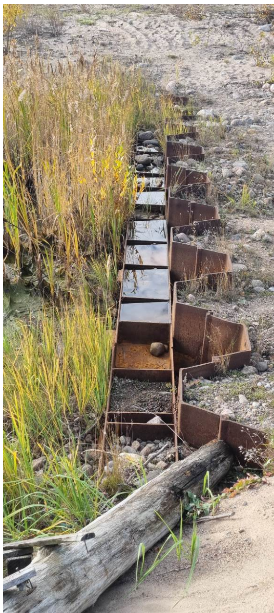
Рис. 36. Угольная гавань-2024. Точка фотофиксации 12. Северная часть обследуемой территории. Конструкции берегоукрепления. Вид с СВ
