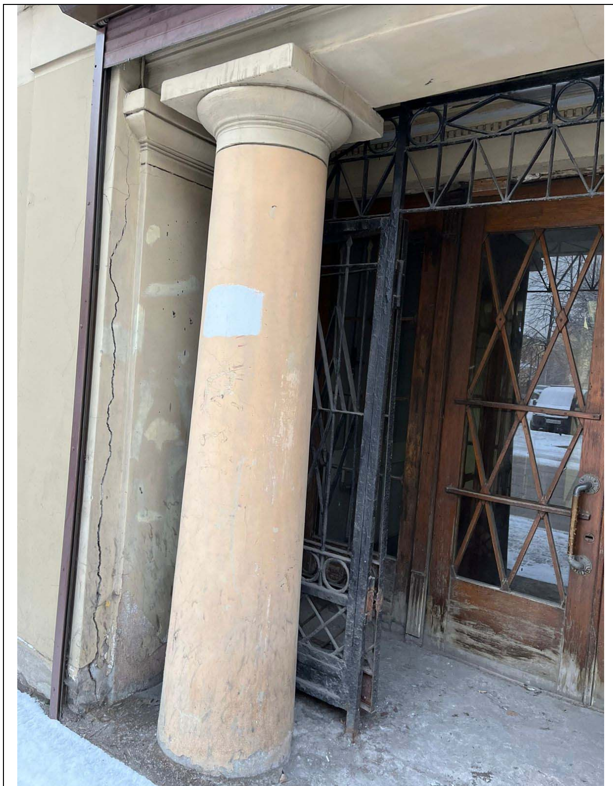
5. Дом Ф.И. Ротина (Вознесенская лечебница М.Я.Ауслендера). Лицевой фасад по Вознесенскому пр. Историческое дверное заполнение.
