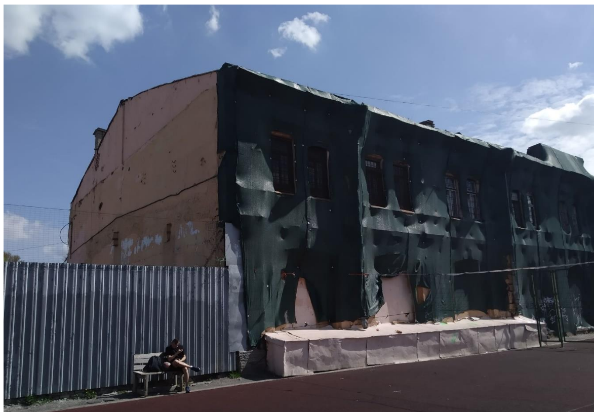
Фото 4. Фрагмент лицевого фасада западного корпуса со стороны Овсянниковского сквера
