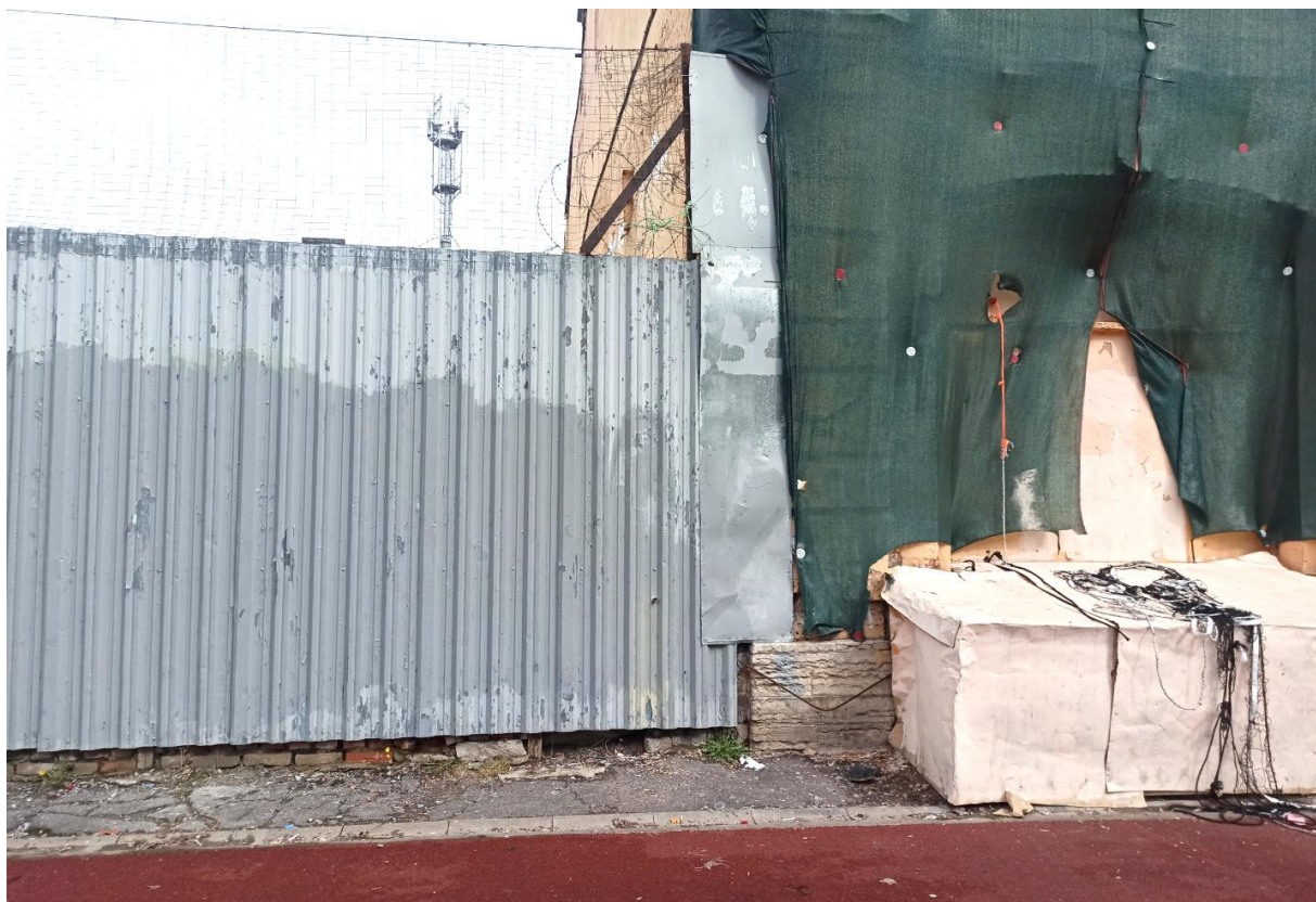
Фото 15. Вид на участок отмостки и спортплощадки в зоне торца исторического здания Мытного двора.
