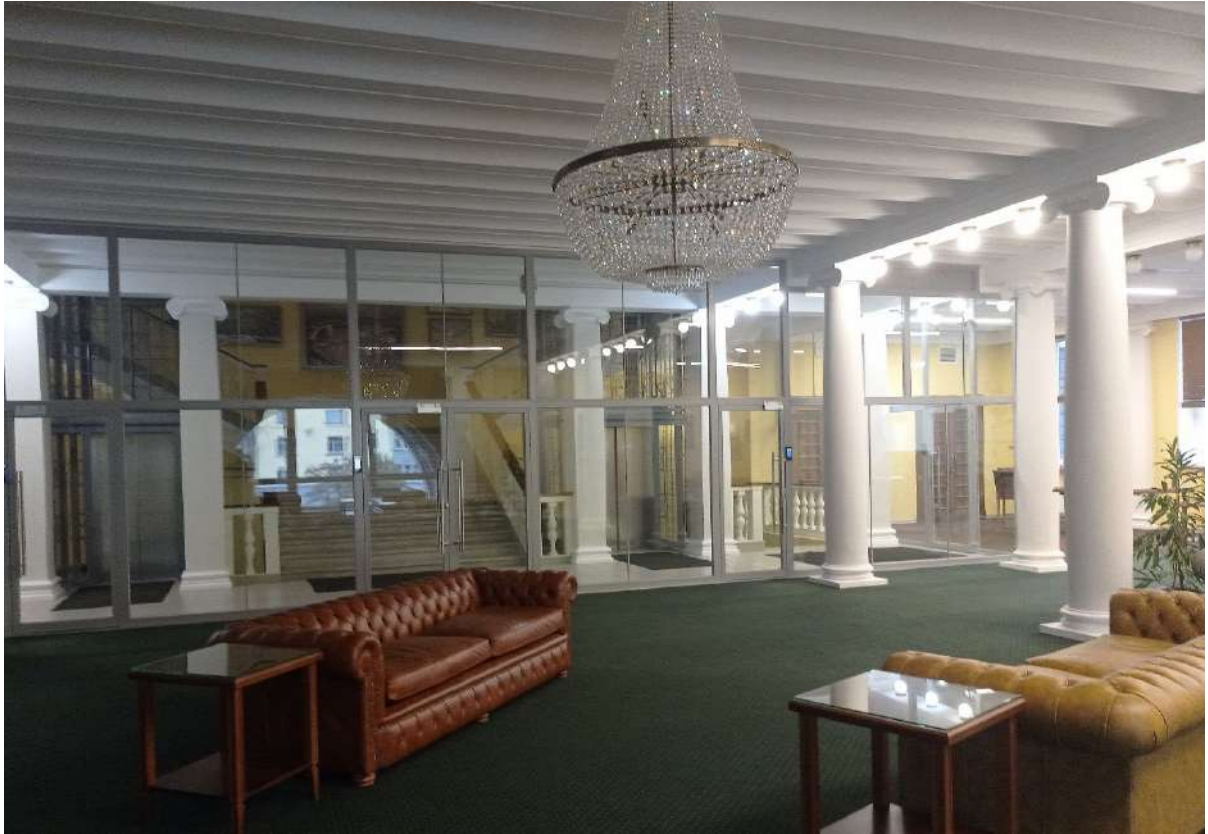
43. ОКНРЗ «Дворец пушкины». Вестибюль второго этажа: колонны коринфского ордера, облицованные искусственным мрамором, поддерживающие потолочные балки; пилястры коринфского ордера. Оформление потолка – балки с профилем по краю. Вид на восток. Дата съемки 18.09.2024.
