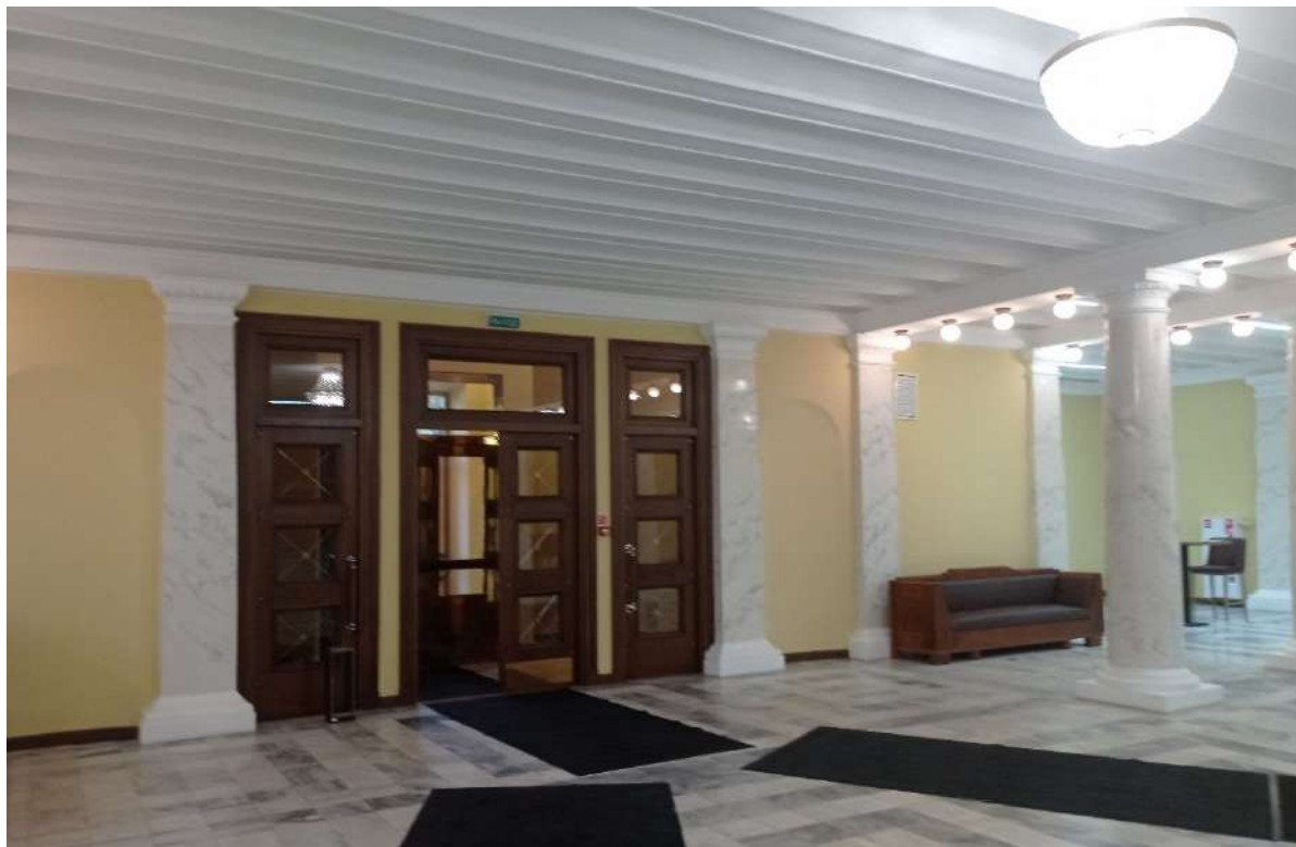
31. ОКНРЗ «Дворец пушкины». Центральный вход: трехчастный дверной проем с деревянным полусветным филленчатым заполнением (центральная часть – двустворчатая). Вид на запад. Дата съемки 18.09.2024.
