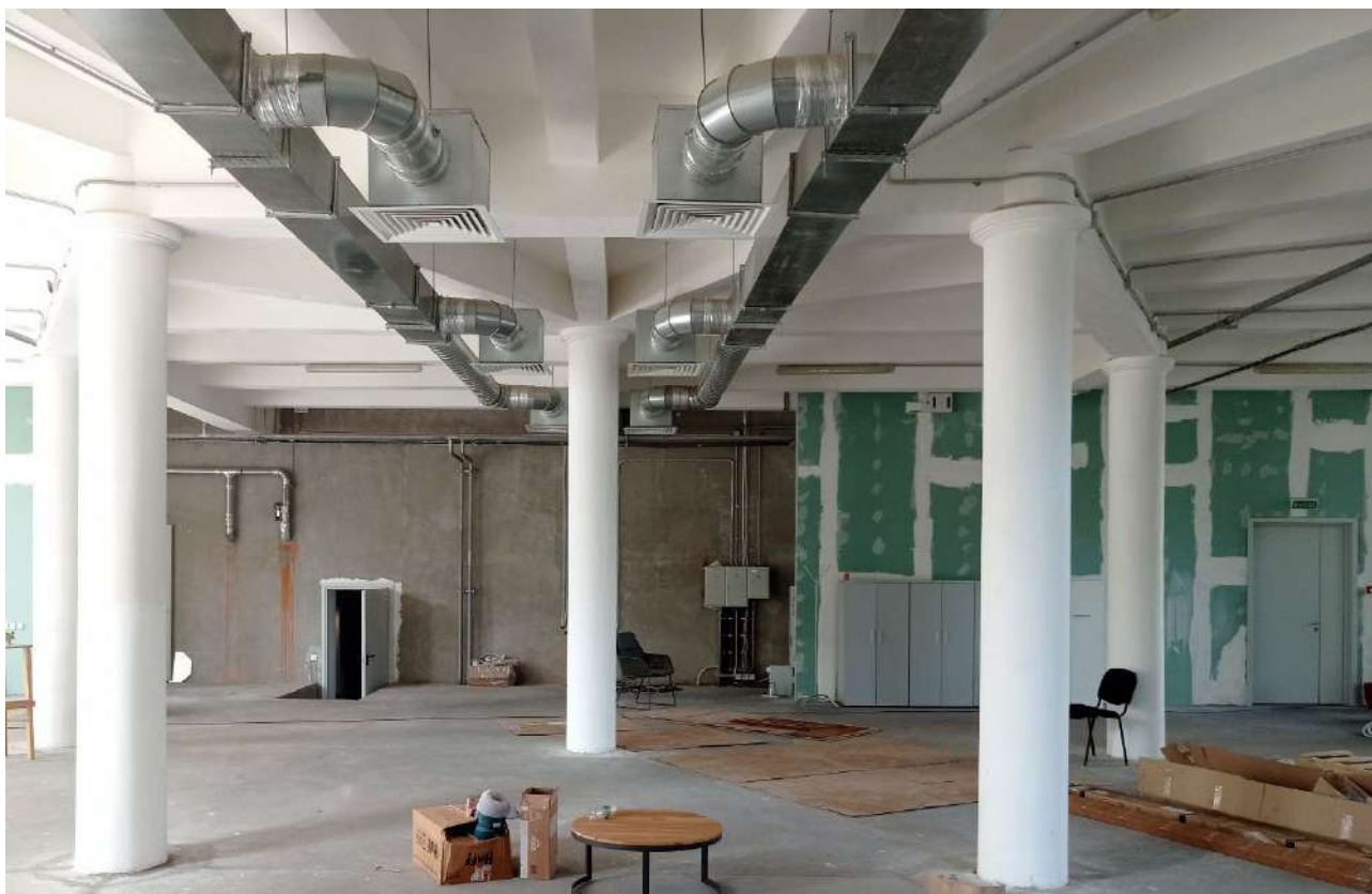
22. ОКНРЗ «Дворец пушнины». Фрагмент помещения под аукционным залом. Элементы конструктивной системы здания – колонны и пилоны. Вид на запад. Дата съемки 18.09.2024.
