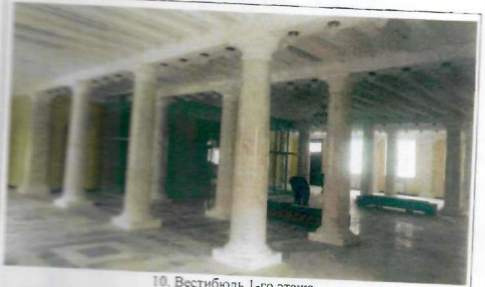
10. Вестибюль 1-го этажа
