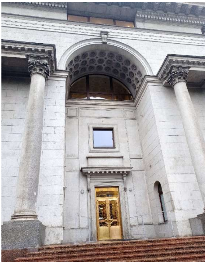
4. ОКНРЗ «Дворец пушнины». Западный фасад. Вид на восток со стороны Московского проспекта. Дата съемки 18.09.2024.
