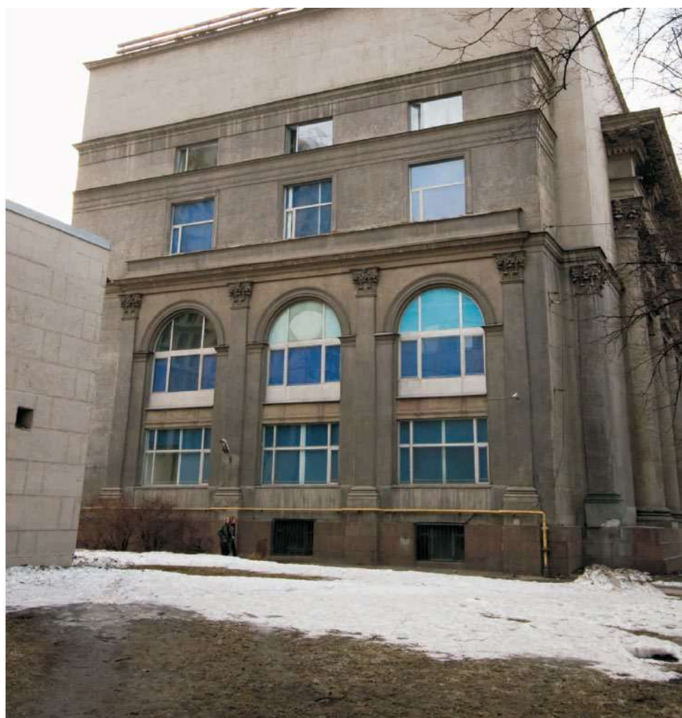
94. Северный фасад. 2010г. ООО «БРК».
