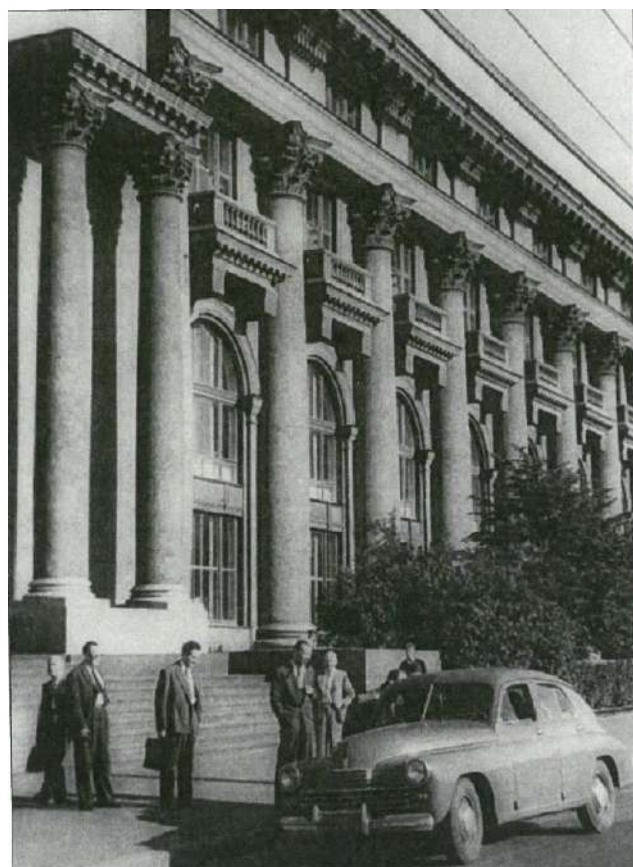
82. Вид части фасада здания «Союзпушнины» на проспекте имени Сталина. 1951г. ЦГАКФФД СПб. Ар 54401.
