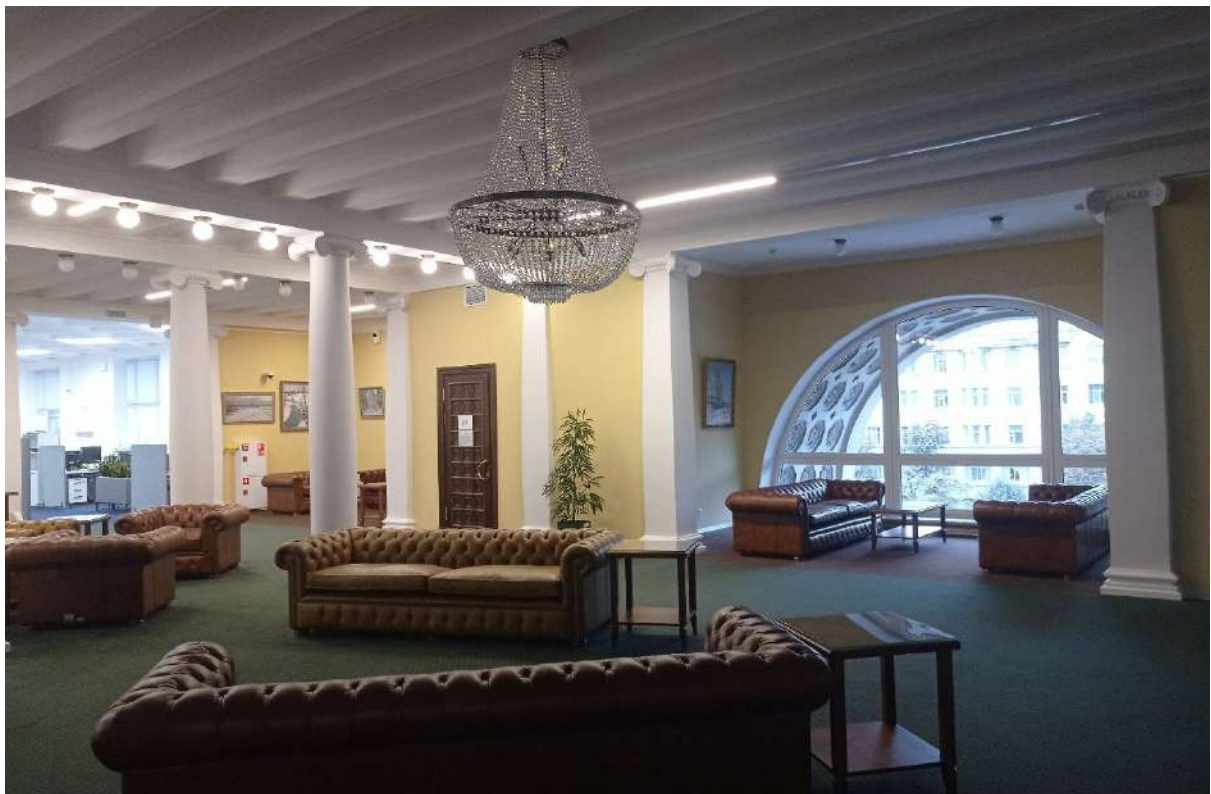
44. ОКНРЗ «Дворец пушкины». Вестибюль второго этажа: колонны коринфского ордера, облицованные искусственным мрамором, поддерживающие потолочные балки; пилястры коринфского ордера. Оформление потолка – балки с профилем по краю. Вид на запад. Дата съемки 18.09.2024.
