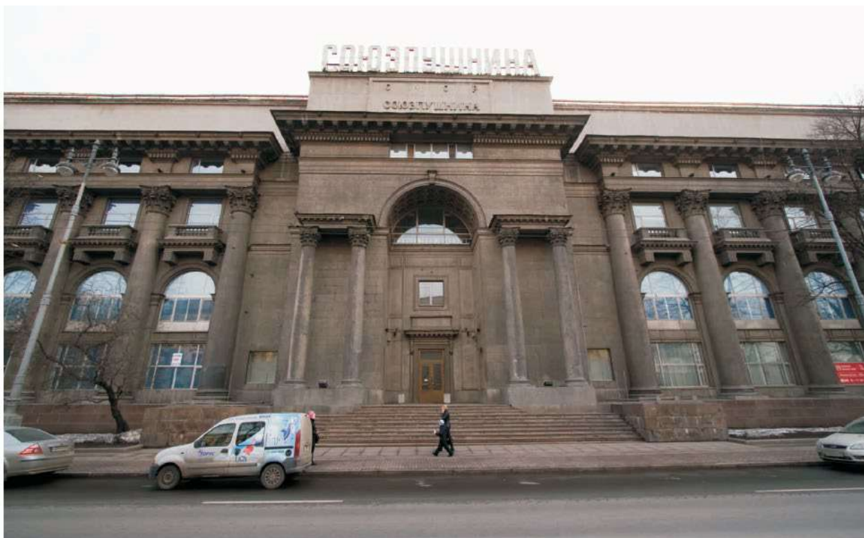
91. Лицевой фасад. Главный вход. 2010г. ООО «БРК».
