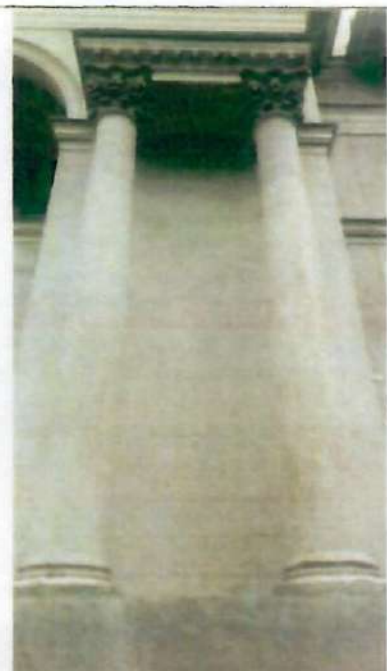
6. Фрагмент оформления западного фасада
