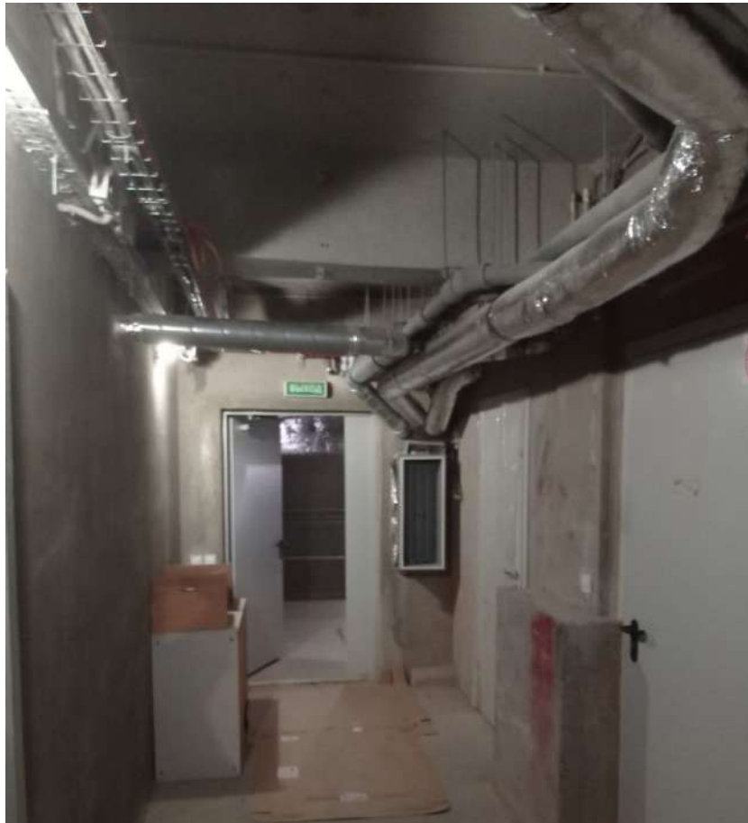
18. ОКНРЗ «Дворец пушнины». Интерьер подвального этажа. Вид на запад. Дата съемки 18.09.2024.
