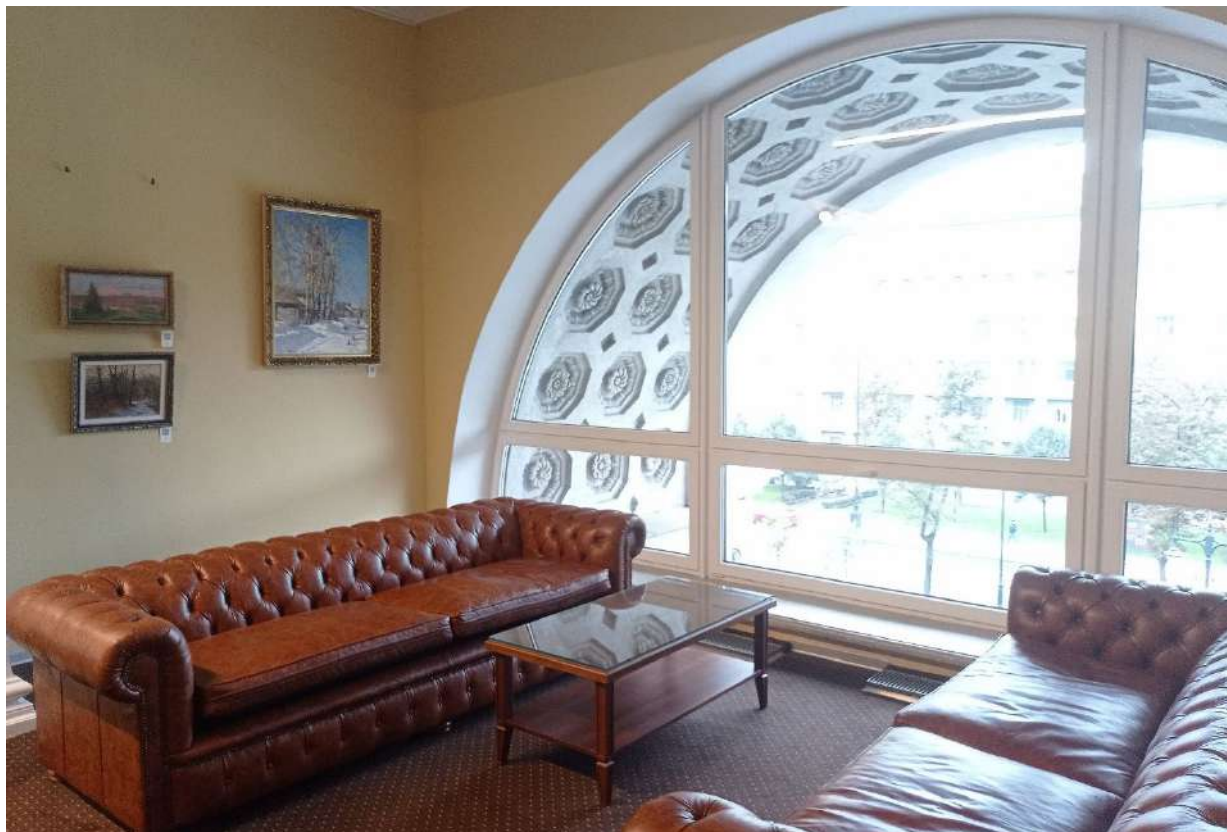
45. ОКНРЗ «Дворец пушнины». Оконный проем с полуциркульным завершением; оформление – профилированные архивольты на импостах, профилированные наличники, филенки и тяги в подоконных простенках; оконное заполнение – рисунок исторической расстекловки. Вид на запад. Дата съемки 18.09.2024.
