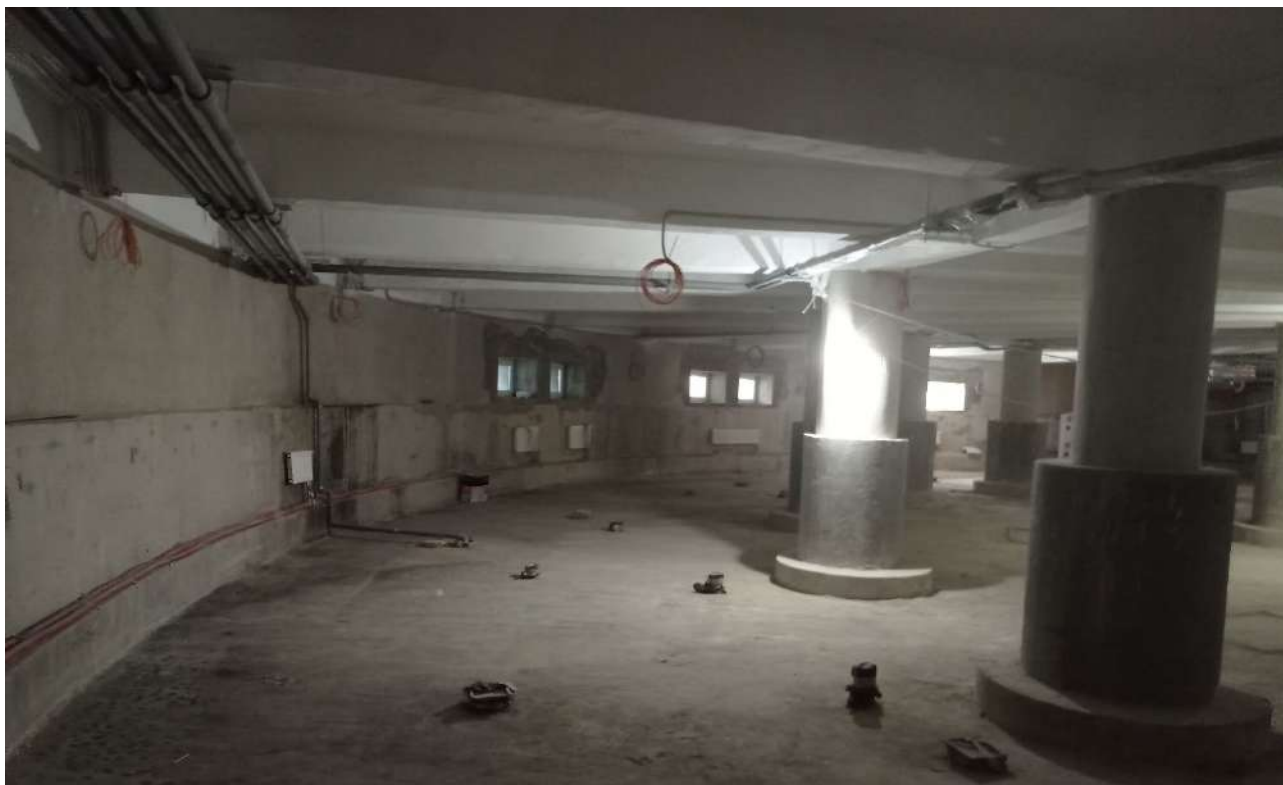
13. ОКНРЗ «Дворец пушнины». Интерьер подвального этажа. Фрагмент конструктивной системы – колонны и историческое перекрытие (перекрестная система железобетонных балок с бетонным заполнением). Вид на юг. Дата съемки 18.09.2024.
