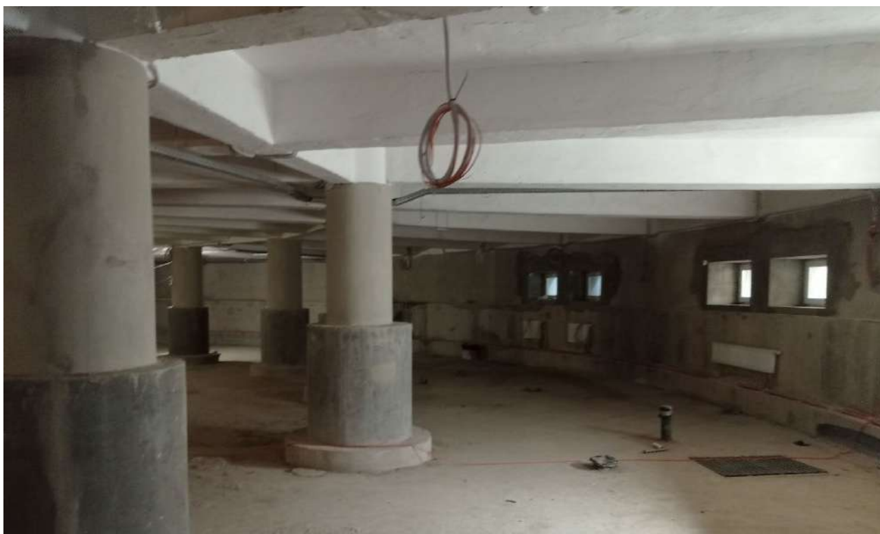
14. ОКНРЗ «Дворец пушнины». Интерьер подвального этажа. Фрагмент конструктивной системы – колонны и историческое перекрытие (перекрестная система железобетонных балок с бетонным заполнением). Вид на север. Дата съемки 18.09.2024.
