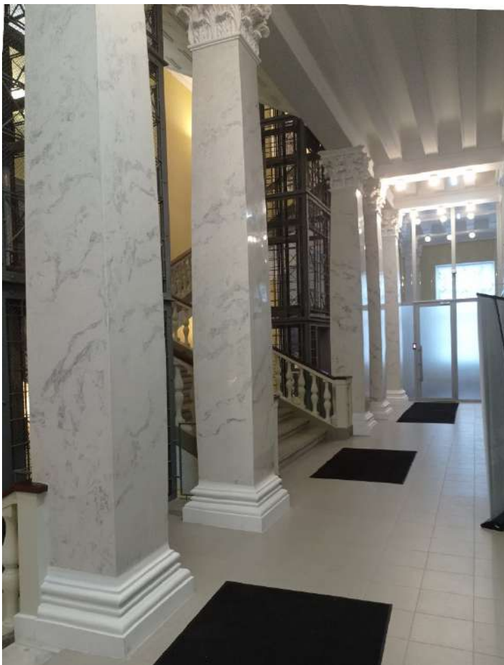
41. ОКНРЗ «Дворец пушнины». Помещение парадной лестницы. Вид на юг. Дата съемки 18.09.2024.
