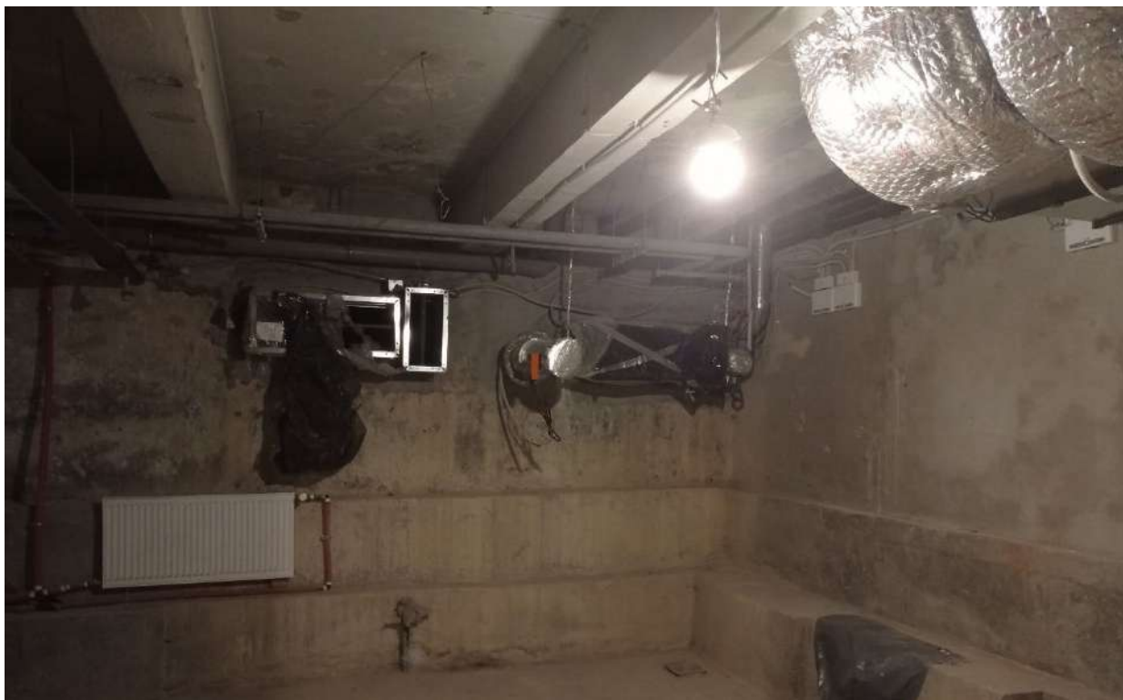
19. ОКНРЗ «Дворец пушнины». Интерьер подвального этажа. Дата съемки 18.09.2024.
