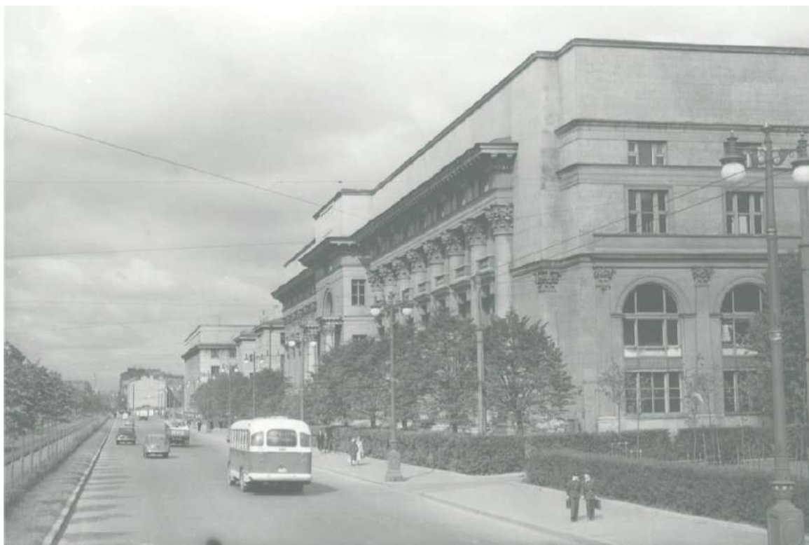
85. Вид на здание Дворца пушнины с юго-запада. 1960-е гг. ЦГАКФФД СПб. Вр 35578.
