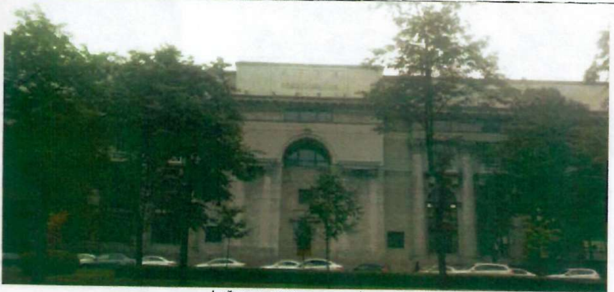
1. Фрагмент западного фасада
