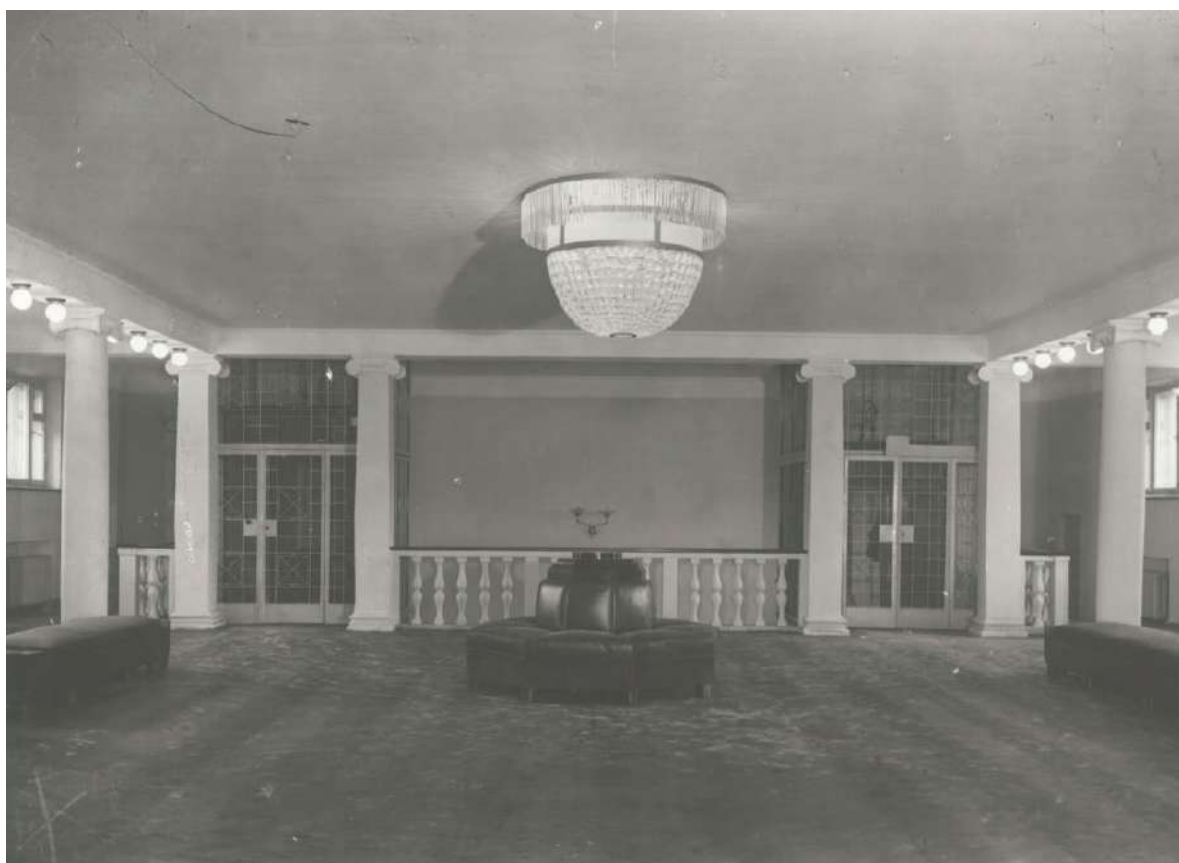
58. Холл 4-го этажа. Вид на балюстраду перильного ограждения парадной лестницы и лифтовые шахты. 1938г. ЦГАКФФД СПб. Вр 37453.
