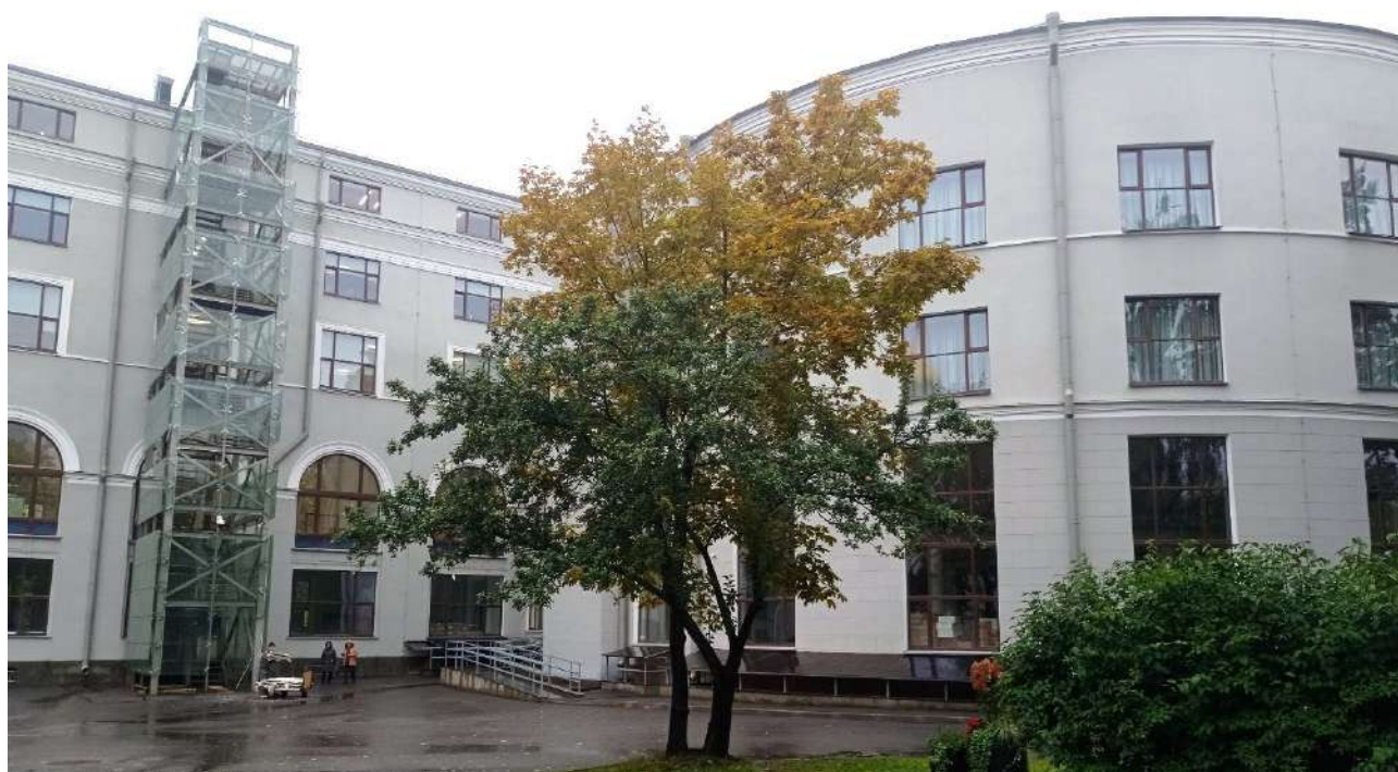
12. ОКНРЗ «Дворец пушкины». Фрагмент восточного фасада. Вид на северо-запад. Дата съёмки 18.09.2024.
