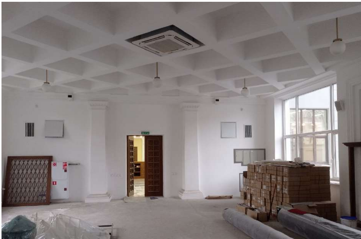
35. ОКНРЗ «Дворец пушнины». Оформление потолка – глубокие кессоны. Вид на юг. Дата съемки 18.09.2024.
