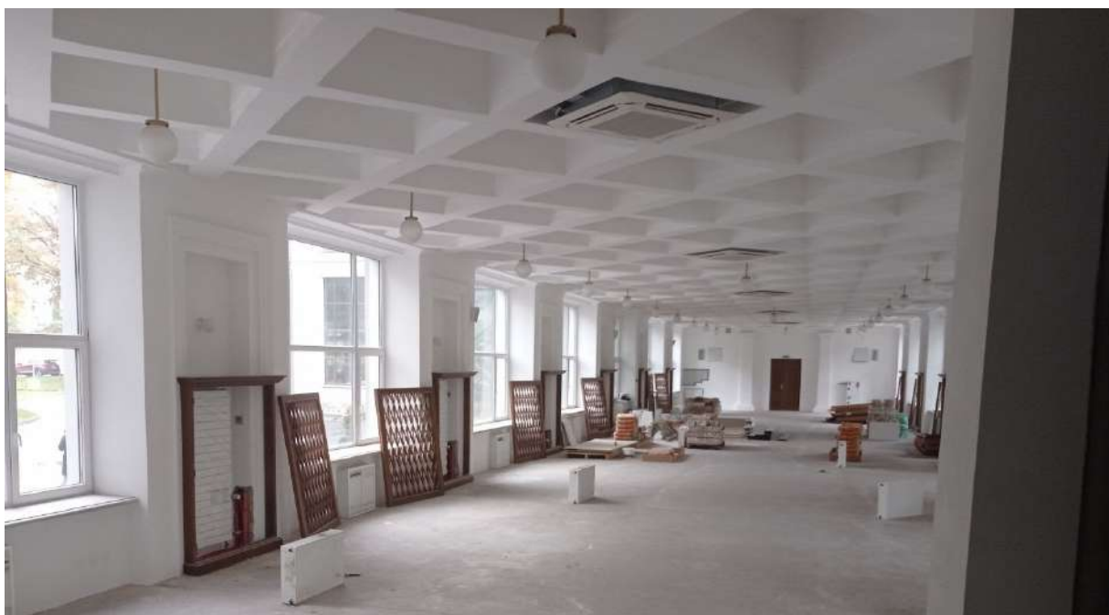
36. ОКНРЗ «Дворец пушнины». Оформление потолка – глубокие кессоны. Ниши в межоконных простенках в профилированных наличниках с деревянными радиаторными решетками сложного рисунка (ромбовидная сетка). Вид на юг. Дата съемки 18.09.2024.
