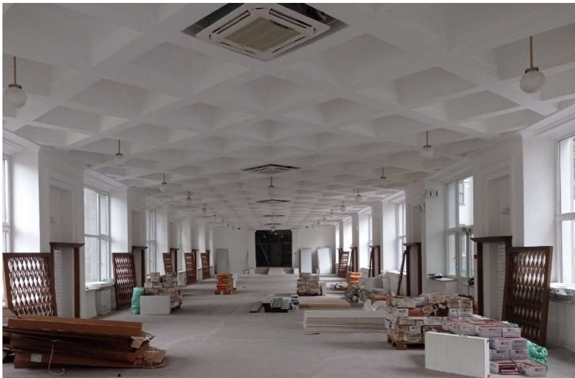
37. ОКНРЗ «Дворец пушнины». Оформление потолка – глубокие кессоны. Ниши в межконных простенках в профилированных наличниках с деревянными радиаторными решетками сложного рисунка (ромбовидная сетка). Вид на север. Дата съемки 18.09.2024.
