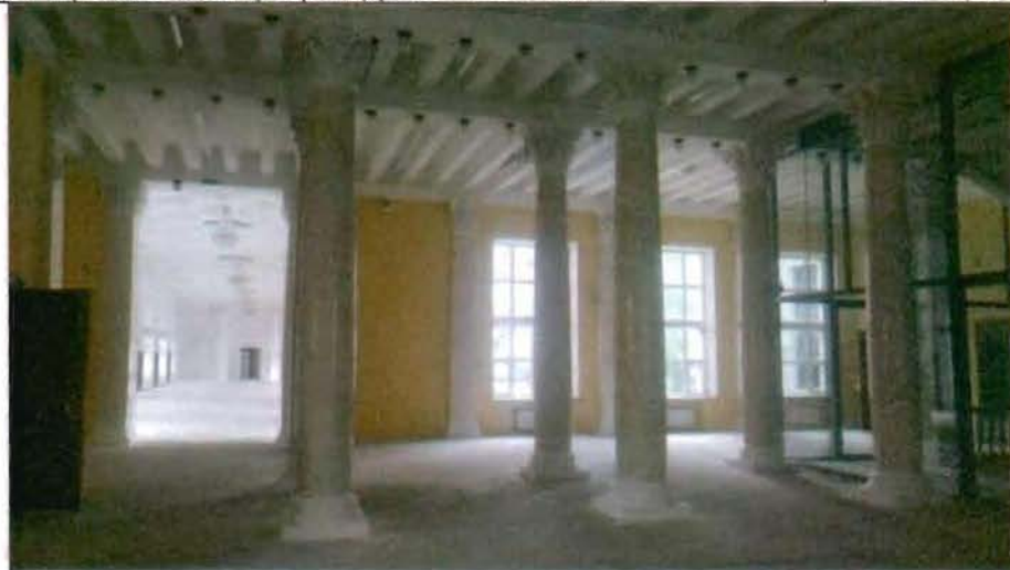
13. Фрагмент интерьера в уровне 2-го этажа
