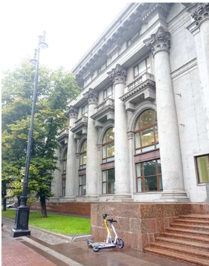
6. ОКНРЗ «Дворец пушнины». Западный фасад. Вид на северо-восток со стороны Московского проспекта. Дата съемки 18.09.2024.
