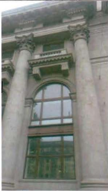
4. Фрагмент оформления западного фасада
