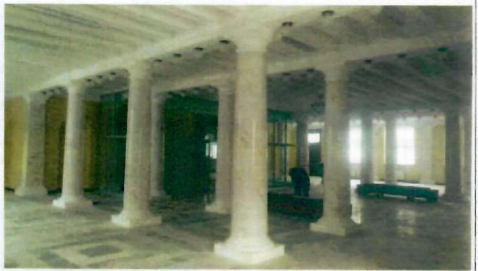
10. Вестибюль 1-го этажа
