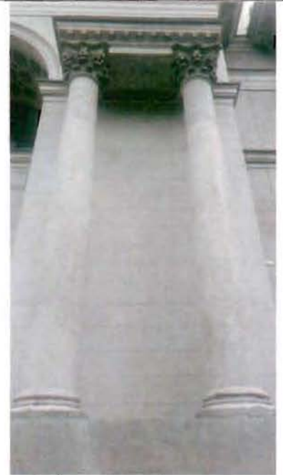
6. Фрагмент оформления западного фасада
