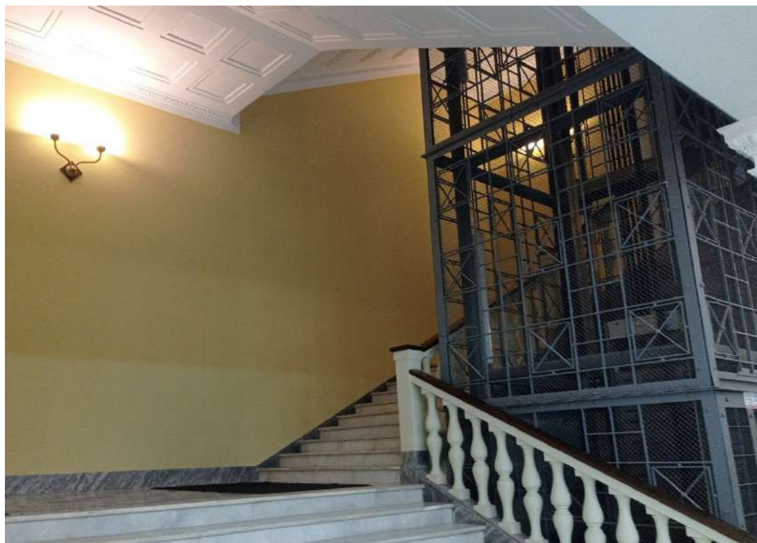
40. ОКНРЗ «Дворец пушнины». Помещение парадной лестницы: мраморная облицовка ступеней и межлестничных площадок, балюстрада парадной лестницы, деревянные профилированные перила; ограждение лифтовых шахт в виде металлических каркасов геометрического рисунка. Дата съемки 18.09.2024.
