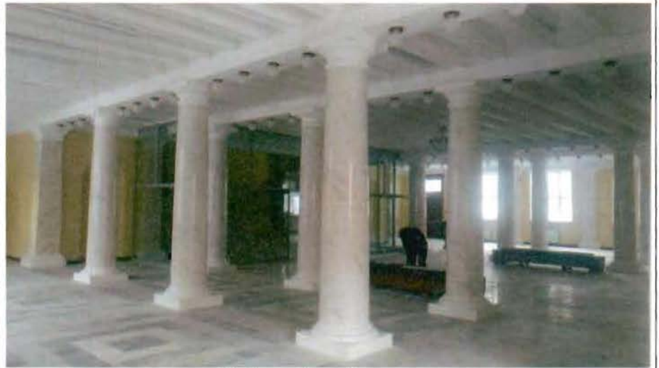
10. Вестибюль 1-го этажа
