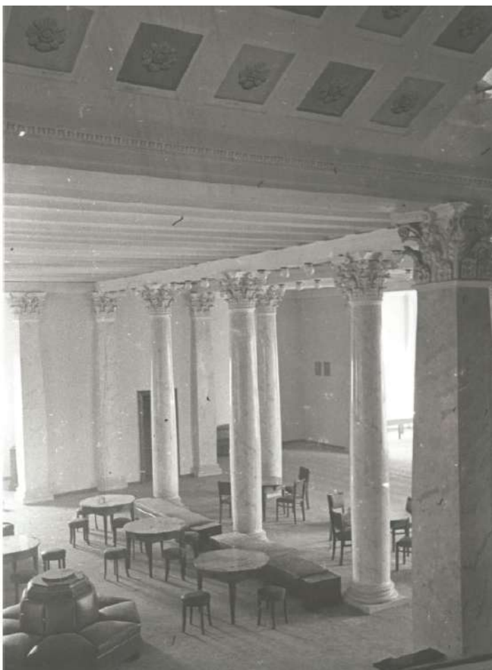
55. Вид на холл 2-го этажа с площадки парадной лестницы. 1938г. ЦГАКФФД СПб. Ар 129354.
