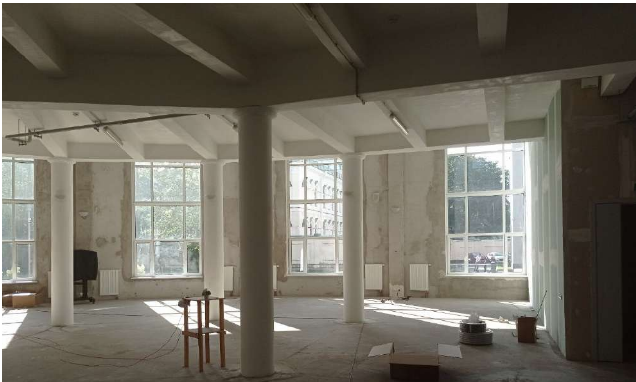
23. ОКНРЗ «Дворец пушнины». Фрагмент помещения под аукционным залом. Элементы конструктивной системы здания – колонны и пилоны. Вид на юг. Дата съемки 18.09.2024.
