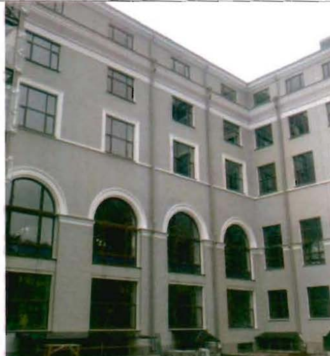
3. Фрагмент восточного фасада
