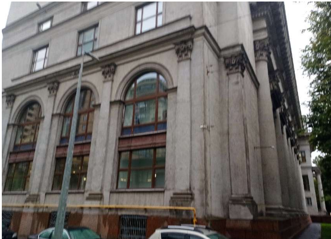
8. ОКНРЗ «Дворец пушнины». Фрагмент угловой части западного и южного фасадов. Вид на юг со стороны Московского проспекта. Дата съемки 18.09.2024.
