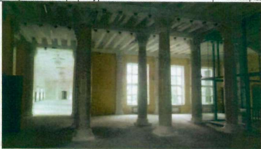
13. Фрагмент интерьера в уровне 2-го этажа
