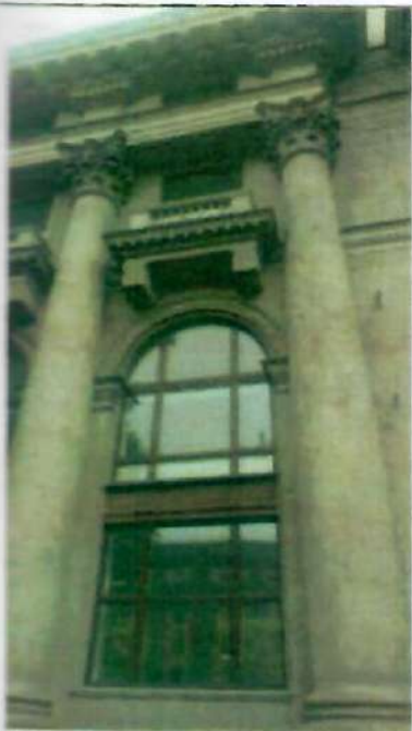
4. Фрагмент оформления западного фасада
