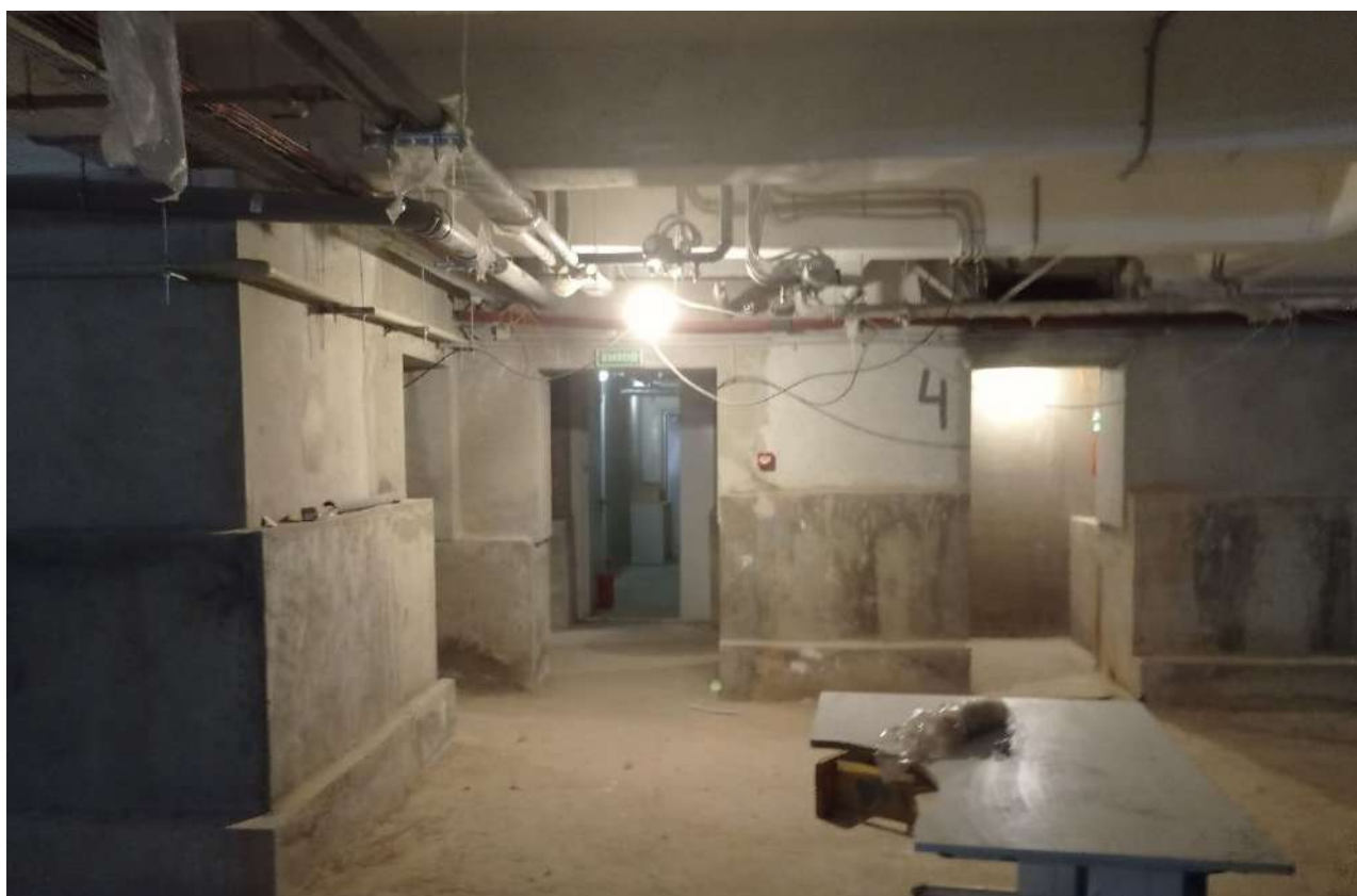
16. ОКНРЗ «Дворец пушнины». Интерьер подвального этажа. Вид на запад. Дата съемки 18.09.2024.
