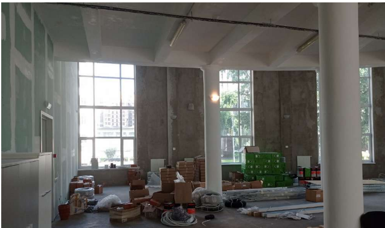
24. ОКНРЗ «Дворец пушнины». Фрагмент помещения под аукционным залом. Элементы конструктивной системы здания – колонны и пилоны. Вид на север. Дата съемки 18.09.2024.
