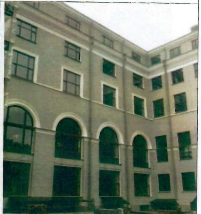
3. Фрагмент восточного фасада
