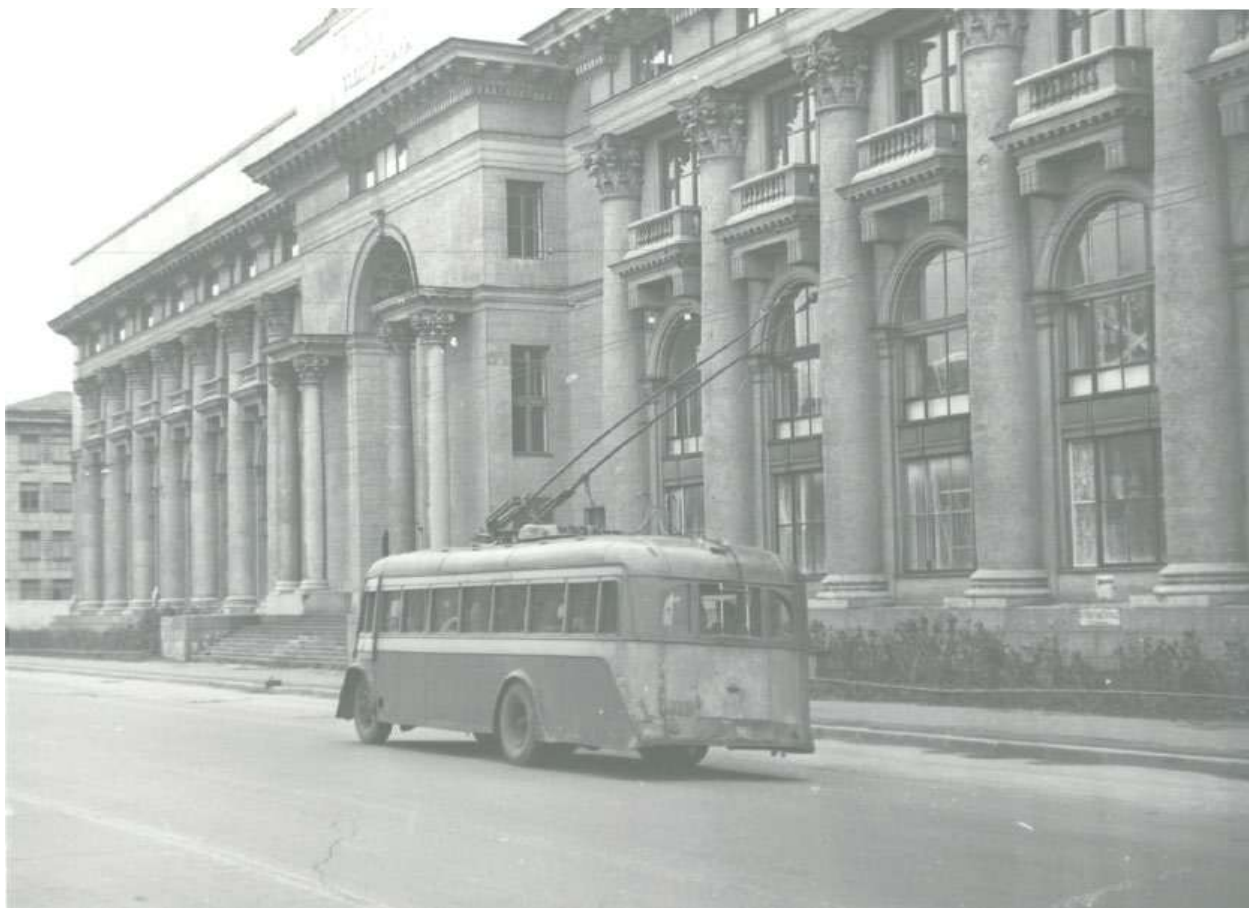
79. Вид фасада Дворца пушкины на Международном проспекте, где в аукционном и выставочном залах проводятся реставрационные работы. 1945г. ЦГАКФФД СПб. Ар 6848.
