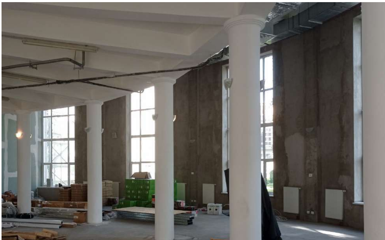
25. ОКНРЗ «Дворец пушнины». Фрагмент помещения под аукционным залом. Элементы конструктивной системы здания – колонны и пилоны. Вид на восток. Дата съемки 18.09.2024.
