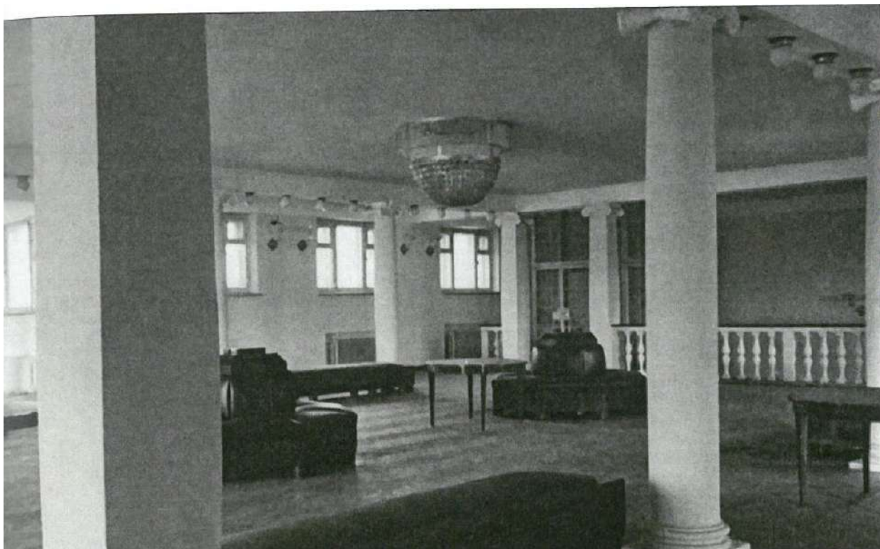
60. Холл 4-го этажа. Колонны ионического ордера. 1938г. ЦГАКФФД СПб. Ар 129351.
