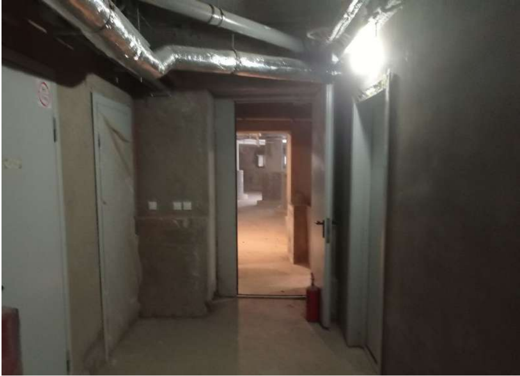
17. ОКНРЗ «Дворец пушнины». Интерьер подвального этажа. Вид на восток. Дата съемки 18.09.2024.
