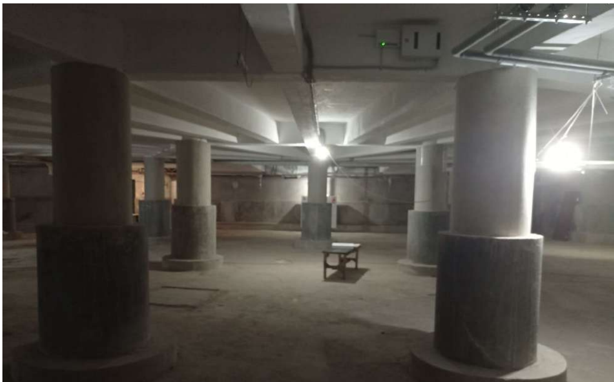
15. ОКНРЗ «Дворец пушнины». Интерьер подвального этажа. Фрагмент конструктивной системы – колонны и историческое перекрытие (перекрестная система железобетонных балок с бетонным заполнением). Вид на запад. Дата съемки 18.09.2024.
