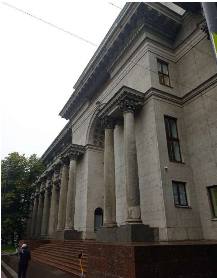
5. ОКНРЗ «Дворец пушнины». Западный фасад. Вид на северо-восток со стороны Московского проспекта. Дата съемки 18.09.2024.
