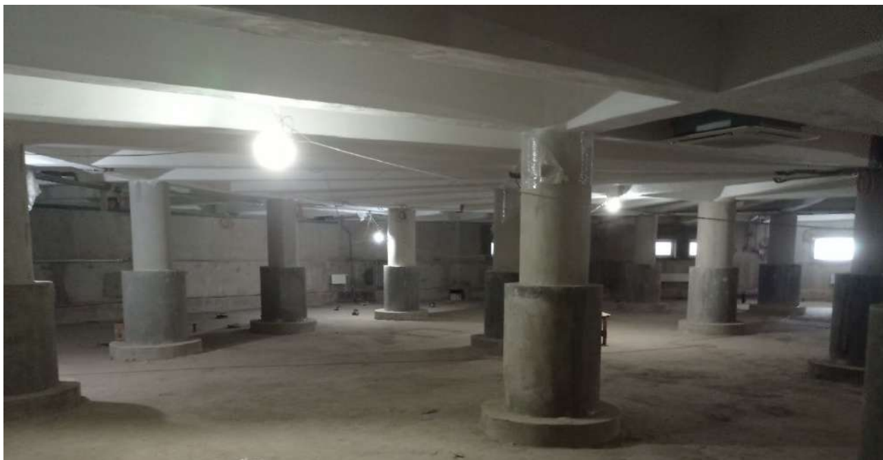
20. ОКНРЗ «Дворец пушнины». Интерьер подвального этажа. Фрагмент конструктивной системы – колонны. Вид на юг. Дата съемки 18.09.2024.
