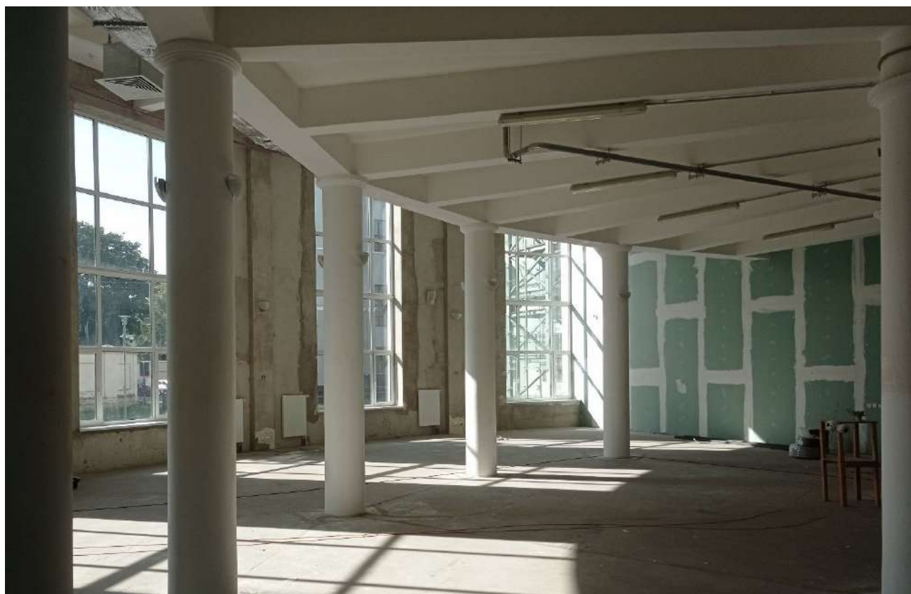
26. ОКНРЗ «Дворец пушнины». Фрагмент помещения под аукционным залом. Элементы конструктивной системы здания – колонны и пилоны. Вид на юг. Дата съемки 18.09.2024.
