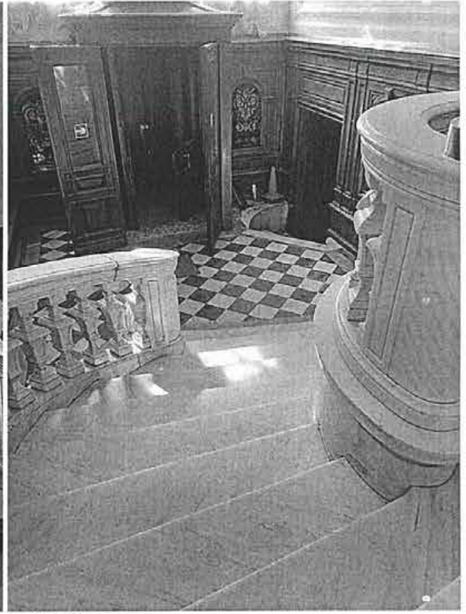
15. Парадная мраморная лестница, нижняя часть стен обшита деревянными панелями
