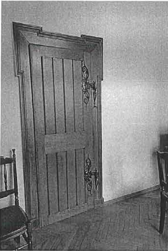
22. Одностворчатая дверь с фигурным наличником и накладными ажурными петлями
