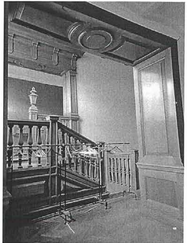
23. Проем оформленный деревянными филенками
