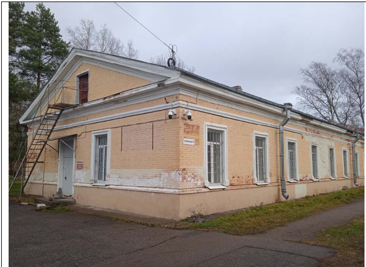
1. «Кухня». Общий вид.
