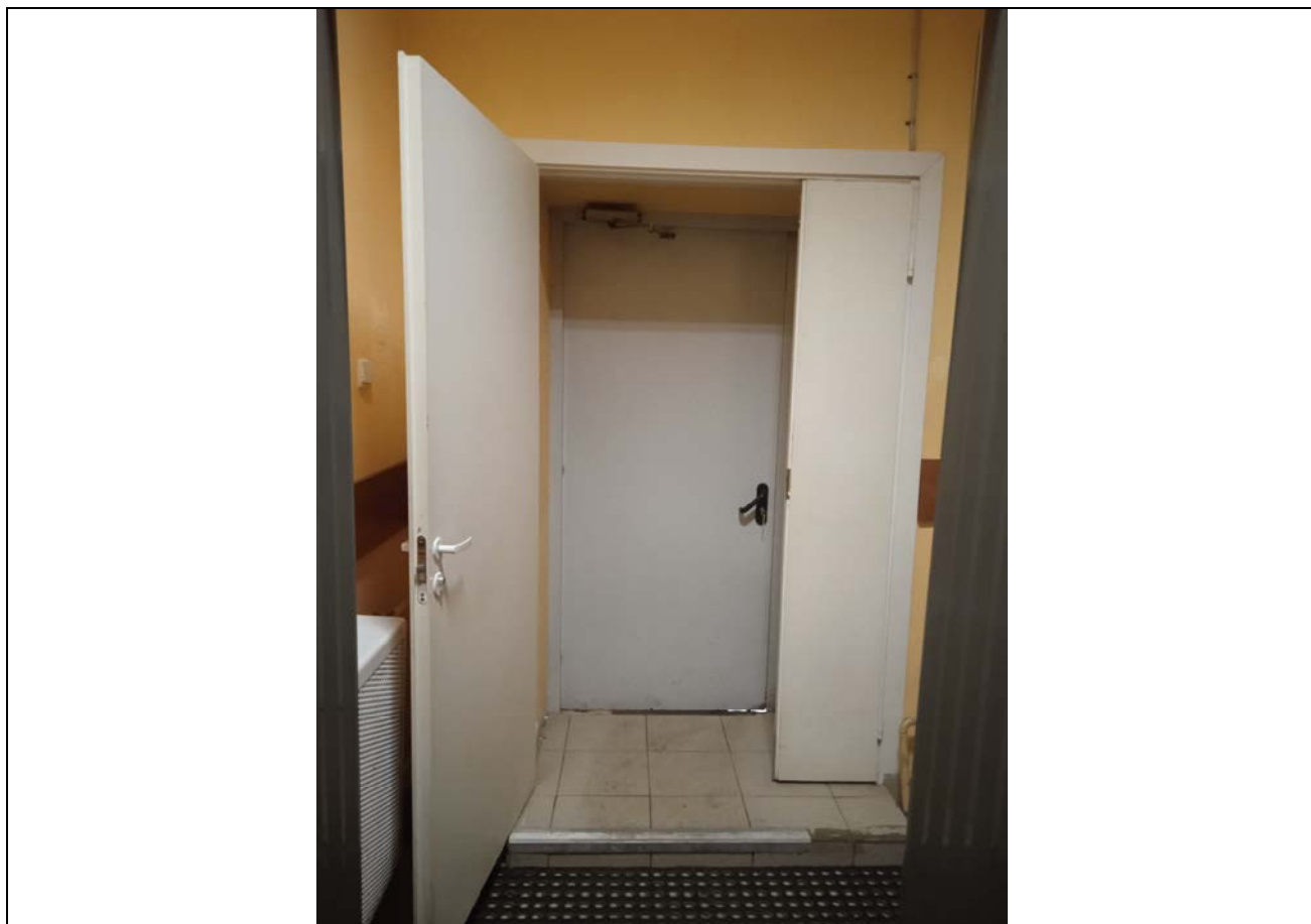
7. «Кухня». Тамбур. Входная дверь.
