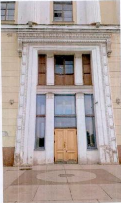
9. Входной портал с западной стороны
