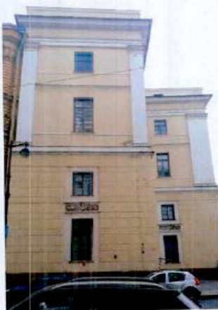
6. Северный фасад здания
