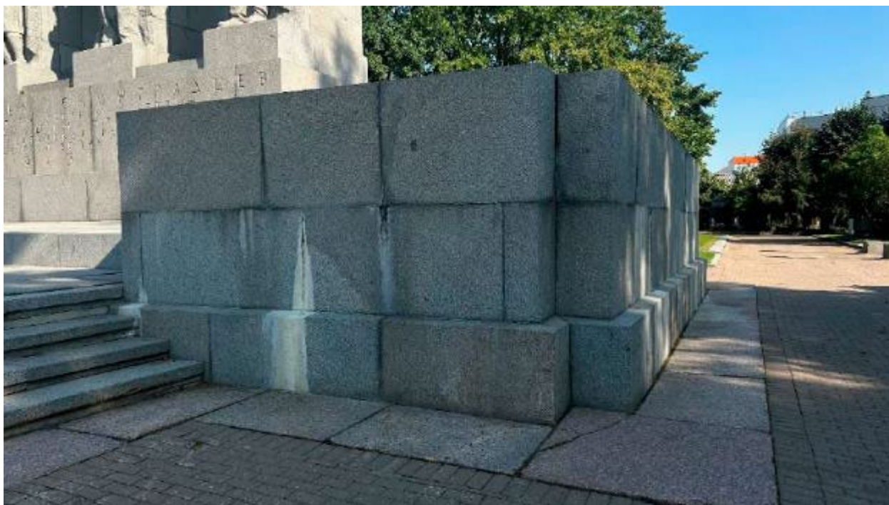
11. Вид с запада на объект культурного наследия федерального значения «Братские могилы защитников и жителей г. Ленинграда, погибших во время блокады 1941-1944 гг.», расположенного по адресу: г. Санкт-Петербург, Серебряков переулок, д. 1, литера А. 26.08.2024
