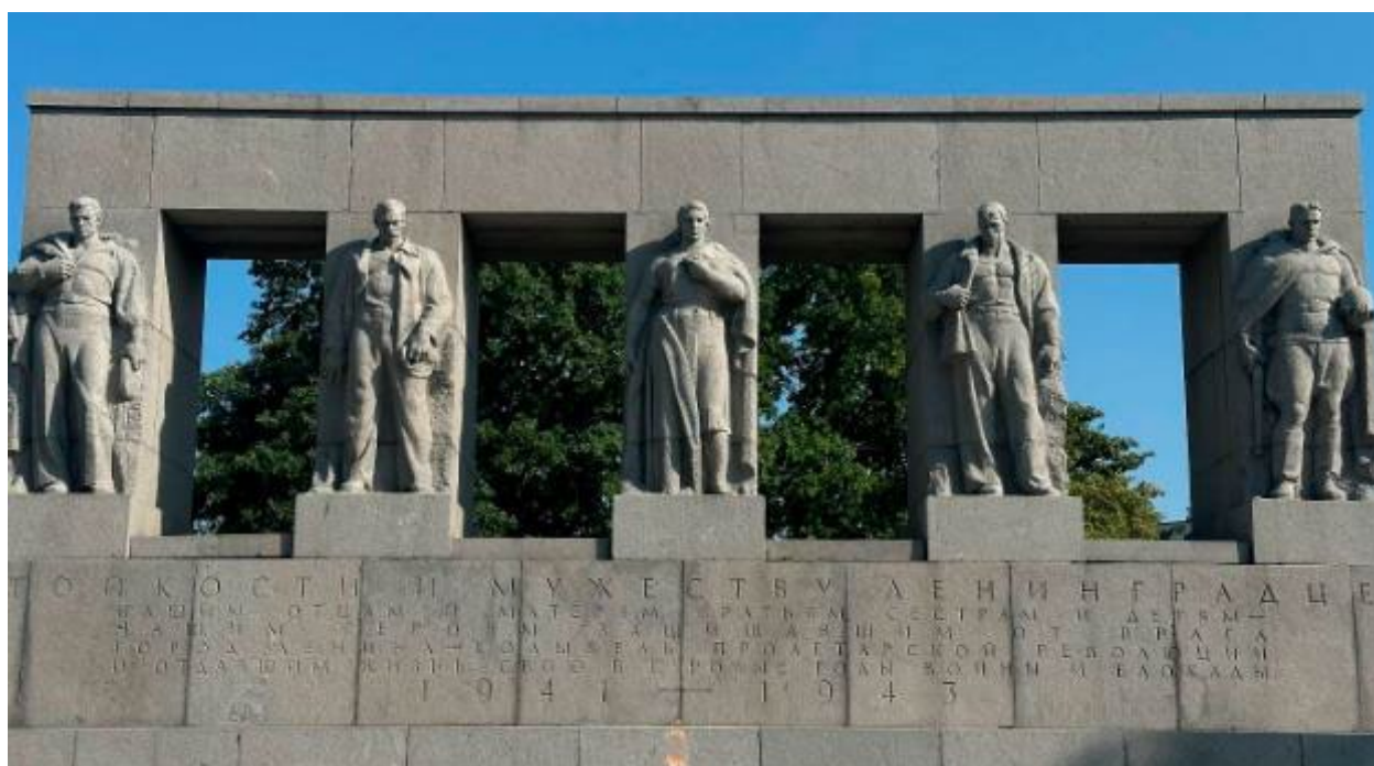
2. Вид с запада на объект культурного наследия федерального значения «Братские могилы защитников и жителей г. Ленинграда, погибших во время блокады 1941-1944 гг.», расположенного по адресу: г. Санкт-Петербург, Серебряков переулок, д. 1, литера А. 26.08.2024
