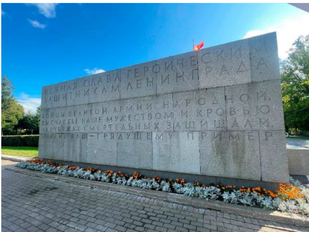
17. Южные пропилеи объекта культурного наследия федерального значения «Братские могилы защитников и жителей г. Ленинграда, погибших во время блокады 1941-1944 гг.», расположенного по адресу: г. Санкт-Петербург, Серебряков переулок, д. 1, литера А. 26.08.2024
