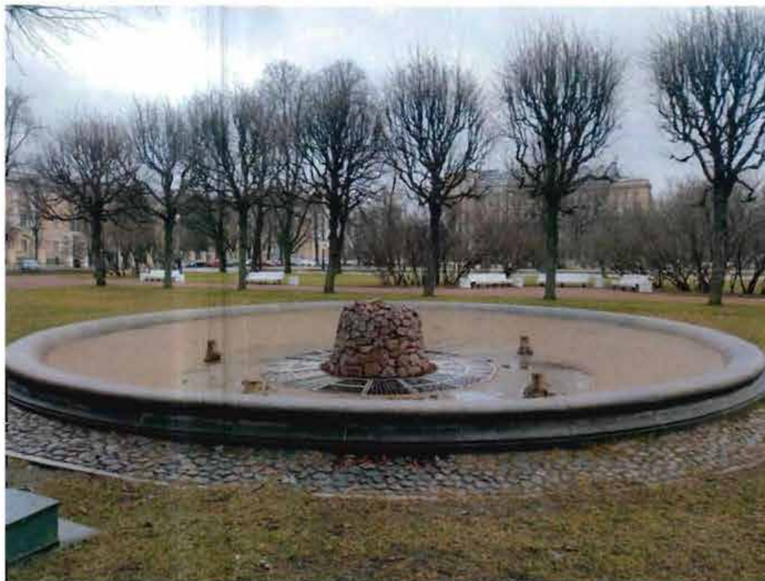
4. Фонтан, расположенный по адресу: г. Санкт-Петербург, аллея Смольного, дом 2, сооружение 2, литера Ф: Вид с северо-запада.
