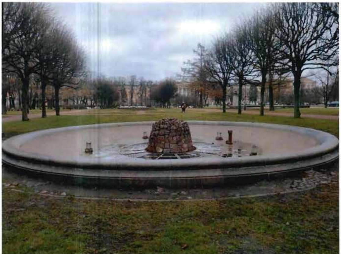
3. Фонтан, расположенный по адресу: г. Санкт-Петербург, аллея Смольного, дом 2, сооружение 1, литера Ф: Вид с запада.
