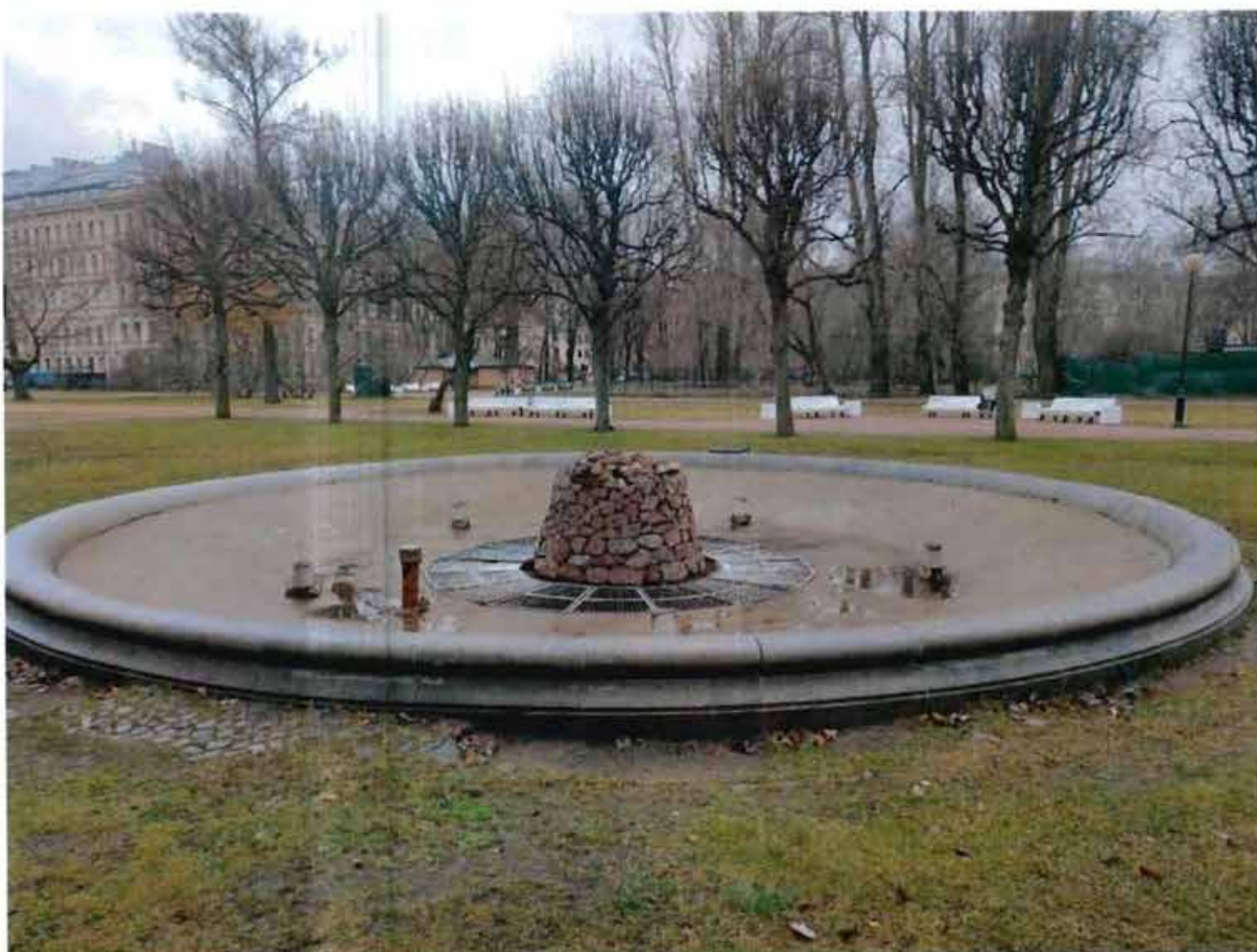
1. Фонтан, расположенный по адресу: г. Санкт-Петербург, аллея Смольного, дом 1, сооружение 1, литера Ф. Вид с северо-запада.
