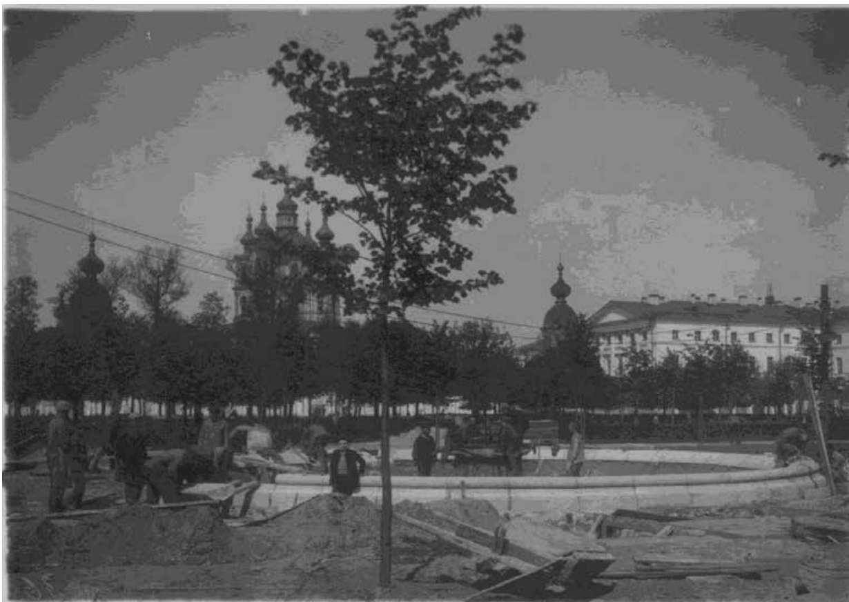
4. Группа рабочих на постройке фонтана у Смольного. Фонтан - 1933–1934 гг., архитекторы В. А. Шуко и В. Г. Гельфрейх. // ЦГАКФФД СПб. Гр 42624. Дата съёмки: 1934 г.
