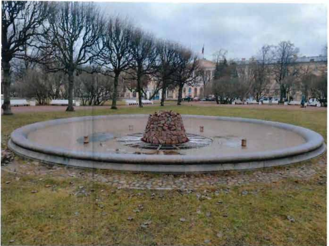
2. Фонтан, расположенный по адресу: г. Санкт-Петербург, аллея Смольного, дом 1, сооружение 2, литера Ф. Вид с запада.
