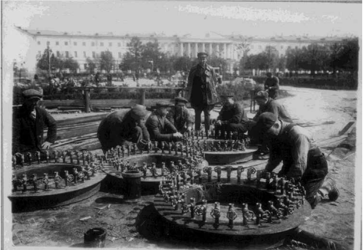
6. Установка кранов в бассейне фонтана у Смольного института на площади Диктатуры. // ЦГАКФФД СПб. Гр 42626. Дата съёмки: 1934 г.
