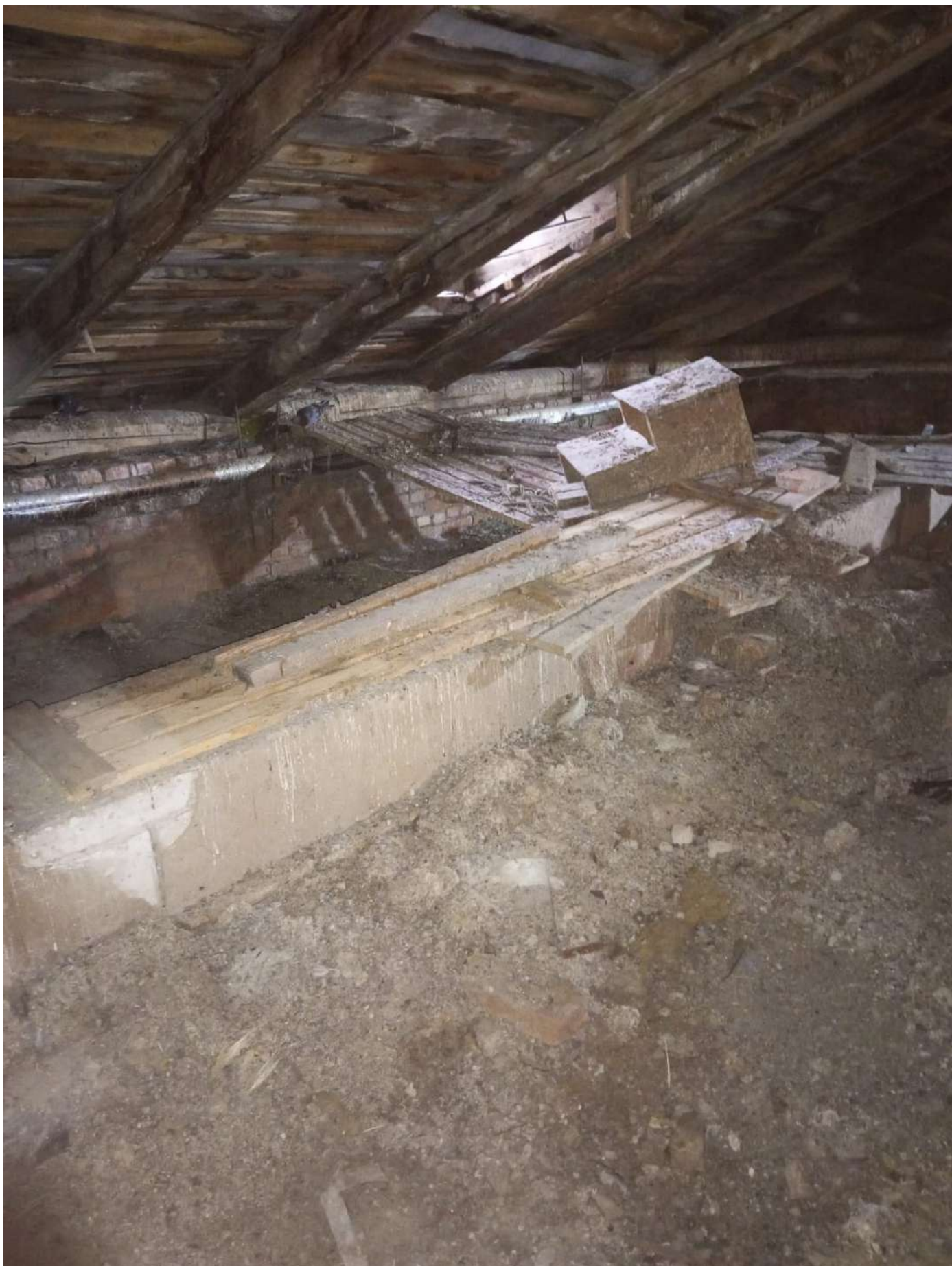
Фото 19. Общий вид чердачного пространства. Дата фотофиксации - 28.09.2024г.
