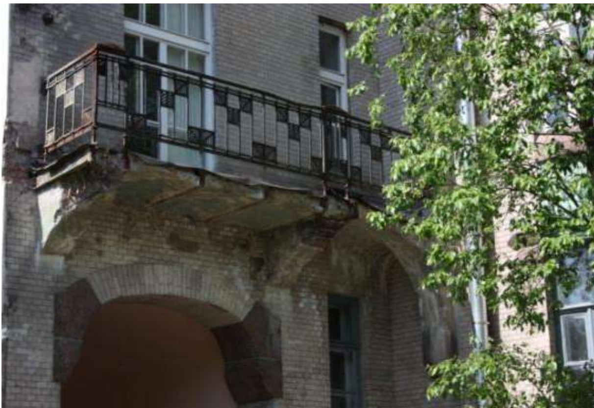
9. Фрагмент дворового фасада. Фото 13.06.2009. https://www.citywalls.ru/
