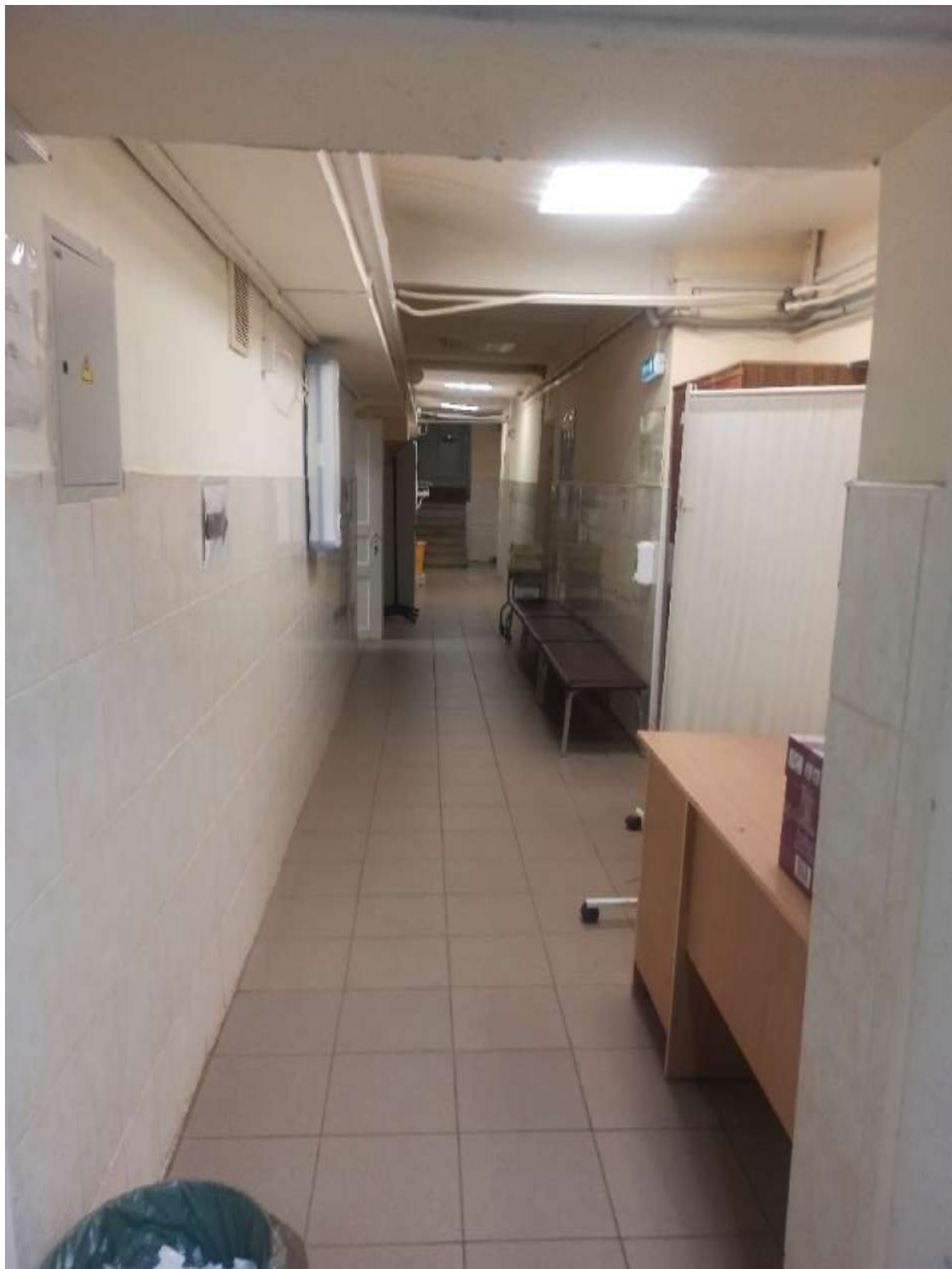
Фото 17. Общий вид 3-го этажа в зоне проектирования. Пом. № 155 по плану ПИБ. Дата фотофиксации - 28.09.2024г.
