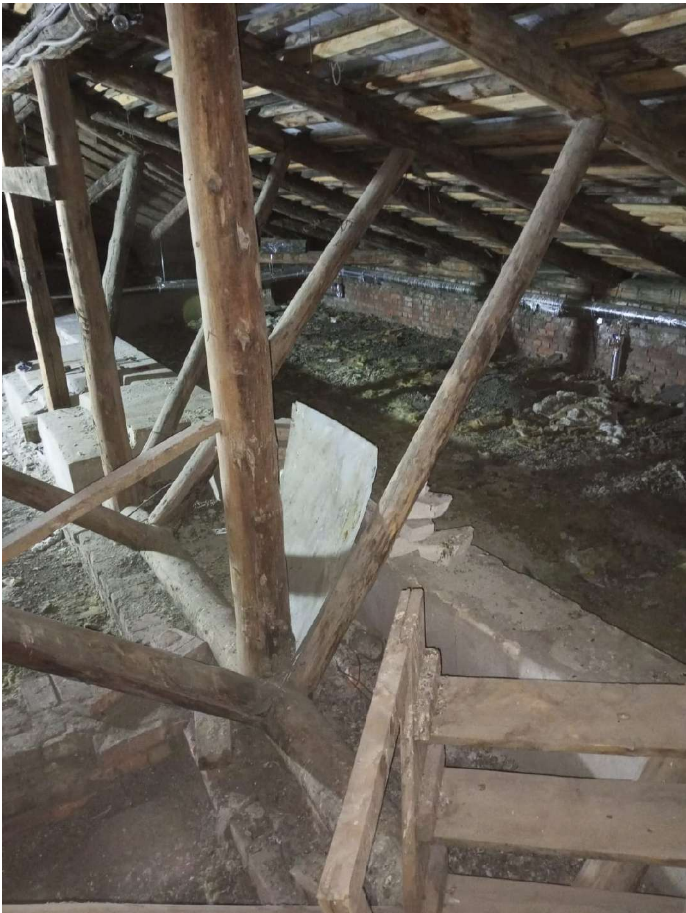
Фото 20. Общий вид чердачного пространства. Дата фотофиксации - 28.09.2024г.
