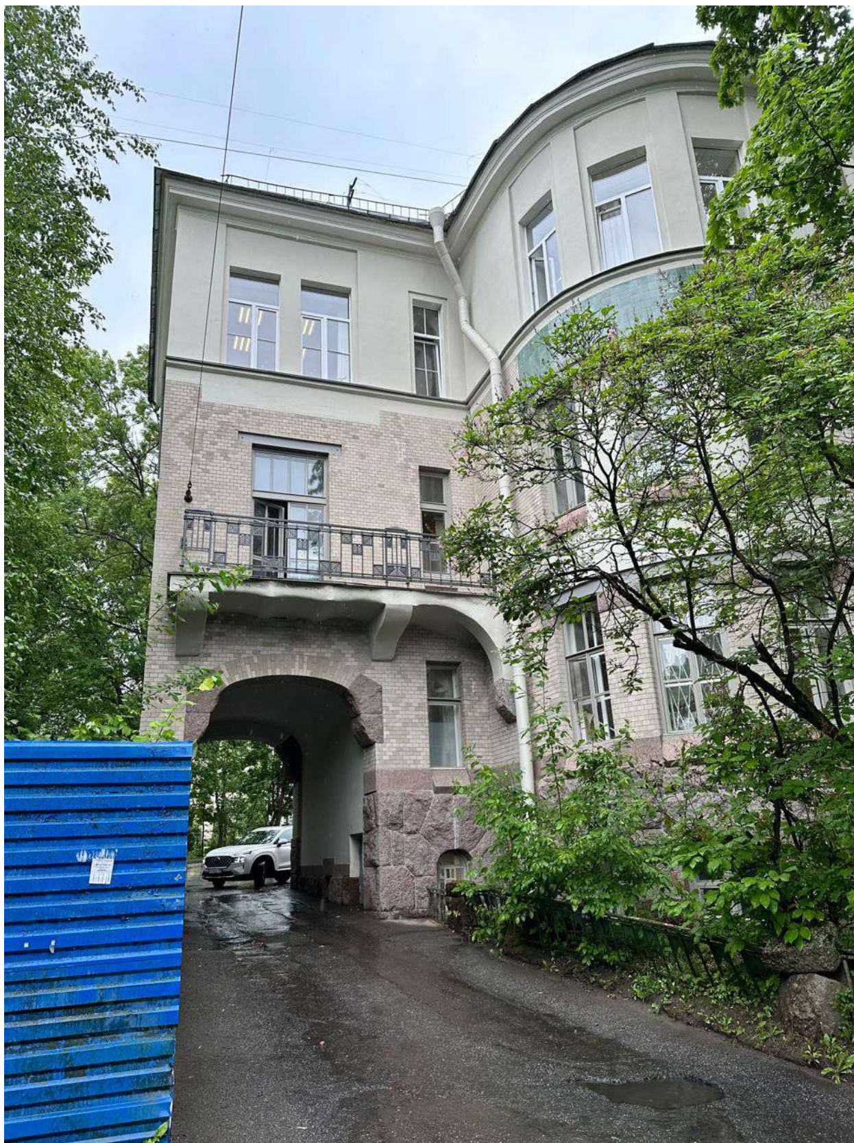
Фото 1. Общий вид на лицевой фасад объекта. Дата фотофиксации - 28.09.2024г.
