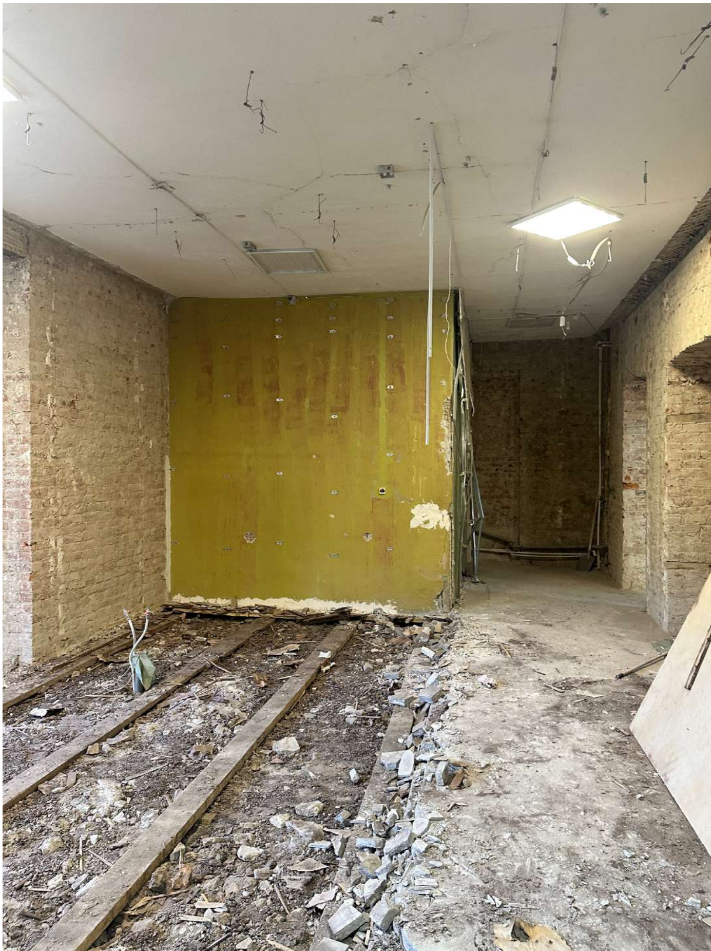
Фото 7. Общий вид 1-го этажа в зоне проектирования. Пом. № 25-26 по плану ПИБ. Дата фотофиксации - 28.09.2024г.
