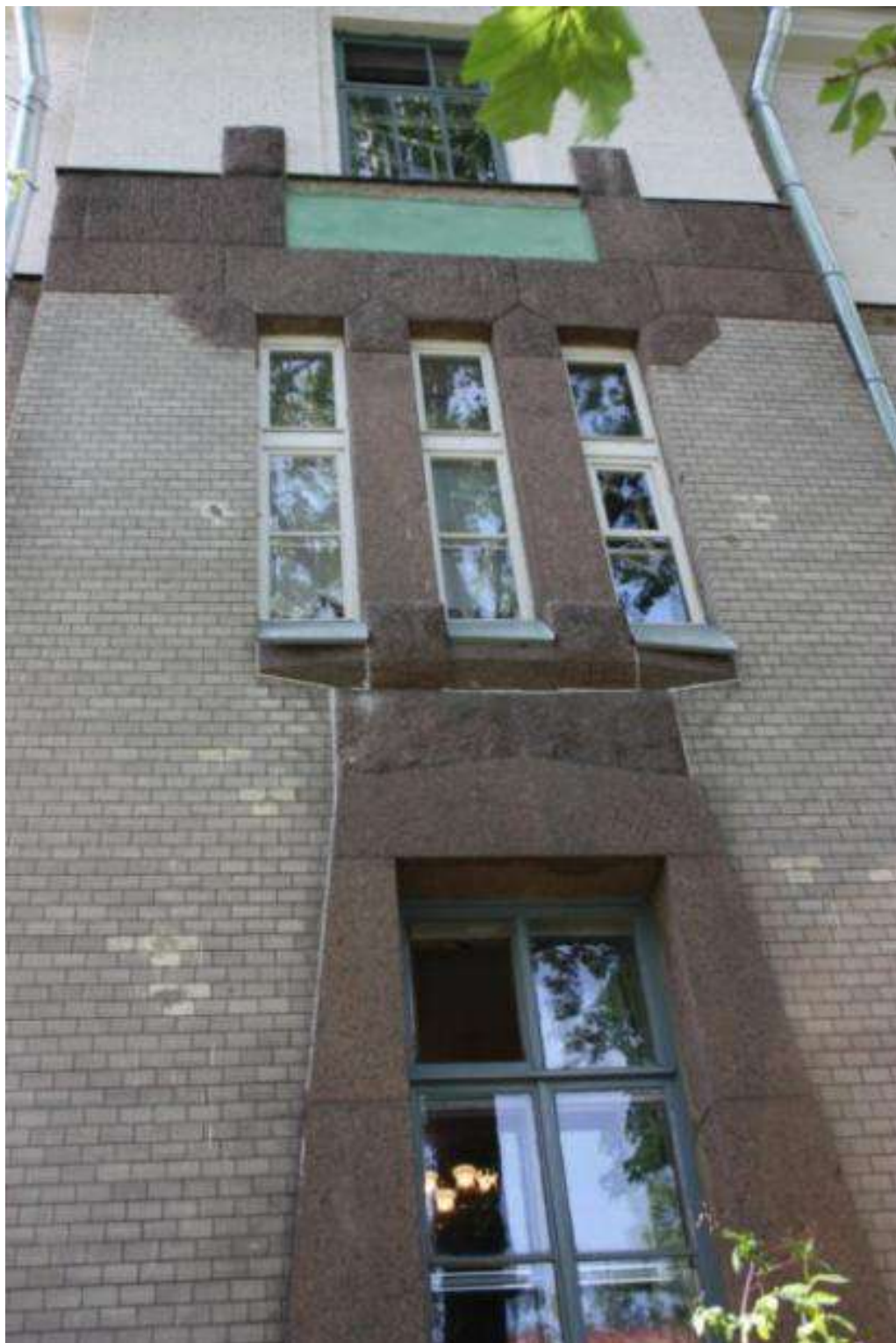
12. Фрагмент ризалита лицевого фасада. Фото 13.06.2009. https://www.citywalls.ru/
