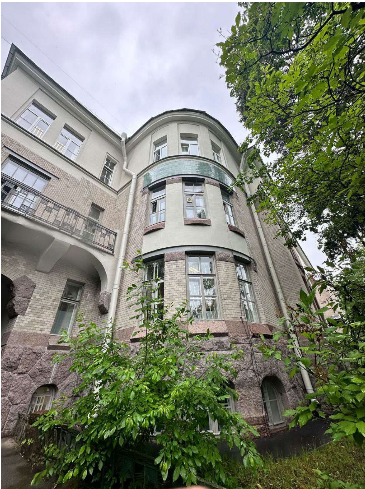
Фото 5. Общий вид на лицевой фасад объекта. Дата фотофиксации - 28.09.2024г.
