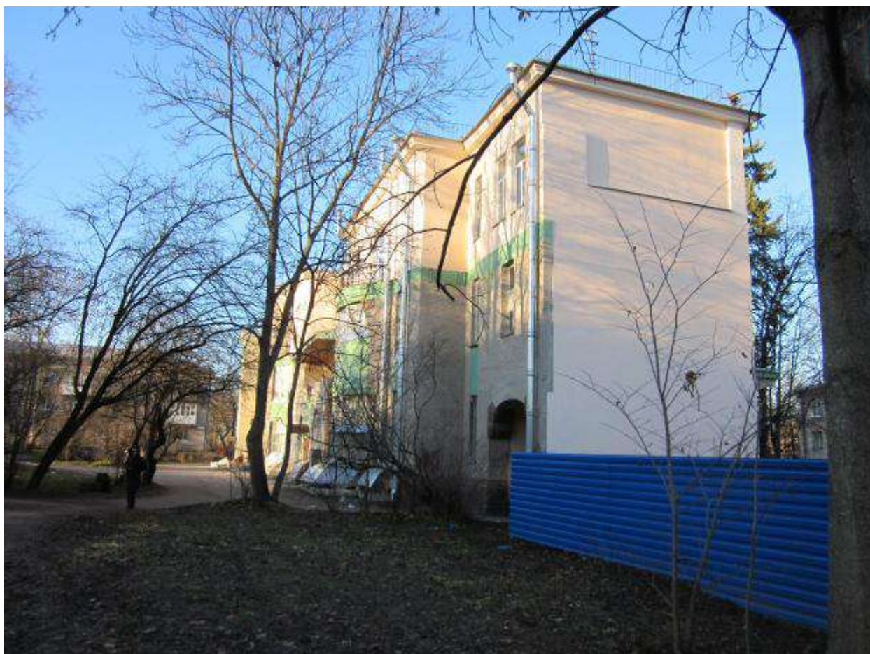
18. Вид на здание с юго-востока. Фото ноябрь 2011 г. https://www.citywalls.ru/
