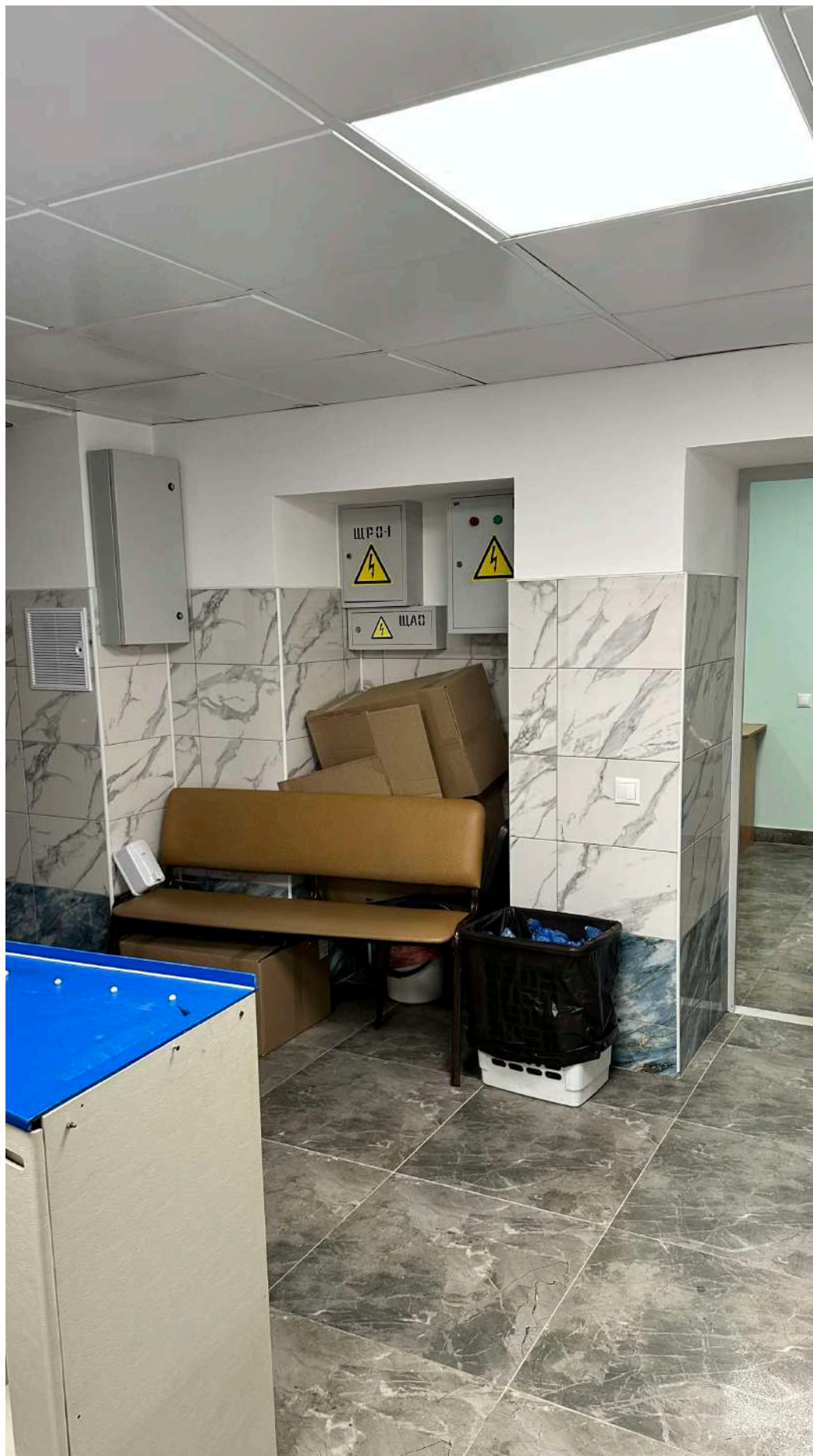
Фото 4. Общий вид подвала в зоне проектирования. Пом. № 184 по плану ПИБ. Дата фотофиксации - 28.09.2024г.
