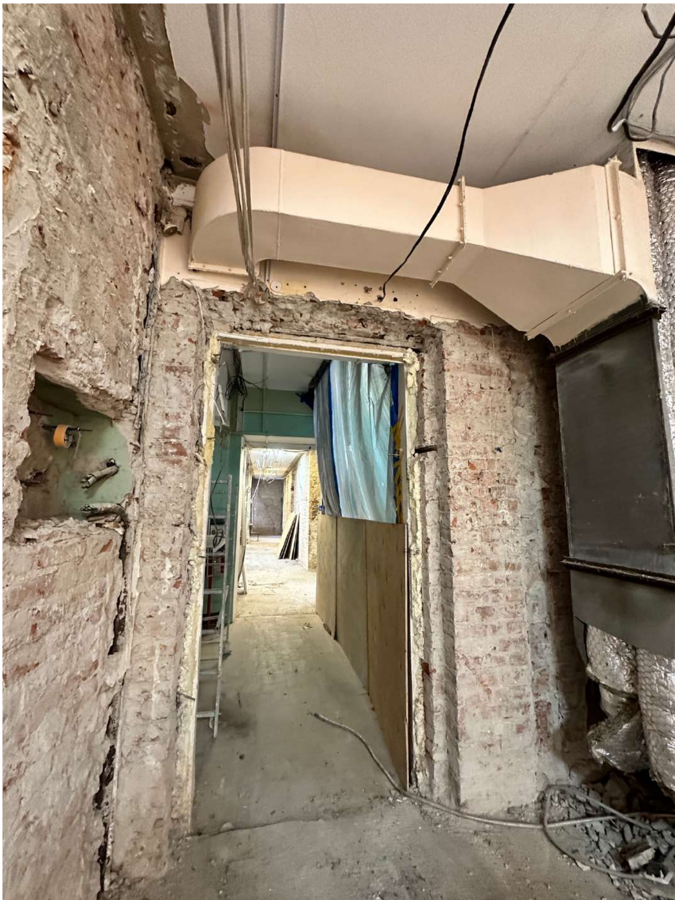
Фото 11. Общий вид 1-го этажа в зоне проектирования. Пом. № 20 по плану ПИБ. Дата фотофиксации - 28.09.2024г.
