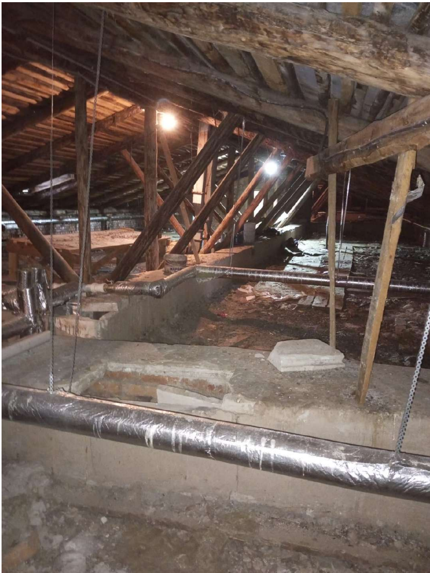
Фото 22. Общий вид чердачного пространства. Дата фотофиксации - 28.09.2024г.
