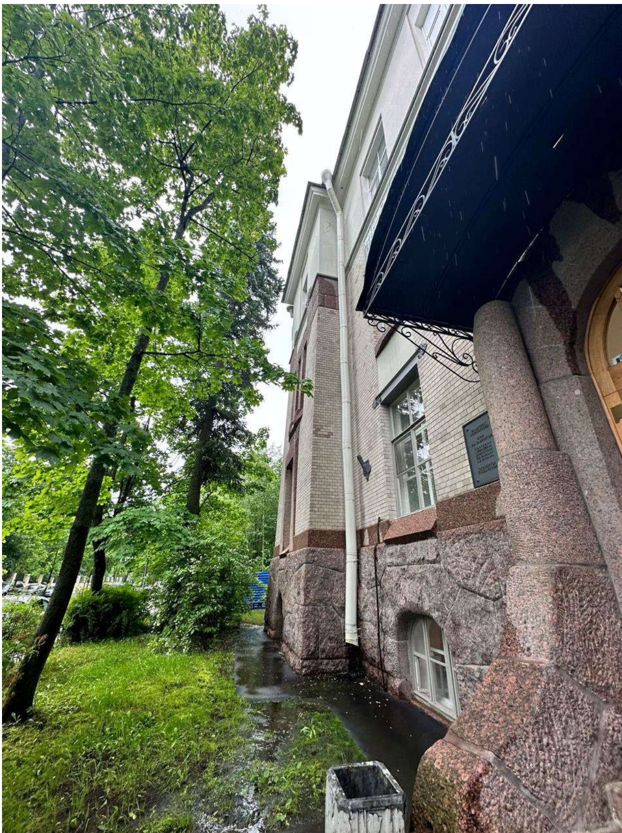
Фото 8. Общий вид на лицевой фасад объекта. Дата фотофиксации - 28.09.2024г.
