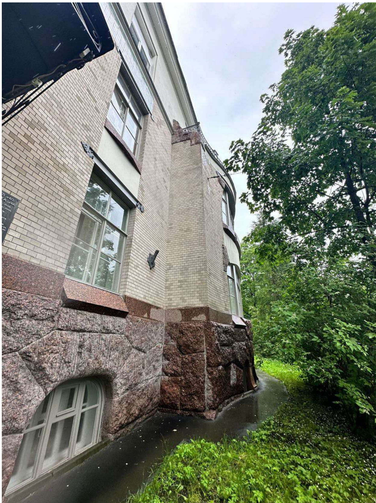
Фото 6. Общий вид на лицевой фасад объекта. Дата фотофиксации - 28.09.2024г.
