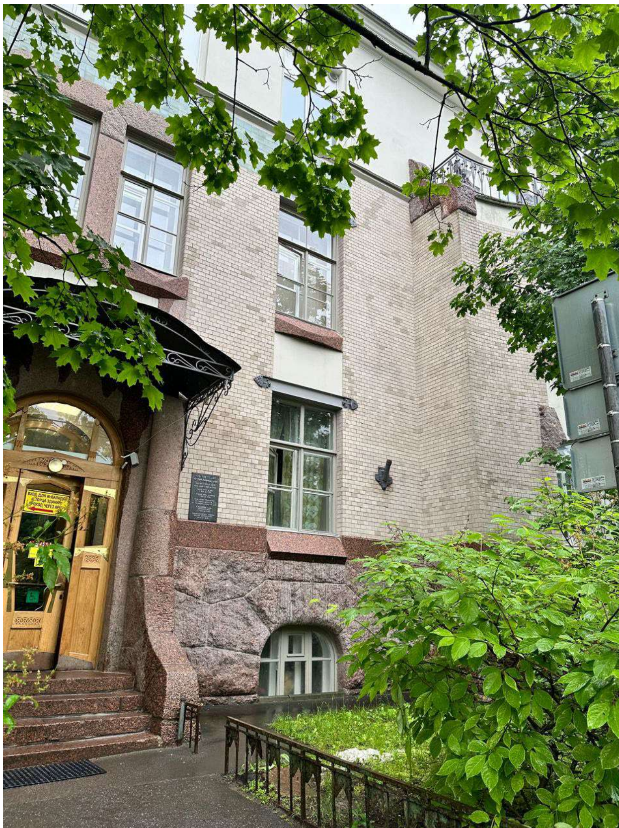
Фото 4. Общий вид на лицевой фасад объекта. Дата фотофиксации - 28.09.2024г.
