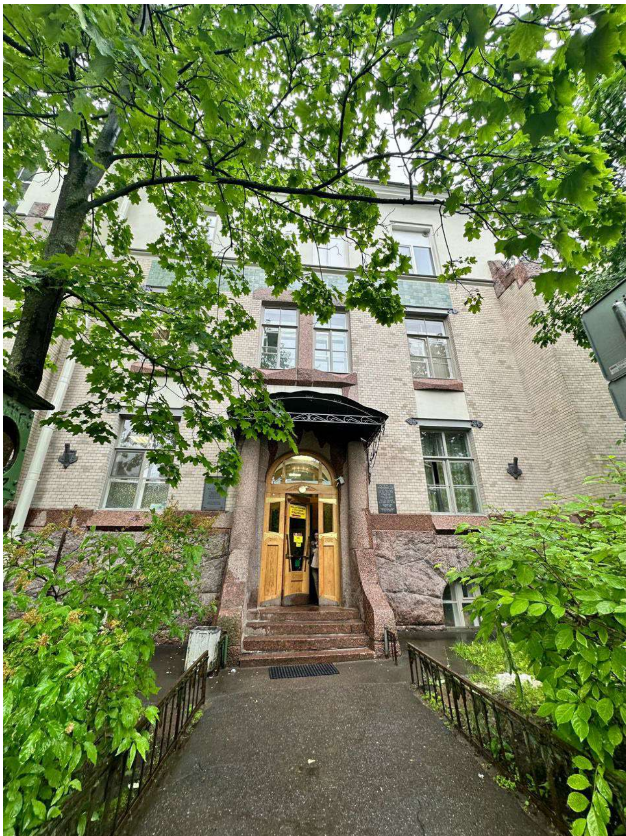
Фото 3. Общий вид на лицевой фасад объекта. Дата фотофиксации - 28.09.2024г.
