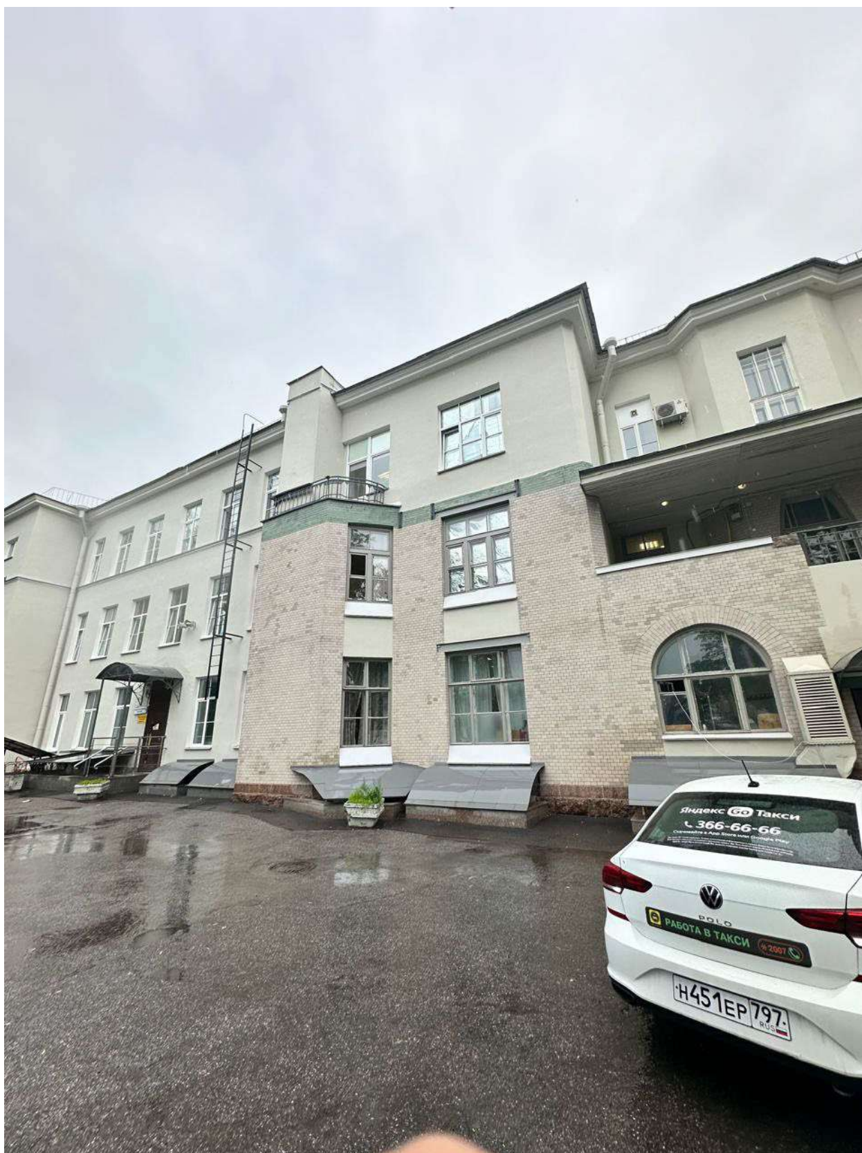
Фото 10. Общий вид на дворовой фасад объекта. Дата фотофиксации - 28.09.2024г.
