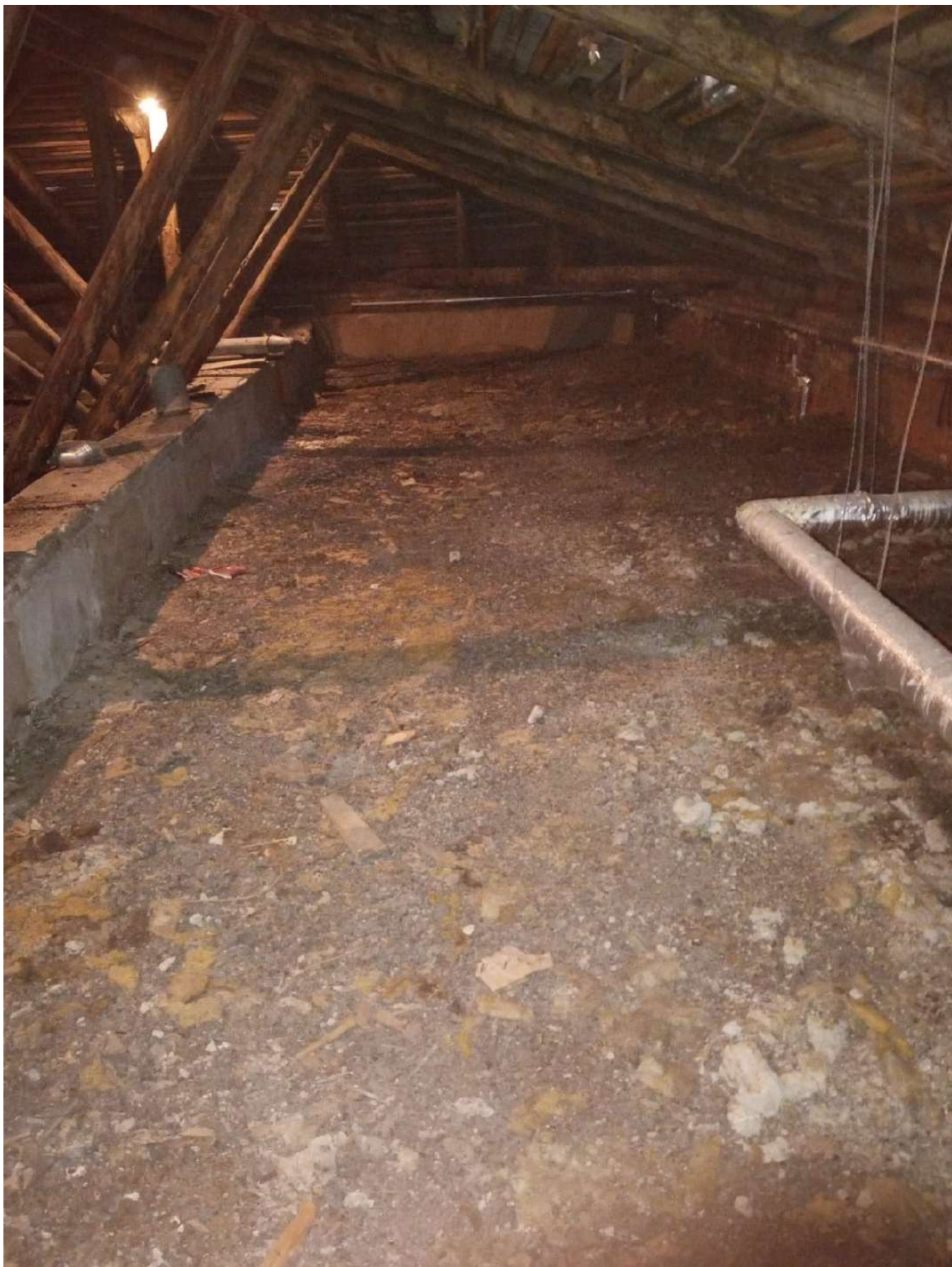
Фото 21. Общий вид чердачного пространства. Дата фотофиксации - 28.09.2024г.
