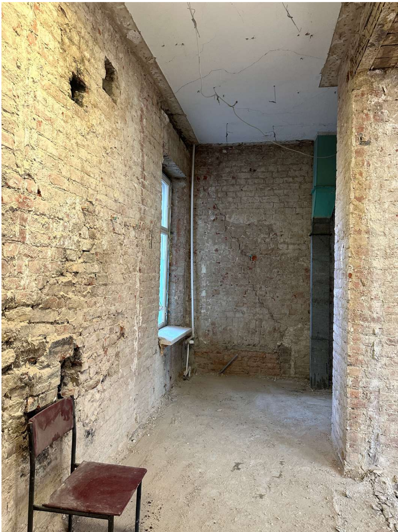
Фото 12. Общий вид 1-го этажа в зоне проектирования. Пом. № 5 по плану ПИБ. Дата фотофиксации - 28.09.2024г.
