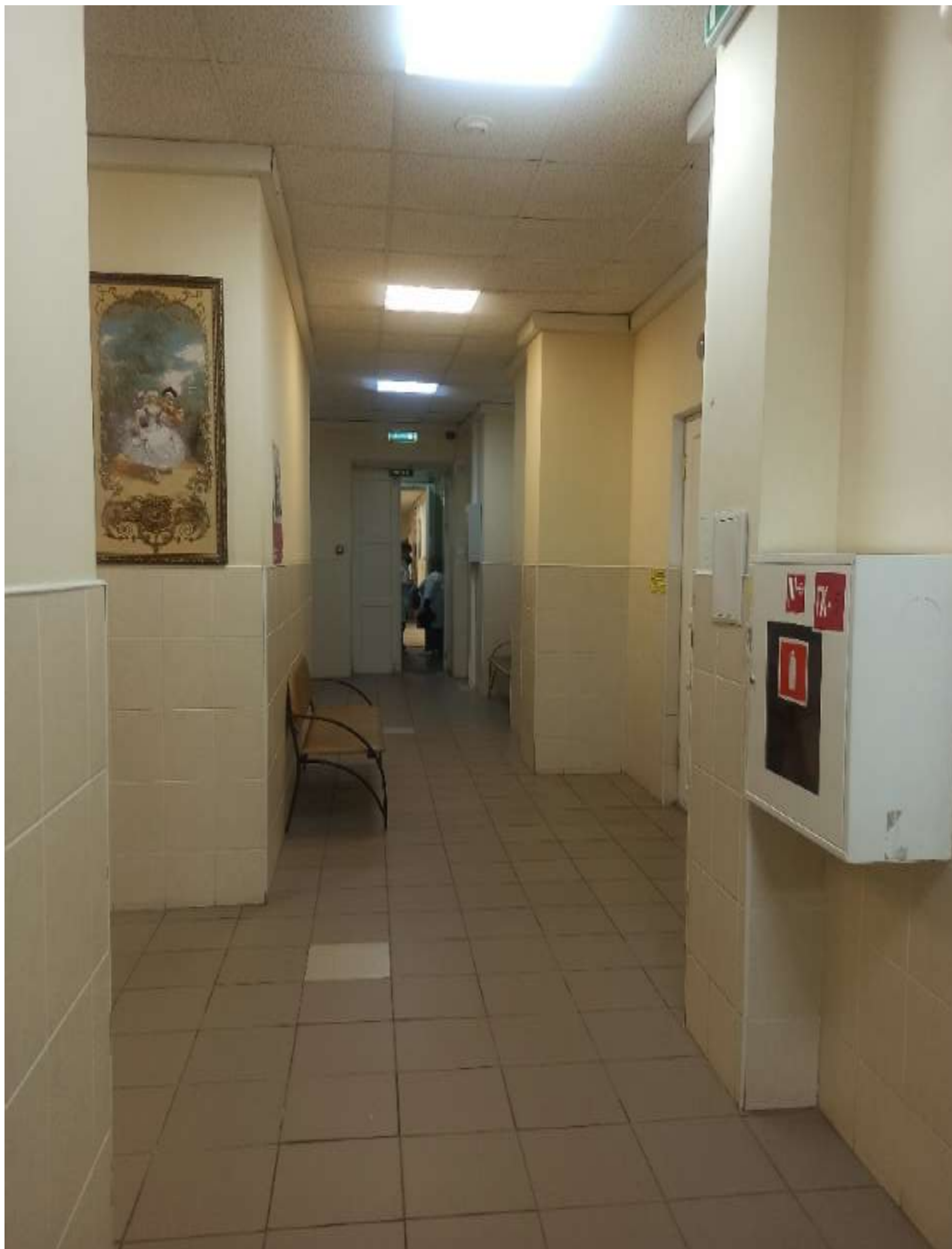
Фото 16. Общий вид 2-го этажа в зоне проектирования. Пом. № 105 по плану ПИБ. Дата фотофиксации - 28.09.2024г.
