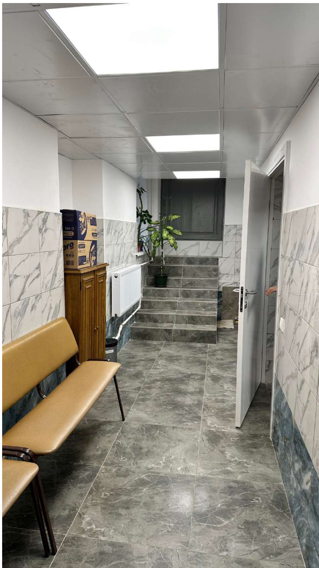
Фото 3. Общий вид подвала в зоне проектирования. Пом. № 184 по плану ПИБ. Дата фотофиксации - 28.09.2024г.
