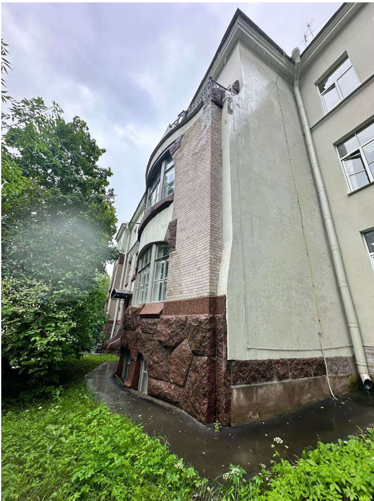
Фото 7. Общий вид на лицевой фасад объекта. Дата фотофиксации - 28.09.2024г.
