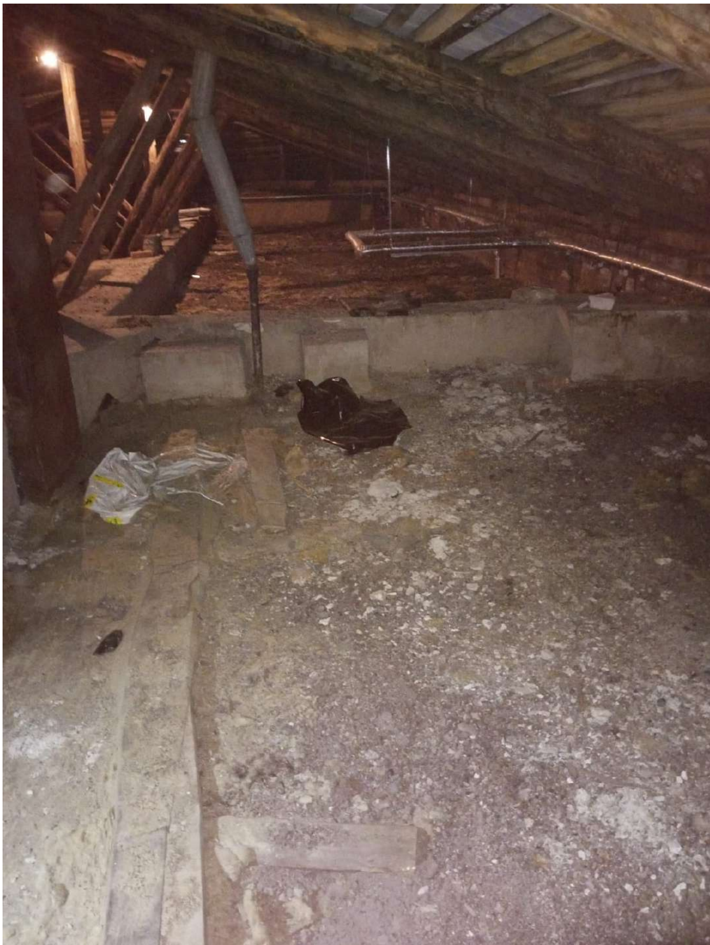
Фото 23. Общий вид чердачного пространства. Дата фотофиксации - 28.09.2024г.
