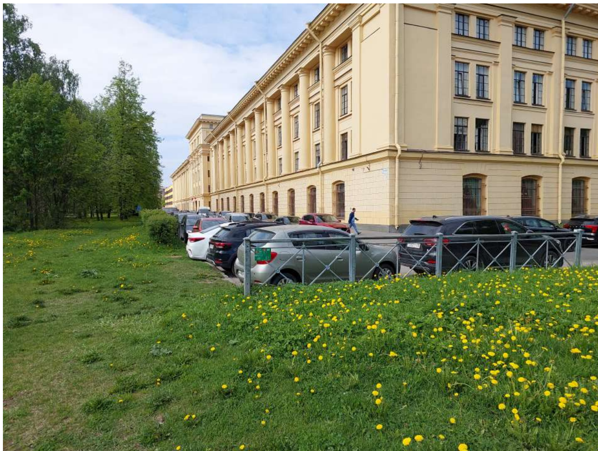
Точка фотофиксации 13. Южный участок полосы отвода, ул. Громова на пересечении с Рижской ул., вдоль Заневского парка. Вид с ЮВ.
