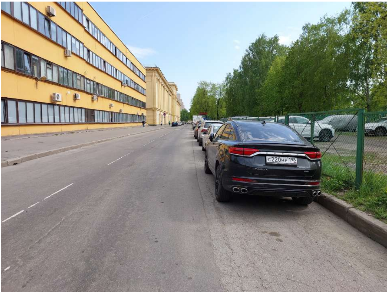
Точка фотофиксации 9. Центральная часть участка полосы отвода, ул. Громова. Вид с СЗ.
