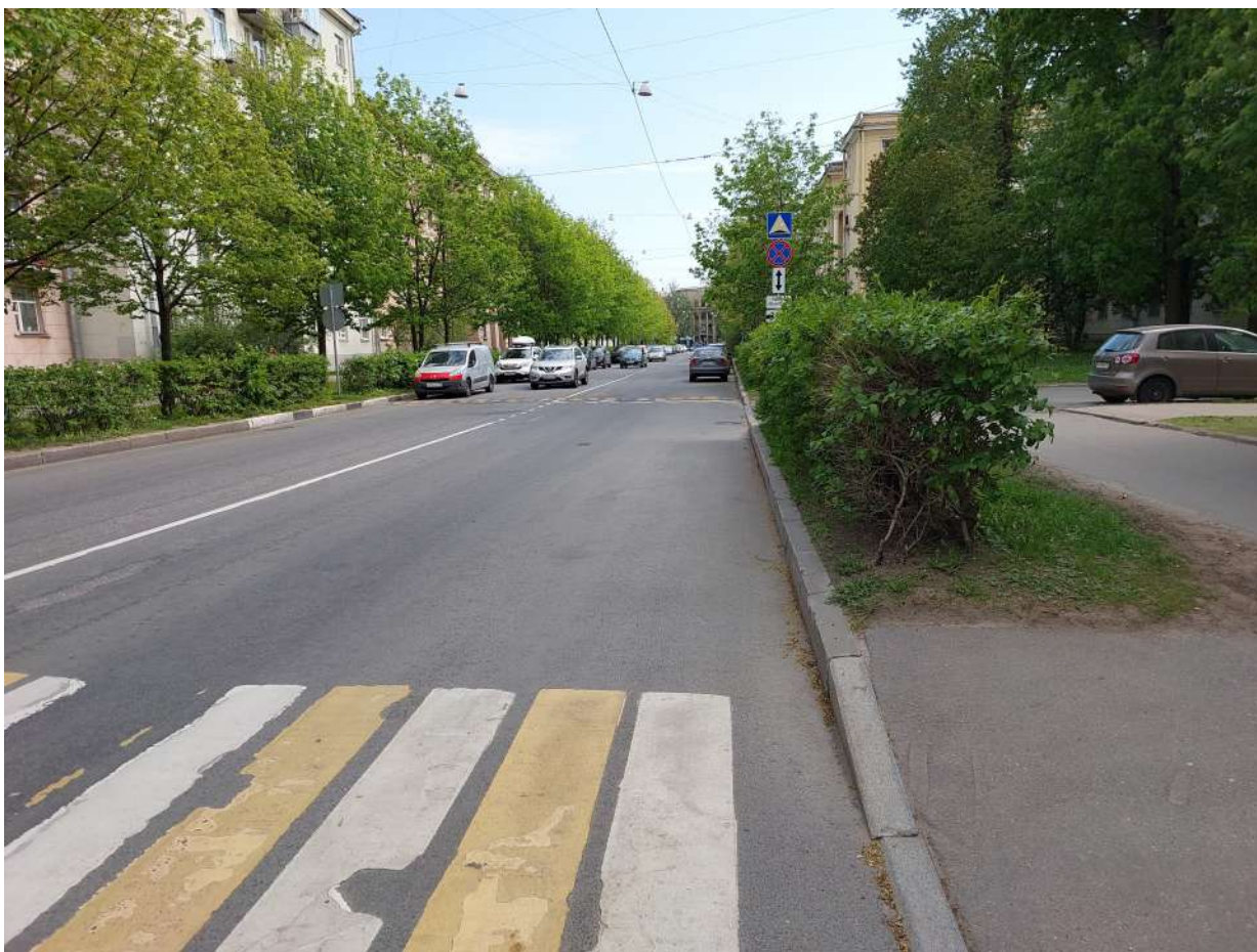
Точка фотофиксации 4. Северный участок полосы отвода, ул. Стахановцев. Вид с ССЗ.
