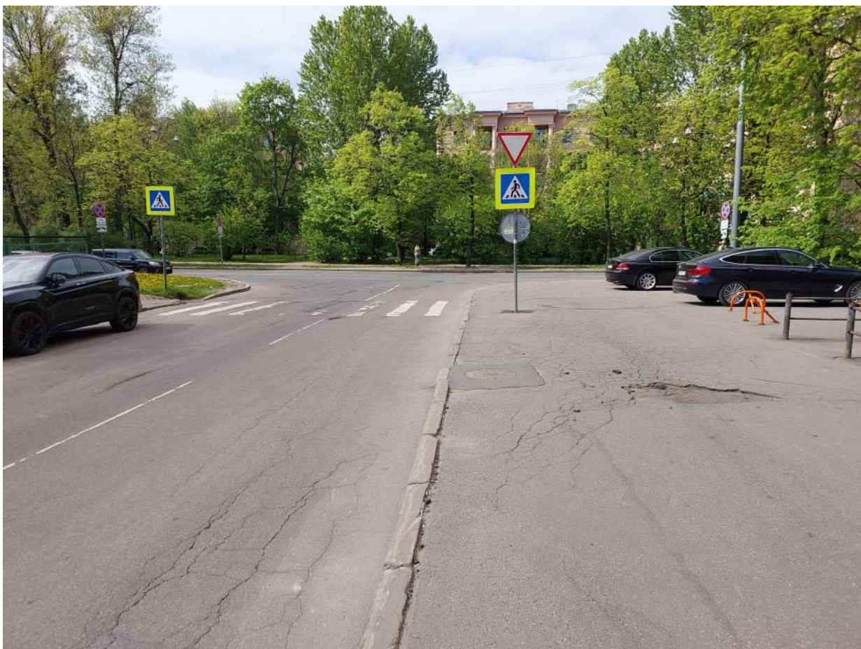
Точка фотофиксации 10. Центральная часть участка полосы отвода, пересечение ул. Громова и ул. Таллинская. Вид с ЮВ.
