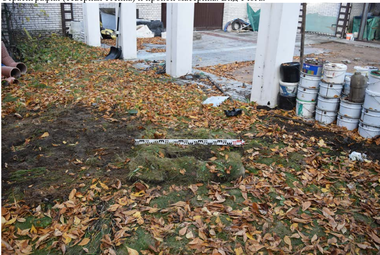
Илл. 41. Санкт-Петербург, Поклонногорская улица, земельный участок 48а. Шурф 1. Рекультивация. Вид с юга.
