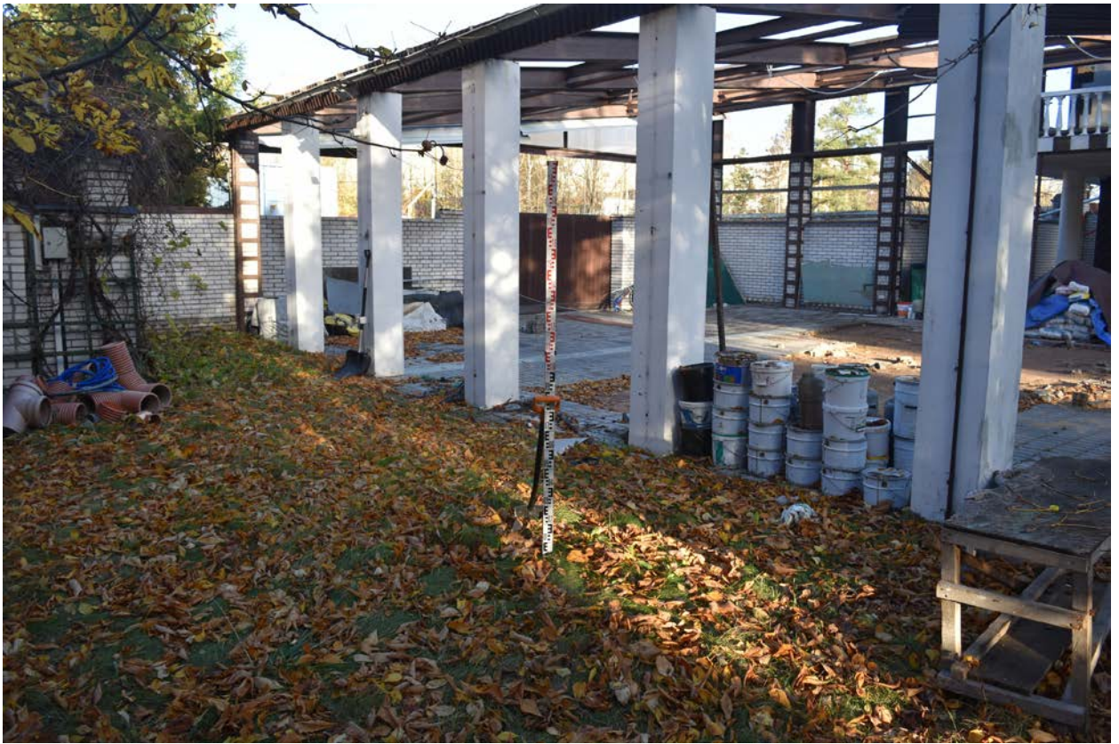
Илл. 36. Санкт-Петербург, Поклонногорская улица, земельный участок 48а. Общий вид на место закладки шурфа 1. Вид с юга. Для масштаба использована рейка длиной 2 м.
