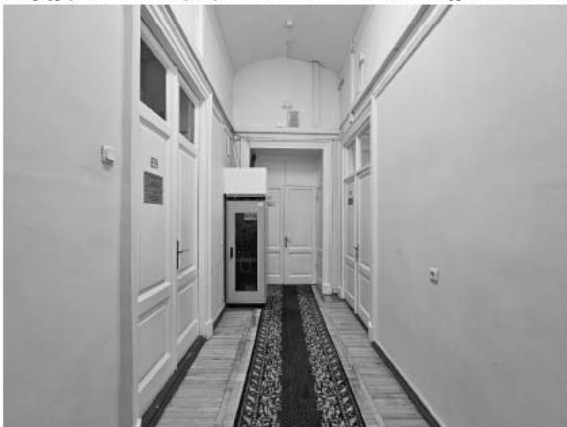
118. Объект культурного наследия федерального значения «Дворец», в составе объекта культурного наследия федерального значения «Дворец Маринский», по адресу: г. Санкт-Петербург, Исаакиевская пл., д. 6, лит. А. Фрагмент пом. 15-Н (42) в уровне 3-го этажа.
