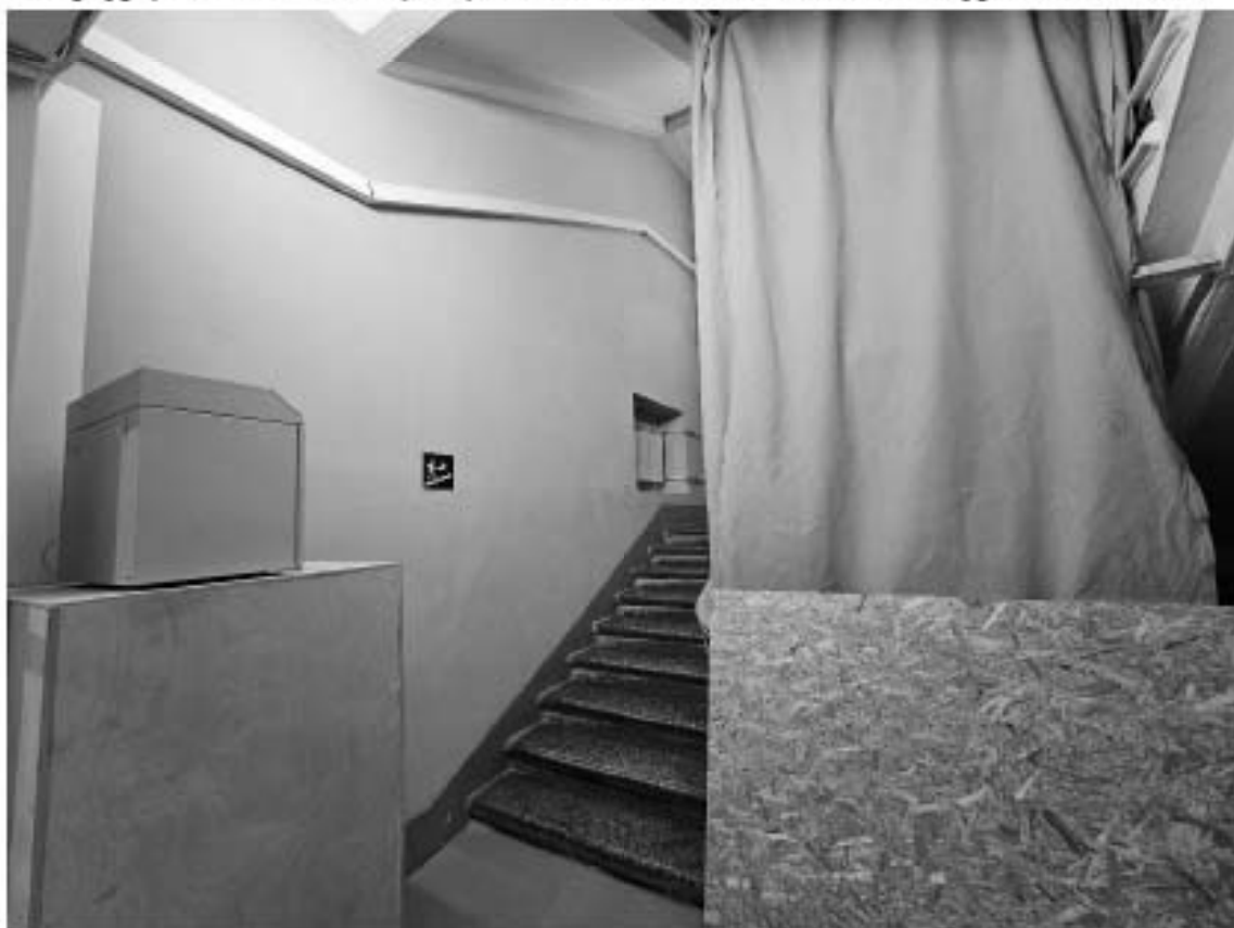
62. Объект культурного наследия федерального значения «Дворец», в составе объекта культурного наследия федерального значения «Дворец Маринский», по адресу: г. Санкт-Петербург, Исаакиевская пл., д. 6, лит. А. Фрагмент лестницы Л-6 в уровне 1-го этажа.
