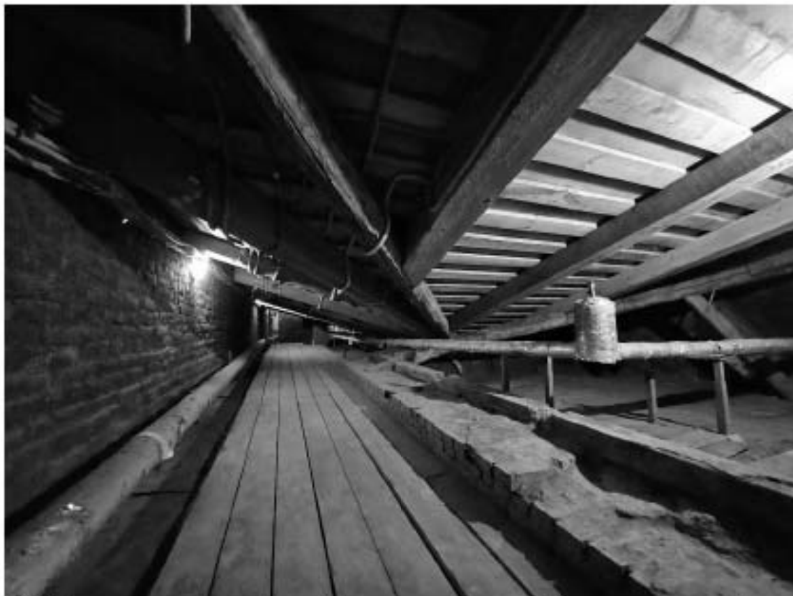
149. Объект культурного наследия федерального значения «Дворец», в составе объекта культурного наследия федерального значения «Дворец Маринский», по адресу: г. Санкт-Петербург, Исаакиевская пл., д. 6, лит. А. Фрагмент стропильной системы крыши в юго-восточной части здания.
