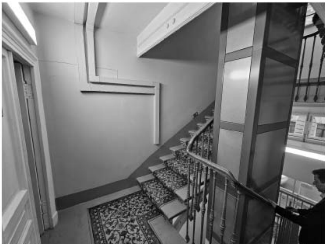
91. Объект культурного наследия федерального значения «Дворец», в составе объекта культурного наследия федерального значения «Дворец Маринский», по адресу: г. Санкт-Петербург, Исаакиевская пл., д. 6, лит. А. Общий вид объема лестницы Л-13 в уровне антресоли.
