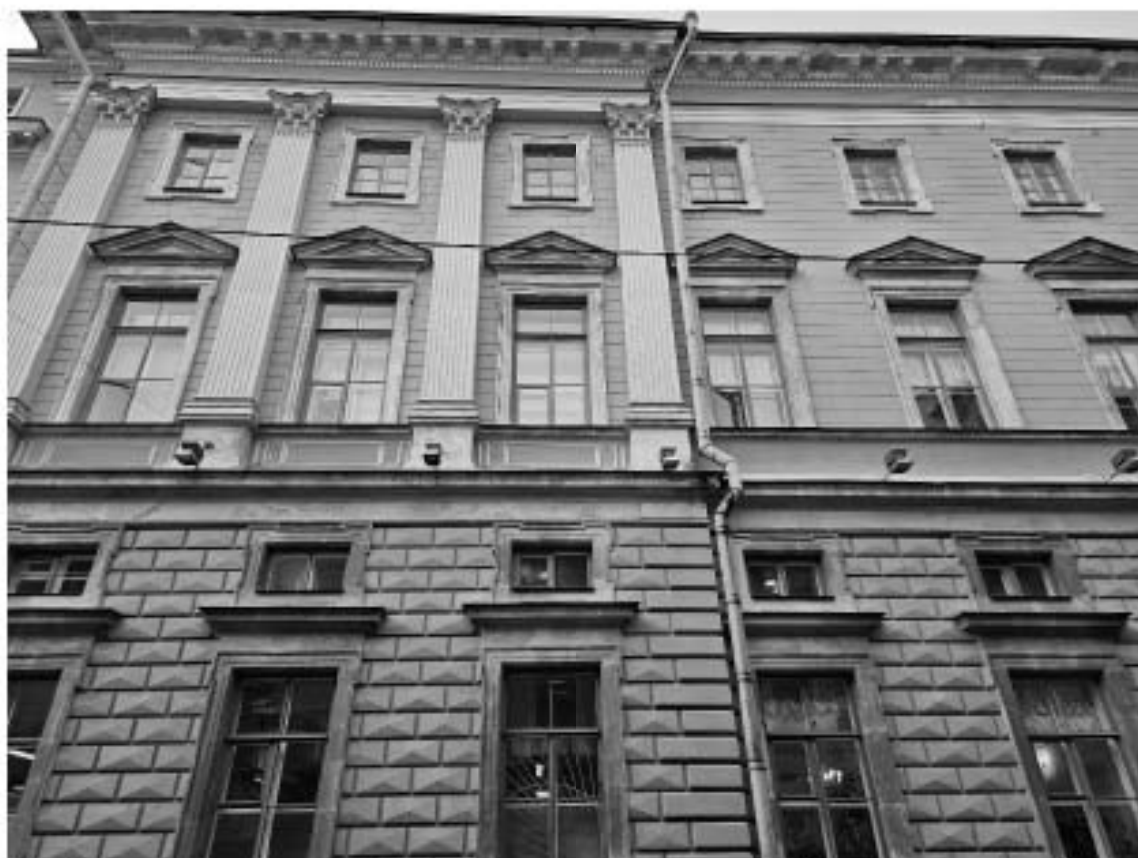
11. Объект культурного наследия федерального значения «Дворец», в составе объекта культурного наследия федерального значения «Дворец Маринский», по адресу: г. Санкт-Петербург, Исаакиевская пл., д. 6, лит. А. Фрагмент фасада по переулку Антоненко.
