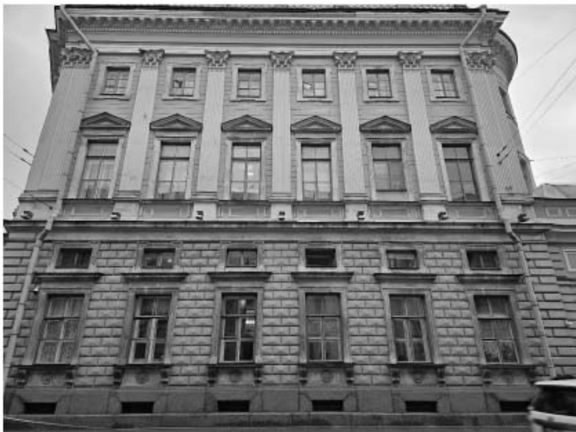
3. Объект культурного наследия федерального значения «Дворец», в составе объекта культурного наследия федерального значения «Дворец Марининский», по адресу: г. Санкт-Петербург, Исаакиевская пл., д. 6, лит. А. Общий вид торцевого фасада по Вознесенскому проспекту.
