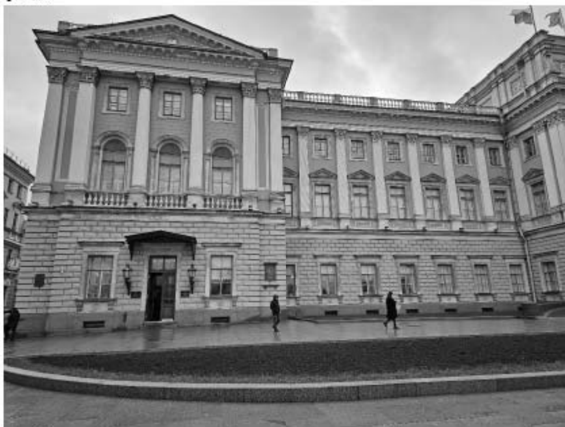
8. Объект культурного наследия федерального значения «Дворец», в составе объекта культурного наследия федерального значения «Дворец Маринский», по адресу: г. Санкт-Петербург, Исаакиевская пл., д. 6, лит. А. Восточная часть северного лицевого фасада.
