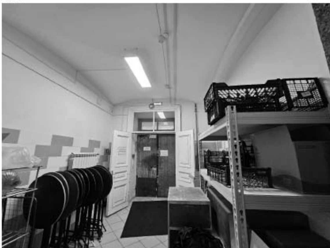
56. Объект культурного наследия федерального значения «Дворец», в составе объекта культурного наследия федерального значения «Дворец Маринский», по адресу: г. Санкт-Петербург, Исаакиевская пл., д. 6, лит. А. Общий вид пом. 15-Н (1) в уровне 1-го этажа.
