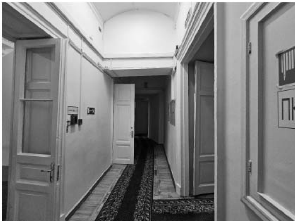
119. Объект культурного наследия федерального значения «Дворец», в составе объекта культурного наследия федерального значения «Дворец Маринский», по адресу: г. Санкт-Петербург, Исаакиевская пл., д. 6, лит. А. Фрагмент пом. 15-Н (42) в уровне 3-го этажа.
