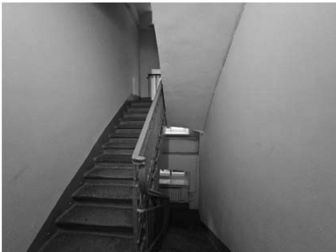
61. Объект культурного наследия федерального значения «Дворец», в составе объекта культурного наследия федерального значения «Дворец Маринский», по адресу: г. Санкт-Петербург, Исаакиевская пл., д. 6, лит. А. Общий вид лестницы Л-5 в уровне 1-го этажа.
