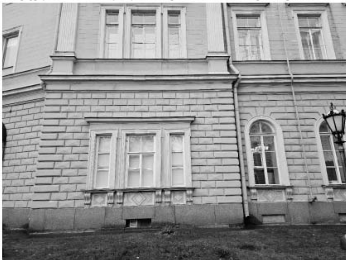
26. Объект культурного наследия федерального значения «Дворец», в составе объекта культурного наследия федерального значения «Дворец Маринский», по адресу: г. Санкт-Петербург, Исаакиевская пл., д. 6, лит. А. Фрагмент южного дворового фасада.
