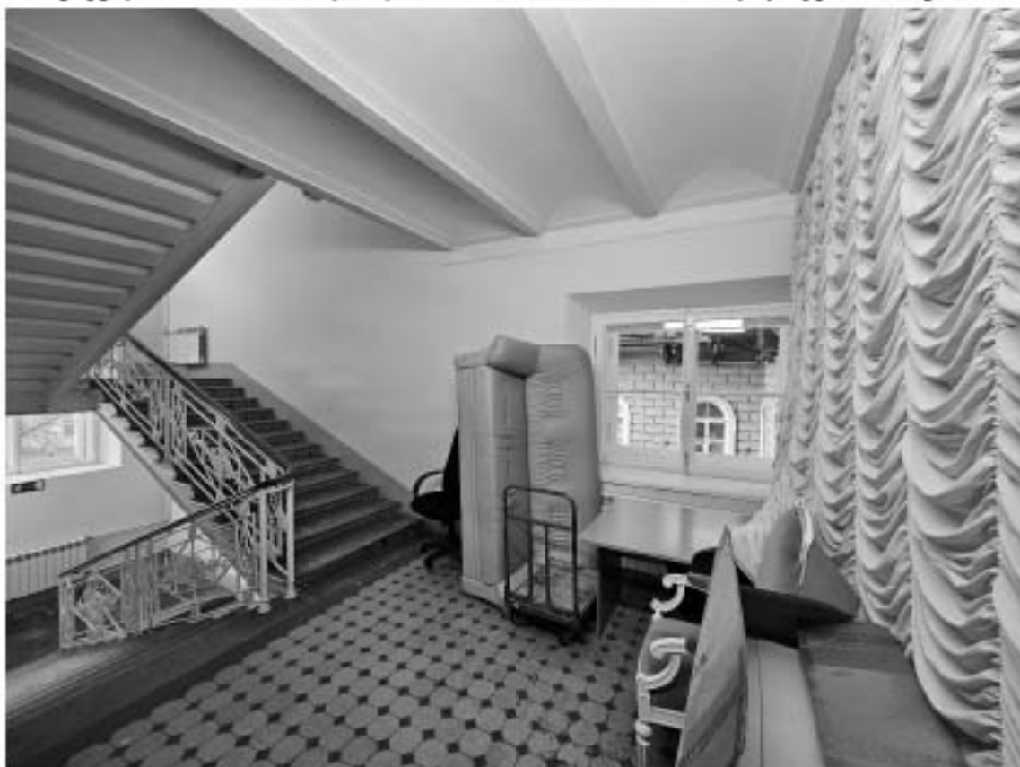
90. Объект культурного наследия федерального значения «Дворец», в составе объекта культурного наследия федерального значения «Дворец Маринский», по адресу: г. Санкт-Петербург, Исаакиевская пл., д. 6, лит. А. Общий вид площадки лестницы Л-9 в уровне антресоли.
