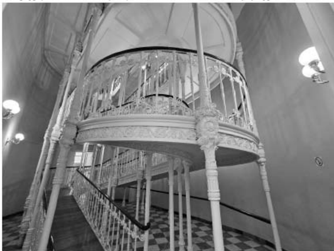
48. Объект культурного наследия федерального значения «Дворец», в составе объекта культурного наследия федерального значения «Дворец Маринский», по адресу: г. Санкт-Петербург, Исаакиевская пл., д. 6, лит. А. Общий вид пандуса в объеме лестницы Л-14 в уровне 1-го этажа.
