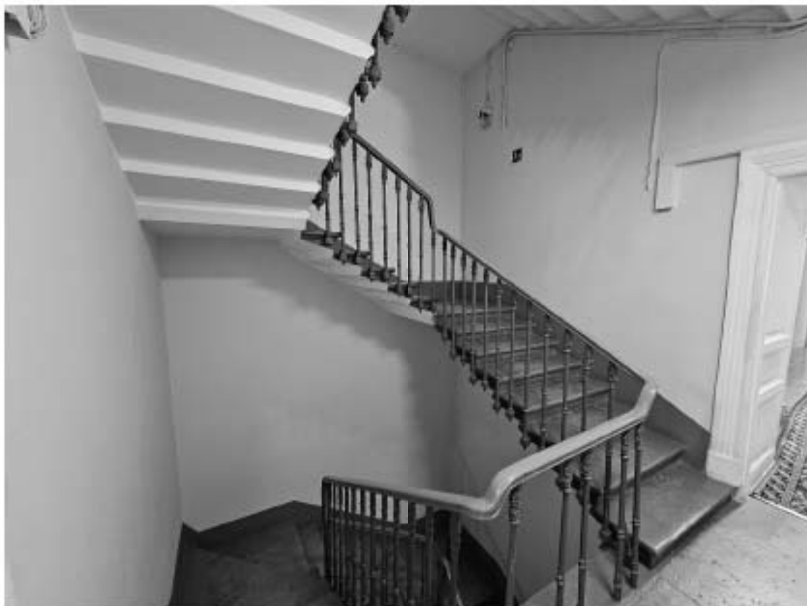
72. Объект культурного наследия федерального значения «Дворец», в составе объекта культурного наследия федерального значения «Дворец Маринский», по адресу: г. Санкт-Петербург, Исаакиевская пл., д. 6, лит. А. Общий вид лестницы Л-7 в уровне антресоли.
