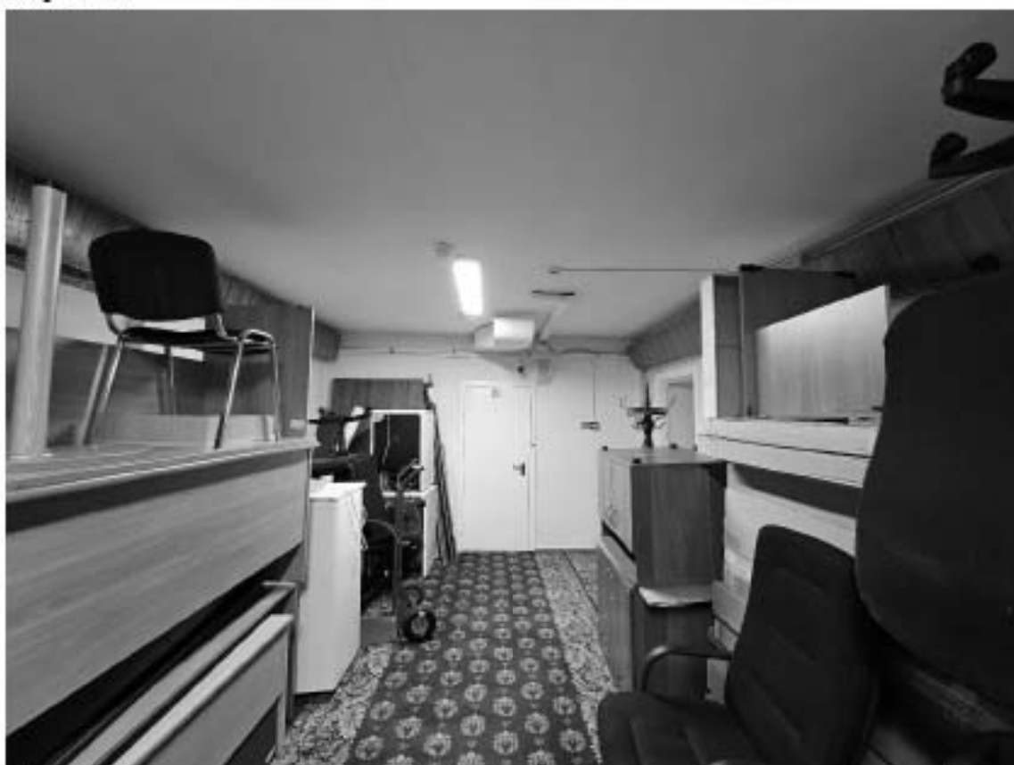
84. Объект культурного наследия федерального значения «Дворец», в составе объекта культурного наследия федерального значения «Дворец Маринский», по адресу: г. Санкт-Петербург, Исаакиевская пл., д. 6, лит. А. Общий вид пом. 15-Н (21) в уровне антресоли.
