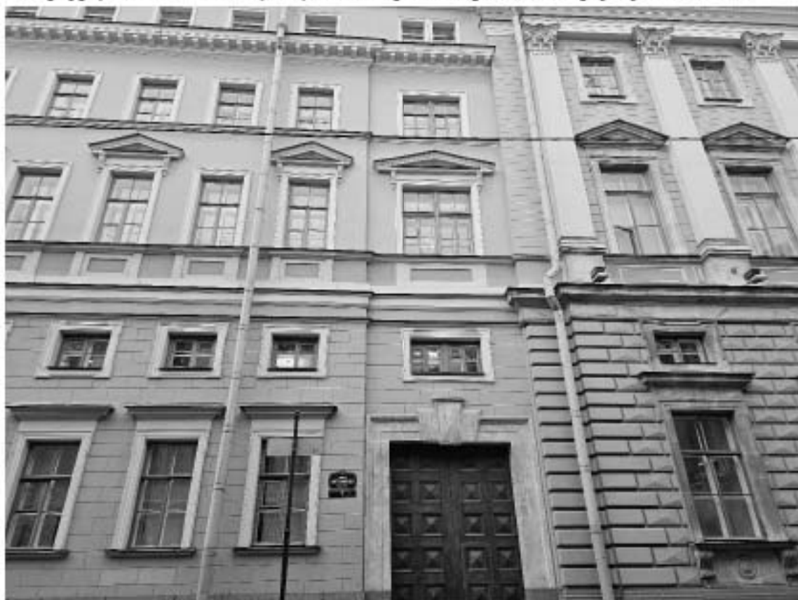
12. Объект культурного наследия федерального значения «Дворец», в составе объекта культурного наследия федерального значения «Дворец Маринский», по адресу: г. Санкт-Петербург, Исаакиевская пл., д. 6, лит. А. Фрагмент фасада по переулку Антоненко.
