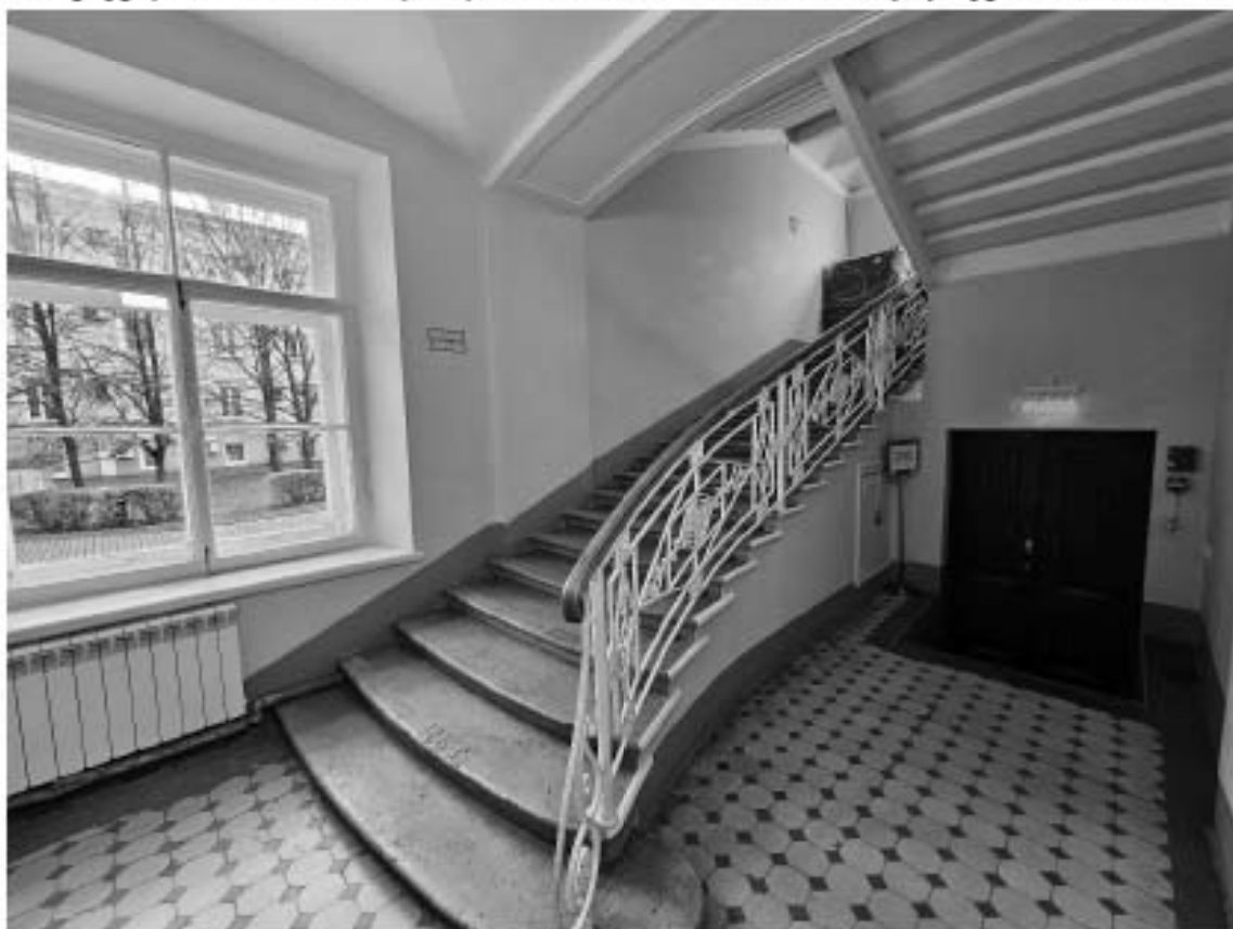
58. Объект культурного наследия федерального значения «Дворец», в составе объекта культурного наследия федерального значения «Дворец Марининский», по адресу: г. Санкт-Петербург, Исаакиевская пл., д. 6, лит. А. Общий вид лестницы Л-8 в уровне 1-го этажа.
