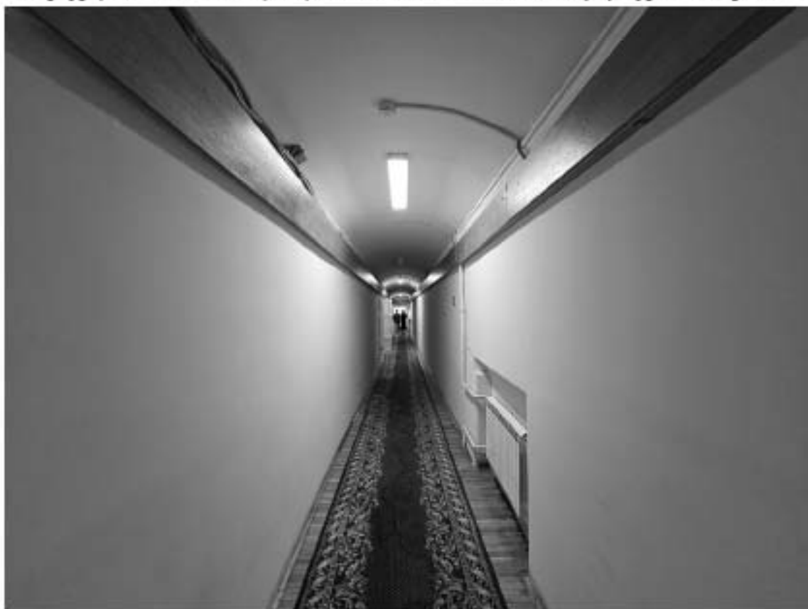
74. Объект культурного наследия федерального значения «Дворец», в составе объекта культурного наследия федерального значения «Дворец Марининский», по адресу: г. Санкт-Петербург, Исаакиевская пл., д. 6, лит. А. Общий вид пом. 15-Н (97) в уровне антресоли.
