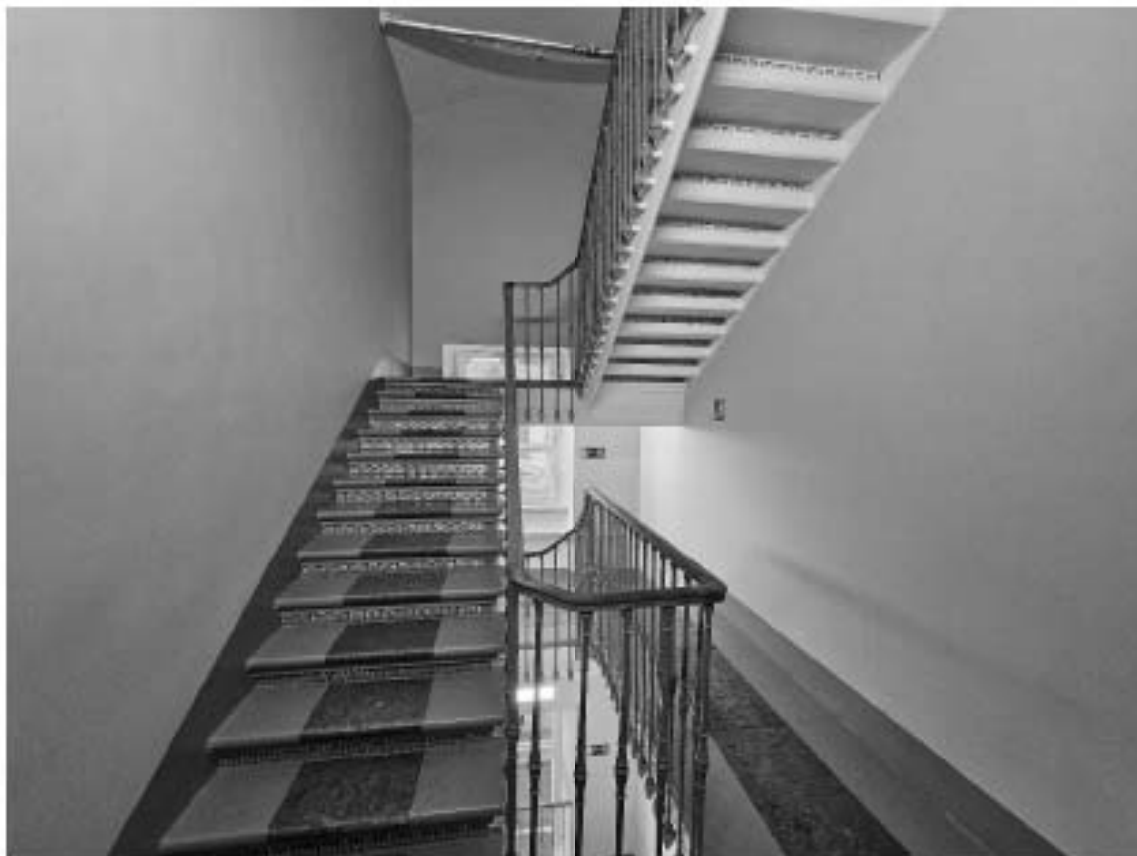
117. Объект культурного наследия федерального значения «Дворец», в составе объекта культурного наследия федерального значения «Дворец Маринский», по адресу: г. Санкт-Петербург, Исаакиевская пл., д. 6, лит. А. Общий вид лестницы Л-13 в уровне 3-го этажа.
