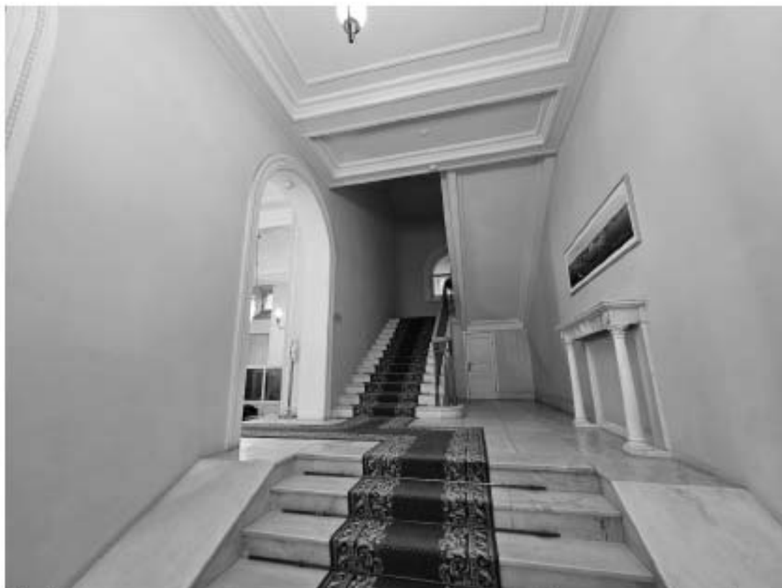
39. Объект культурного наследия федерального значения «Дворец», в составе объекта культурного наследия федерального значения «Дворец Маринский», по адресу: г. Санкт-Петербург, Исаакиевская пл., д. 6, лит. А. Общий вид межэтажной лестницы Л-3 в уровне 1-го этажа.
