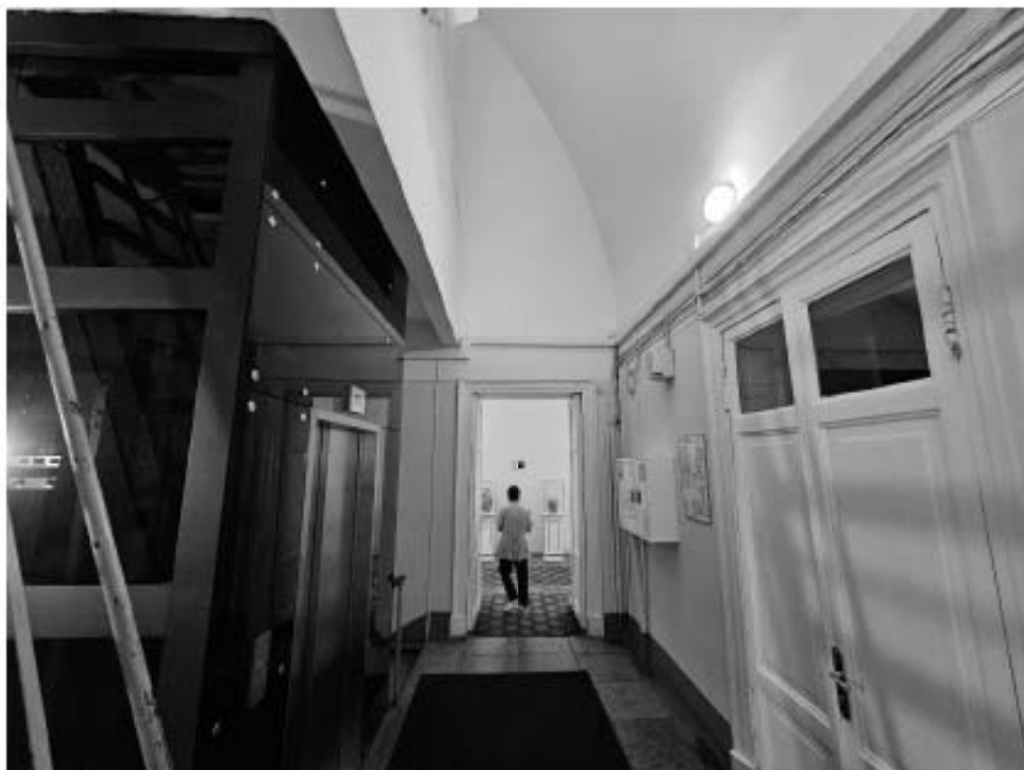
137. Объект культурного наследия федерального значения «Дворец», в составе объекта культурного наследия федерального значения «Дворец Маринский», по адресу: г. Санкт-Петербург, Исаакьевская пл., д. 6, лит. А. Фрагмент объема лестницы Л-4 в уровне 3-го этажа.
