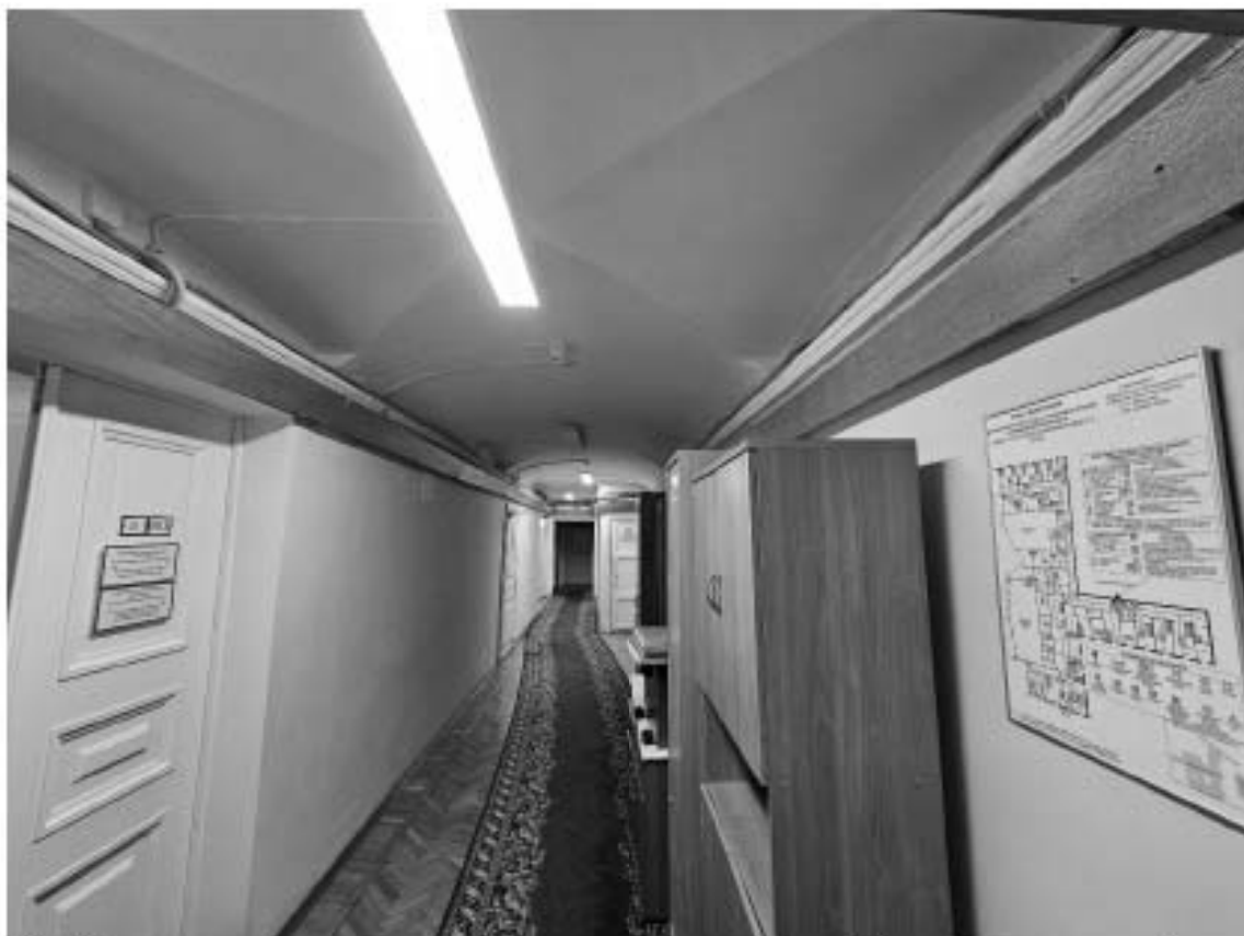
73. Объект культурного наследия федерального значения «Дворец», в составе объекта культурного наследия федерального значения «Дворец Марининский», по адресу: г. Санкт-Петербург, Исаакиевская пл., д. 6, лит. А. Общий вид пом. 15-Н (14) в уровне антресоли.
