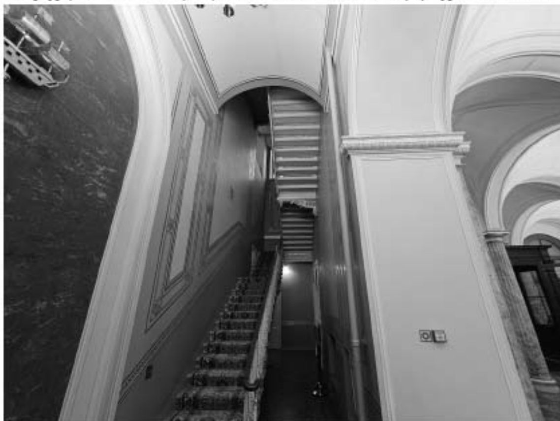
44. Объект культурного наследия федерального значения «Дворец», в составе объекта культурного наследия федерального значения «Дворец Маринский», по адресу: г. Санкт-Петербург, Исаакиевская пл., д. 6, лит. А. Общий вид лестницы Л-1 в уровне 1-го этажа.
