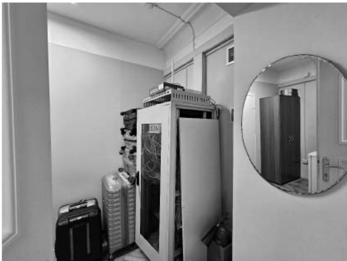
71. Объект культурного наследия федерального значения «Дворец», в составе объекта культурного наследия федерального значения «Дворец Маринский», по адресу: г. Санкт-Петербург, Исаакиевская пл., д. 6, лит. А. Фрагмент пом. 15-Н (9) в уровне антресоли.
