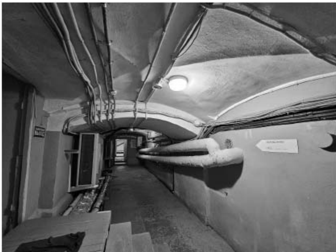
30. Объект культурного наследия федерального значения «Дворец», в составе объекта культурного наследия федерального значения «Дворец Маринский», по адресу: г. Санкт-Петербург, Исаакиевская пл., д. 6, лит. А. Фрагмент пом. 8-Н (44) в уровне подвала.
