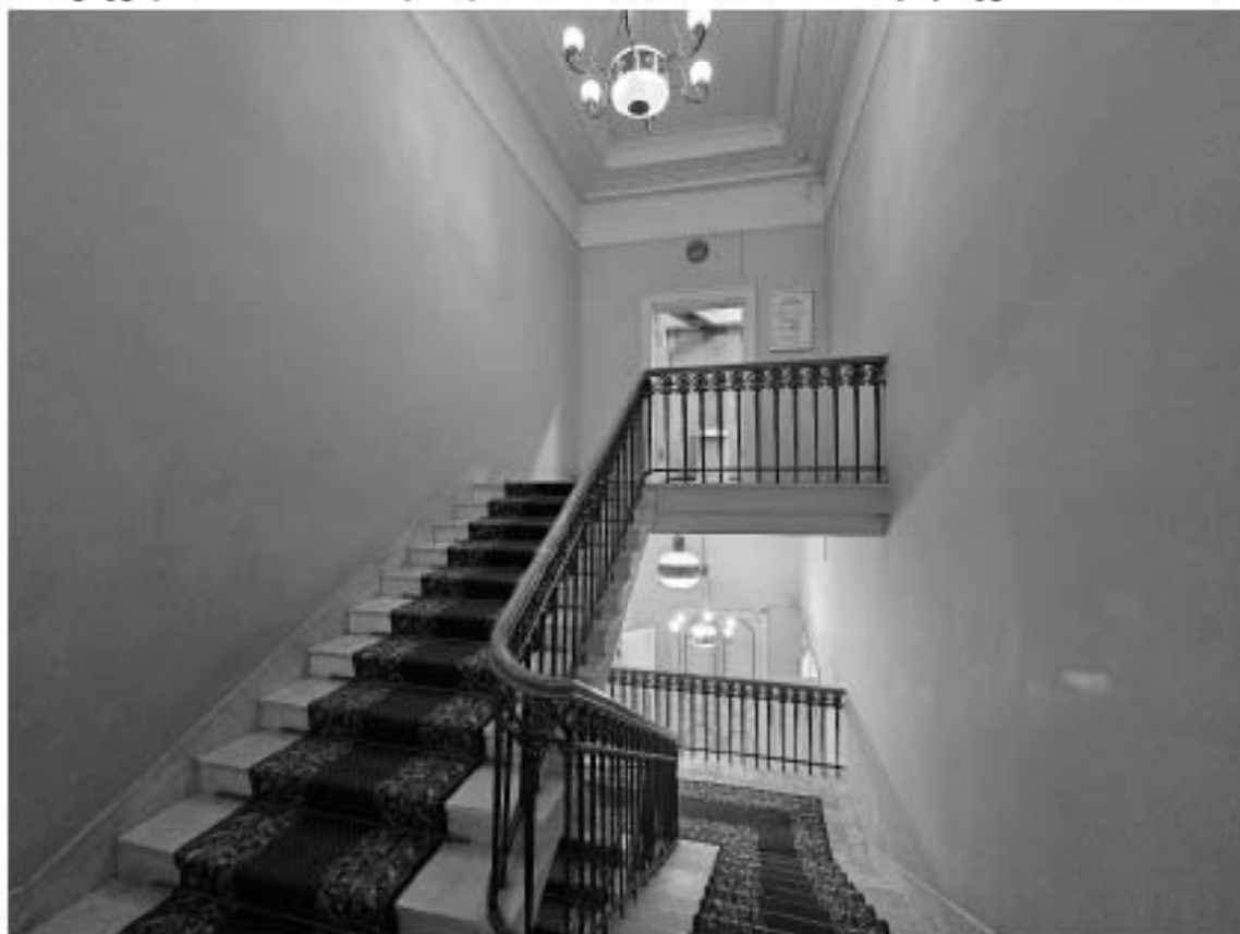
136. Объект культурного наследия федерального значения «Дворец», в составе объекта культурного наследия федерального значения «Дворец Маринский», по адресу: г. Санкт-Петербург, Исаакиевская пл., д. 6, лит. А. Общий вид лестницы Л-3 в уровне 3-го этажа.
