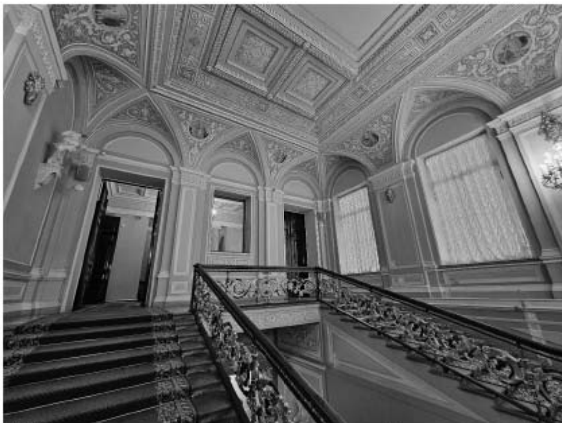
102. Объект культурного наследия федерального значения «Дворец», в составе объекта культурного наследия федерального значения «Дворец Марининский», по адресу: г. Санкт-Петербург, Исаакиевская пл., д. 6, лит. А. Общий вид площадки парадной лестницы Л-2 в уровне 2-го этажа.
