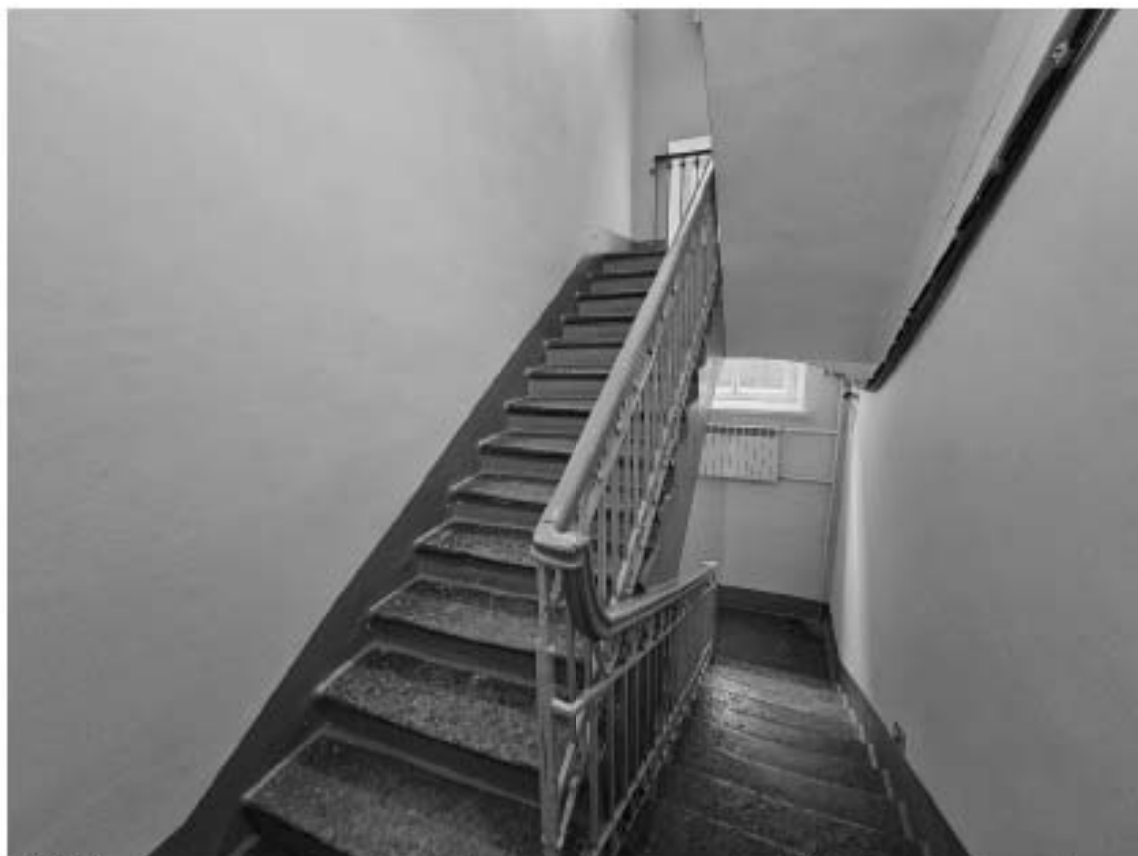
110. Объект культурного наследия федерального значения «Дворец», в составе объекта культурного наследия федерального значения «Дворец Маринский», по адресу: г. Санкт-Петербург, Исаакиевская пл., д. 6, лит. А. Общий вид лестницы Л-5 в уровне 2-го этажа.
