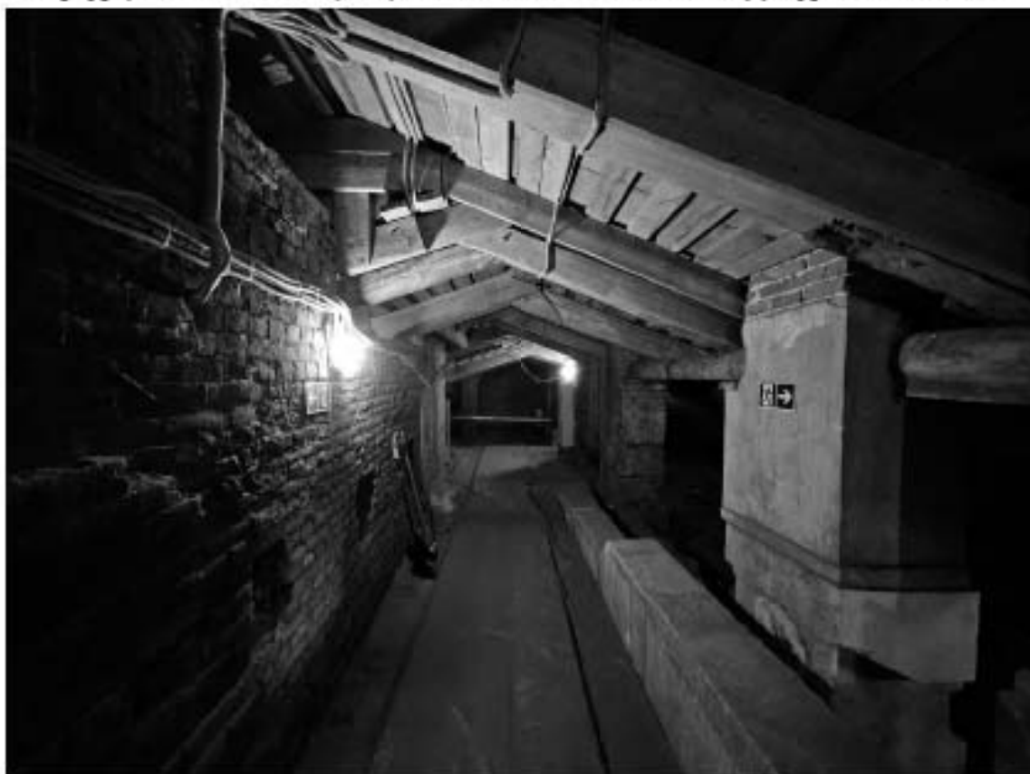
148. Объект культурного наследия федерального значения «Дворец», в составе объекта культурного наследия федерального значения «Дворец Маринский», по адресу: г. Санкт-Петербург, Исаакиевская пл., д. 6, лит. А. Фрагмент стропильной системы крыши в юго-восточной части здания.
