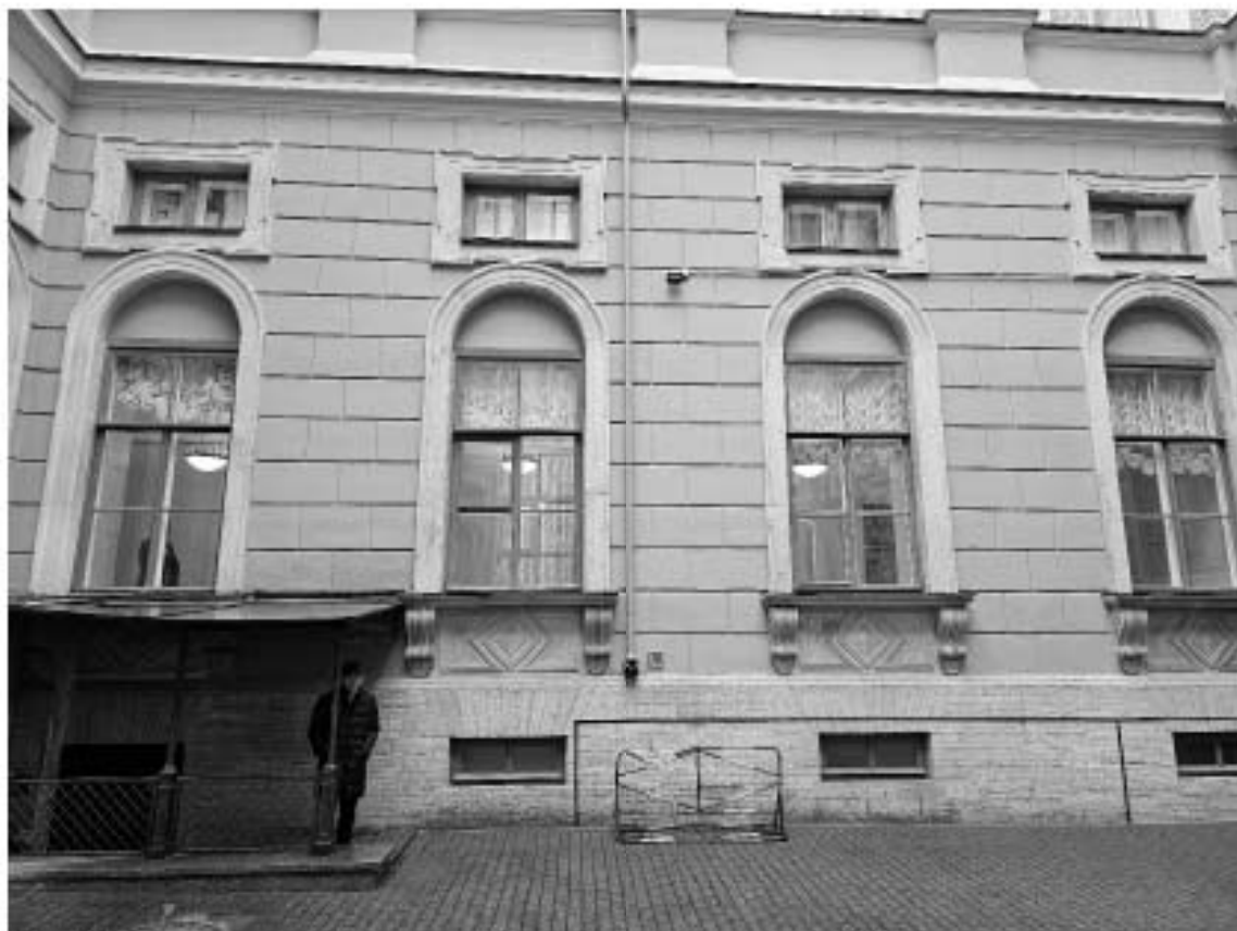
15. Объект культурного наследия федерального значения «Дворец», в составе объекта культурного наследия федерального значения «Дворец Маринский», по адресу: г. Санкт-Петербург, Исаакиевская пл., д. 6, лит. А. Фрагмент западного дворового фасада северного двора.
