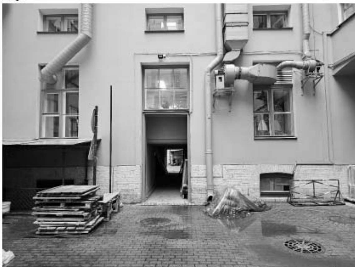
16. Объект культурного наследия федерального значения «Дворец», в составе объекта культурного наследия федерального значения «Дворец Маринский», по адресу: г. Санкт-Петербург, Исаакиевская пл., д. 6, лит. А. Фрагмент южного дворового фасада южного двора.
