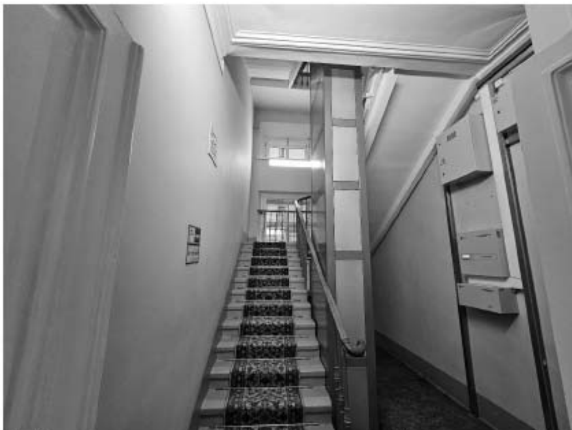
51. Объект культурного наследия федерального значения «Дворец», в составе объекта культурного наследия федерального значения «Дворец Марининский», по адресу: г. Санкт-Петербург, Исаакиевская пл., д. 6, лит. А. Общий вид лестницы Л-13 в уровне 1-го этажа.
