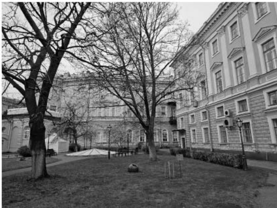
23. Объект культурного наследия федерального значения «Дворец», в составе объекта культурного наследия федерального значения «Дворец Маринский», по адресу: г. Санкт-Петербург, Исаакиевская пл., д. 6, лит. А. Общий вид территории парадного двора.
