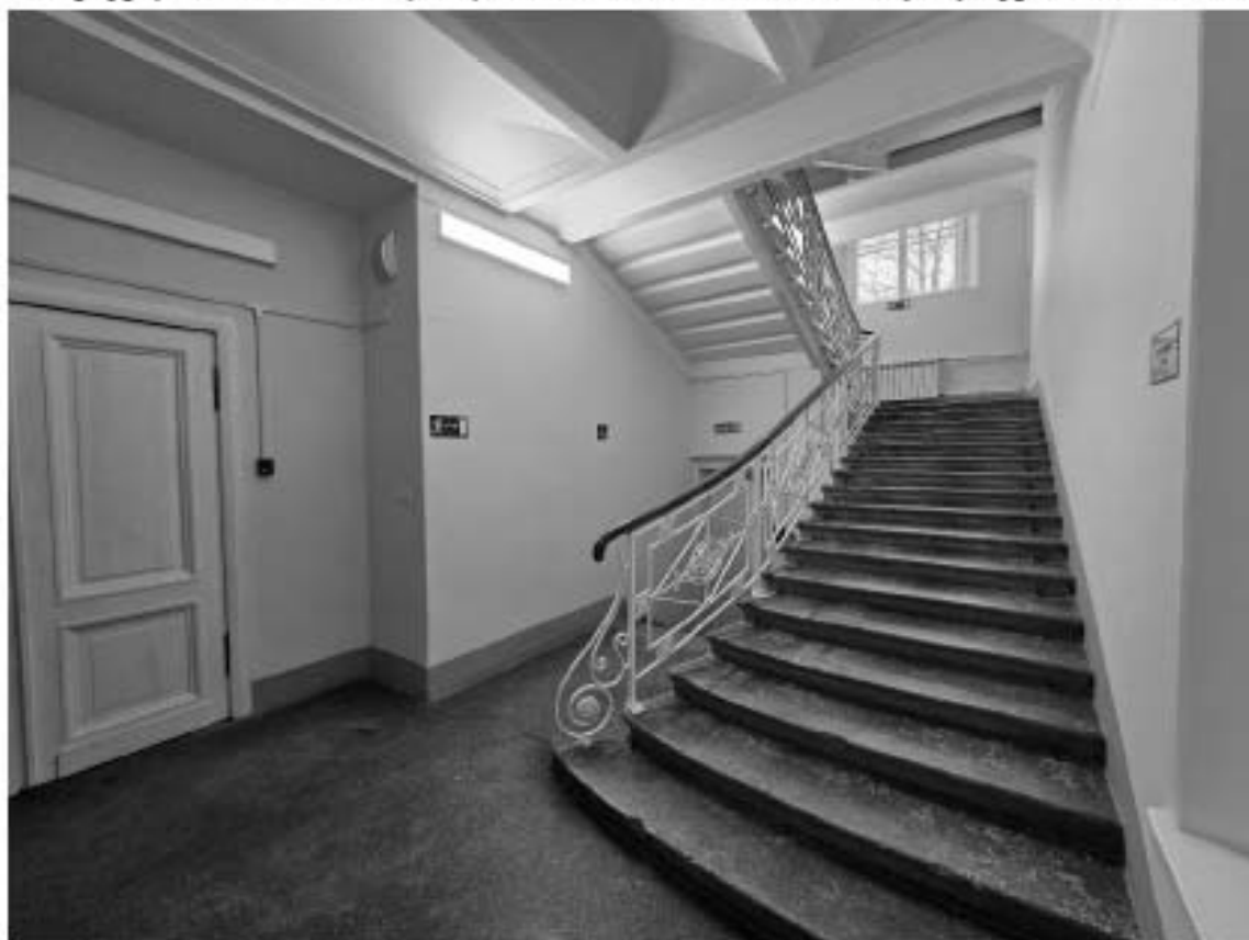
54. Объект культурного наследия федерального значения «Дворец», в составе объекта культурного наследия федерального значения «Дворец Маринский», по адресу: г. Санкт-Петербург, Исаакиевская пл., д. 6, лит. А. Общий вид лестницы Л-9 в уровне 1-го этажа.
