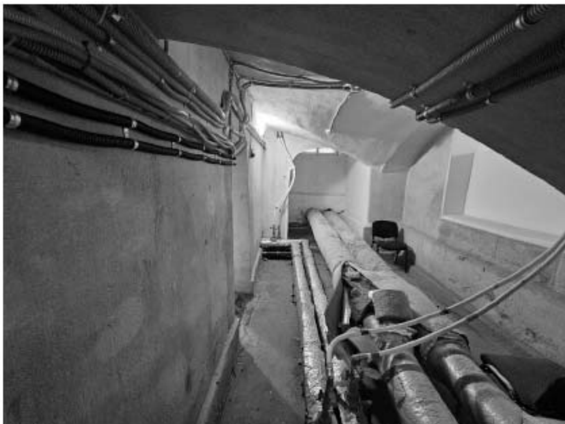
32. Объект культурного наследия федерального значения «Дворец», в составе объекта культурного наследия федерального значения «Дворец Маринский», по адресу: г. Санкт-Петербург, Исаакиевская пл., д. 6, лит. А. Фрагмент пом. 8-Н (61) в уровне подвала.
