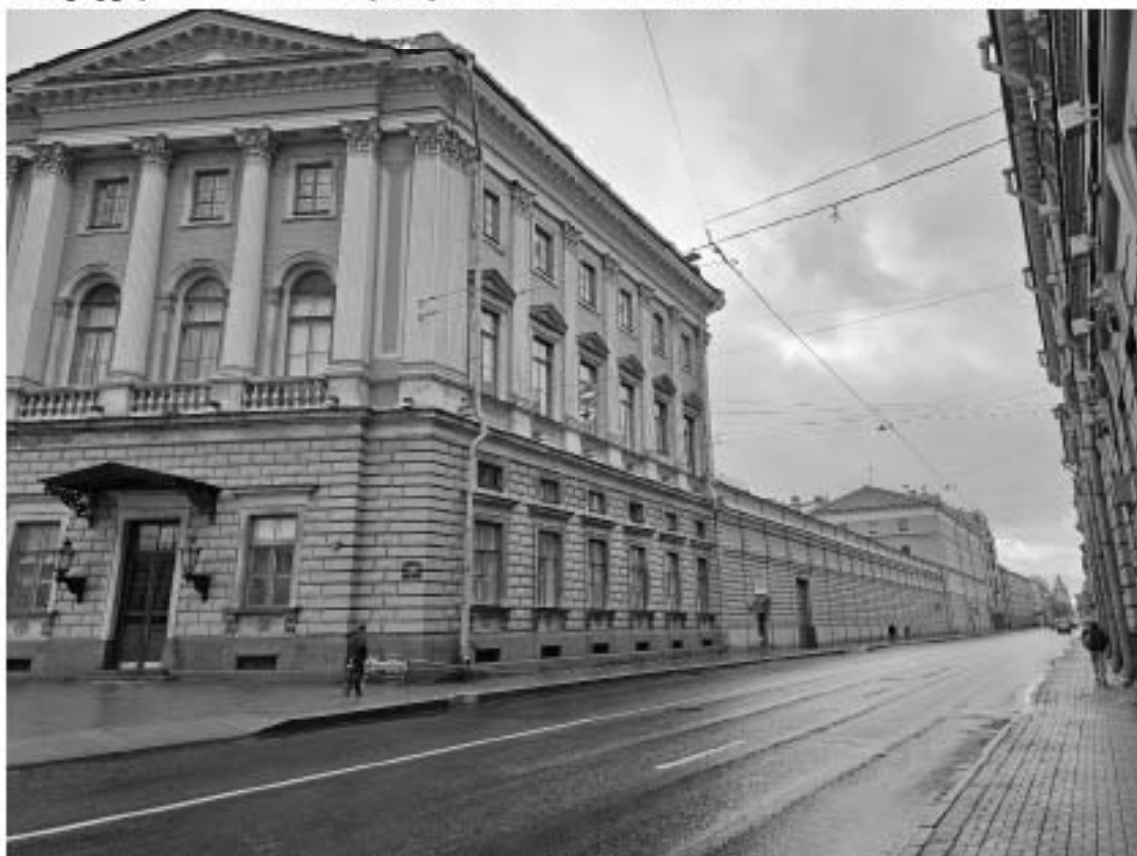
2. Объект культурного наследия федерального значения «Дворец», в составе объекта культурного наследия федерального значения «Дворец Маринский», по адресу: г. Санкт-Петербург, Исаакиевская пл., д. 6, лит. А. Общий вид фасада по Вознесенскому проспекту и западного ризалита лицевого фасада.
