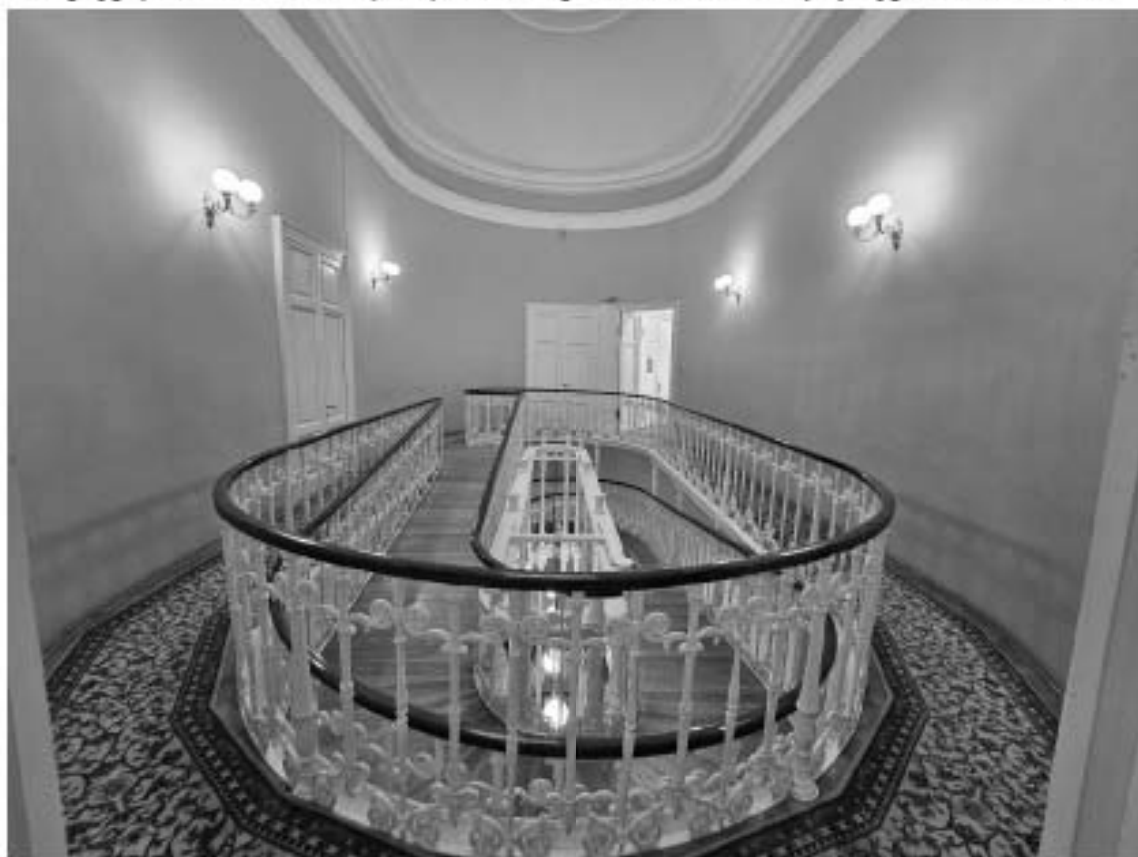
120. Объект культурного наследия федерального значения «Дворец», в составе объекта культурного наследия федерального значения «Дворец Маринский», по адресу: г. Санкт-Петербург, Исаакиевская пл., д. 6, лит. А. Общий вид пандуса в уровне 3-го этажа.
