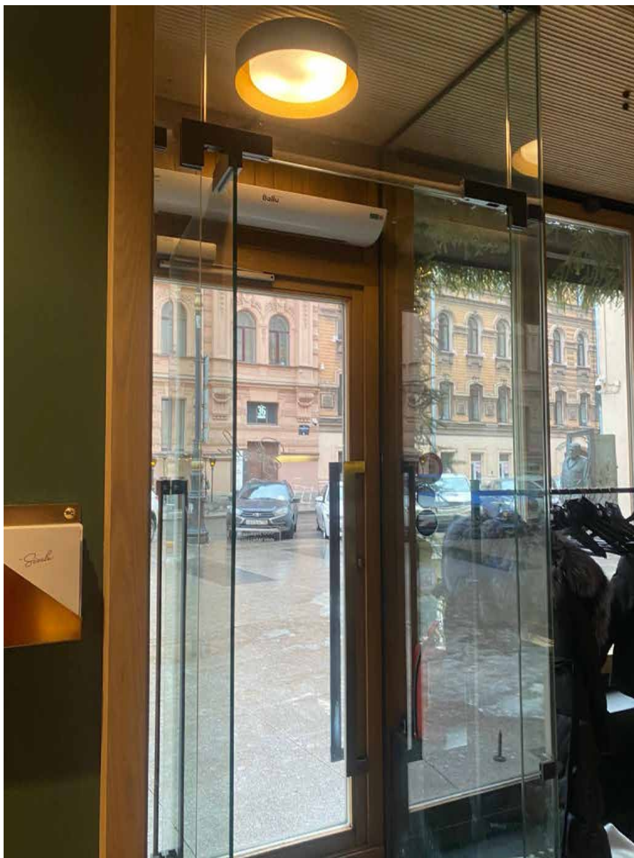
3. Вид на входную дверь в помещение 3-Н;
