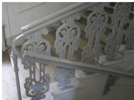
местоположение, габариты, тип и конфигурация черных лестниц (4 штуки) дворовых корпусов (маршевая с поворотом), материал ступеней (лещадная плита);
