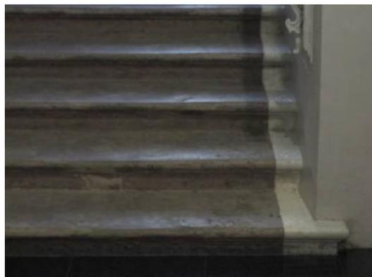
лестница № 2 по наб. реки Мойки – тип (маршевая с поворотом), конструкция (лестничные марши на косоурах), материал ступеней (лещадная плита); ограждение – габариты, материал (металл), техника исполнения (литье), рисунок (растительный орнамент); свод (вестибюль) – коробовый с распалубками и подпружными арками, декорированный профилированными тягами; свод (перекрытий межэтажных площадок) – коробовый с распалубками;
