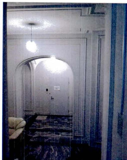
вестибюль – местоположение, габариты, конфигурация (двухуровневый), разделен тремя подпружными коробовыми арками; оформление арок и распалубок – профилированные тяги;
