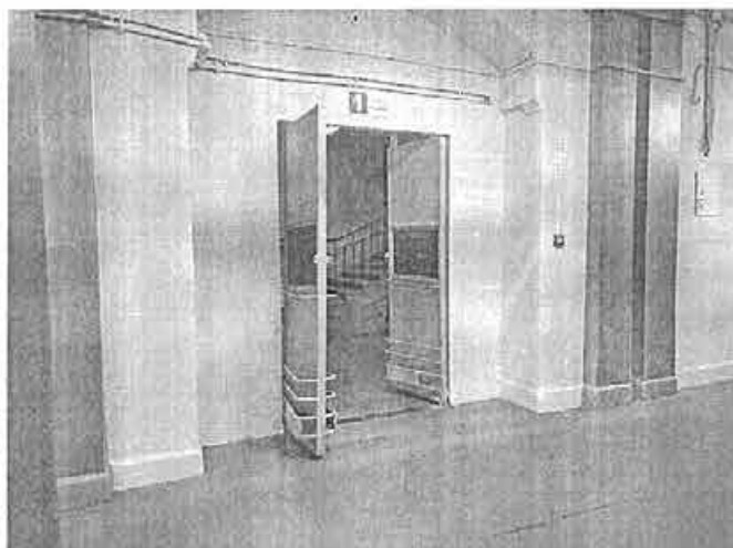
15. Фрагмент вестибюля парадного входа со стороны Гатчинской улицы
