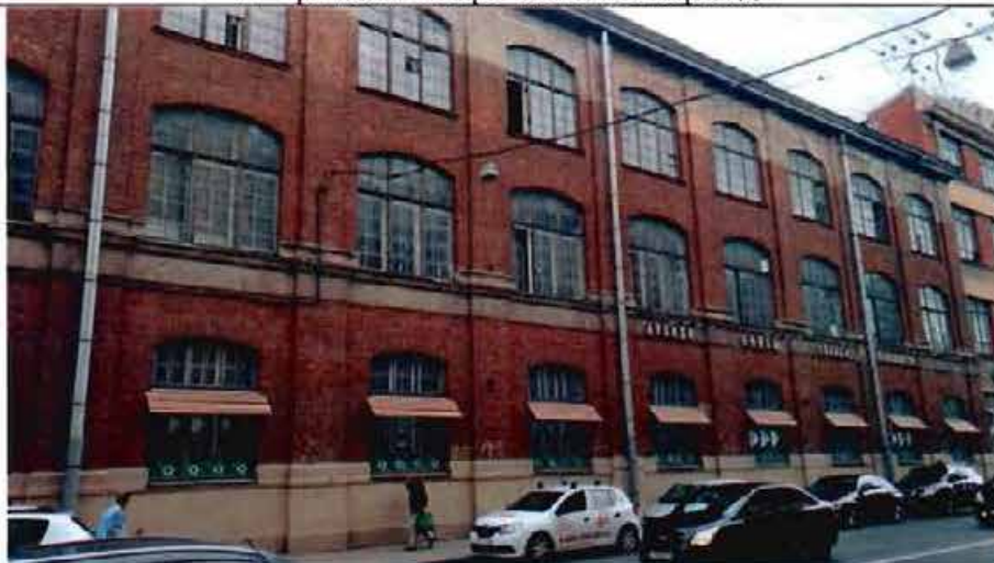
2. Фрагмент северо-западного фасада
