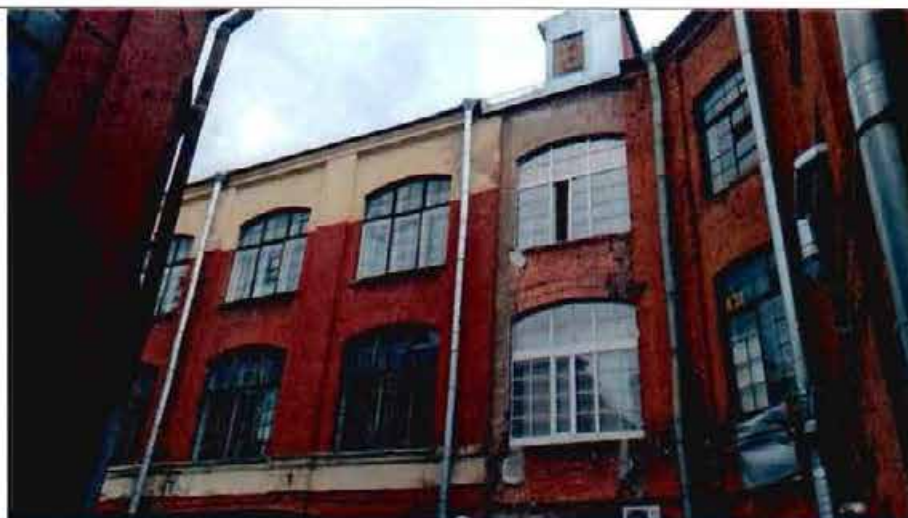
4. Фрагмент дворового фасада
