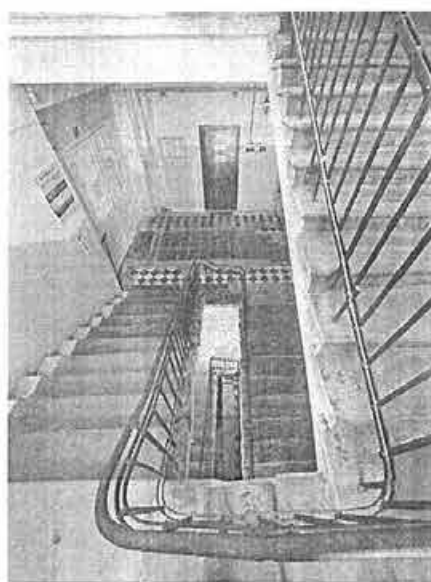
21. Служебная лестница объекта культурного наследия
