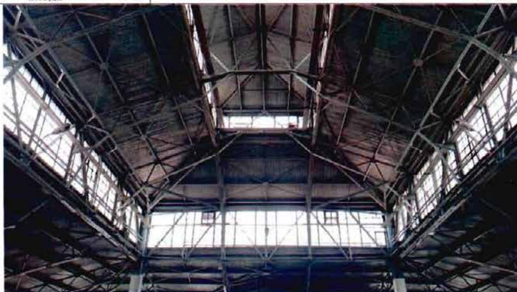
7. Металлоконструкции светового фонаря
