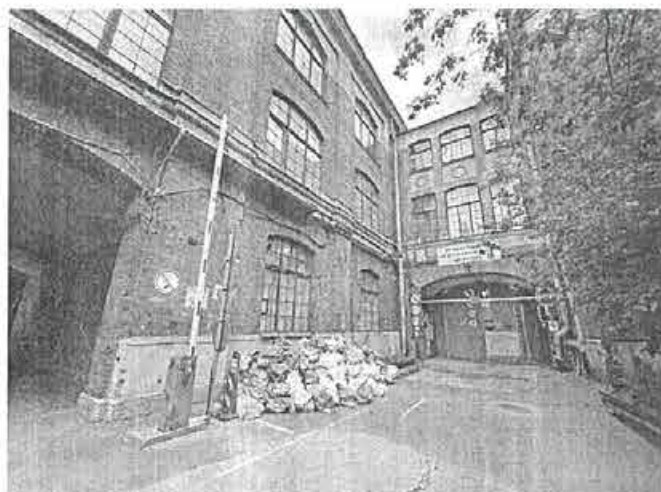
7. Соединительный переход со стороны внутреннего двора объекта культурного наследия
