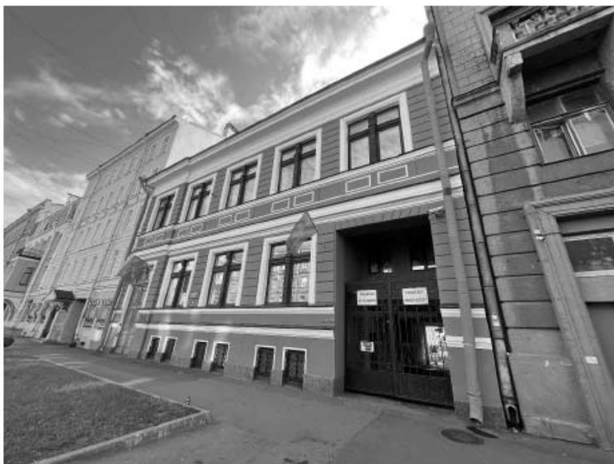
Фото №2. Лицевой западный фасад, общий вид.
