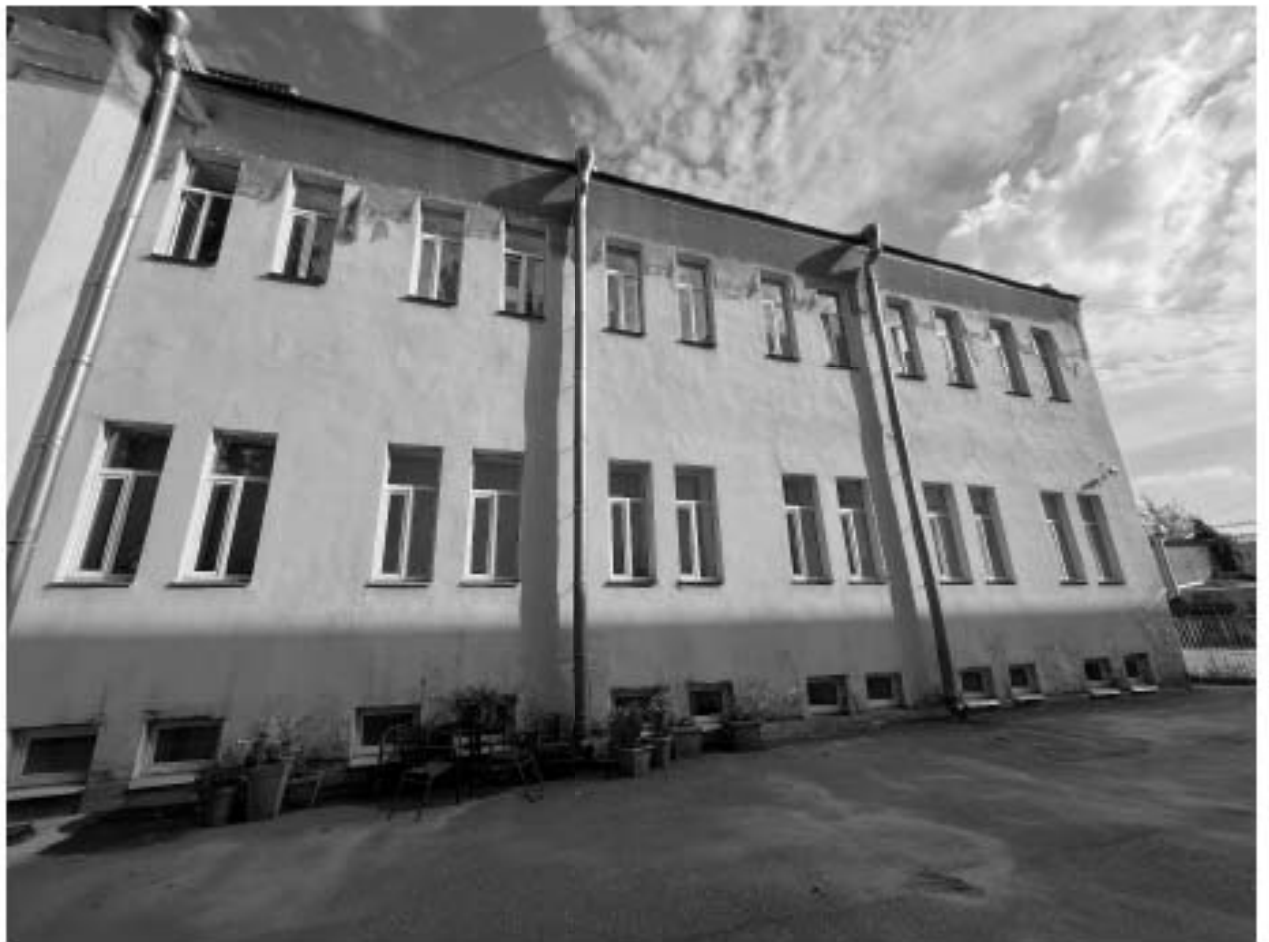
Фото №12. Фрагмент южного дворового фасада, вход здание.
