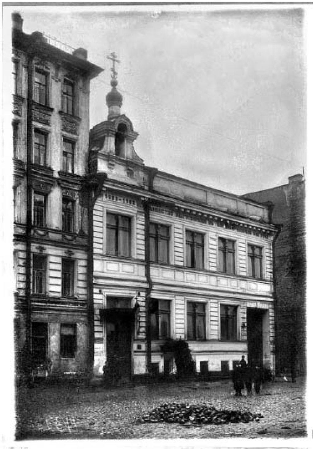
Илл. №1. Тамбовская ул., 16, 1926 г. (источник: www.citywalls.ru со ссылкой на ЦГАКФФД Гр 31219).
