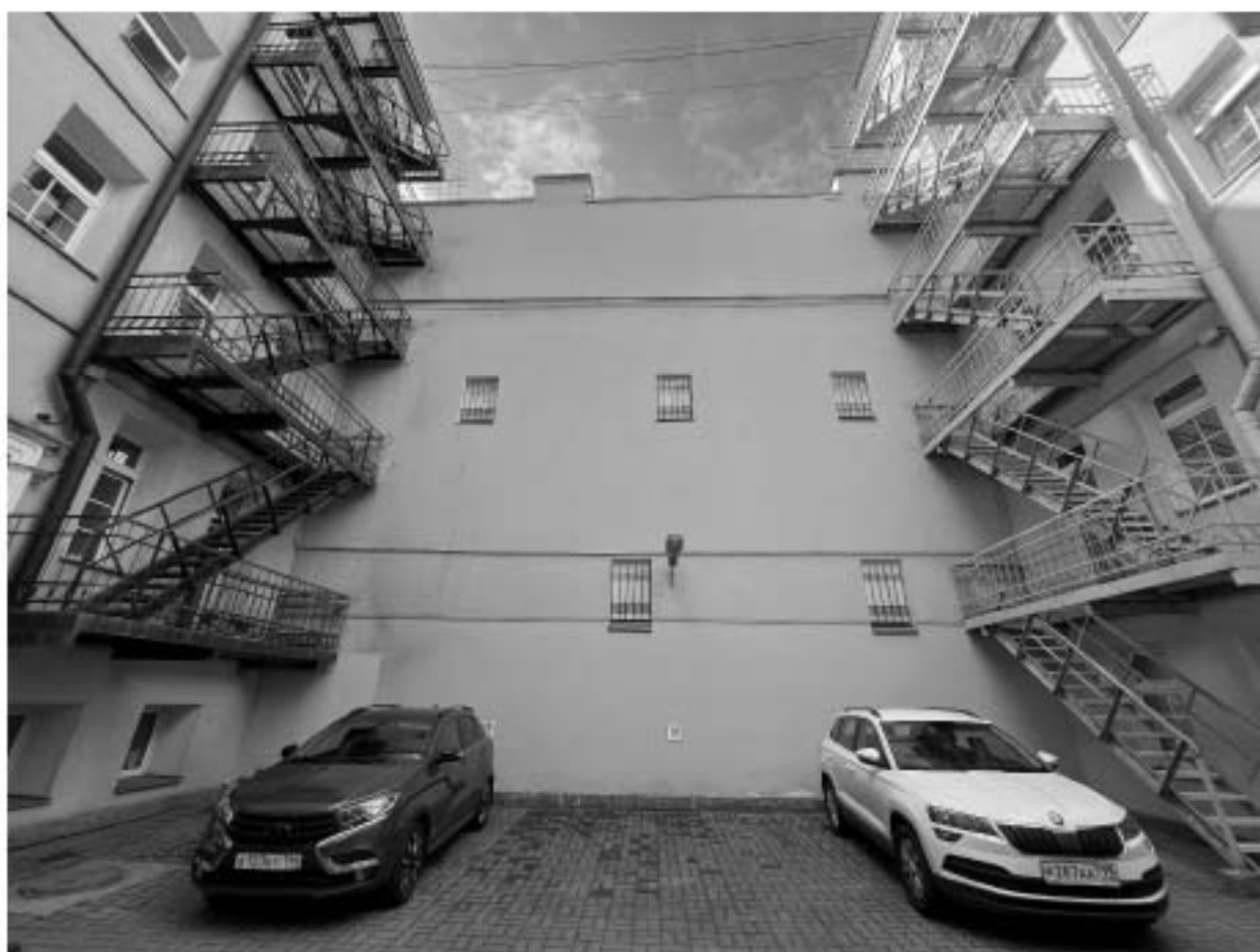
Фото №16. Фрагмент северного дворового фасада.
