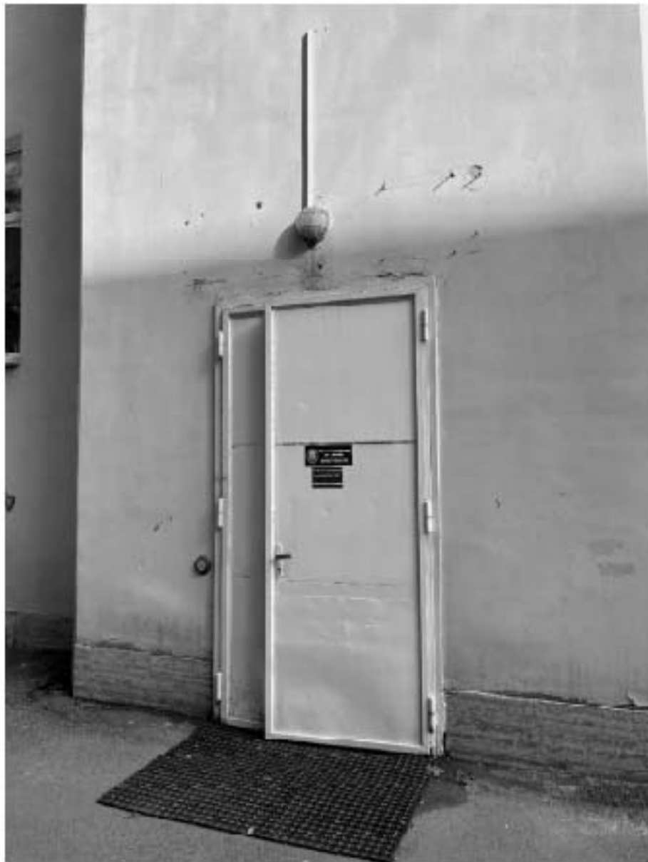
Фото №11. Фрагмент южного дворового фасада, вход здание.
