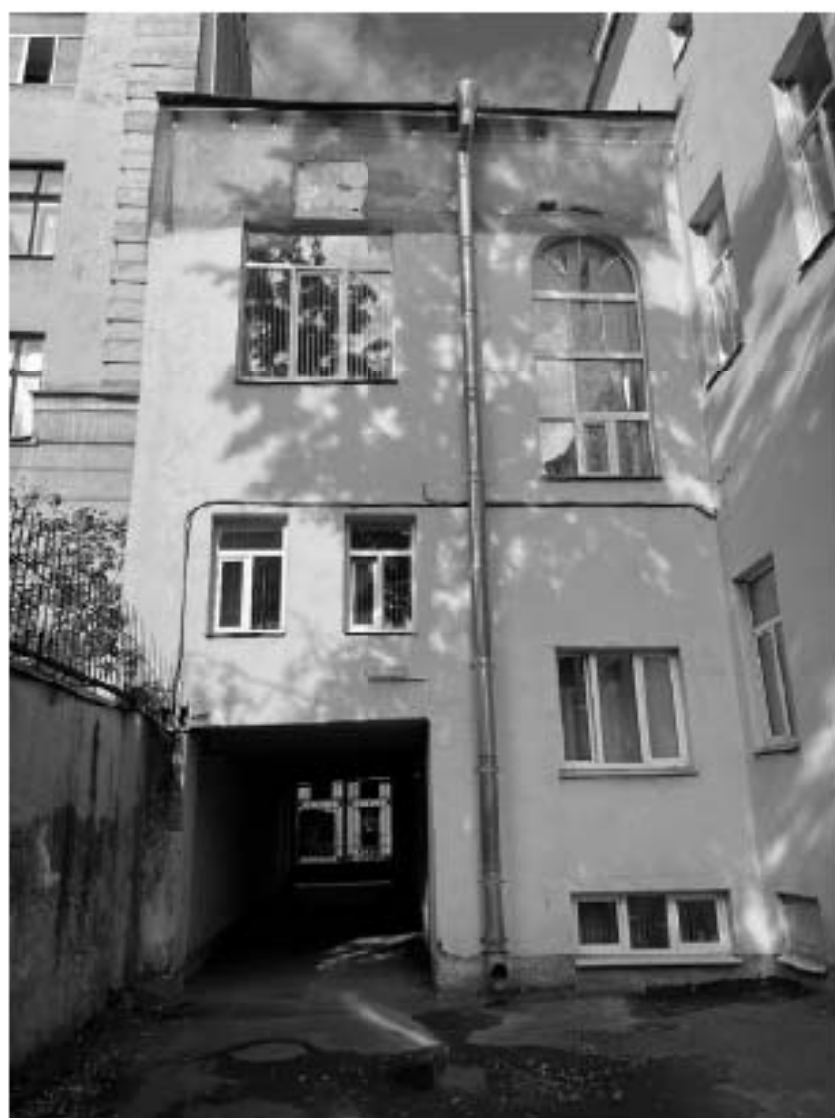
Фото №6. Восточный дворовый фасад.
