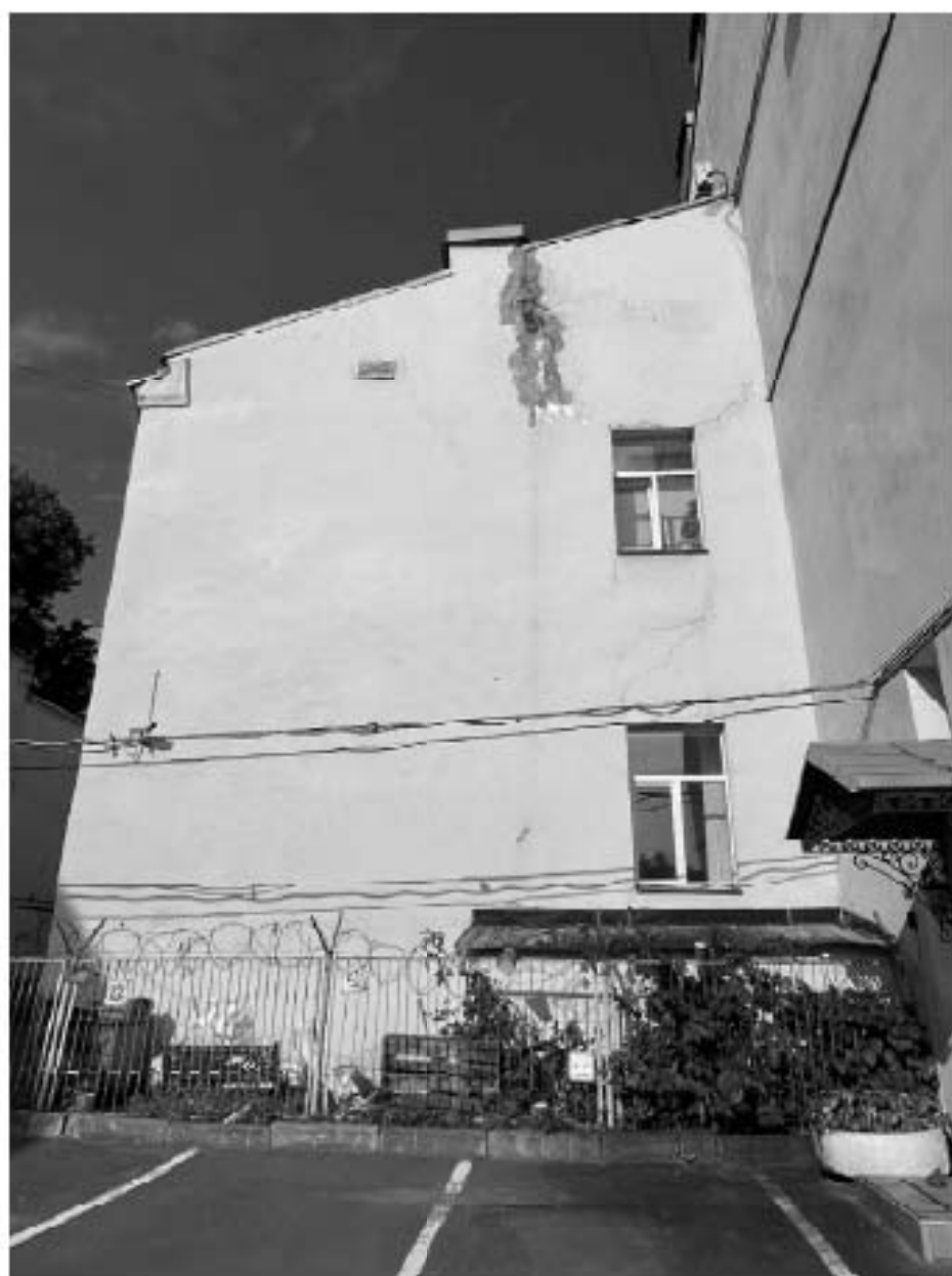
Фото №14. Восточный торцевой фасад.
