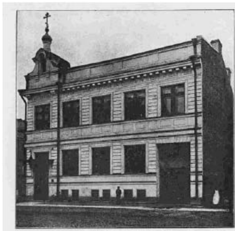
Илл 5. Тамбовская ул., 16 (источник: www.citywalls.ru ).
