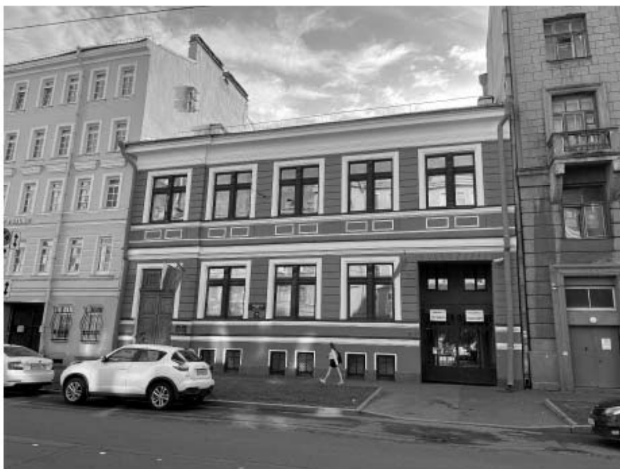
Фото №1. Лицевой западный фасад, общий вид.
