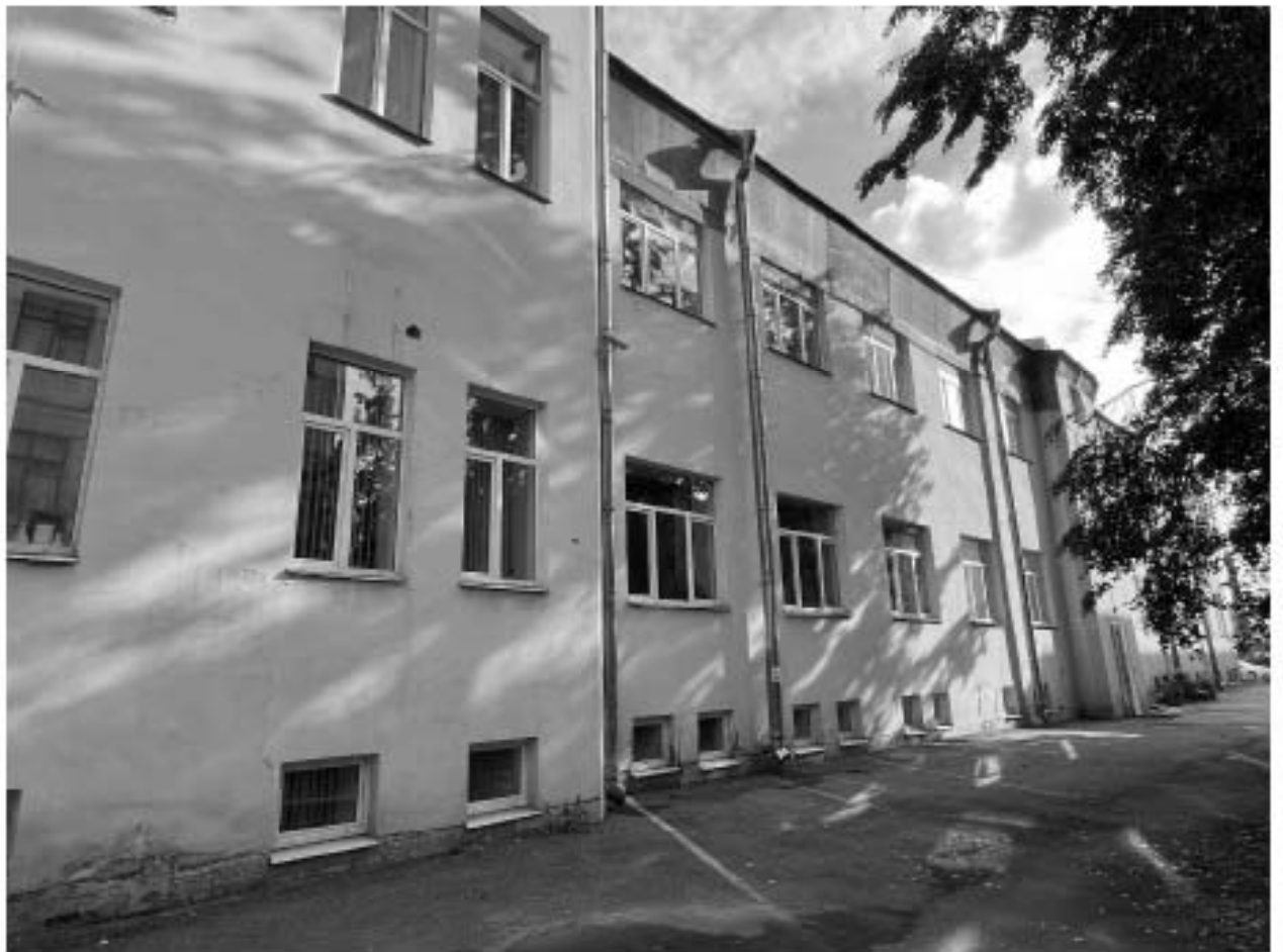
Фото №8. Южный дворовый фасад.
