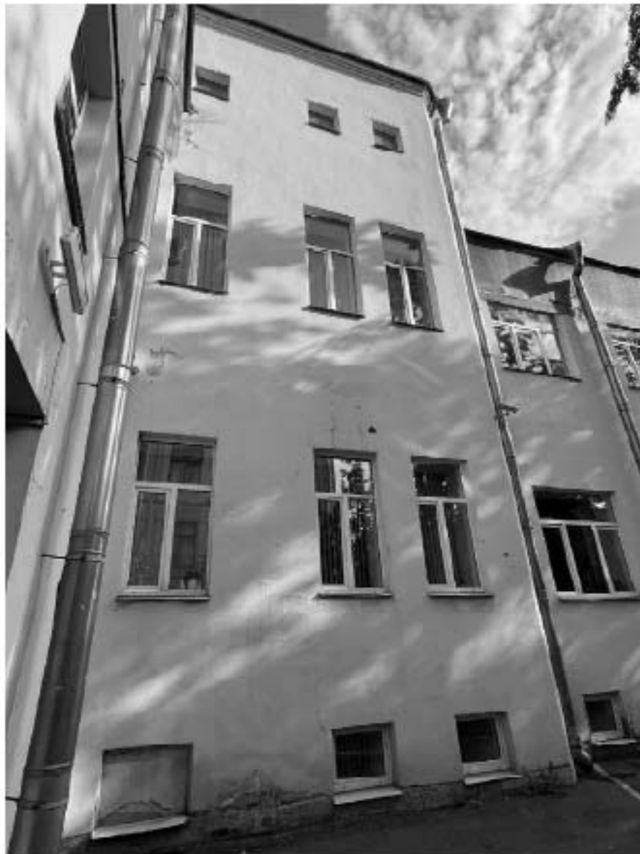
Фото №7. Фрагмент южного дворового фасада.
