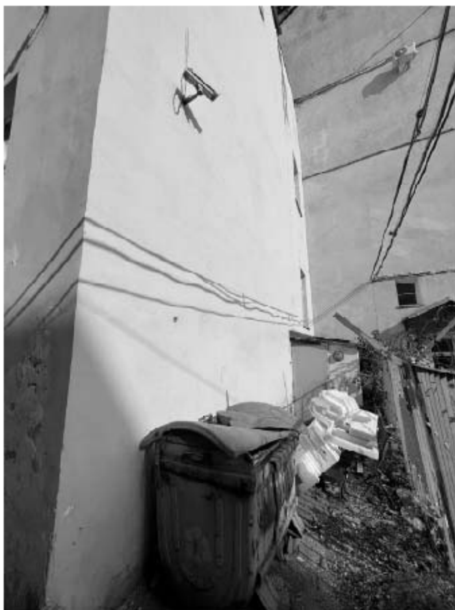
Фото №13. Фрагмент восточного (торцевого) дворового фасада.
