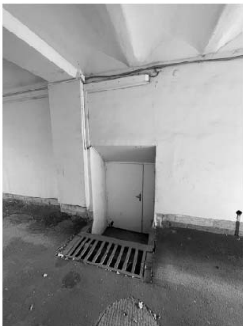
Фото №5. Воротный проезд, прямик, вход в подвал.
