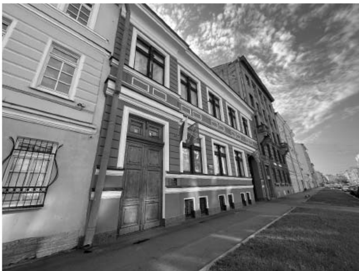
Фото №3. Лицевой западный фасад, общий вид.
