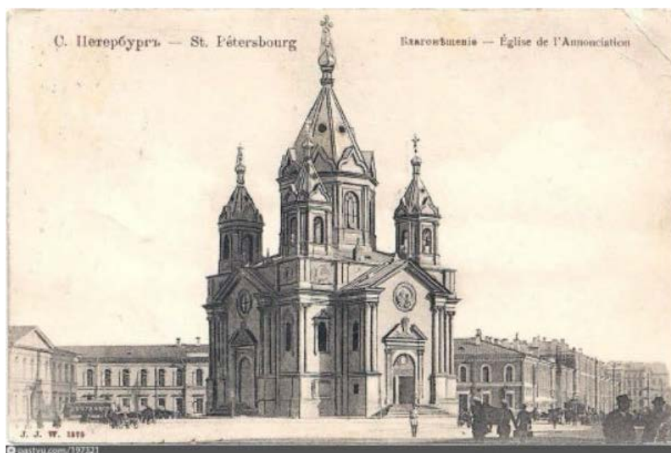
12. Фото Благовещенской церкви (ныне не существует) около 1885-1890 годов, на заднем плане обследуемый участок объекта культурного наследия «Казармы с конюшнями» – фасад с Актовым залом http://www.pastvu.com
