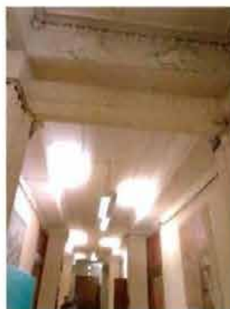
8. Помещение 1-го этажа.
