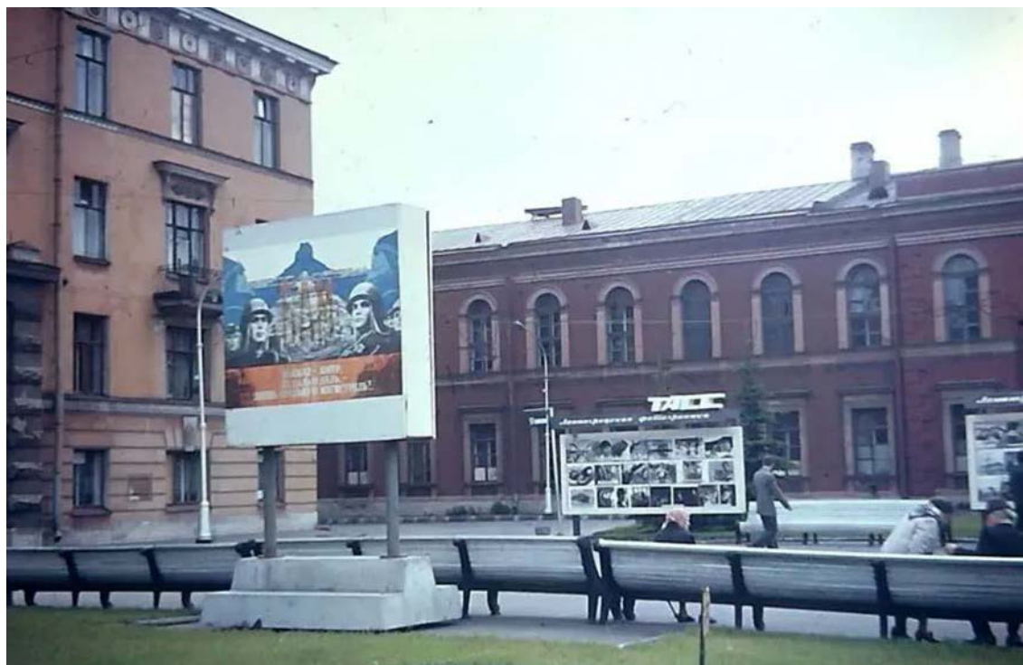
17. Фото 1975 год. Объект культурного наследия «Казармы с конюшнями». (СПб., Большая Морская ул., д. 67 лит. А) Вид на «Казармы с конюшнями», фасад по площади Труда https://www.pastvu.com/p/337993
