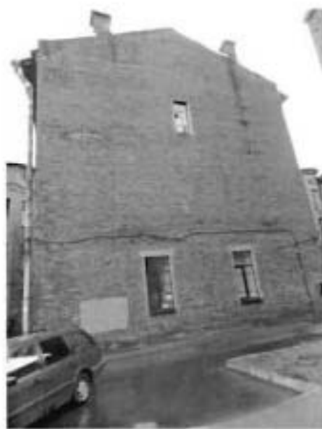
20. Флигель сиротского дома. Фрагмент северо-западного дворового фасада.
