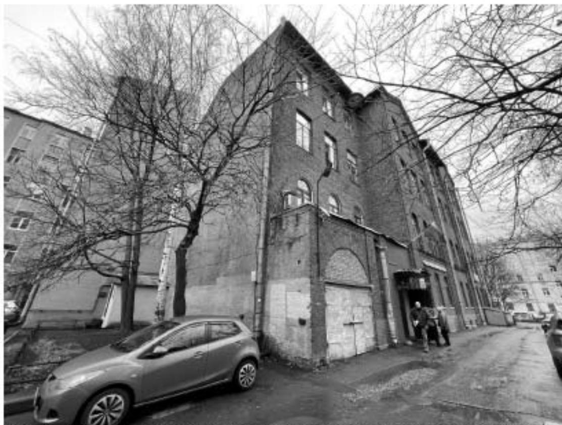
Фото 11. Фрагмент лицевого фасада объекта культурного наследия регионального значения «Школа и приют лютеранской церкви св. Екатерины»
