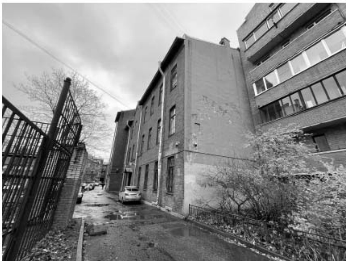
Фото 1. Фрагмент лицевого фасада объекта культурного наследия регионального значения «Школа и приют лютеранской церкви св. Екатерины»
