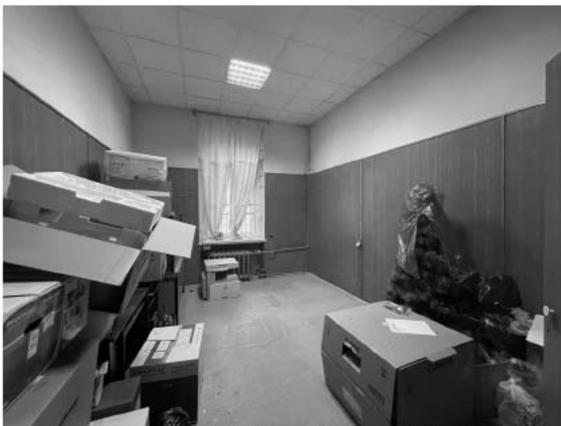
Фото 59. Интерьер 2 этажа объекта культурного наследия регионального значения «Школа и приют лютеранской церкви св. Екатерины»
