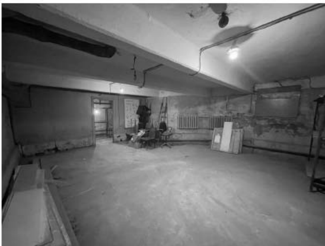
Фото 14. Интерьер подвала объекта культурного наследия регионального значения «Школа и приют лютеранской церкви св. Екатерины»
