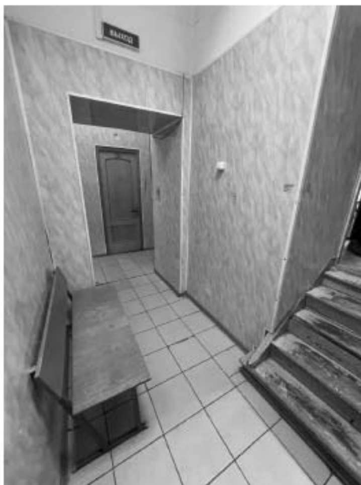
Фото 39. Интерьер 1 этажа объекта культурного наследия регионального значения «Школа и приют лютеранской церкви св. Екатерины»
