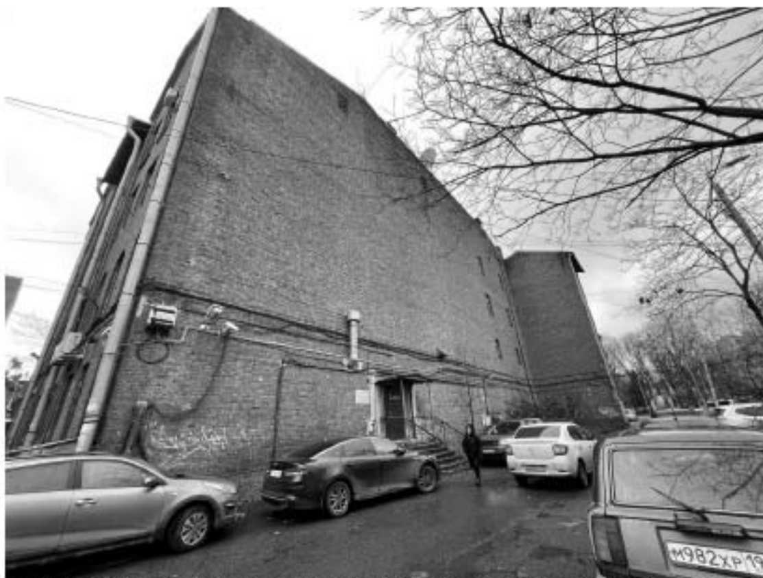
Фото 9. Фрагмент лицевого фасада объекта культурного наследия регионального значения «Школа и приют лютеранской церкви св. Екатерины»
