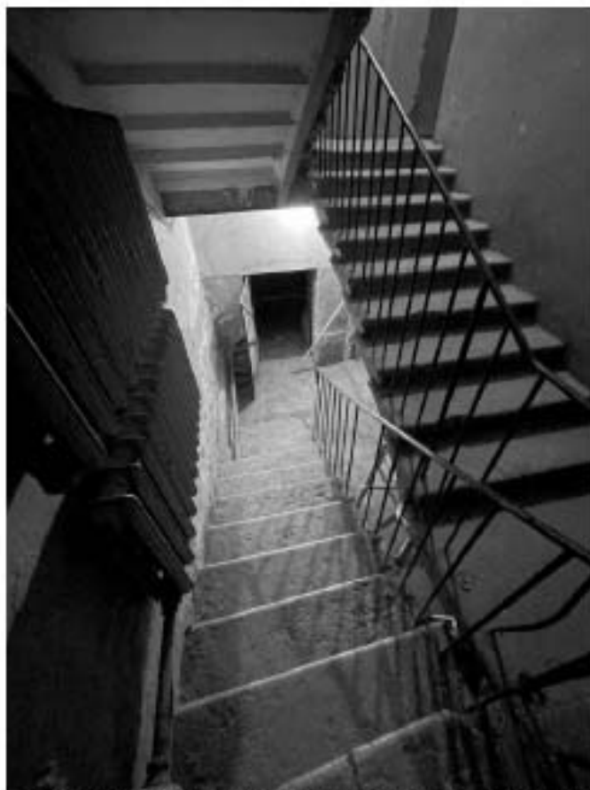
Фото 13. Интерьер подвала объекта культурного наследия регионального значения «Школа и приют лютеранской церкви св. Екатерины»
