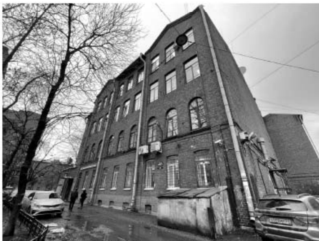
Фото 10. Фрагмент лицевого фасада объекта культурного наследия регионального значения «Школа и приют лютеранской церкви св. Екатерины»
