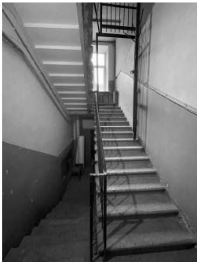
Фото 17. Интерьер 1 этажа объекта культурного наследия регионального значения «Школа и приют лютеранской церкви св. Екатерины»
