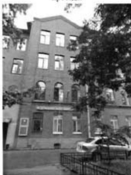
19. Флигель сиротского дома. Фрагмент юго-восточного фасада.
