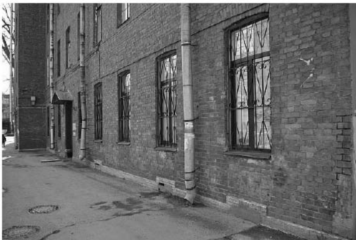
14. 2010 г. — Отдел военного комиссариата Санкт-Петербурга по Василеостровскому району // Citywalls.ru – архитектурный сайт Петербурга [Электронный ресурс]. URL: https://www.citywalls.ru/house11997.html .
