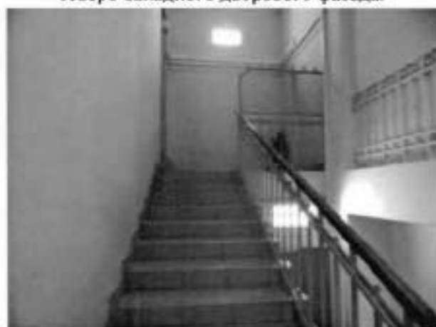
22. Флигель сиротского дома. Внутреннее помещения. Соединительная часть южного и северного крыла. Лестничная клетка.
