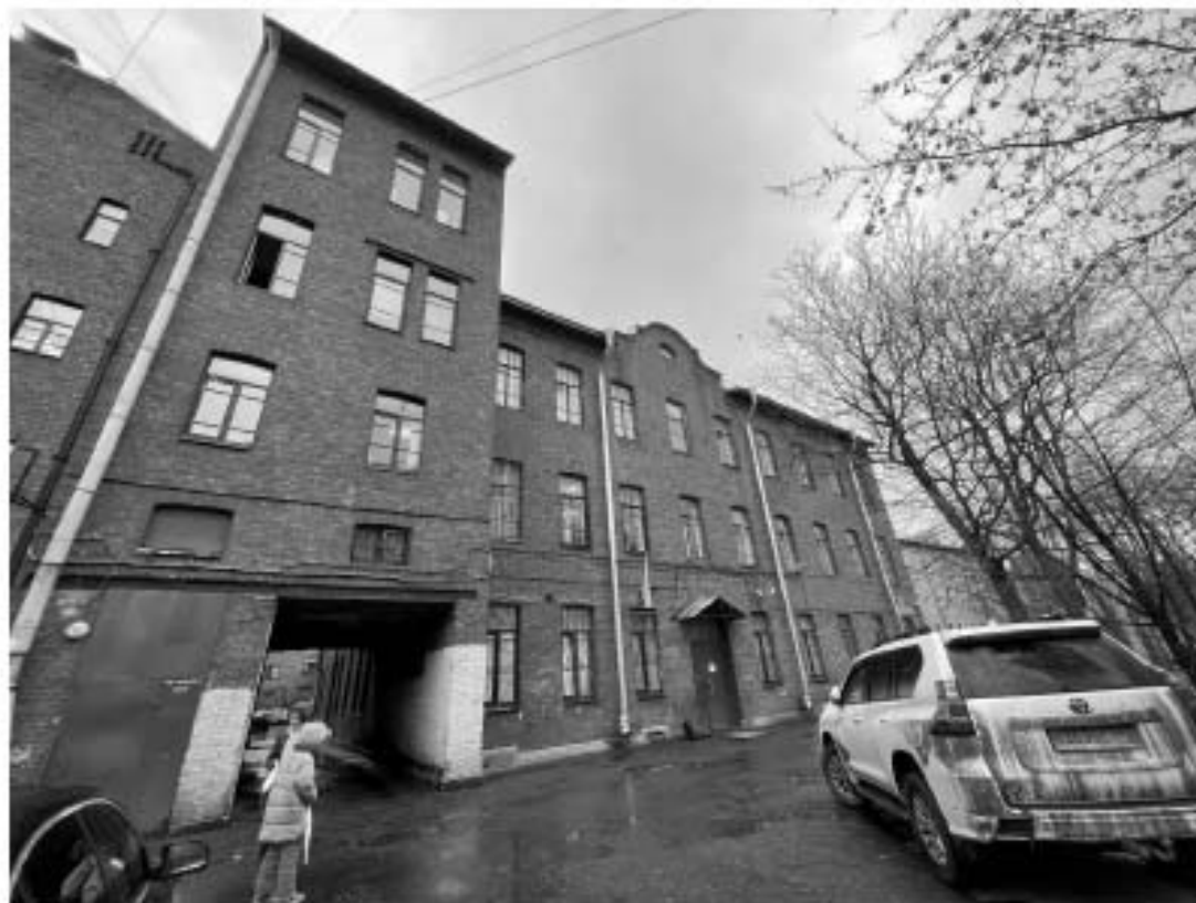
Фото 2. Фрагмент лицевого фасада объекта культурного наследия регионального значения «Школа и приют лютеранской церкви св. Екатерины»
