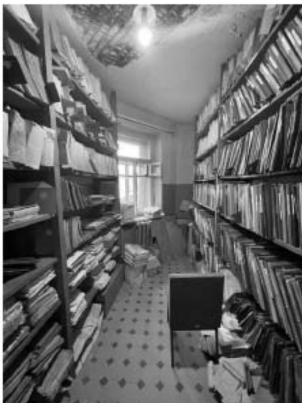
Фото 87. Интерьер мансарды объекта культурного наследия регионального значения «Школа и приют лютеранской церкви св. Екатерины»
