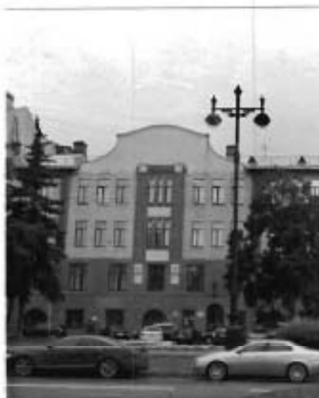
13. Сиротский дом со школой. Лицевой фасад.
