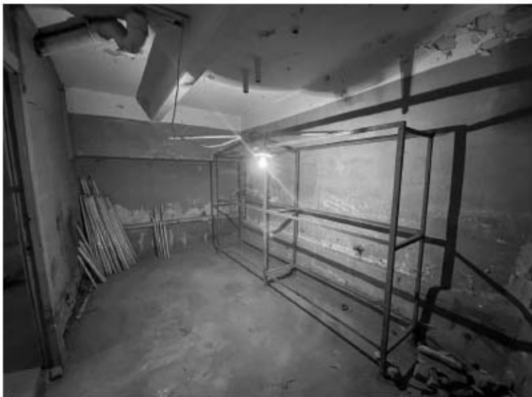
Фото 15. Интерьер подвала объекта культурного наследия регионального значения «Школа и приют лютеранской церкви св. Екатерины»
