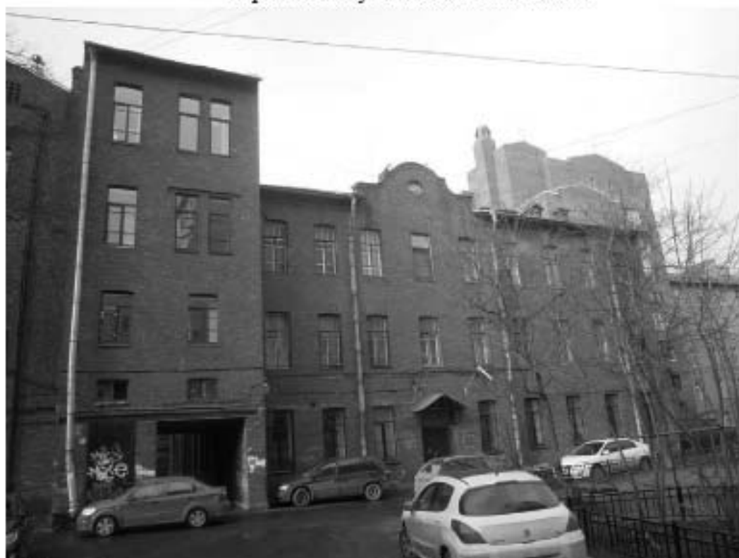
15. 2015 г. — Отдел военного комиссариата Санкт-Петербурга по Василеостровскому району // Citywalls.ru – архитектурный сайт Петербурга [Электронный ресурс]. URL: https://www.citywalls.ru/house11997.html .
