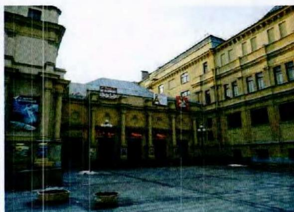
колонны стилизованного тосканского ордера на высоких цоколях, раскрепованный антаблемент из гладкого фриза и выносного профилированного карниза; фигурные штукатурные филенки над дверными проемами; линейные сандрики на стилизованных модульонах;
