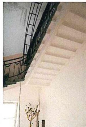
ограждения лестничных маршей кованого черного металла в характере модерна из вертикальных стержней, оканчивающихся гирькой, в верхней части крепление в форме шара, вписанного в круг, с коваными деталями в виде провисающих драпировок и бантов на тетиве;
