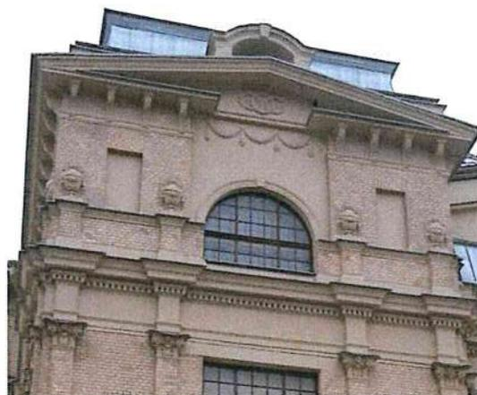
филенки, оформленные фактурной штукатуркой «в расческу» вертикальную в уровне третьего этажа - нижняя часть с выбранными углами верхняя с лепной композицией из фланкирующих провисающих гирлянд и центрального прямоугольного «зеркала» с круглым медальоном, декорированным стилизованными волютами, провисающими гирляндами и оканчивающегося стилизованными шишками по сторонам и фигурной частью между ними.
