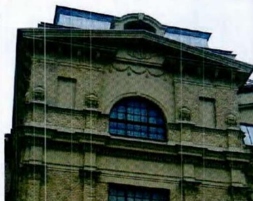
филенки, оформленные фактурной штукатуркой «в расческу» вертикальную в уровне третьего этажа - нижняя часть с выбранными углами верхняя с лепной композицией из фланкирующих провисающих гирлянд и центрального прямоугольного «зеркала» с круглым медальоном, декорированным стилизованными волютами, провисающими гирляндами и оканчивающегося стилизованными шишками по сторонам и фигурной частью между ними.
