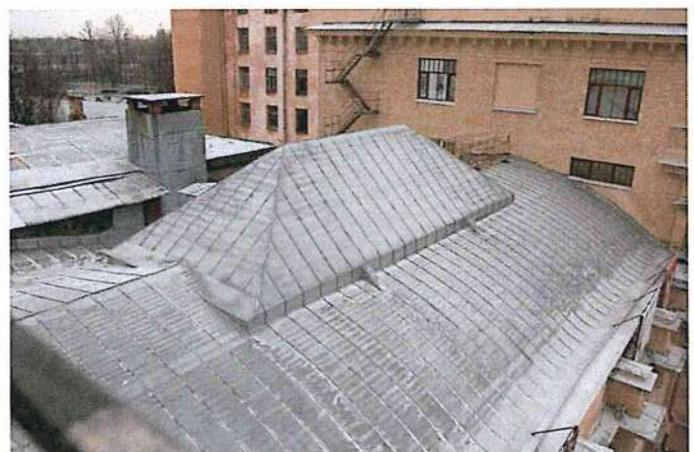
скатная крыша лучковой конфигурации над дворовым 8-этажным объемом и над двухэтажным соединительным корпусом в месте примыкания к основному лицевому объему;
