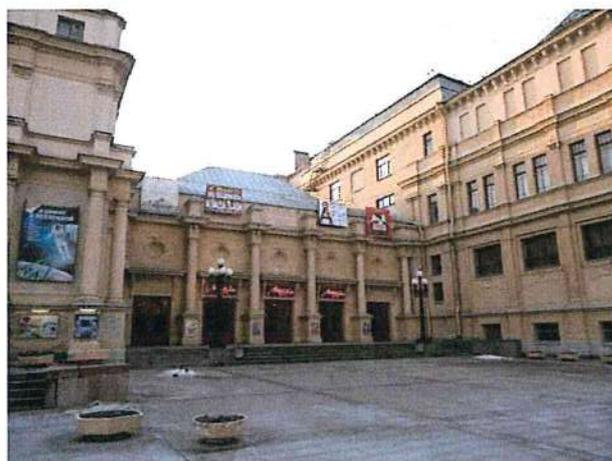
колонны стилизованного тосканского ордера на высоких цоколях, раскрепованный антаблемент из гладкого фриза и выносного профилированного карниза; фигурные штукатурные филенки над дверными проемами; линейные сандрики на стилизованных модульонах;
