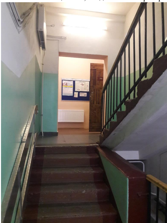
Фото 42. Лестница ЛК 4, вход на 2 этаж пристройки к южной части здания.
