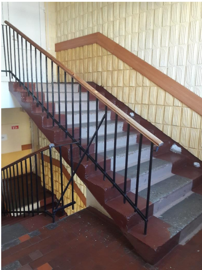
Фото 43. Марш центральной лестницы на 4 этаж.
