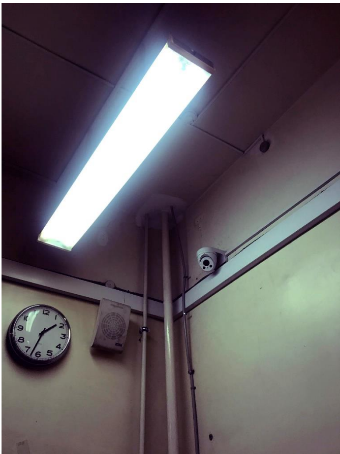
Фото 14. Коридор 2 этажа центральной части здания
