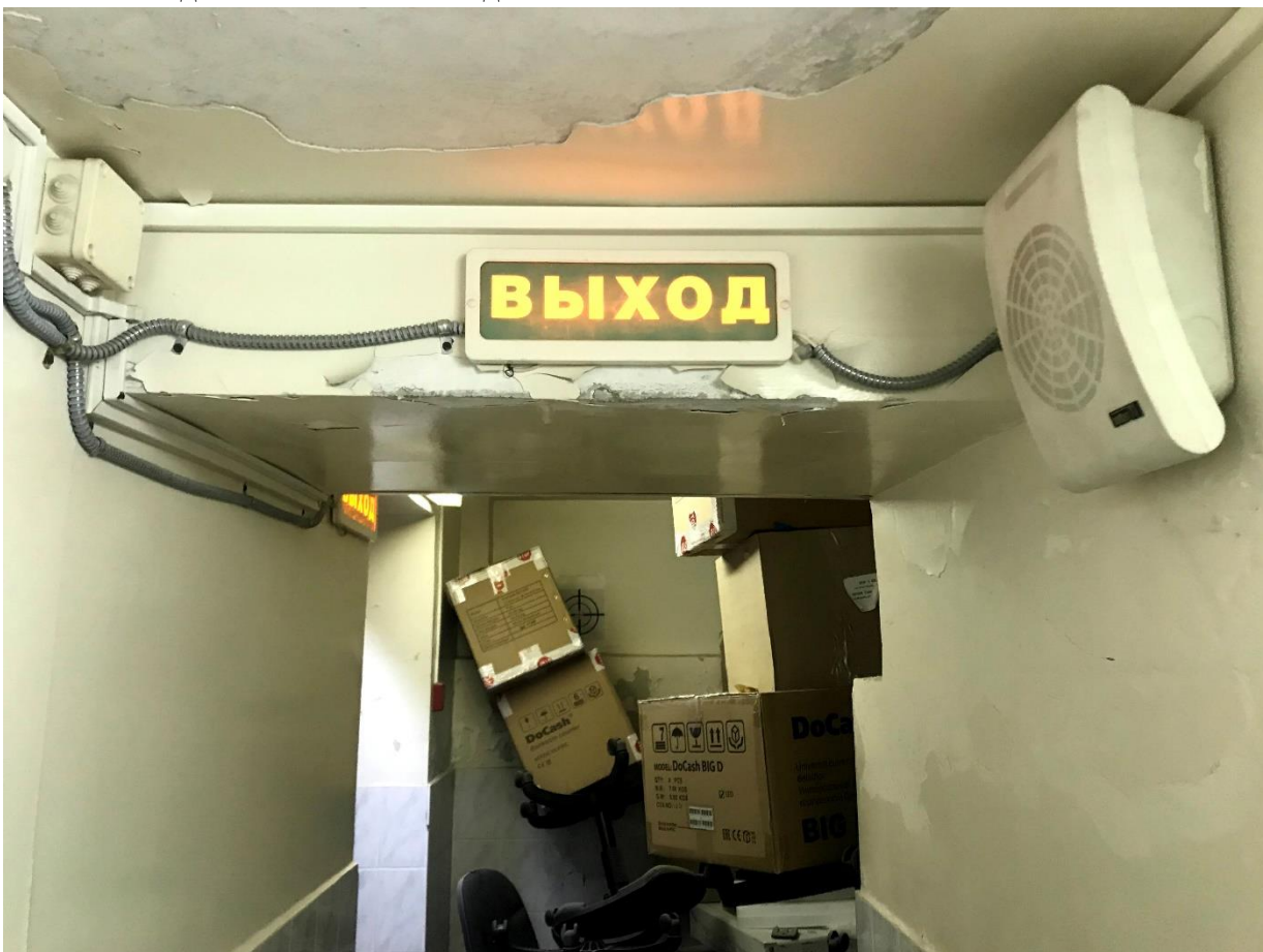
Фото 40. Подвал в южной части здания
