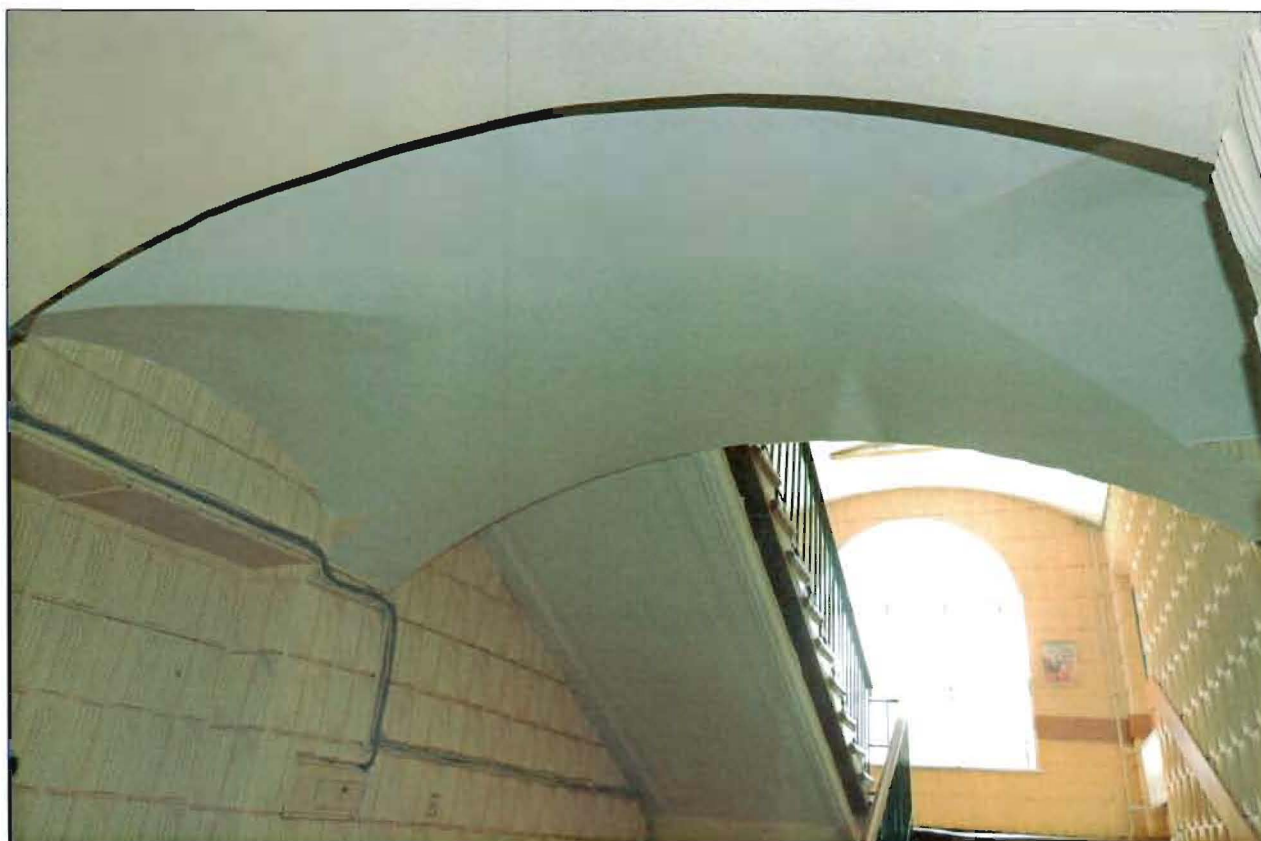
8. Интерьер. Фрагмент. Свод под площадкой парадной лестницы.
