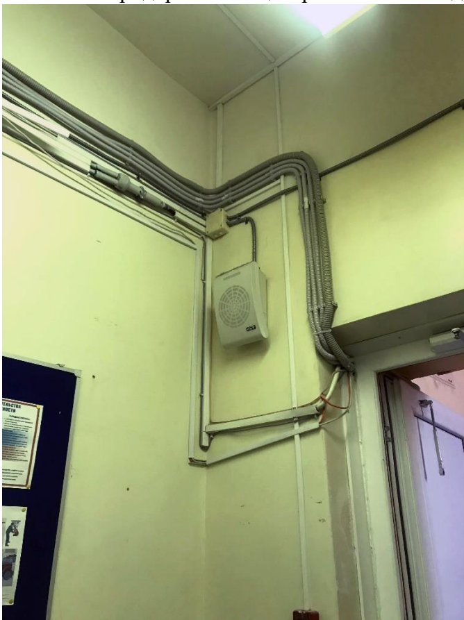
Фото 17. Коридор 2 этажа центральной части здания
