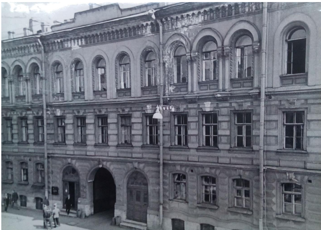
Илл. 5. Лицевой фасад. 1970-е гг. до надстройки 4 этажа.
