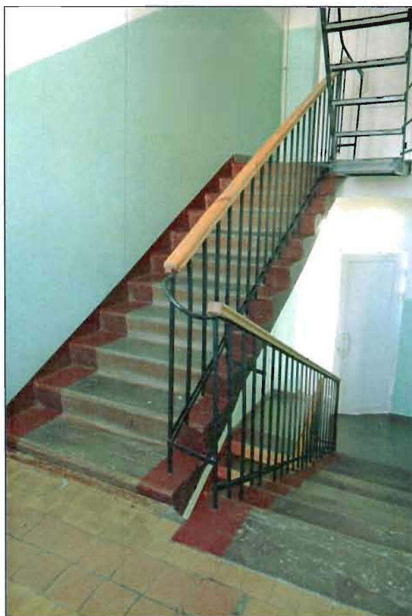
10. Интерьер. Фрагмент. Двухмаршевая межэтажная лестница.
