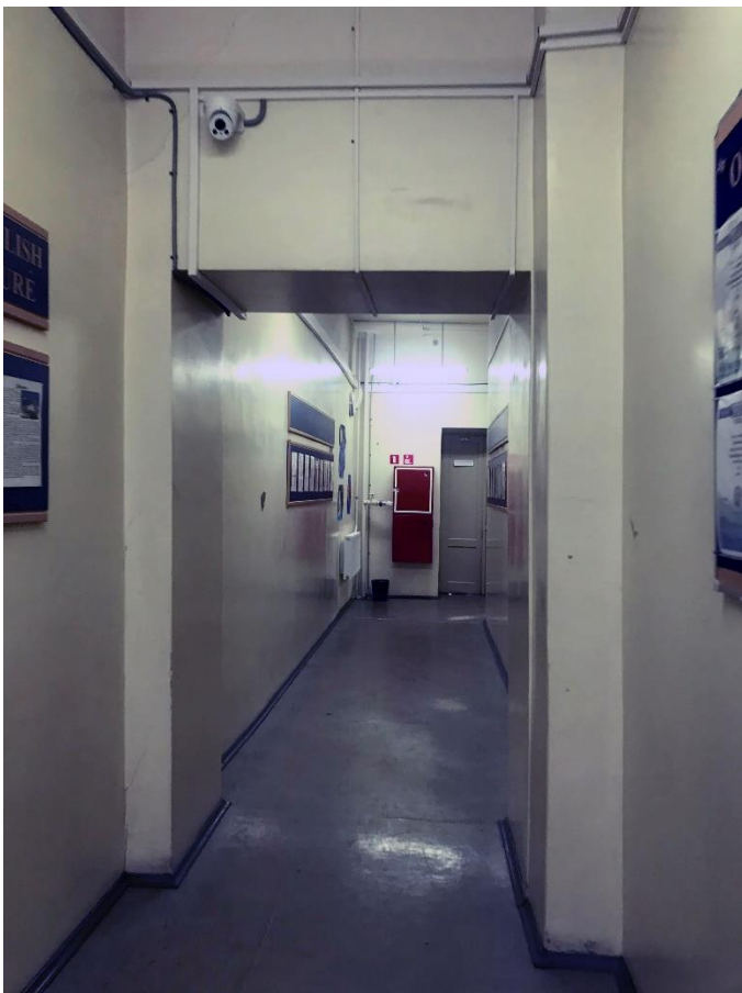
Фото 16. Коридор 2 этажа центральной части здания
