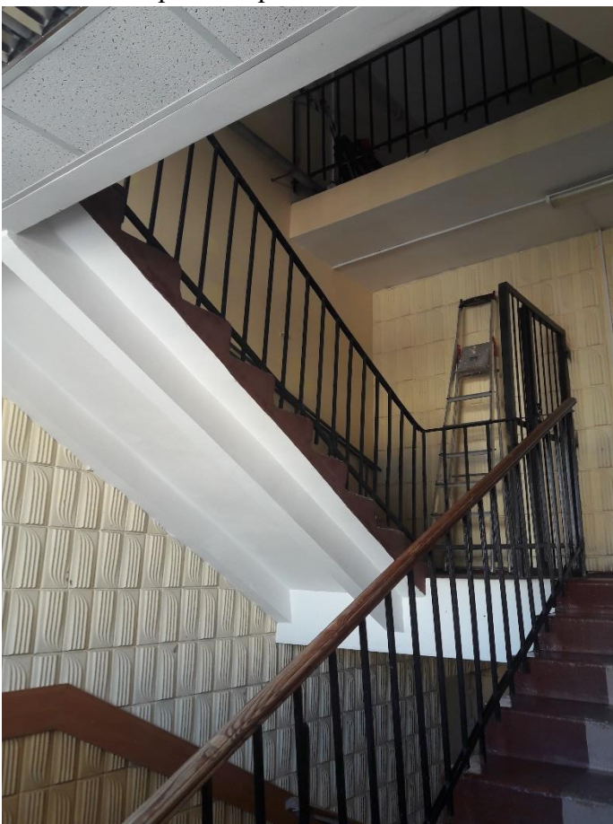
Фото 44. Марш центральной лестницы на 5 этаж.
