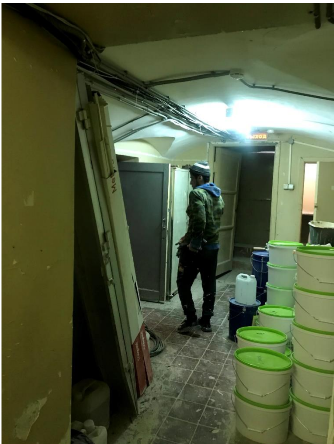
Фото 37. Подвал в южной части здания.
