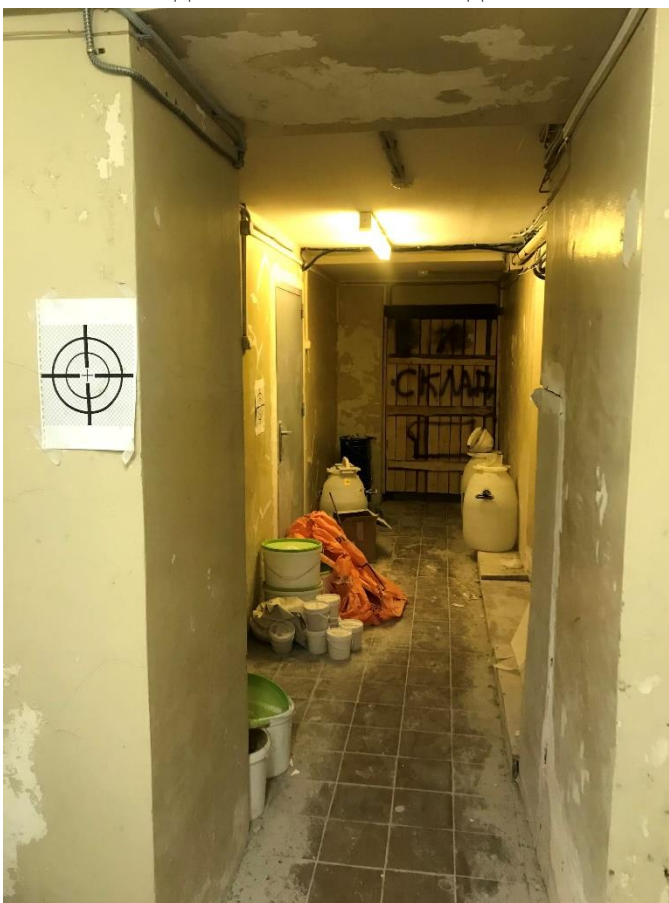
Фото 38. Подвал в южной части здания.
