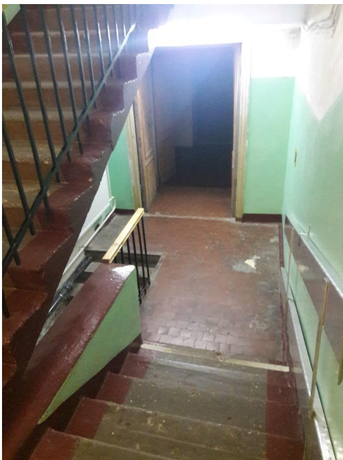
Фото 41. Лестница ЛК 4, вход на 1 этаж пристройки к южной части здания.
