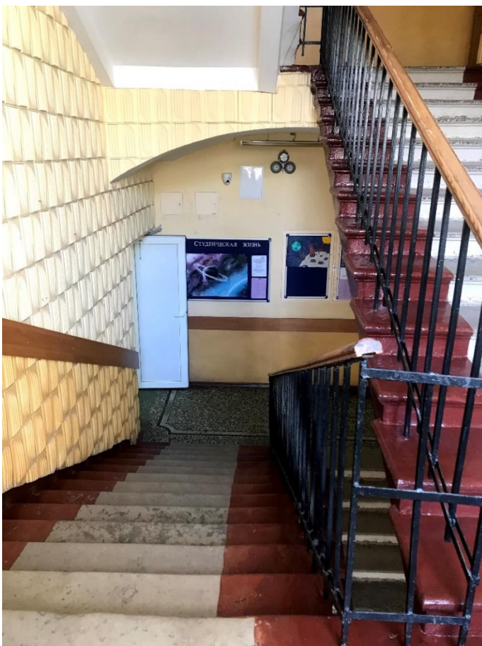
Фото 23. Центральная лестница. Вид с промежуточной площадки на площадку второго этажа.
