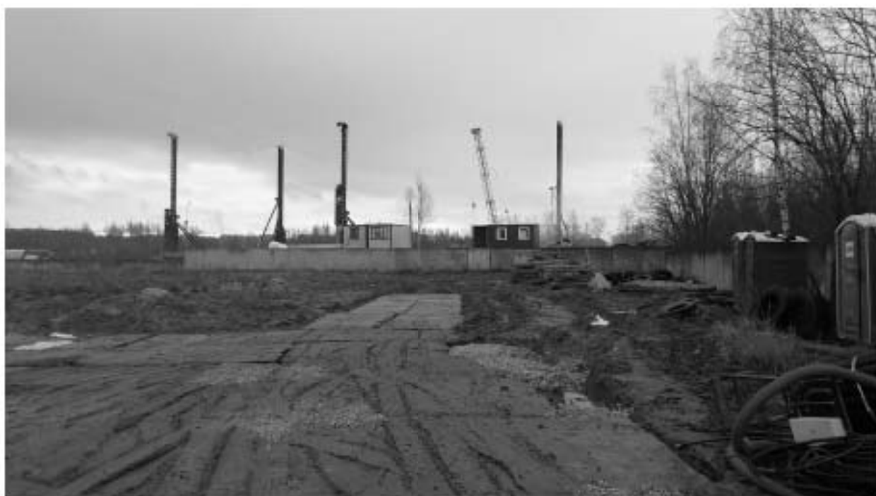
Фотофиксация 2. Западная часть участка обследования. Вид с С.
