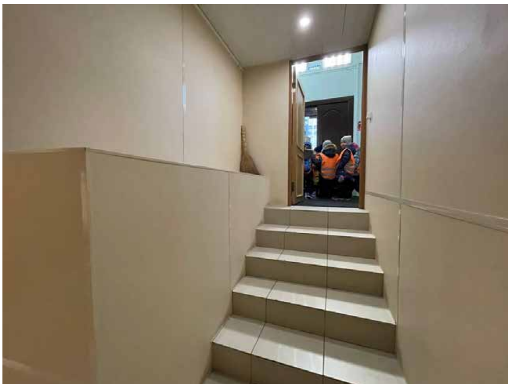
Фото 23. Интерьер пом. 2-Н объекта культурного наследия регионального значения «Дворец вел. кн. Кирилла Владимировича», подвальный этаж
