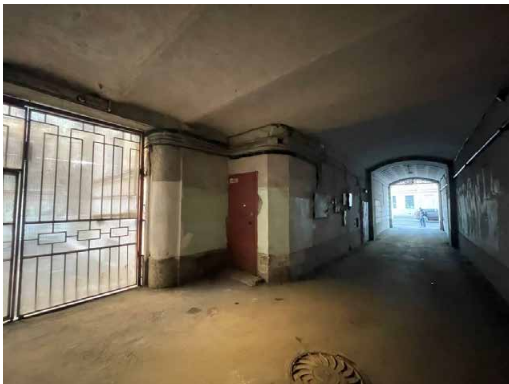
Фото 3. Фрагмент дворового фасада объекта культурного наследия регионального значения «Дворец вел. кн. Кирилла Владимировича»
