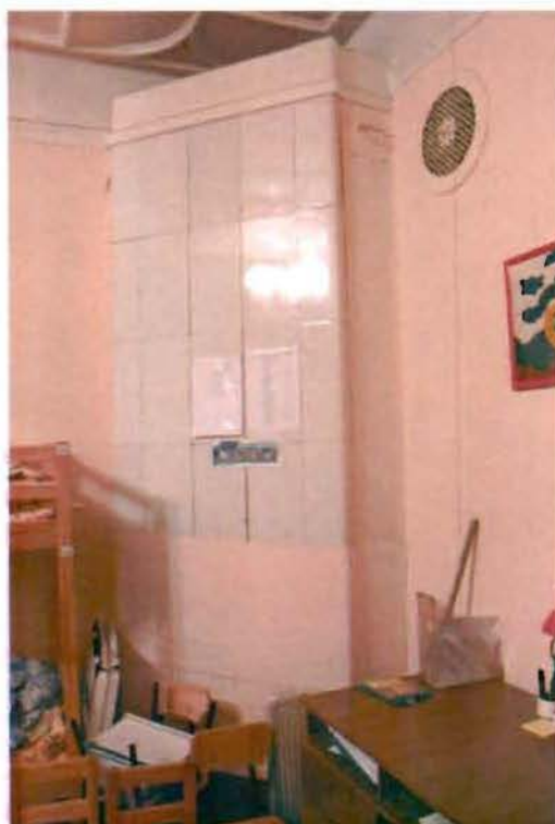
Фото № 16. Печь в пом. 2-Н (38).
