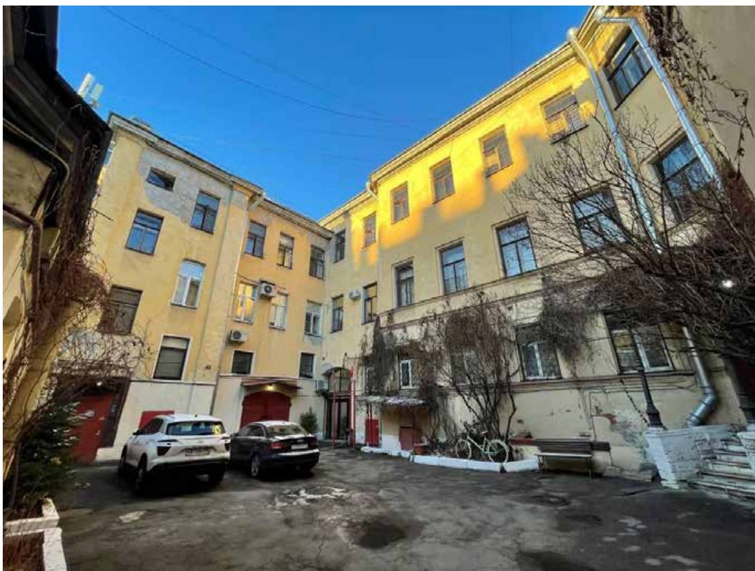
Фото 4. Фрагмент дворового фасада объекта культурного наследия регионального значения «Дворец вел. кн. Кирилла Владимировича»
