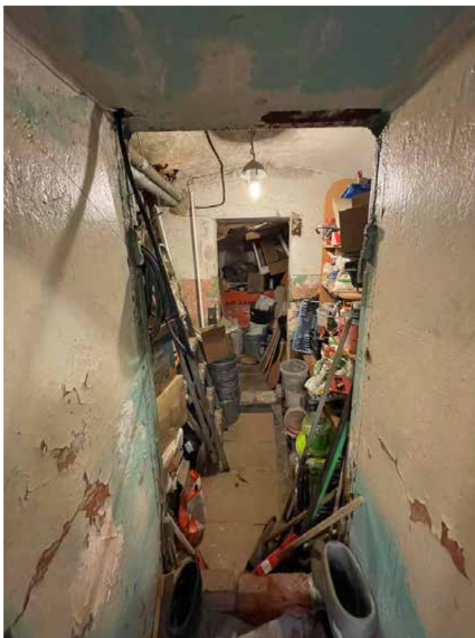
Фото 19. Интерьер пом. 2-Н объекта культурного наследия регионального значения «Дворец вел. кн. Кирилла Владимировича», подвальный этаж
