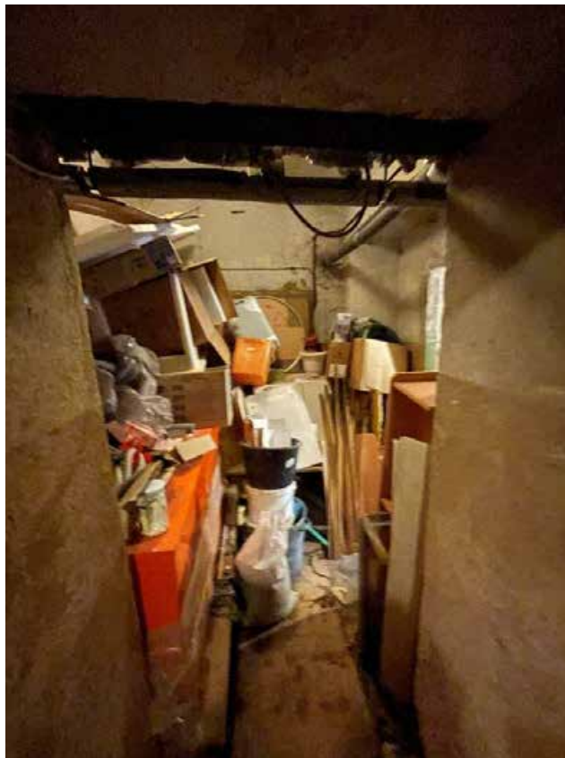
Фото 18. Интерьер пом. 2-Н объекта культурного наследия регионального значения «Дворец вел. кн. Кирилла Владимировича», подвальный этаж
