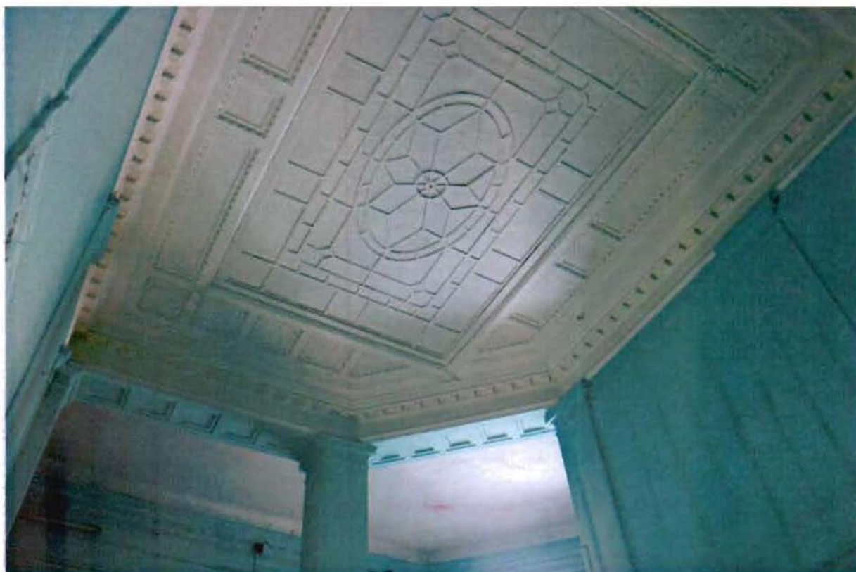
Фото № 22, 23, 24. Лестничная клетка Л-2 восточного корпуса.
