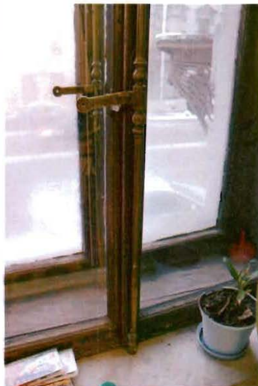
Фото № 19. Оконное заполнение с мраморным подоконником и латунными задвижками.
