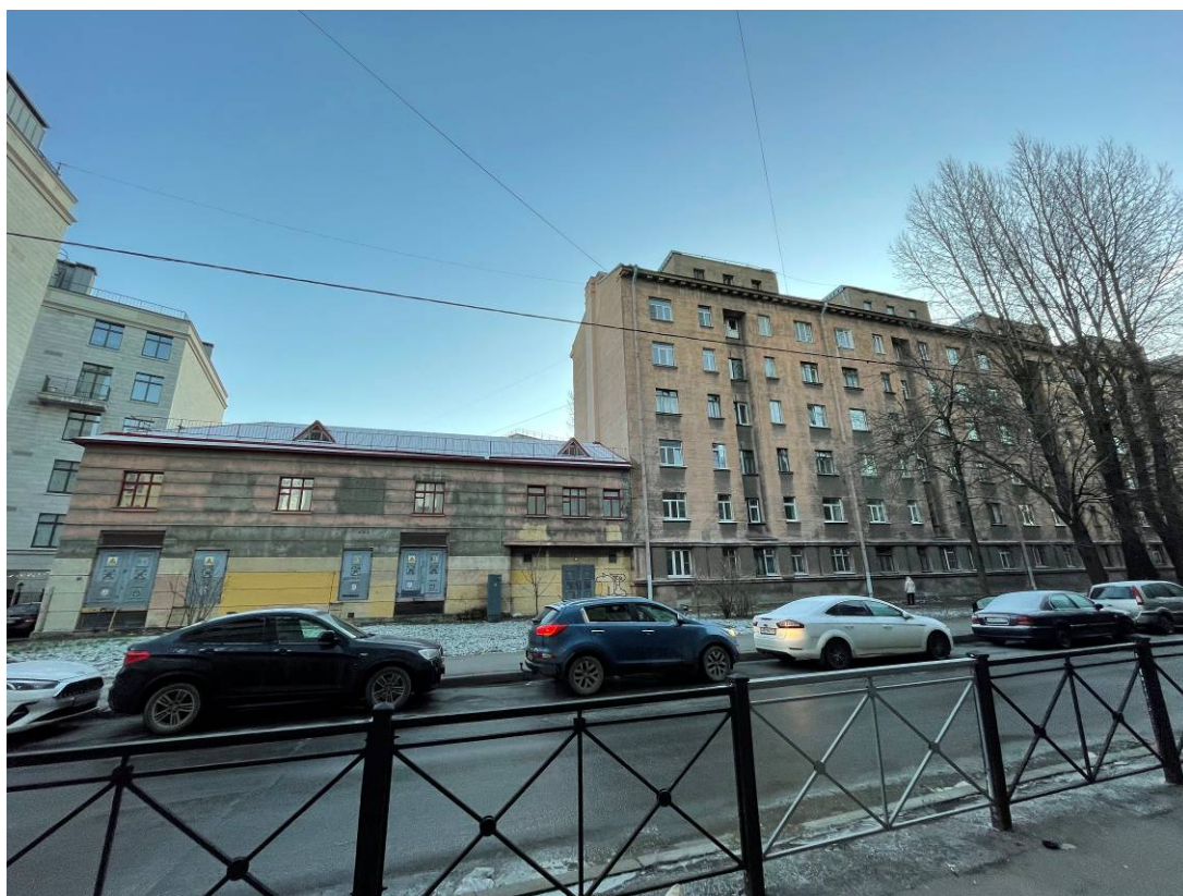
Фото 6. Фрагмент лицевого фасада выявленного объекта культурного наследия «Жилой дом работников Союзверфи» (по Матвеева пер.)
