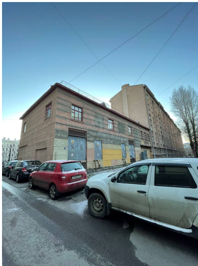
Фото 7. Фрагмент лицевого фасада выявленного объекта культурного наследия «Жилой дом работников Союзверфи» (по Матвеева пер.)
