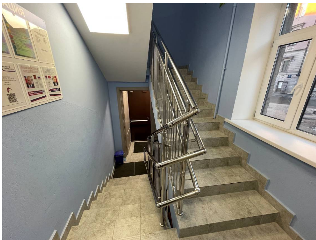
Фото 8. Интерьер первого этажа выявленного объекта культурного наследия «Жилой дом работников Союзверфи»
