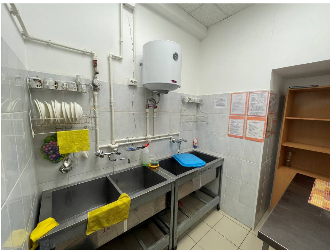
Фото 44. Интерьер второго этажа выявленного объекта культурного наследия «Жилой дом работников Союзверфи»
