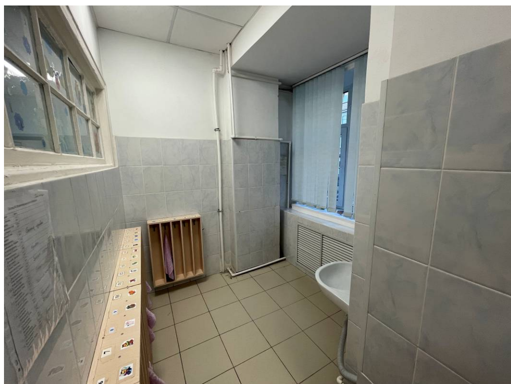
Фото 30. Интерьер первого этажа выявленного объекта культурного наследия «Жилой дом работников Союзверфи»
