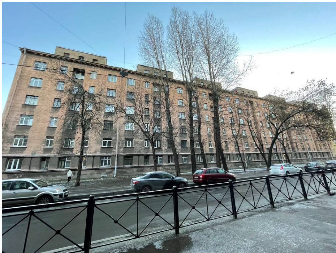
Фото 5. Фрагмент лицевого фасада выявленного объекта культурного наследия «Жилой дом работников Союзверфи» (по Матвеева пер.)
