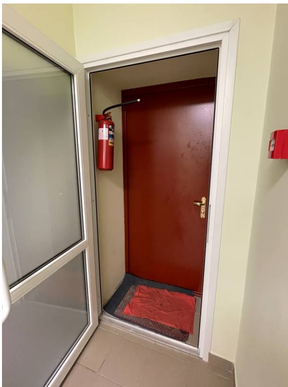
Фото 17 Интерьер первого этажа выявленного объекта культурного наследия «Жилой дом работников Союзверфи»
