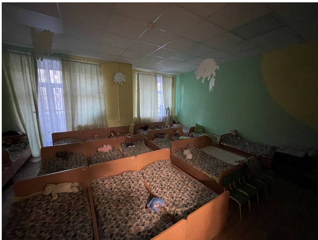
Фото 47. Интерьер второго этажа выявленного объекта культурного наследия «Жилой дом работников Союзверфи»
