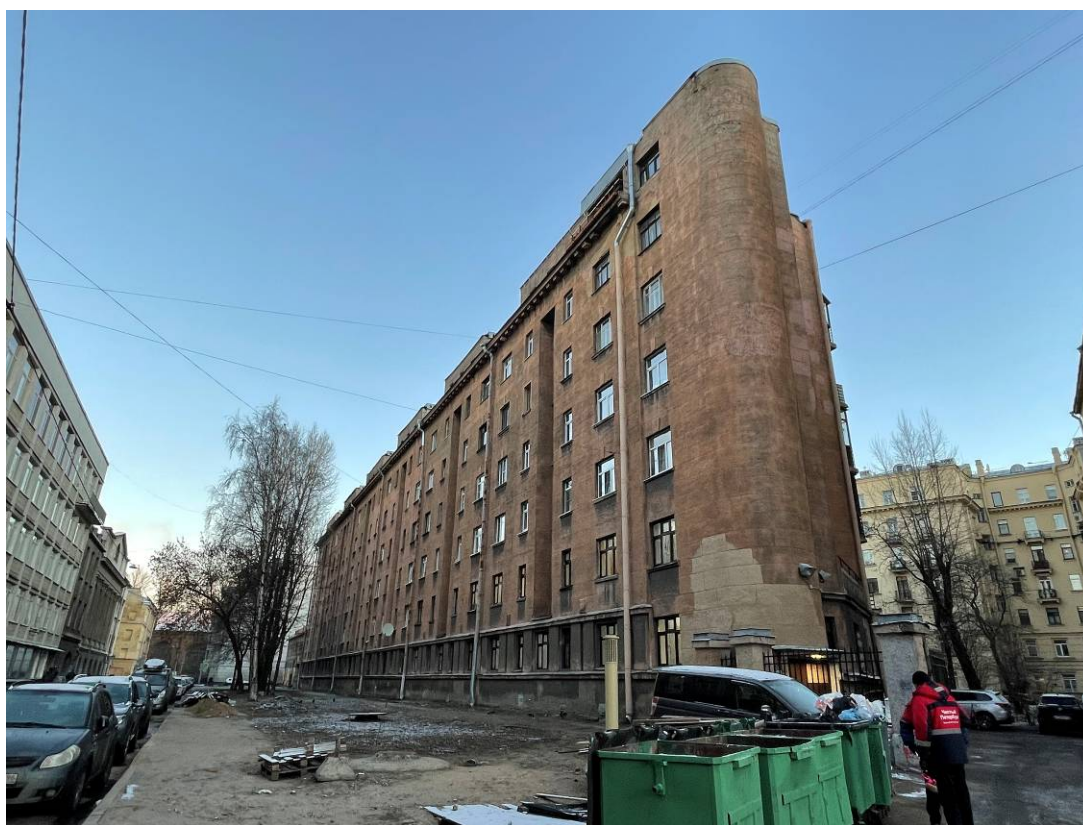
Фото 4. Фрагмент лицевого фасада выявленного объекта культурного наследия «Жилой дом работников Союзверфи» (по Матвеева пер.)
