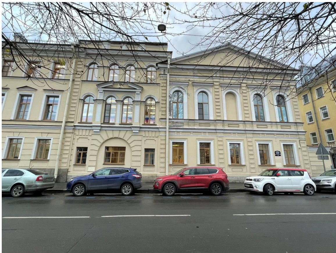
Фото 1. Фрагмент лицевого фасада выявленного объекта культурного наследия «Гимназия Императорского человеколюбивого общества»
