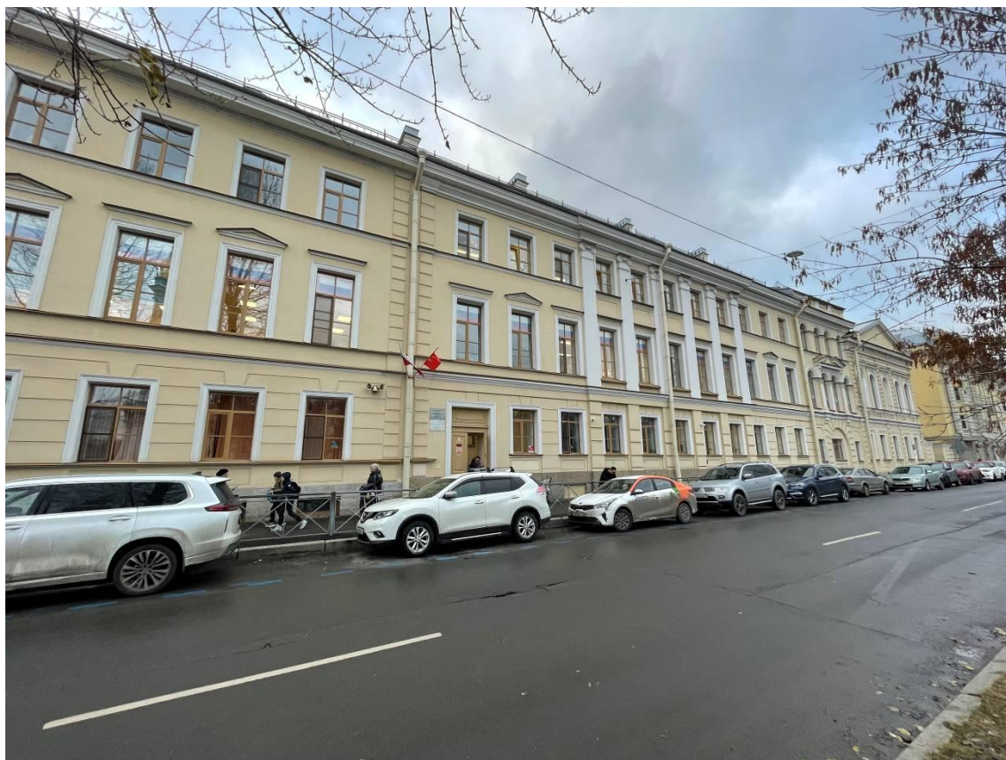
Фото 2. Фрагмент лицевого фасада выявленного объекта культурного наследия «Гимназия Императорского человеколюбивого общества»
