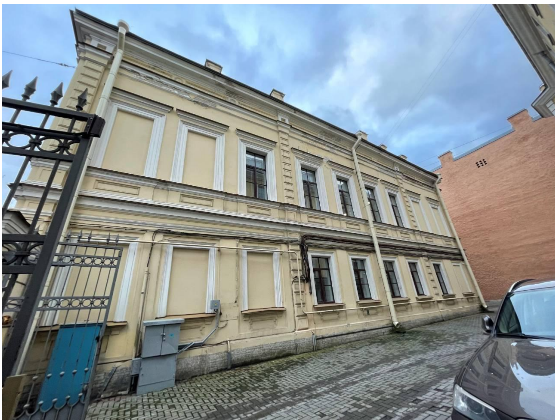
Фото 3. Фрагмент лицевого фасада выявленного объекта культурного наследия «Гимназия Императорского человеколюбивого общества»
