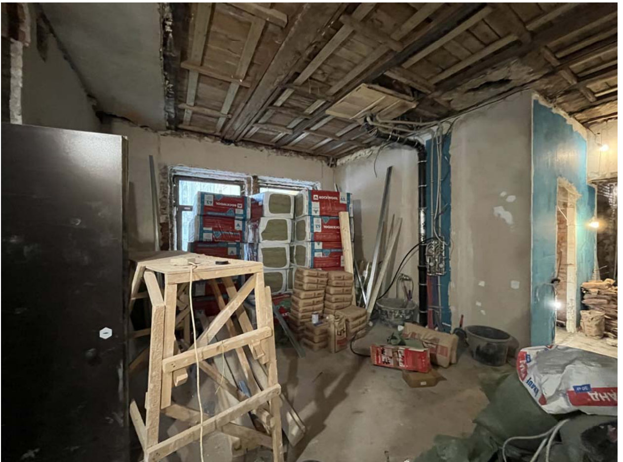
Фото №7. Помещения №№ 1, 2. Перегородка между помещениями демонтирована.
