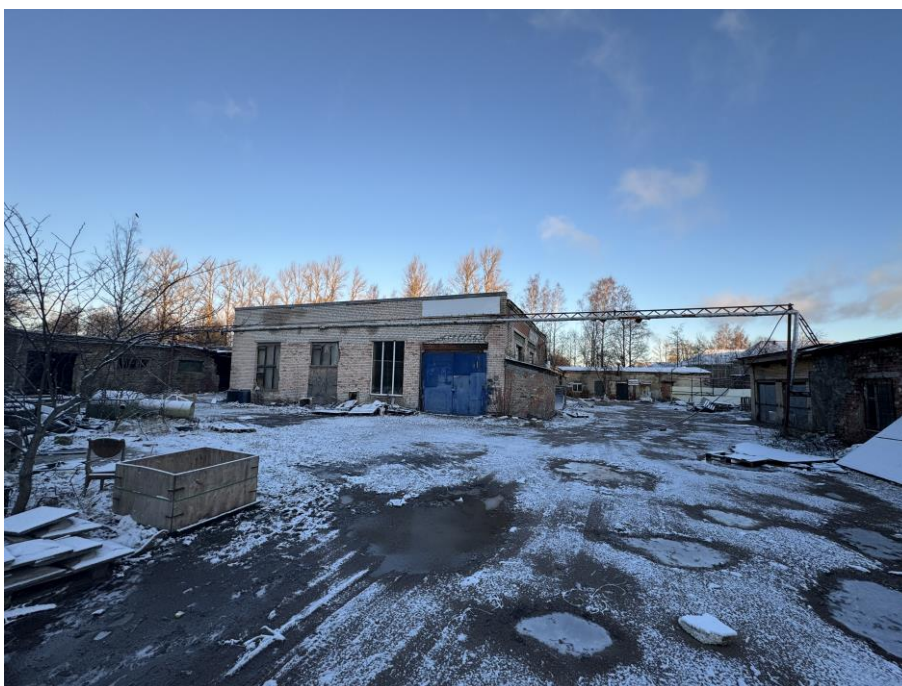
Фото №15. Производственное здание литера Ж на территории исследуемого земельного участка со стороны Дворцового проспекта
