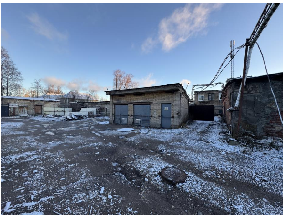
Фото №17. Трансформаторная подстанция, здание литеры Д на территории исследуемого земельного участка
