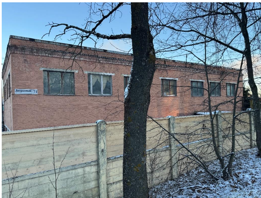
Фото №5. Торцы административного здания литеры А со стороны Дворцового проспекта
