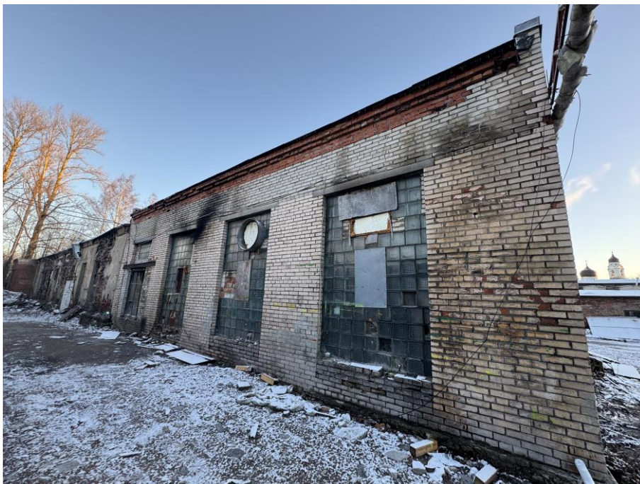
Фото №20. Угол производственного здания литеры Ж
