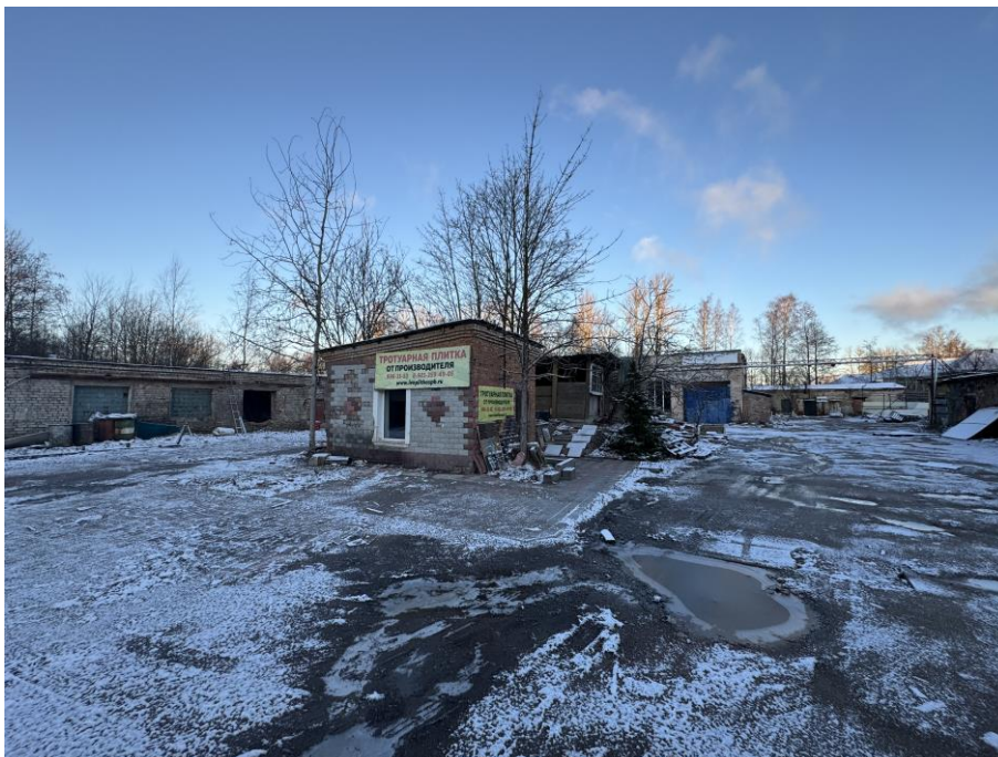
Фото №14.1. Здание насосной станции литера З на территории исследуемого земельного участка
