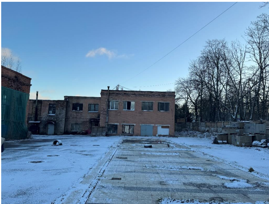
Фото №11. Дворовый фасад административного здания литеры А исследуемого земельного участка
