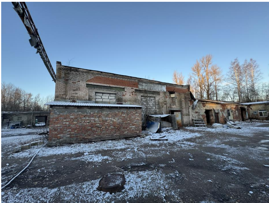
Фото №16. Производственное здание литеры Ж на территории исследуемого земельного участка со стороны улицы Первомайская
