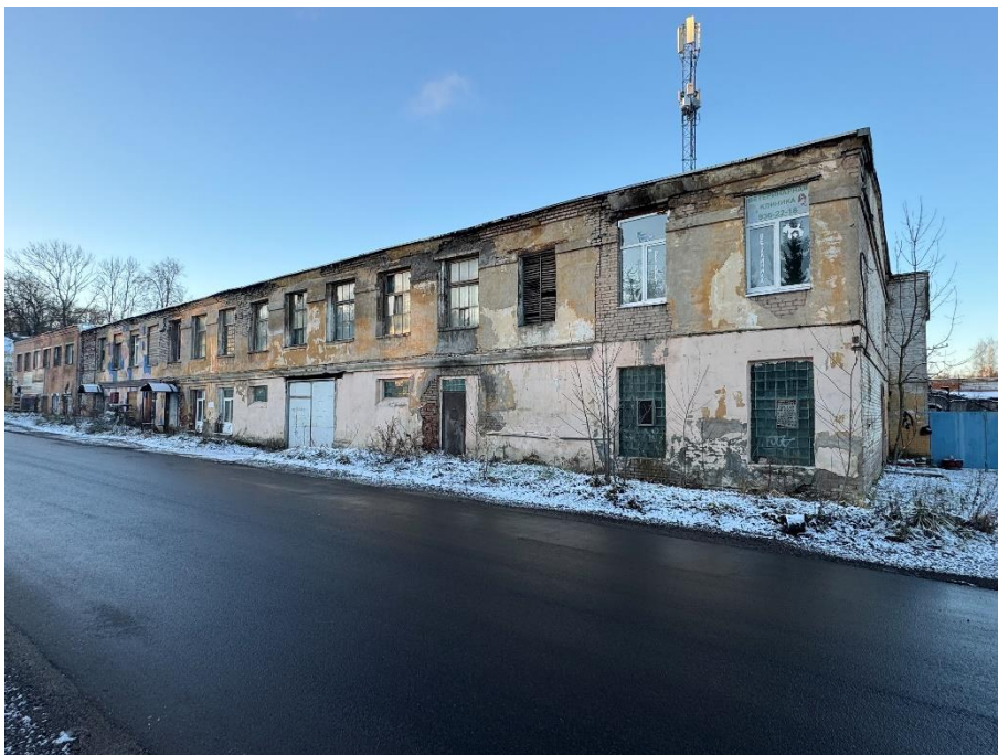
Фото №9. Производственное здание литера Б по улице Первомайская в месте технологического присоединения к магистральному газопроводу
