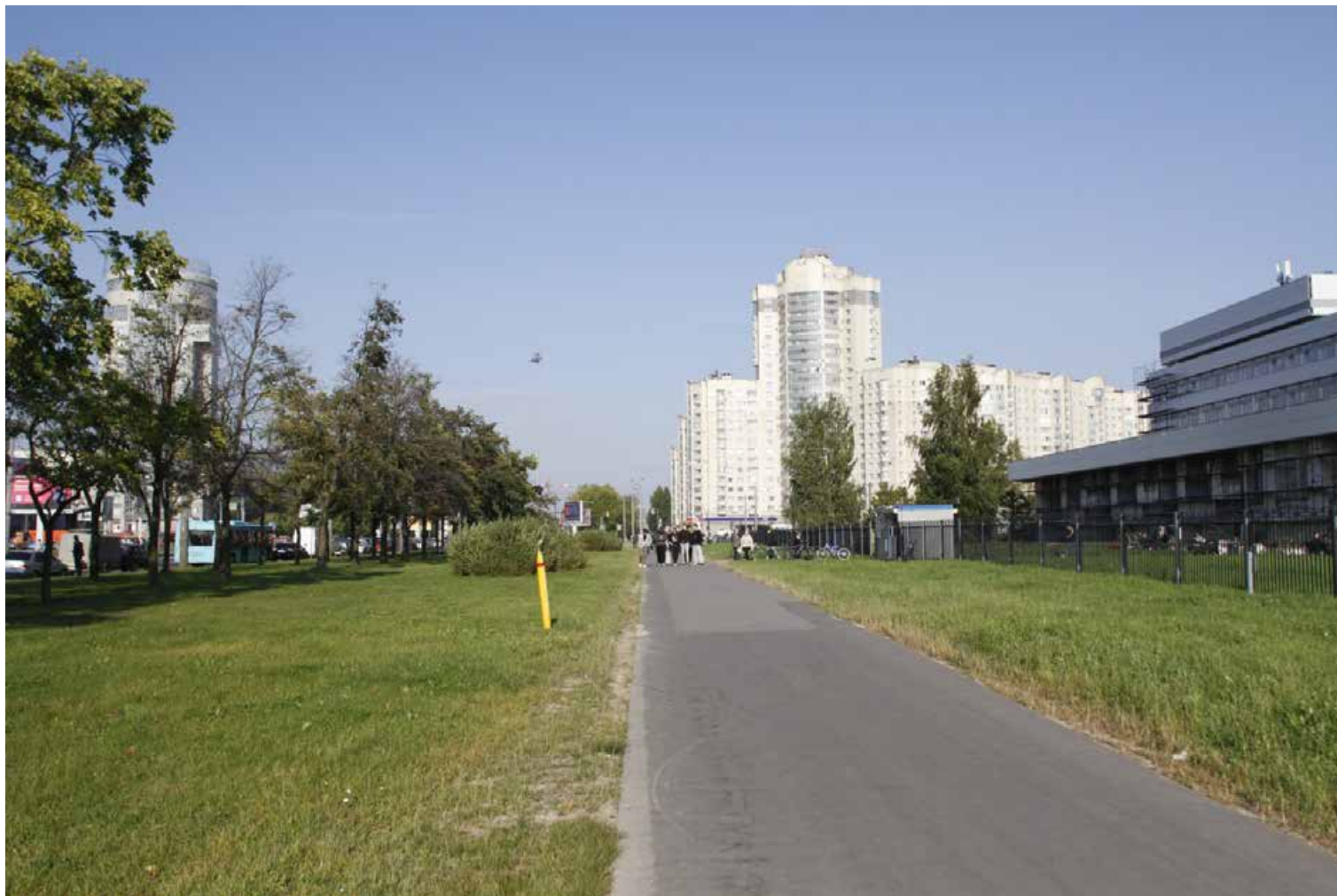
53. Вид вдоль трассы пр. Маршала Жукова. Фото:30.09.2024.
