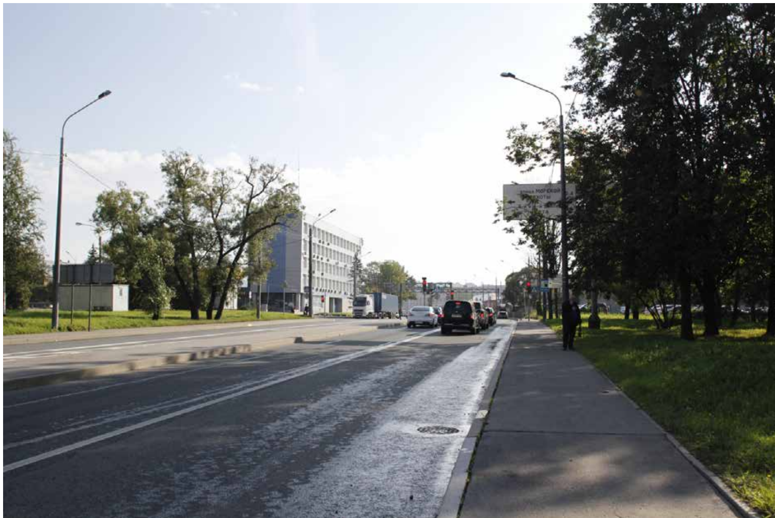
7. Вид вдоль трассы Автомобильной ул. Фото:30.09.2024.
