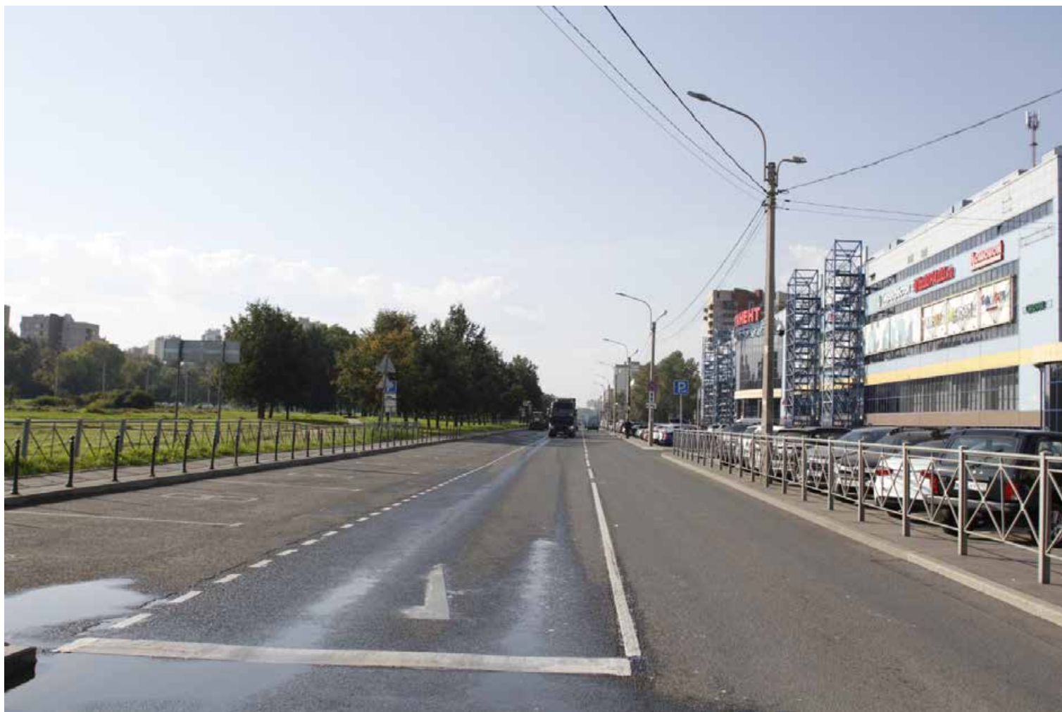
15. Вид вдоль трассы пр. Стачек. Фото:30.09.2024.
