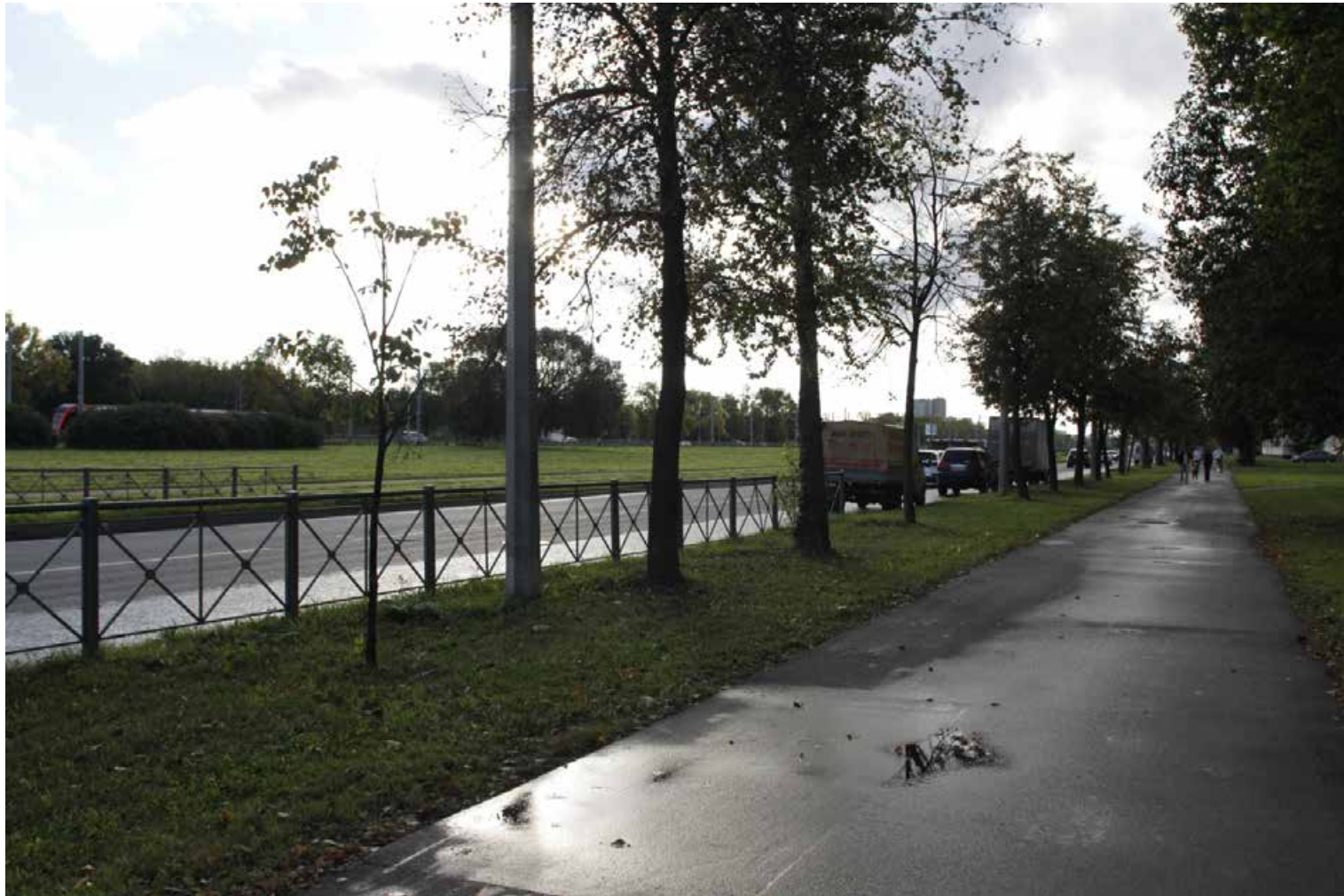
80. Вид вдоль трассы Петергофского шоссе и на объект культурного наследия регионального значения «Исторические трассы Петергофской и Нарвской дорог». Фото:30.09.2024.
