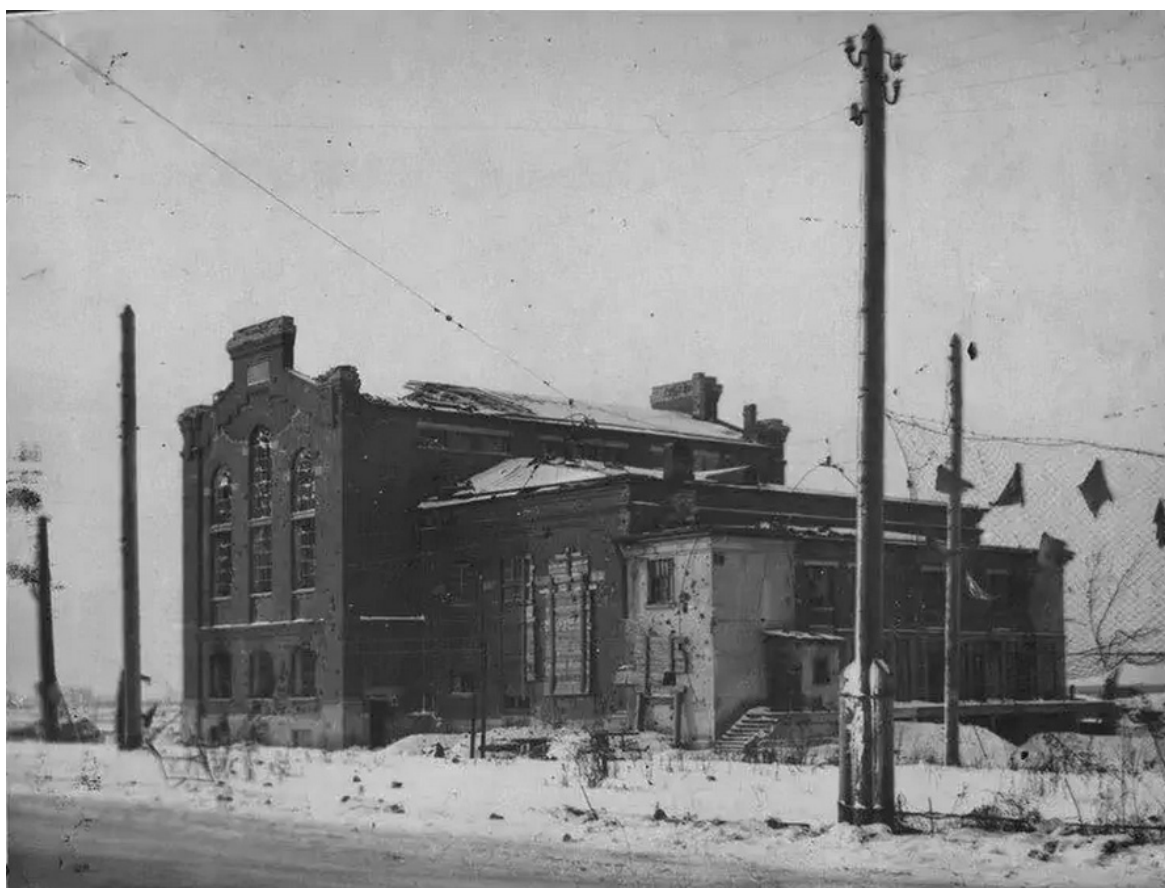
Ил. 5 Фото здания трансформаторной подстанции электрифицированной дороги ОранЭЛ времен ВОВ. Электронный ресурс: https://oranela.ru
