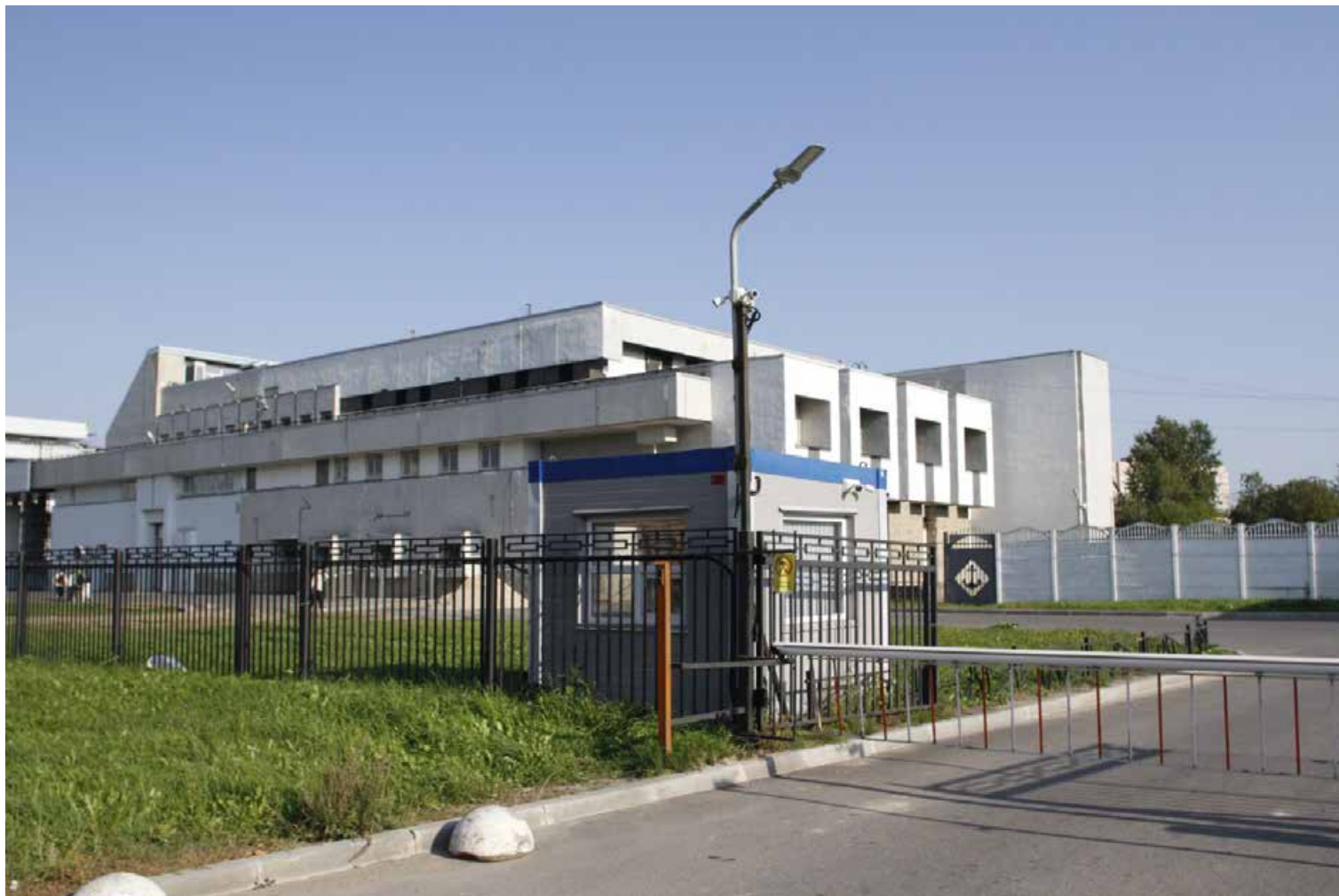
54. Вид вдоль трассы пр. Маршала Жукова. ПС 369. Фото:30.09.2024.
