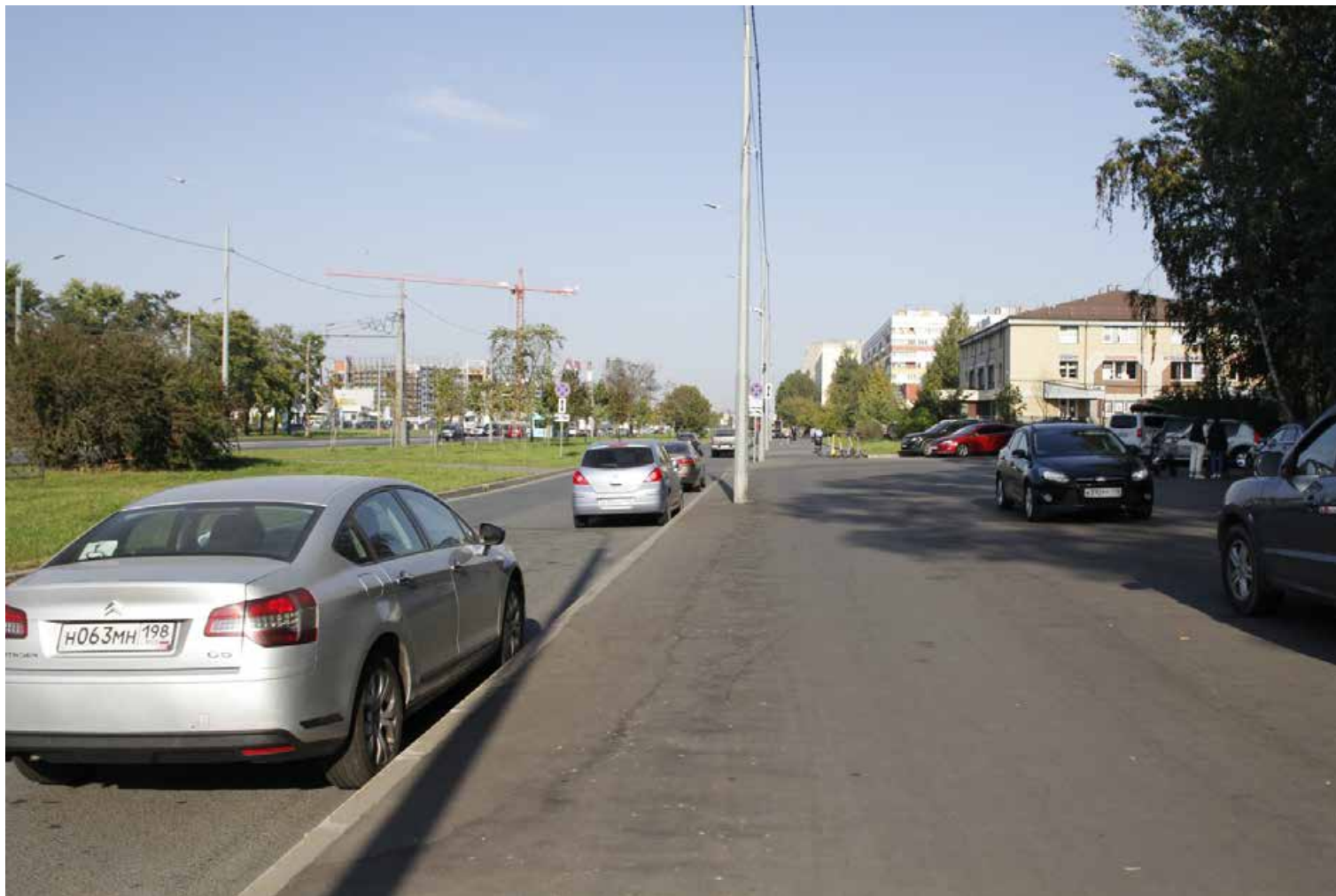
69. Вид вдоль трассы пр. Маршала Жукова. Фото:30.09.2024.
