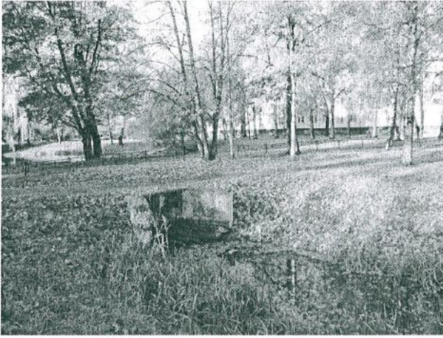
9. Оголовок водовыпуска под пешеходной дорожкой в западной части круглого пруда
