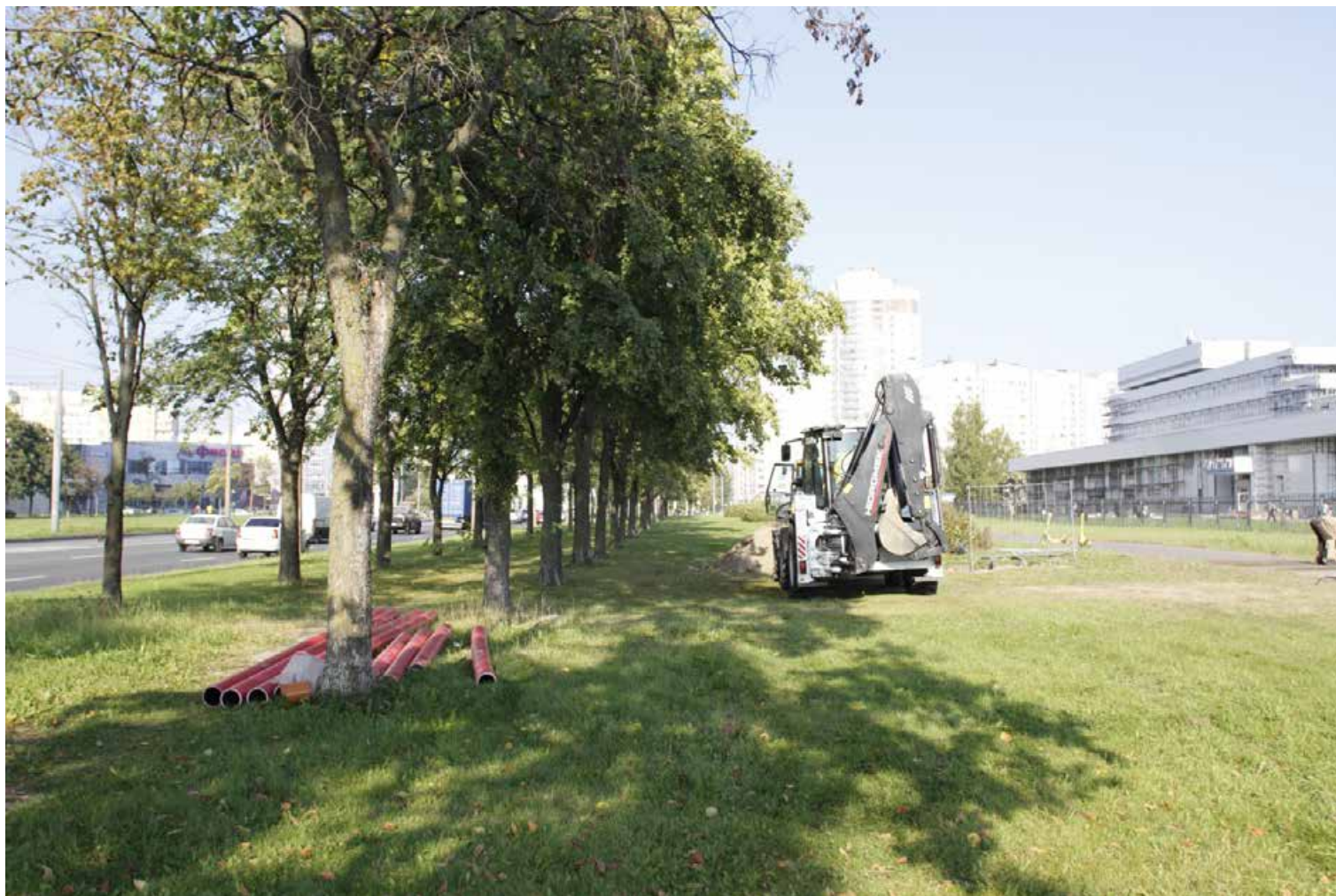
55. Вид вдоль трассы пр. Маршала Жукова. Фото:30.09.2024.
