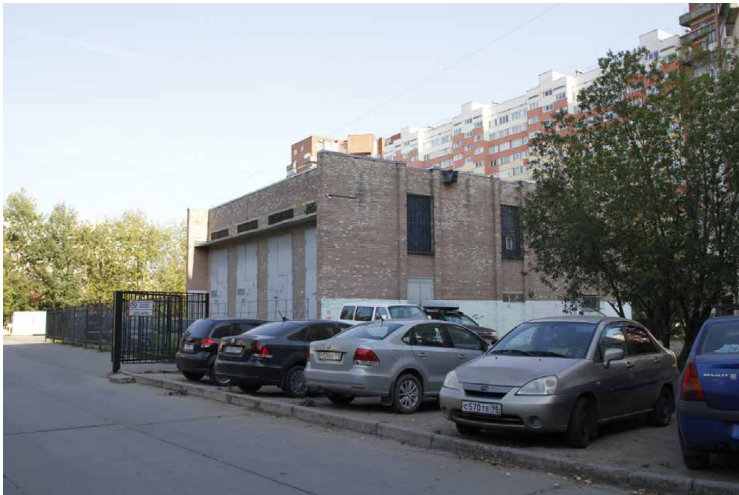
71. Внутривдворовая территория. РП 36490 (п/ст №77). Фото:30.09.2024.
