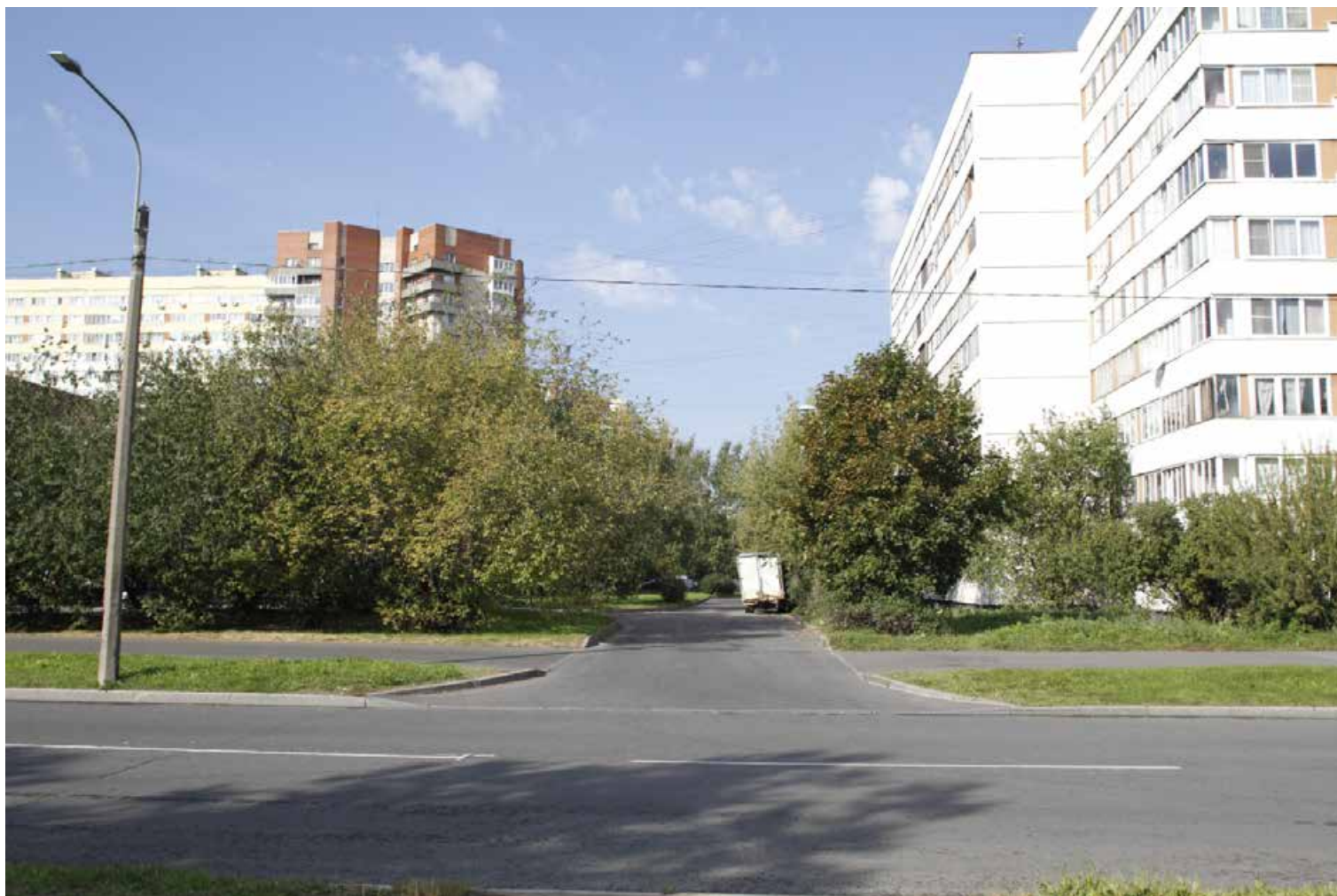
22. Вид вдоль трассы пр. Стачек. Фото:30.09.2024.
