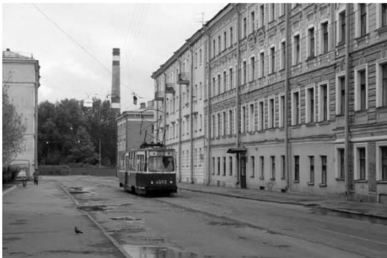
Илл. 74. Вид на сад и забор Больницы им. Свердлова со стороны Перекупного пер. 1987 г. https://pastvu.com/p/610549
