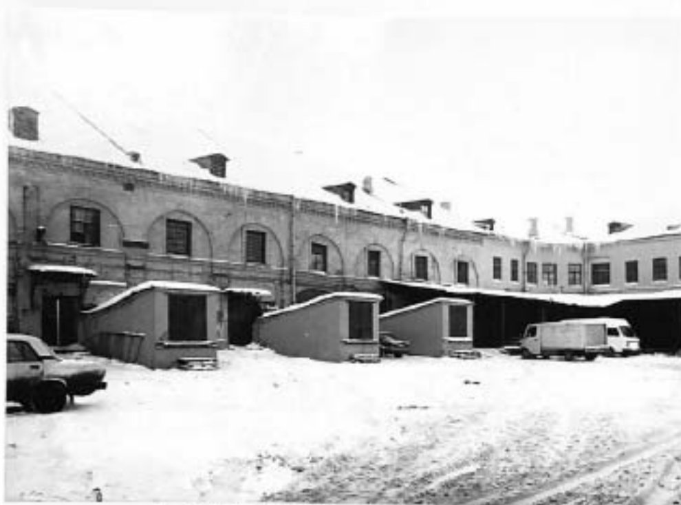
6. Б. Мыльный двор. Главный корпус. Вид со двора. Февраль 1996 г. Фотограф Гринев И.Е.
