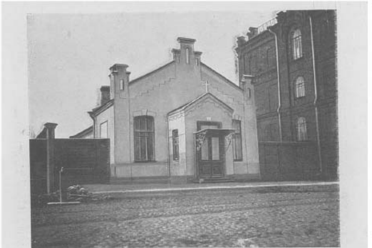
Часовня и покойницкая при больницѣ Общины Св. Евгениі, построенная фирмою въ 1912 г. изъ 16'' бетонныхъ пустотѣлыхъ камней.
