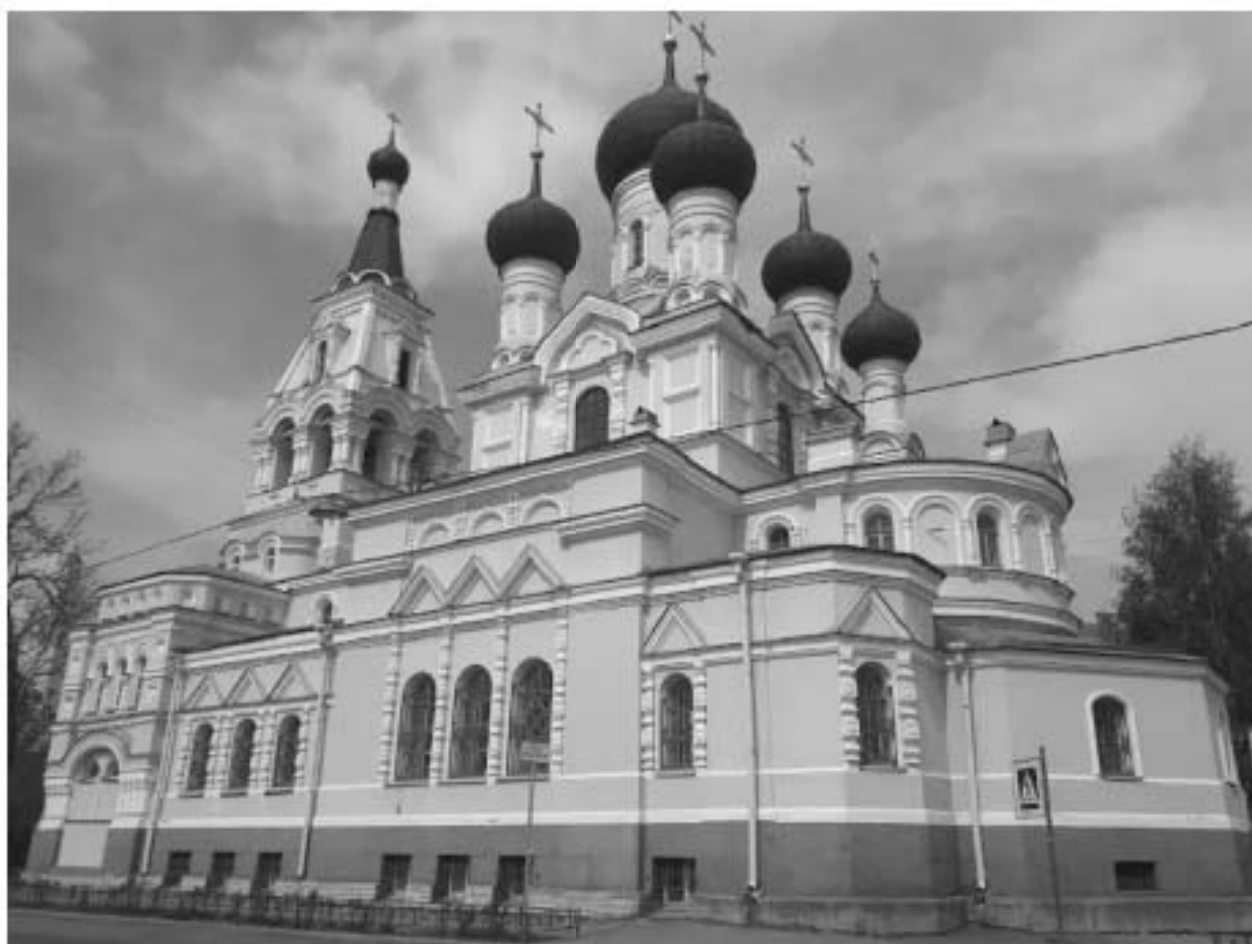
Фото 9. Вид на объект культурного наследия «Церковь Шестаковской иконы Божией Матери подворья Шестаковского Вознесенского монастыря» - Старорусская ул., 8; Кирилловская ул., 2
