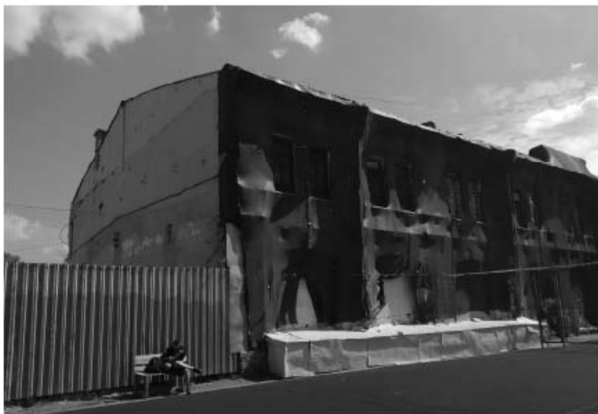
Фото 4. Фрагмент лицевого фасада западного корпуса со стороны Овсянниковского сквера ноябрь 2024
