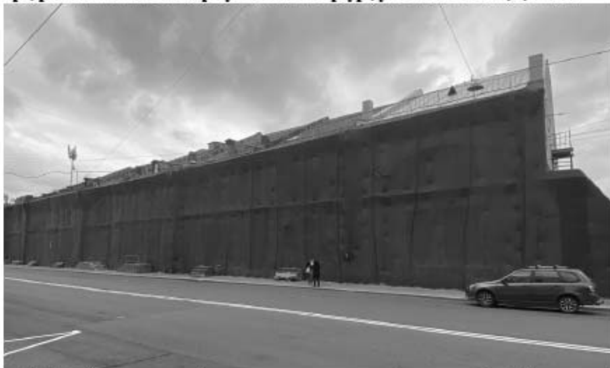
Фото 1. Общий вид восточного фасада здания со стороны пр. Бакунина ноябрь 2024.
