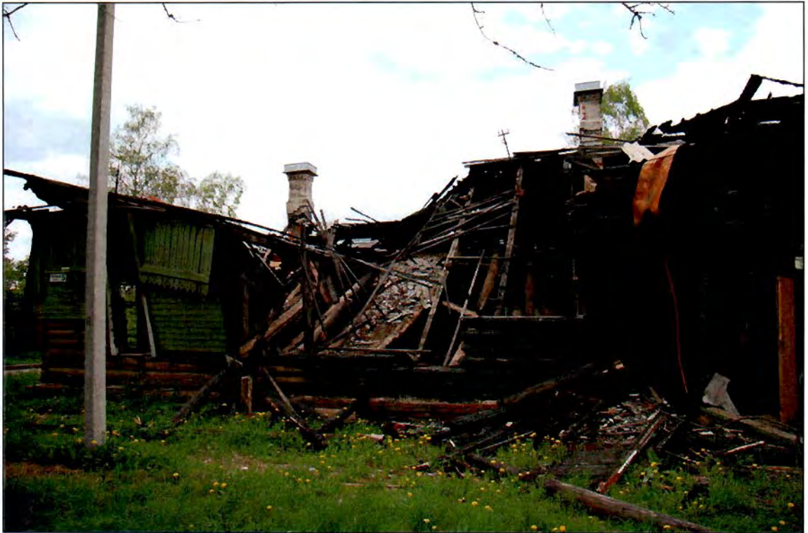
19. Фрагмент. Северо-восточный фасад.
