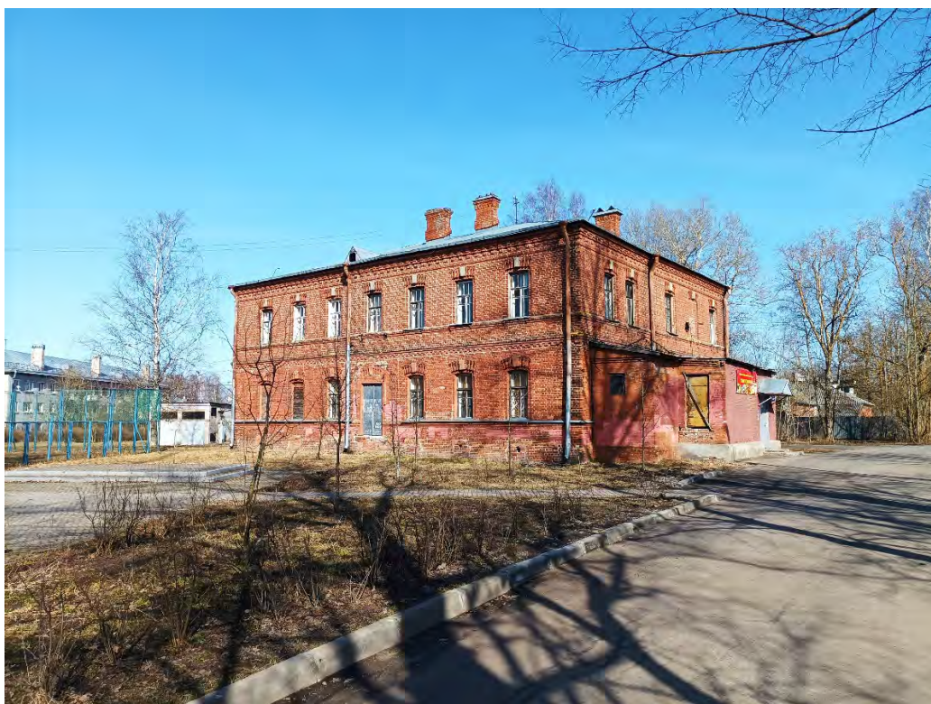
1. «Мастерские», по адресу: Санкт-Петербург, г. Павловск, Динамо, Клубная пл., д. 1, лит. А. Общий вид. Дата съемки: 25.03.2024 г.
