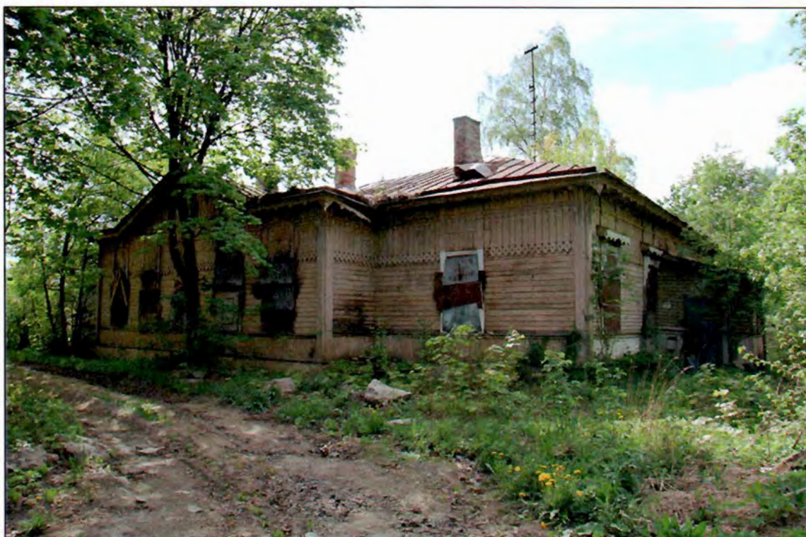
22. Общий вид. Юго-восточный фасад.
