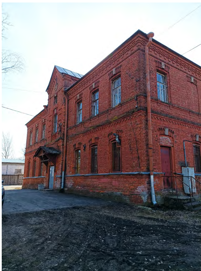
6. «Мастерские», по адресу: Санкт-Петербург, г. Павловск, Динамо, Клубная пл., д. 1, лит. А. Фасад восточный. Дата съемки: 25.03.2024 г.
