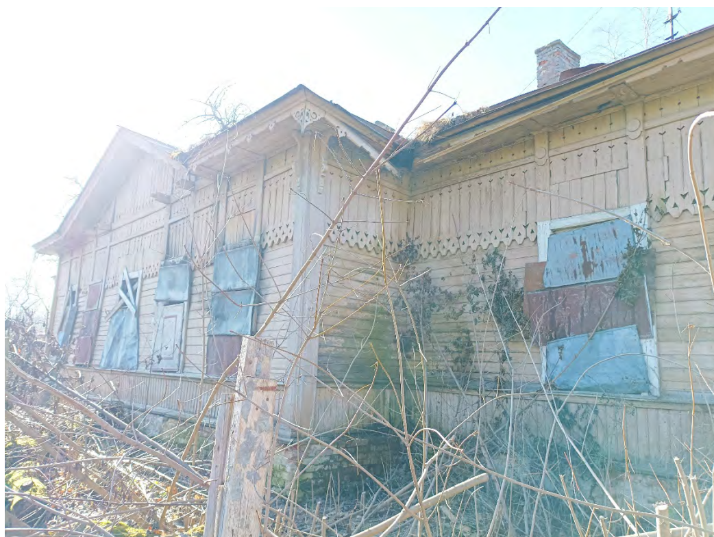
18. «Жилой дом для мальчиков с холостым надзирателем», по адресу: Санкт-Петербург, г. Павловск, Павловское шоссе, д. 9, лит. А. Фасад восточный. Дата съемки: 25.03.2024 г.
