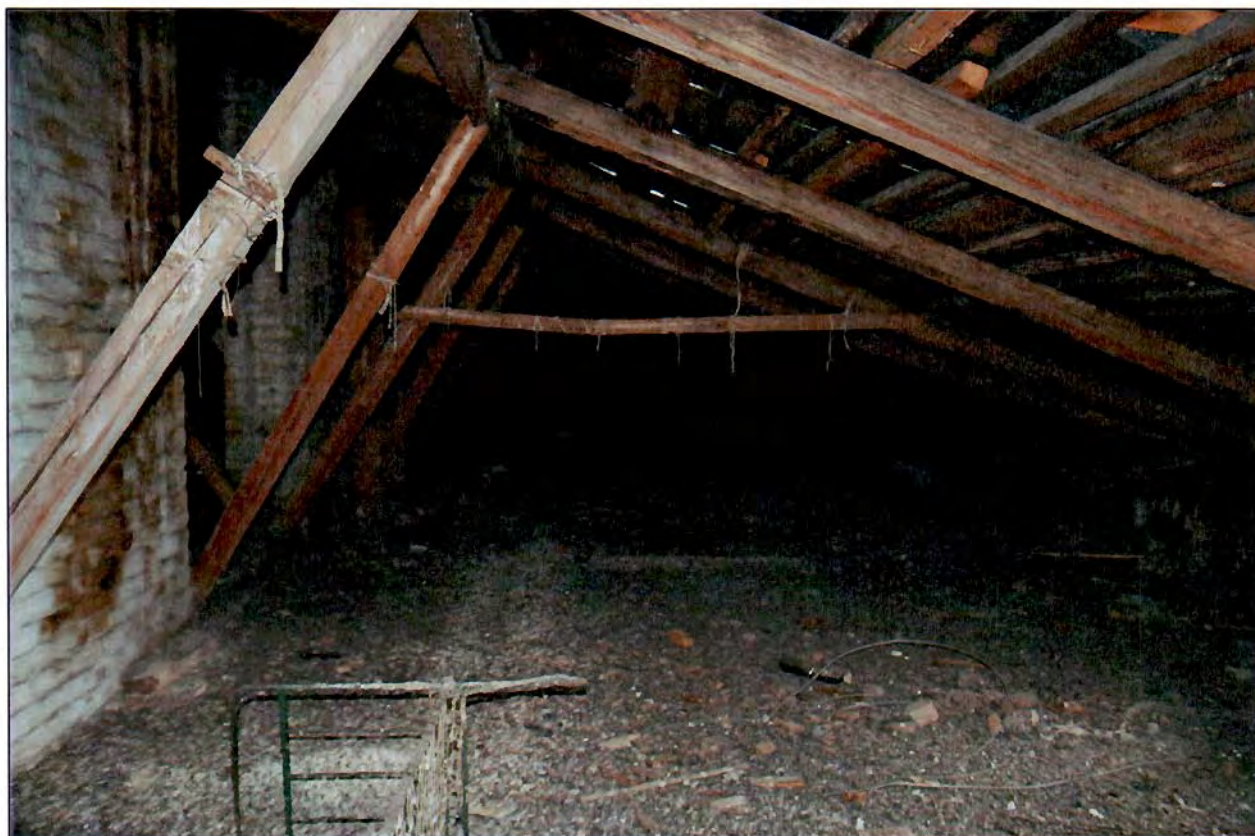
14. Интерьер. Чердак. Стропильная система.
