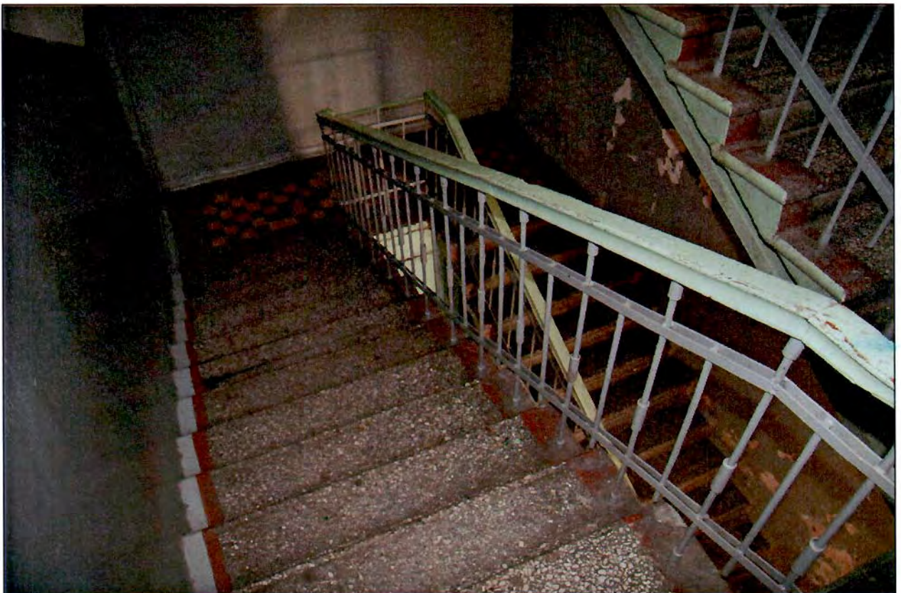
10. Интерьер. Главная лестница.
