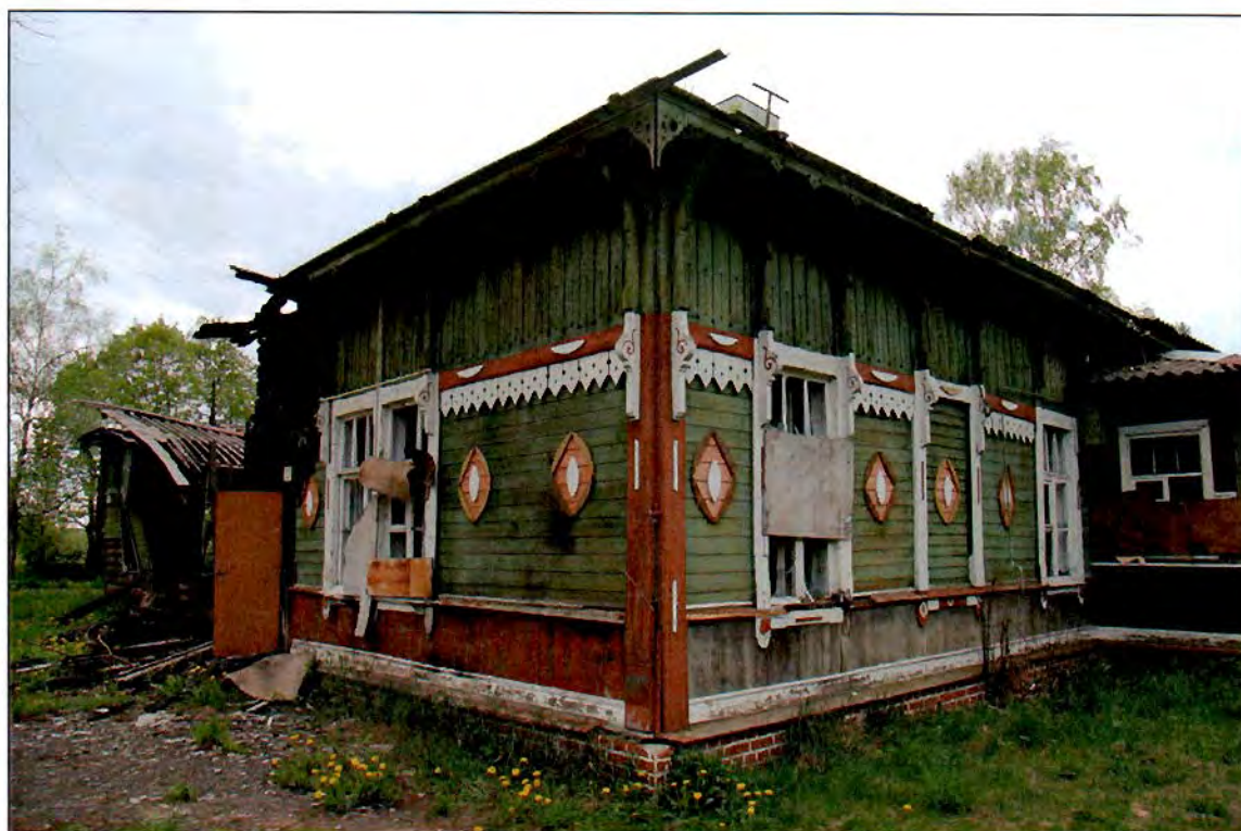
17. Общий вид. Северо-восточный фасад.
