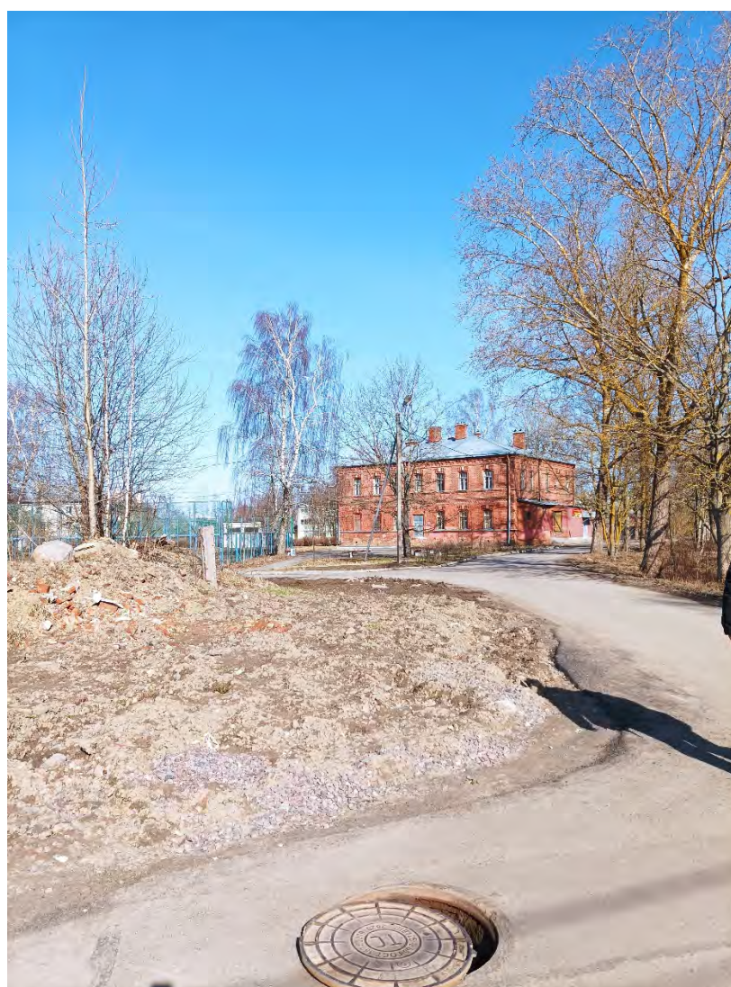
8. Земельный участок проектирования реконструкции тепловых сетей. Дата съемки: 25.03.2024 г.
