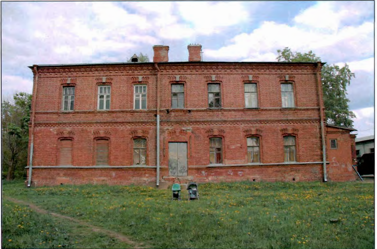
3. Общий вид. Западный фасад
