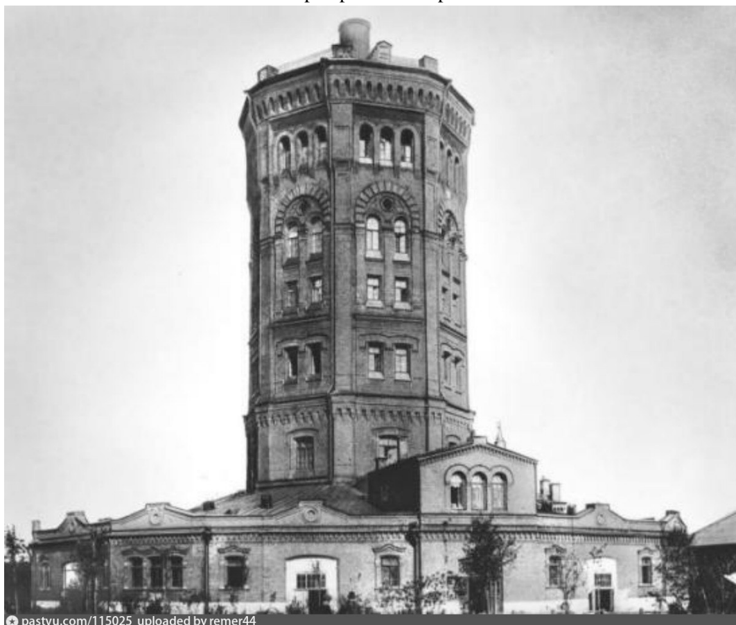
12. Водонапорная башня главной станции петербургских водопроводов. 1900 - 1917 г. г. — «PastVu» – ретро-фотографии стран и городов [Электронный ресурс]. URL: https://pastvu.com/p/115025 .
