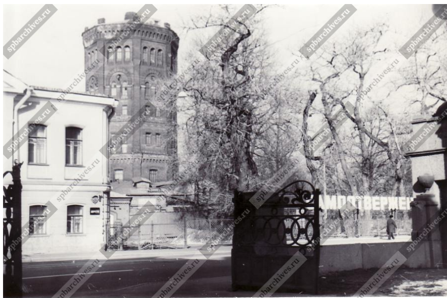
15. Вид от Таврического дворца на водопроводную башню Главной водопроводной станции города Ленинграда по улице Воинова., 56 (гражданские инженеры И.А.Мерц, Э.Г.Шуберский, 1859 -1863 гг.). 21 марта 1979 г. // ЦГАКФФД СПб Ар 214918.
