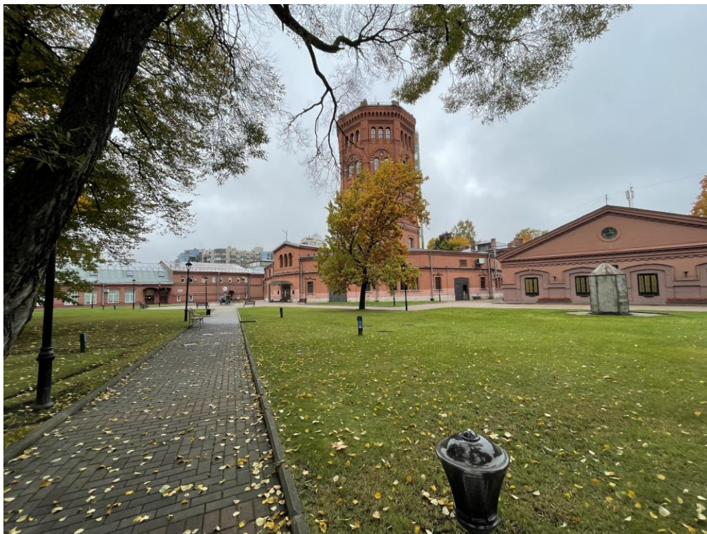
Фото 5. Вид на объект культурного наследия регионального значения «Водонапорная башня с машинным отделением и котельной», входящий в состав объекта культурного наследия регионального значения «Комплекс главной станции Санкт-Петербургских городских водопроводов»
