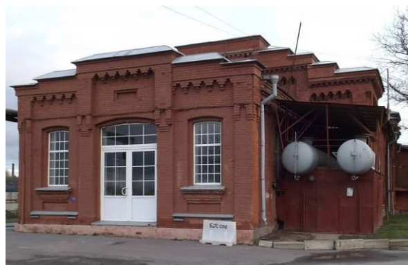
Ризалит западного фасада юго-западного корпуса
