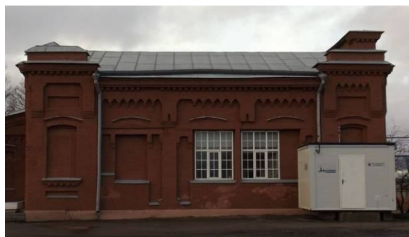
Восточный фасад северо-восточного корпуса
