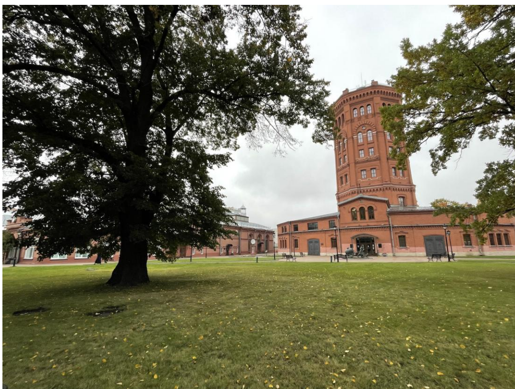
Фото 2. Вид на объект культурного наследия регионального значения «Водонапорная башня с машинным отделением и котельной», входящий в состав объекта культурного наследия регионального значения «Комплекс главной станции Санкт-Петербургских городских водопроводов»
