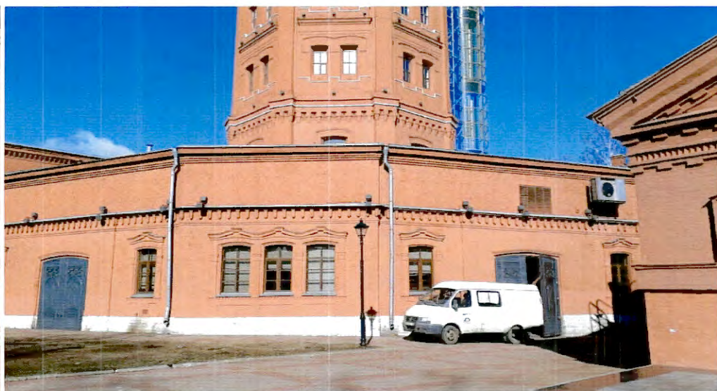
7. Вид на нижний ярус башни с восточной стороны
