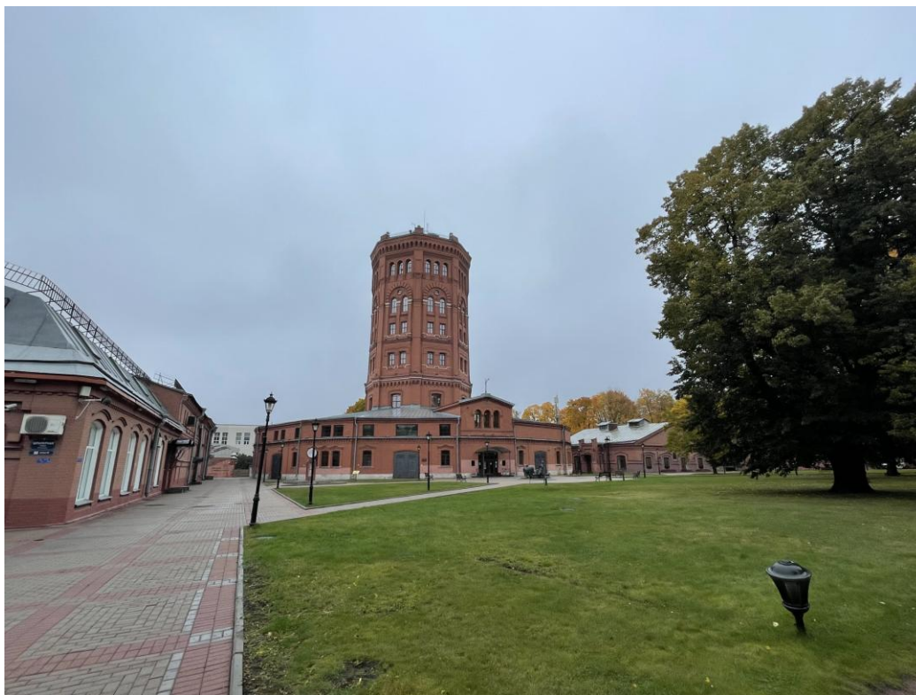
Фото 1. Вид на объект культурного наследия регионального значения «Водонапорная башня с машинным отделением и котельной», входящий в состав объекта культурного наследия регионального значения «Комплекс главной станции Санкт-Петербургских городских водопроводов»
