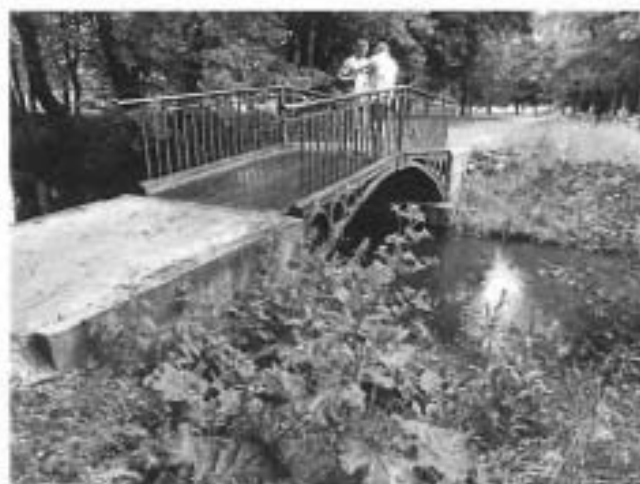
Фото 4. Металлический мост на бетонных устоях.
