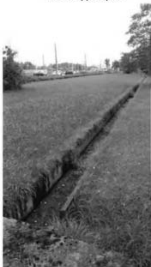
27. Водосбросный лоток в северной части территории
