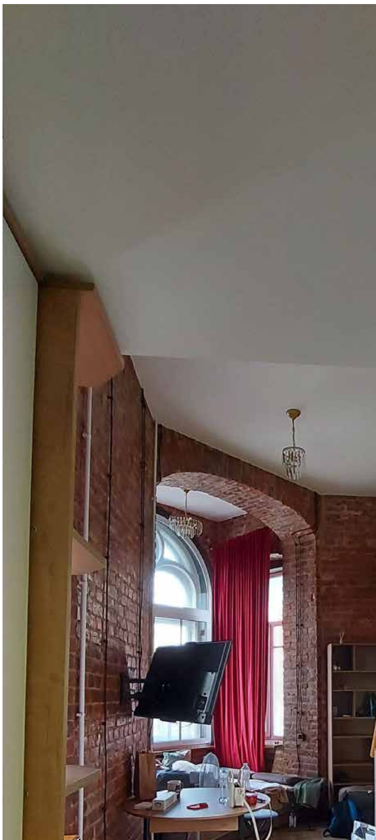
Фото 14. Выявленный объект культурного наследия «Дом М.А.Панова», Санкт-Петербург, Суворовский пр., 1/8, лит.А., квартира 3. Часть помещения 11 (по плану ПИБ).
