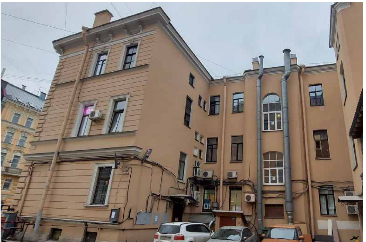
Фото.2 Выявленный объект культурного наследия «Дом М.А.Панова», Санкт-Петербург, Суворовский пр., 1/8, лит.А. Дворовые фасады, общий вид.
