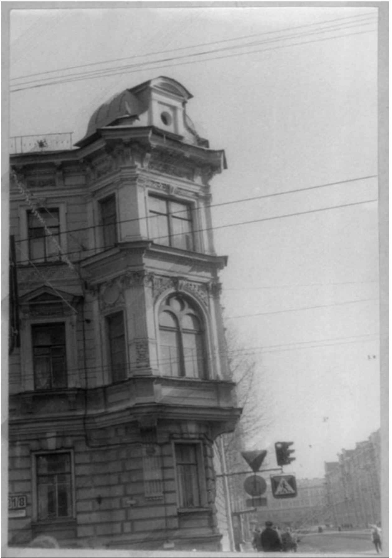
Илл.18. Фрагмент углового фасада бывшего доходного дома М. А. Панова на пересечении 2-й Советской улицы и Суворовского проспекта.. Дата:1983г. Автор:Громов С.Р. Источник:ЦГАКФФД СПб Ар 120960
