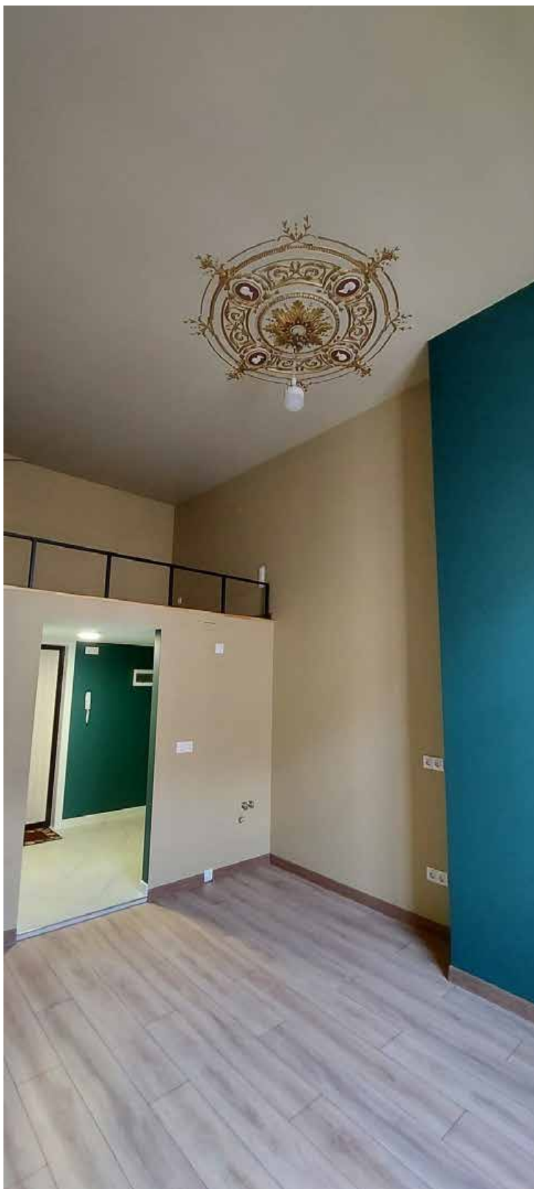
Фото 11. Выявленный объект культурного наследия «Дом М.А.Панова», Санкт-Петербург, Суворовский пр., 1/8, лит.А., квартира 3. Часть помещения 9 (по плану ПИБ), антресоль.
