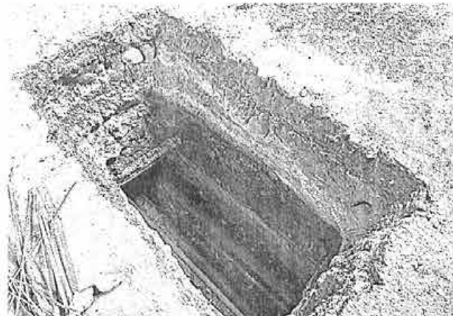
9. Асфальтовое покрытие северного проезда (между трехэтажным и двухэтажным корпусом)
