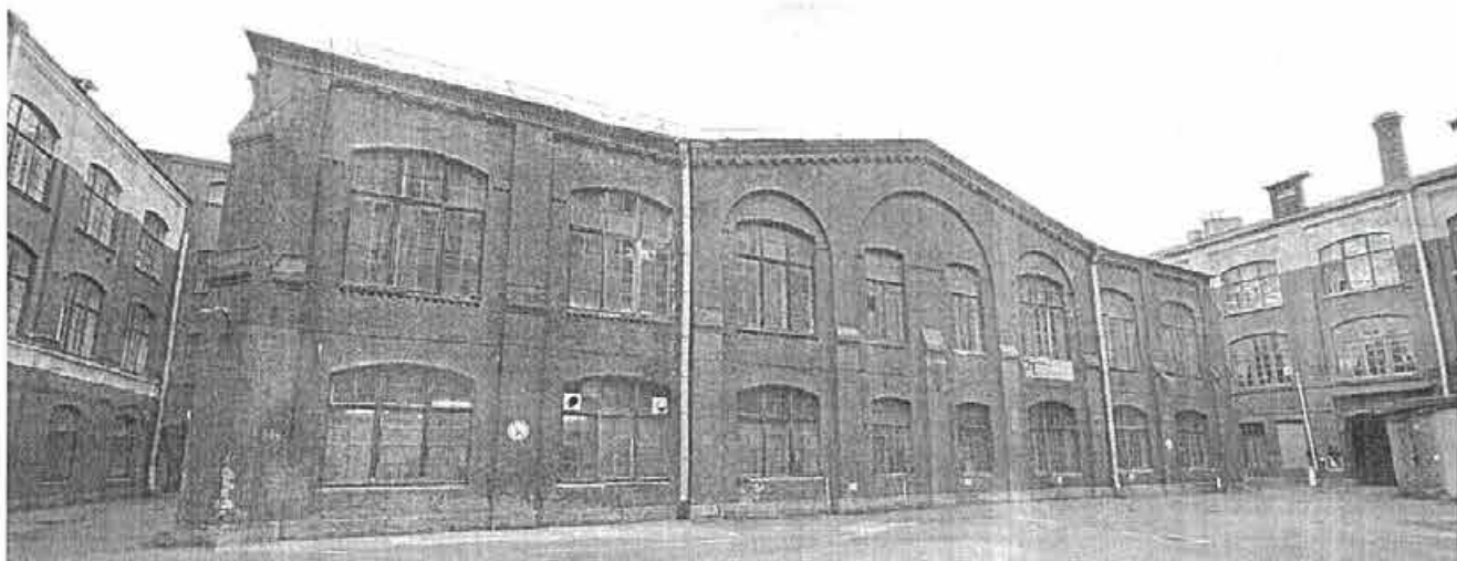
3. Вид на южный фасад объекта культурного наследия (двухэтажный дворовой корпус)
