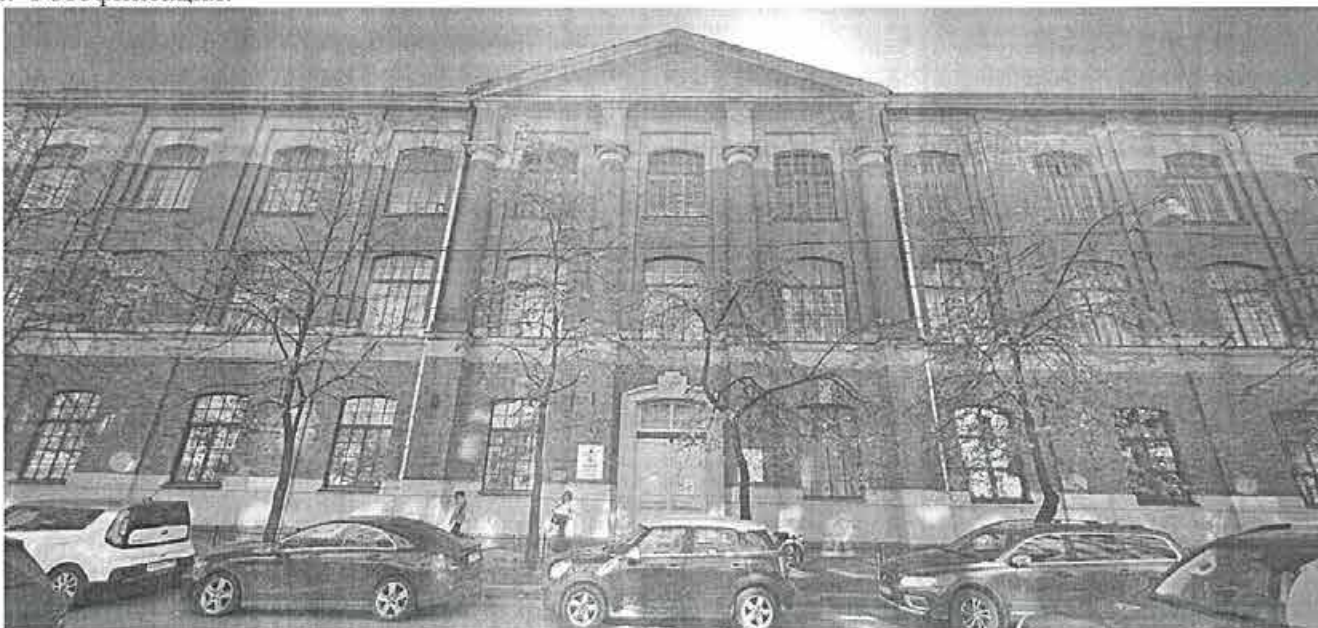
1. Вид на северный фасад объекта культурного наследия (выходящий на Гатчинскую ул.)
