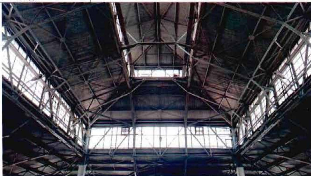
7. Металлоконструкции светового фонаря
