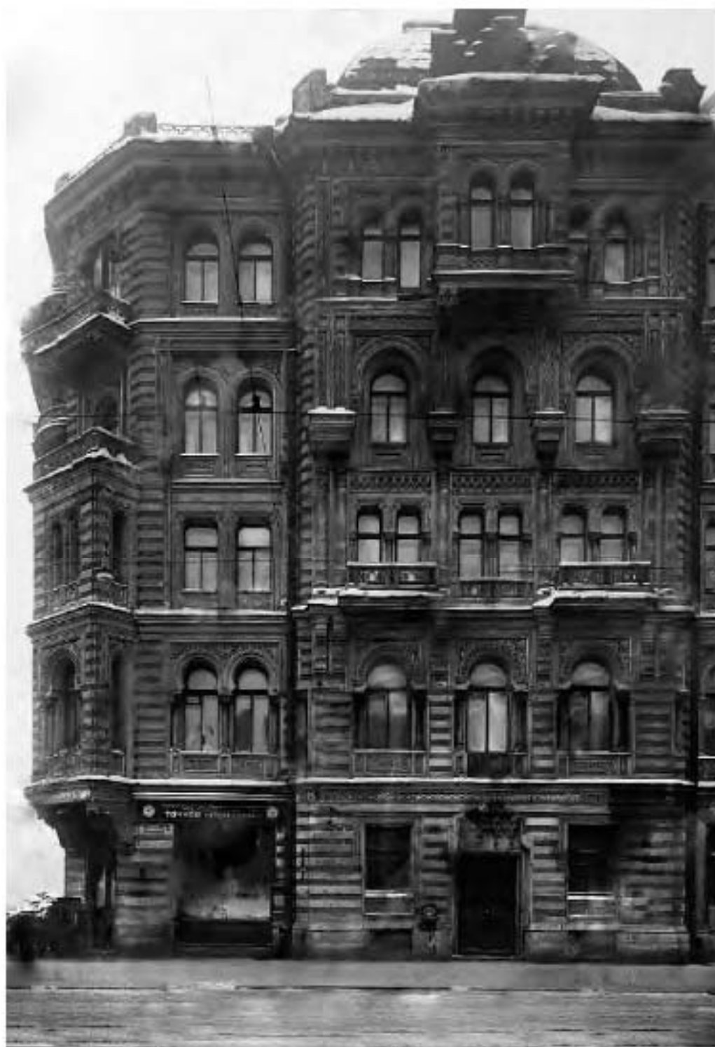
Илл. 25. Часть фасада дома №27 по проспекту Володарского (Литейному). 1938 г. Автор съемки неизвестен //ЦГА КФФД. Гр 69244//
