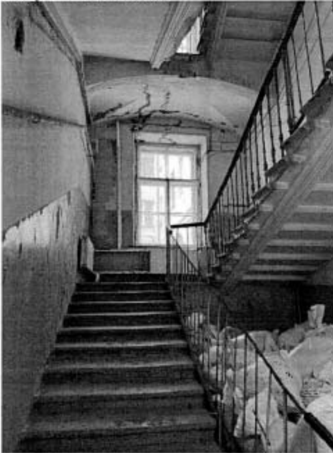
19. Фрагмент двухмаршевой лестницы 1ЛК между 1-м и 2-м этажами.
