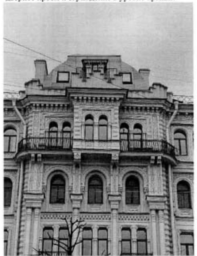
6. Лицевой фасад по ул. Короленко. Окна-ветух, дверное проем и ограждение в уровне крыши.
