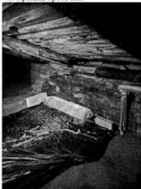
41. Крыша, протечки.
