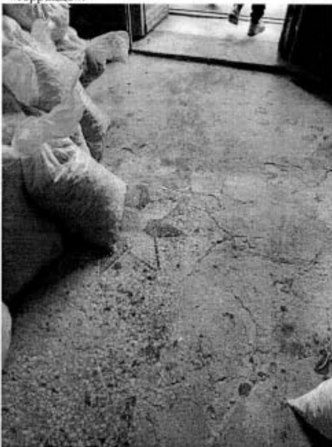
18. Покры́тие пола 1ЛК – мозаика в технике «терраццо».
