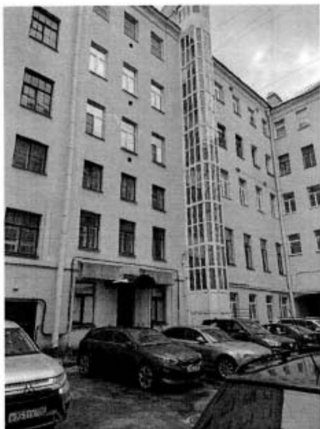
13. Фрагмент северного фасада. Металлопластиковая конструкция над приемком.
