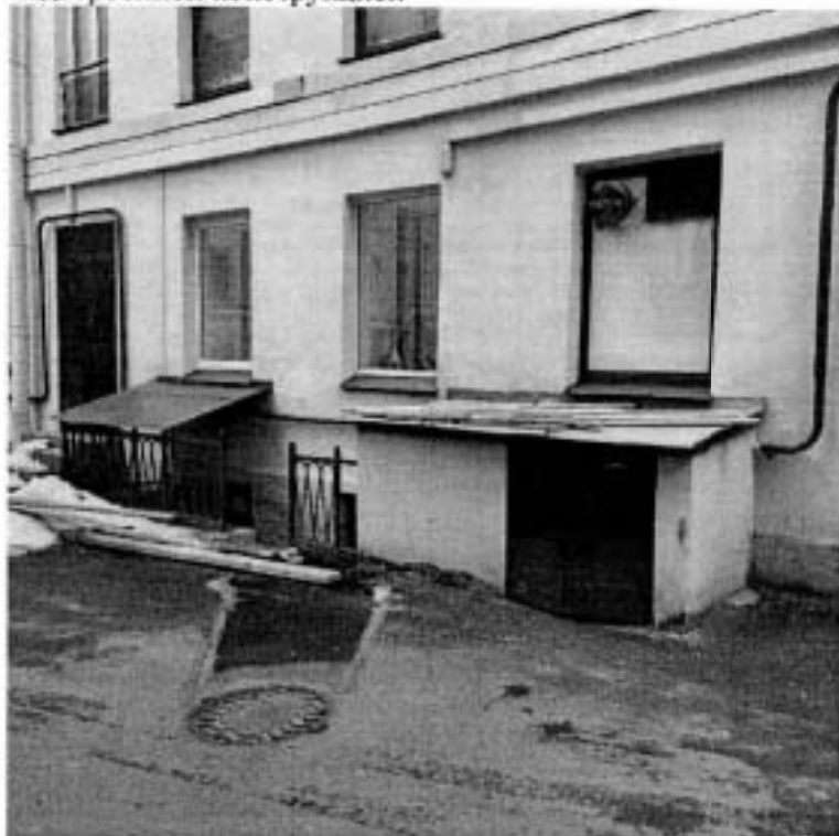
15. Фрагмент южного фасада. Прямо́к с кирпичной надстроенной конструкцией
