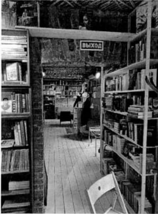
34. Помещение 35-Н. Устройство нового проема.
