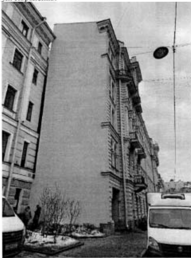
5. Брандмауэрный фасад со стороны ул. Короленко.
