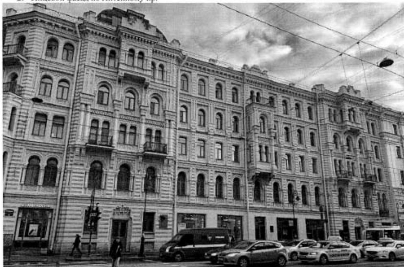
2. Лицевой фасад по Литейному пр.
