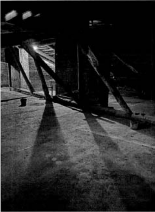
42. Устройство нового перекрытия над кв. 9.
