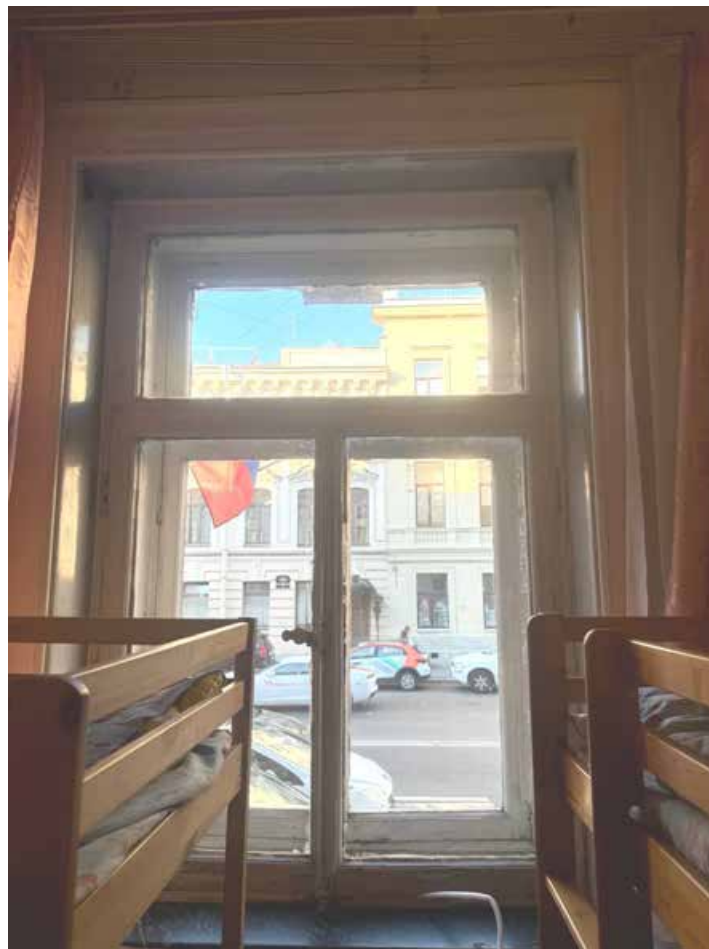
32. Объект культурного наследия «Дворец Великого Князя Кирилла Владимировича». Помещение первого этажа.
