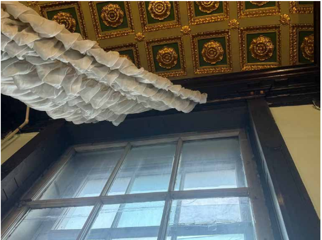
45. Объект культурного наследия «Дворец Великого Князя Кирилла Владимировича». Лестничная клетка на уровне второго этажа.
