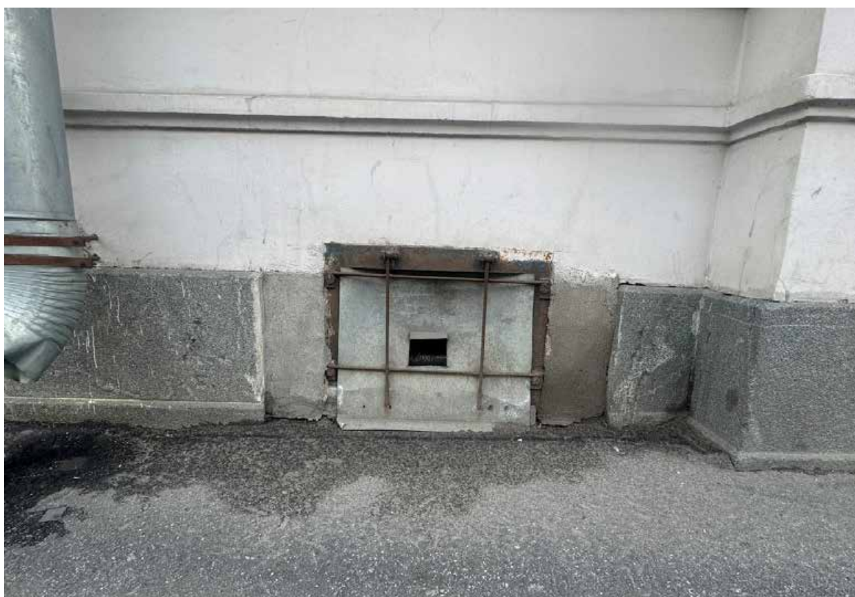
18. Объект культурного наследия «Дворец Великого Князя Кирилла Владимировича». Лицевой фасад. Фрагмент. Оконный проем цокольного этажа.
