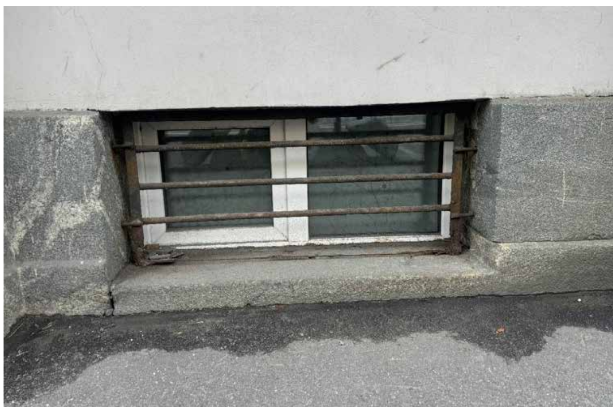
12. Объект культурного наследия «Дворец Великого Князя Кирилла Владимировича». Лицевой фасад. Фрагмент. Оконный проем цокольного этажа.
