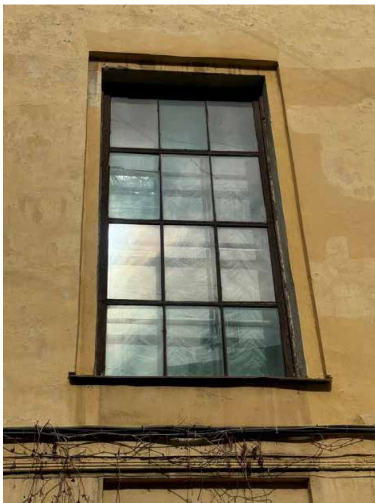
20. Объект культурного наследия «Дворец Великого Князя Кирилла Владимировича». Дворовый фасад. Фрагмент. Оконный проем.
