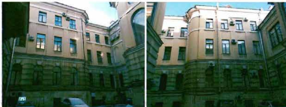
11, 12. Северный двор. Северный и южный фасад
