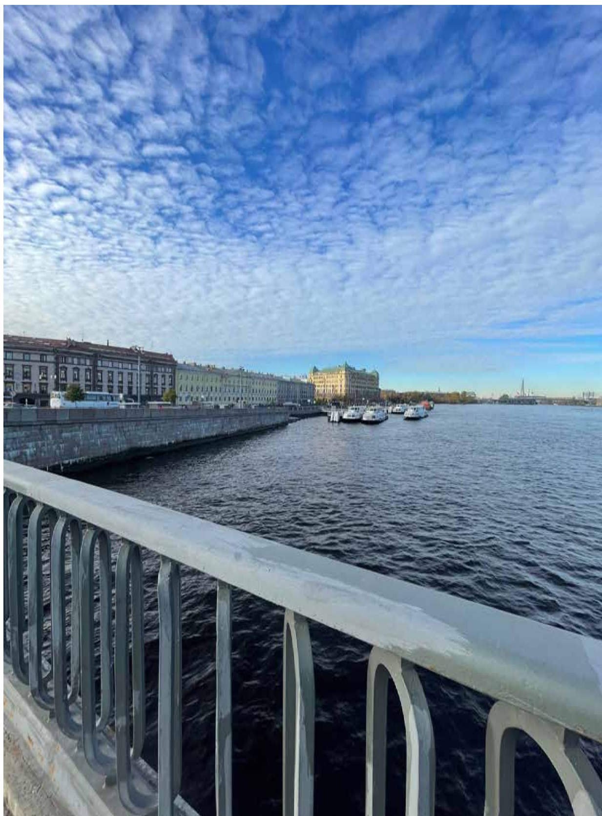
7. Общий вид спуска по адресу: г. Санкт-Петербург, участок набережной реки Малой Невы «Тучков мост – набережная реки Смоленки», литера Б, кадастровый номер 78:06:0201601:1009 (напротив дома 24 по наб. Макарова)
