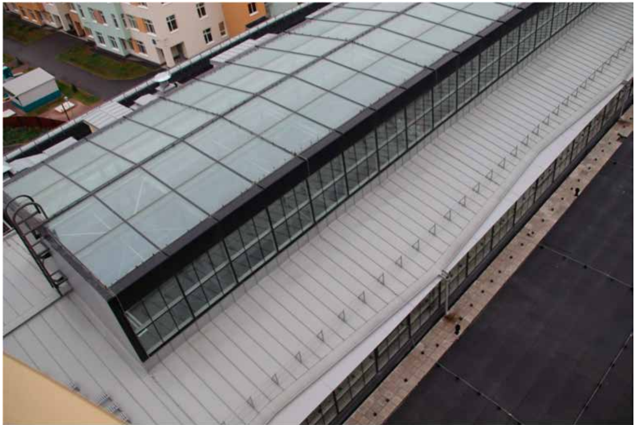
61. Объект культурного наследия регионального значения «Канатный цех с водонапорной башней завода «Красный гвоздильщик», расположенный по адресу: Санкт-Петербург, Василеостровский район, 25-я линия В.О., 6, корпус 1, литера Б Фрагмент крыши.
