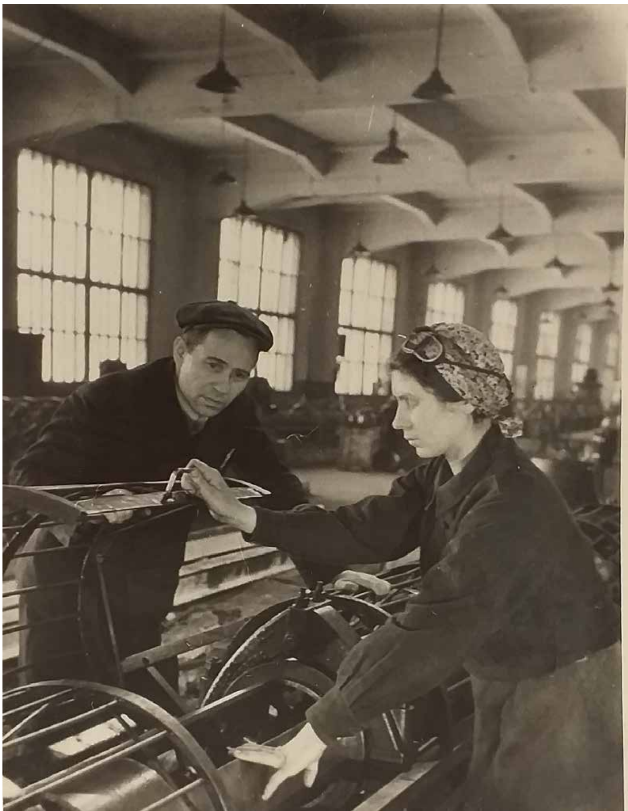
29. Сталепрокатный и проволочно-канатный завод им. Молотова выполняет заказы. Канатный цех. Направление съемки: север. 1951 г. ЦГАКФФД СПб. Ар 38545.
