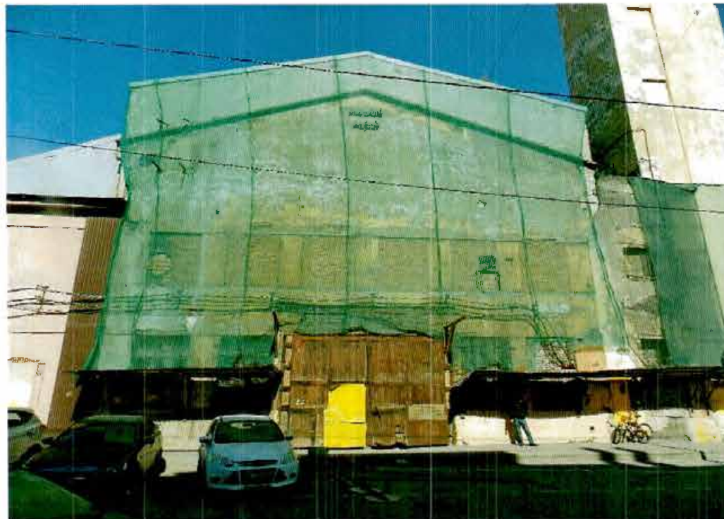
3. Вид на юго-восточный фасад.
