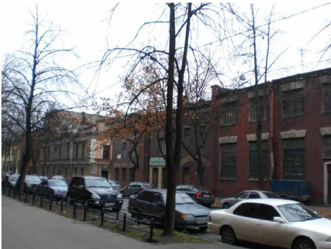
36. Панорама 25-й линии Васильевского острова. Постройки Сталепрокатного завода, снесенные осенью 2011 г. Фото 2010 г.
