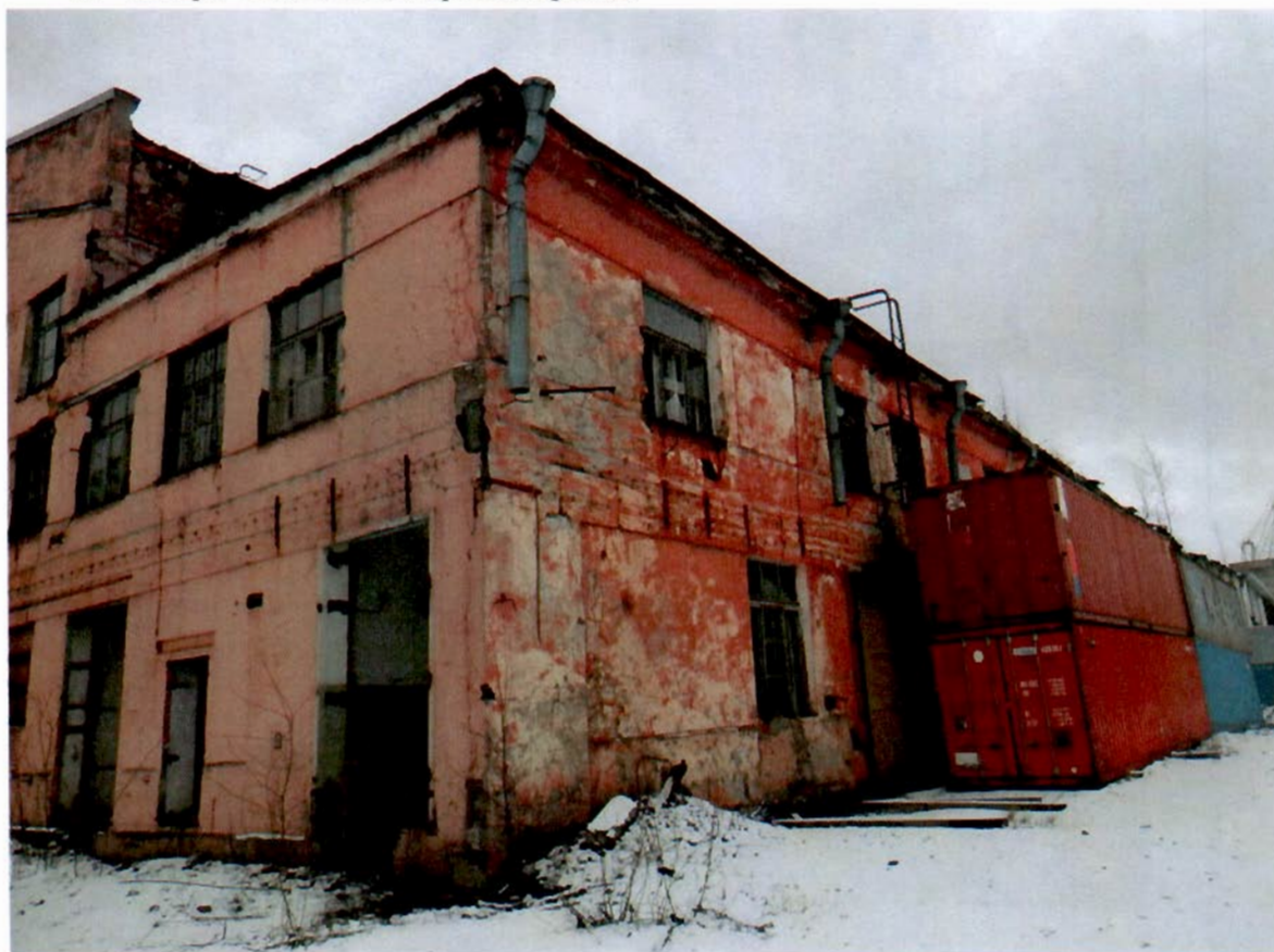
6. Северо-западный дворовый фасад
