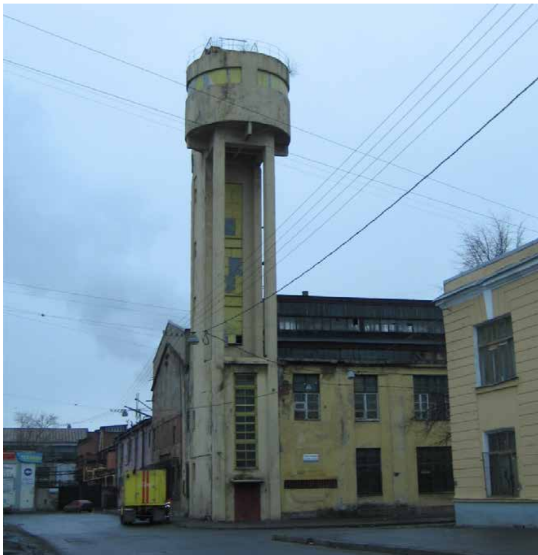
33. Канатный цех. Направление съемки: север. 2008 г.
