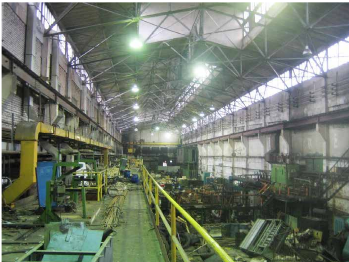
32. Канатный цех. Направление съемки: юг. 2008 г.
