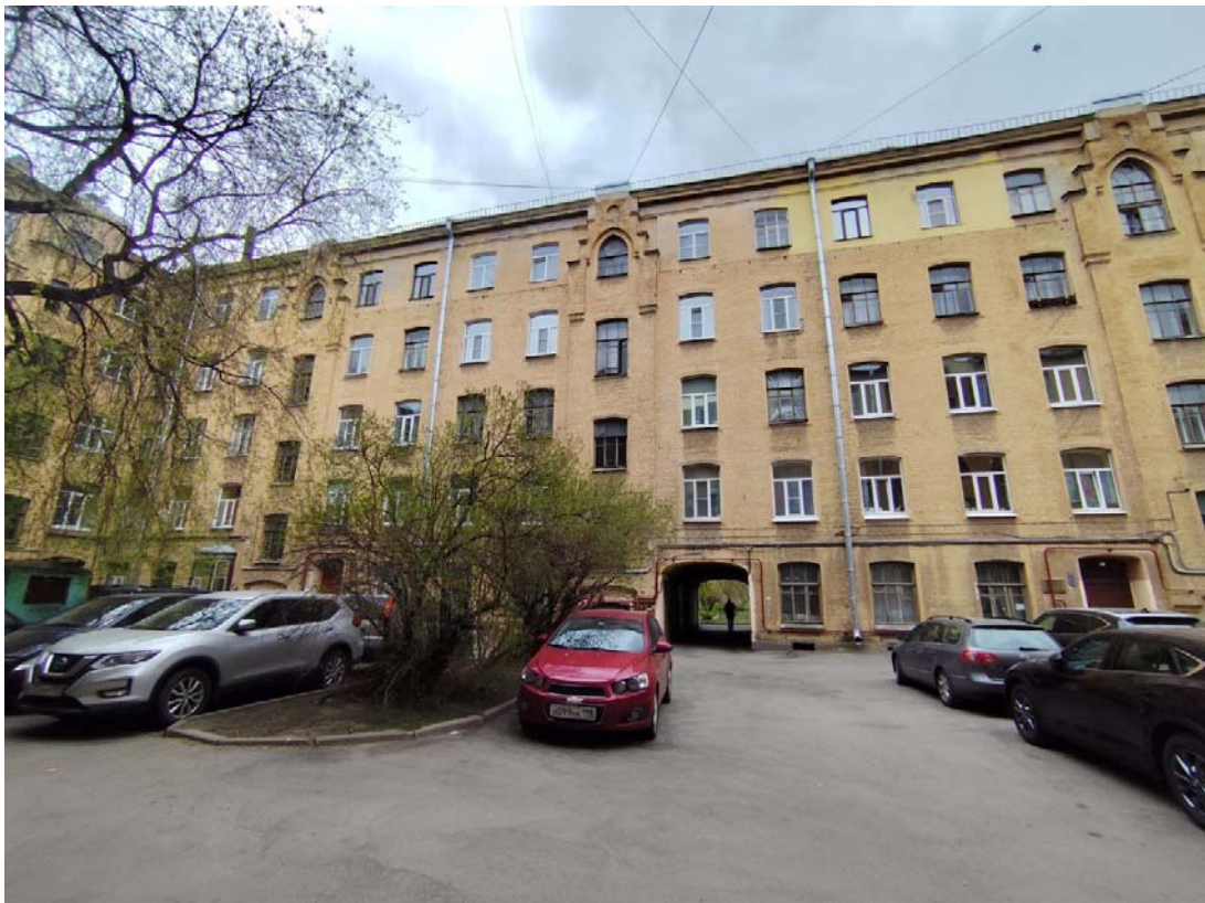
Фото 7. Северо-западный дворовый фасад дворового корпуса.
