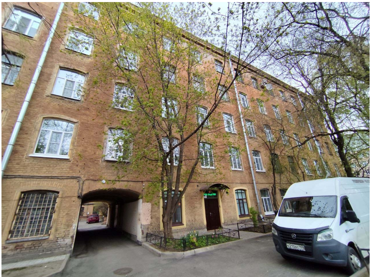
Фото 10. Юго-восточный фасад дворового корпуса.
