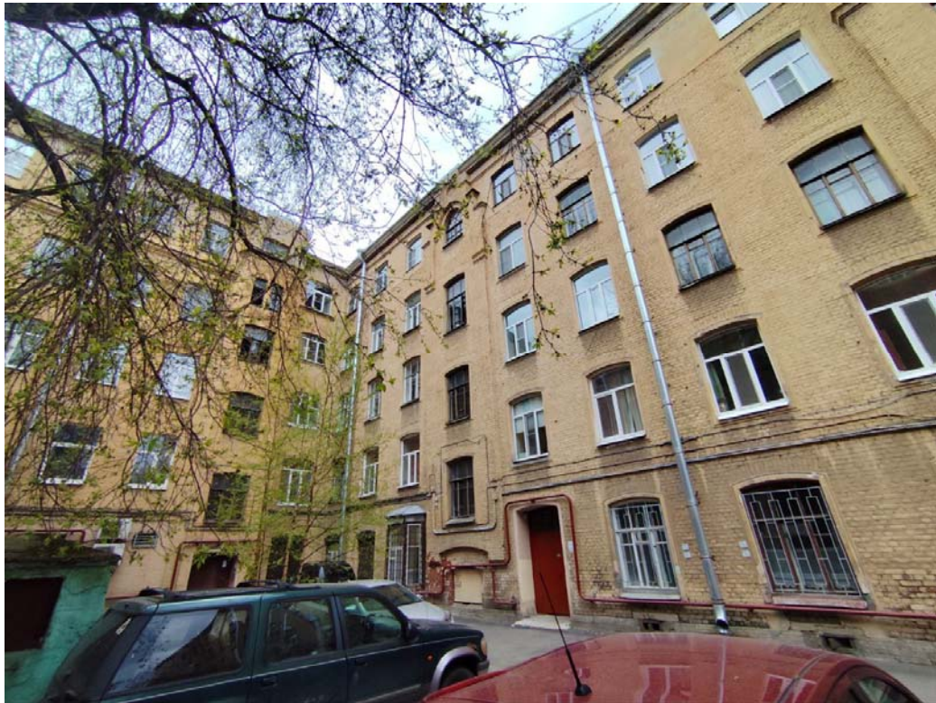
Фото 6. Дворовые фасады, общий вид.
