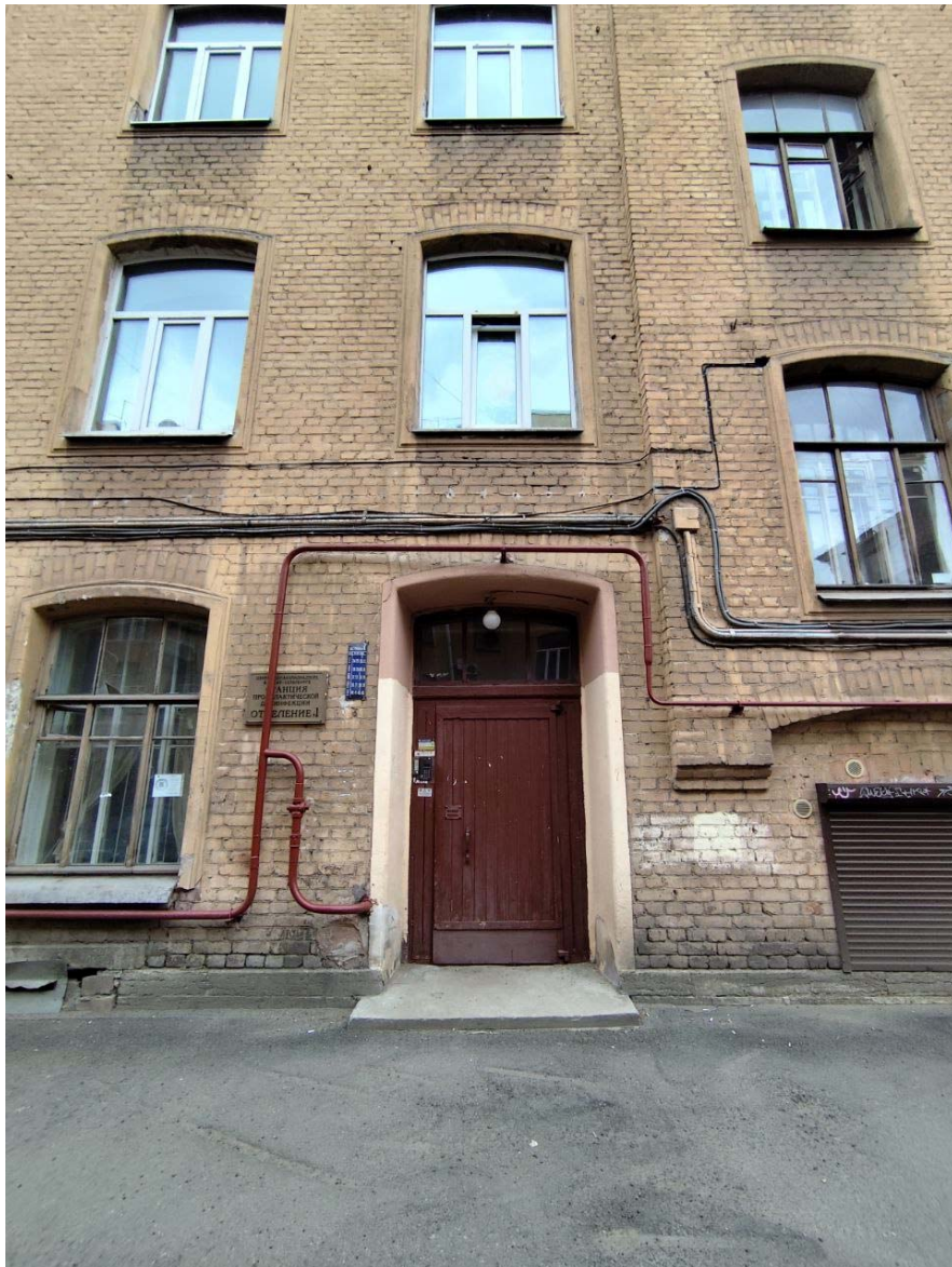
Фото 12. Вход в подзем.
