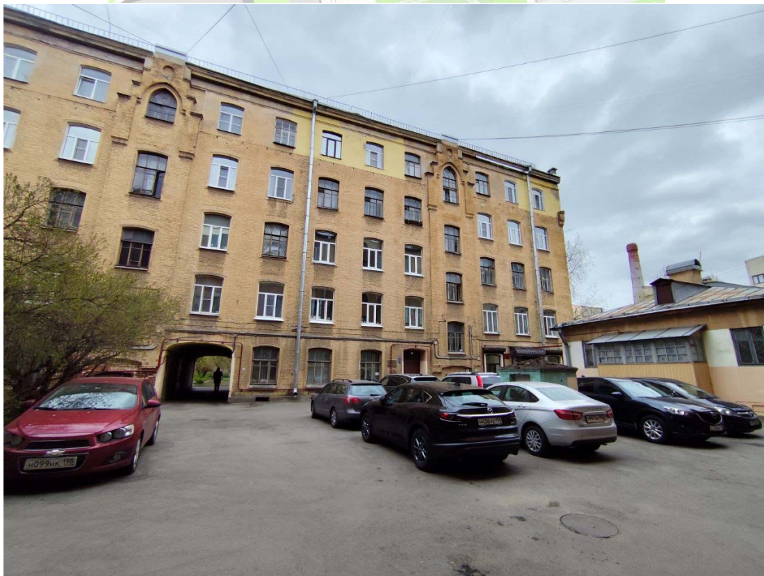
Фото 8. Северо-западный дворовый фасад дворового корпуса.
