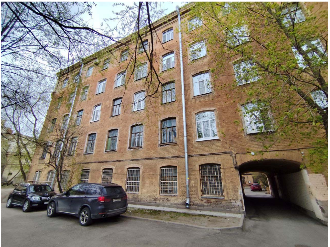
Фото 9. Юго-восточный фасад дворового корпуса.
