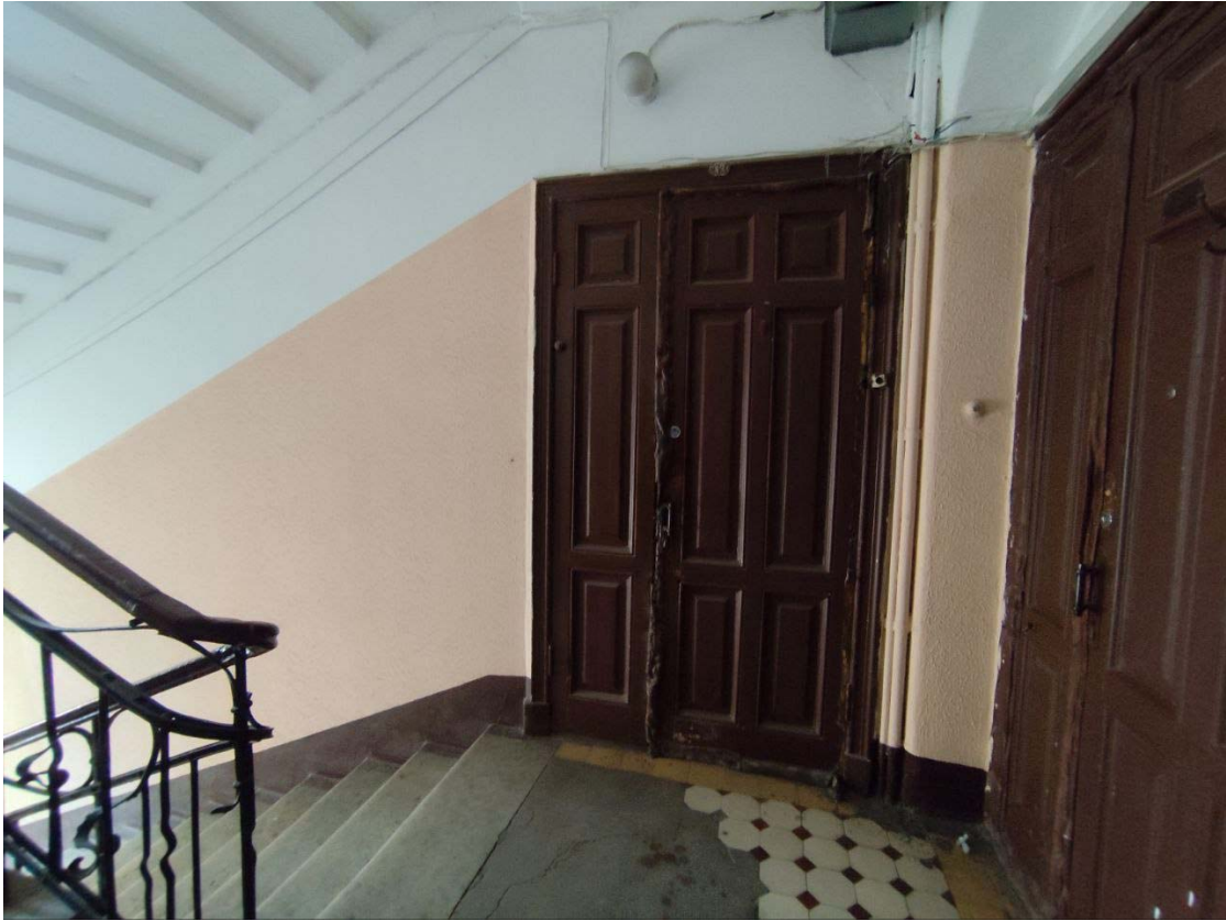
Фото 15. 3 этаж, вход в квартиру №32.
