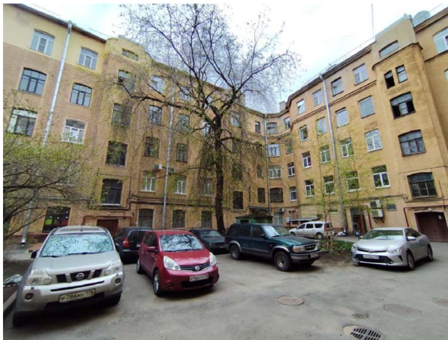
Фото 5. Дворовые фасады, общий вид.
