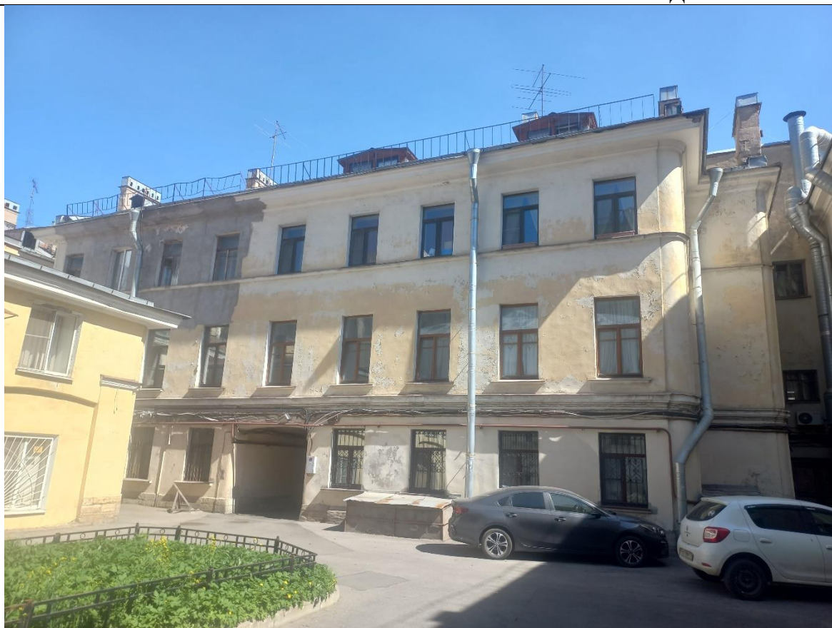
Фото № 6. Объект культурного наследия регионального значения «Дом М.Х. Усовой», расположенный по адресу г. Санкт-Петербург, линия 13-я В.О., дом 2/19, литера А. Двор.
