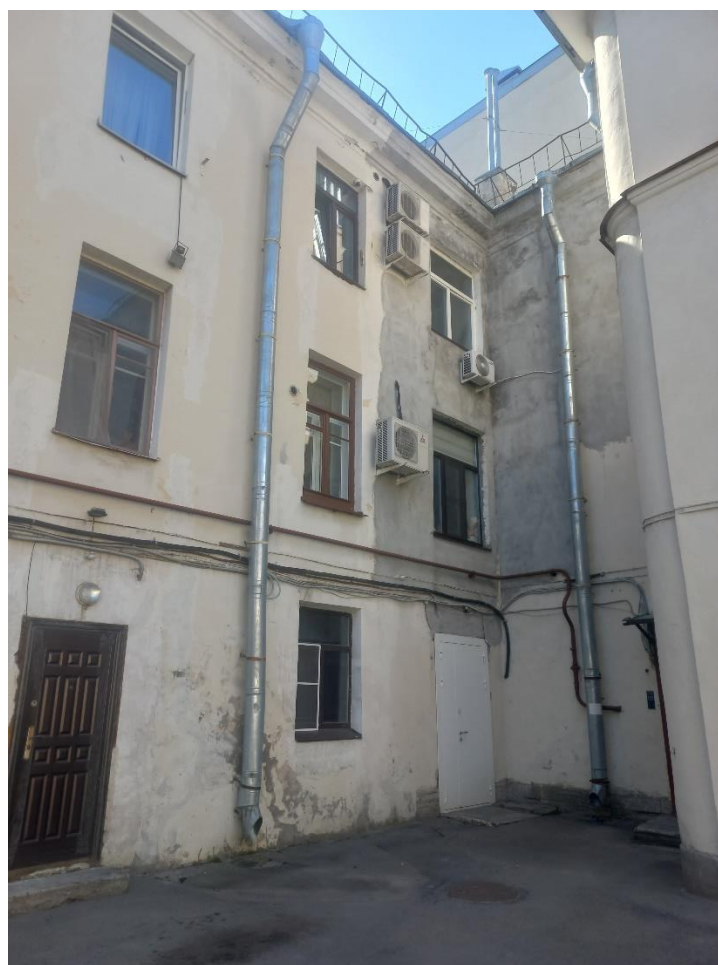
Фото №8. Объект культурного наследия регионального значения «Дом М.Х. Усовой», расположенный по адресу г. Санкт-Петербург, линия 13-я В.О., дом 2/19, литера А. Двор
