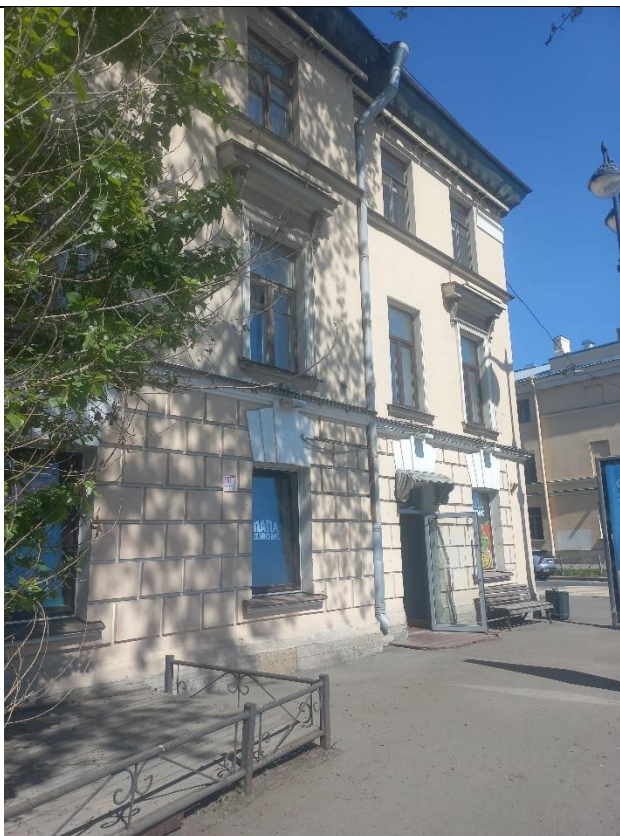
Фото №3. Объект культурного наследия регионального значения «Дом М.Х. Усовой», расположенный по адресу г. Санкт-Петербург, линия 13-я В.О., дом 2/19, литера А. Со стороны набережной лейтенанта Шмидта
