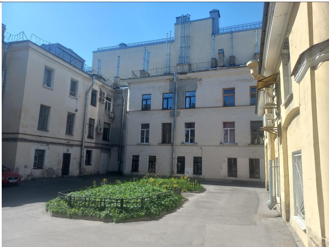
Фото № 5. Объект культурного наследия регионального значения «Дом М.Х. Усовой», расположенный по адресу г. Санкт-Петербург, линия 13-я В.О., дом 2/19, литера А. Двор.
