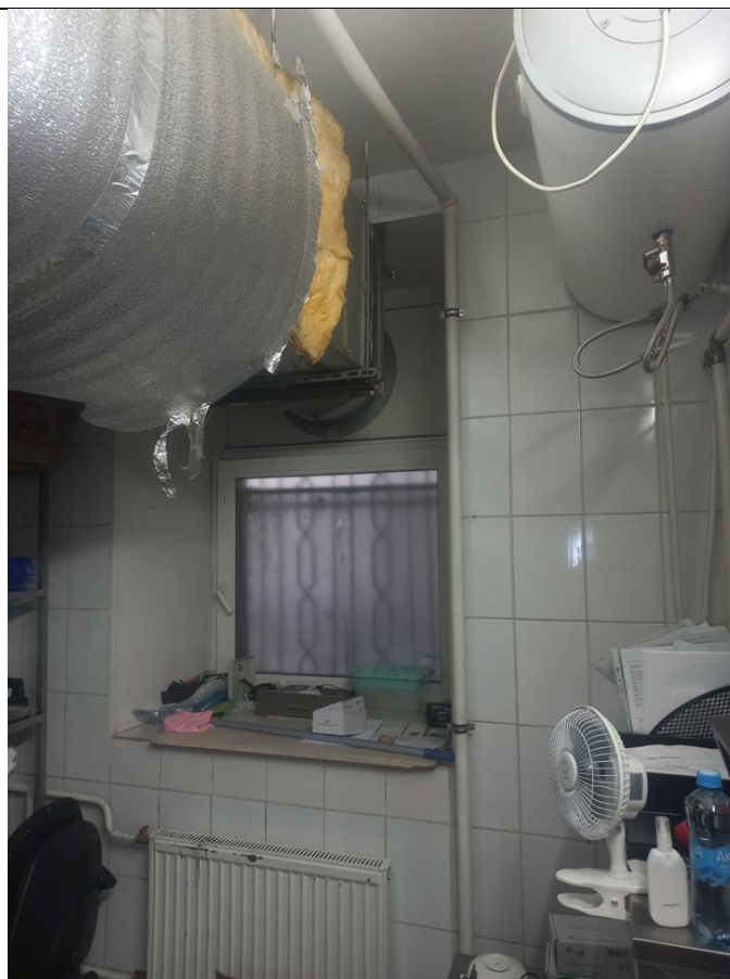
Фото №20. Объект культурного наследия регионального значения «Дом М.Х. Усовой», расположенный по адресу г. Санкт-Петербург, линия 13-я В.О., дом 2/19, литера А. Подсобное помещение
