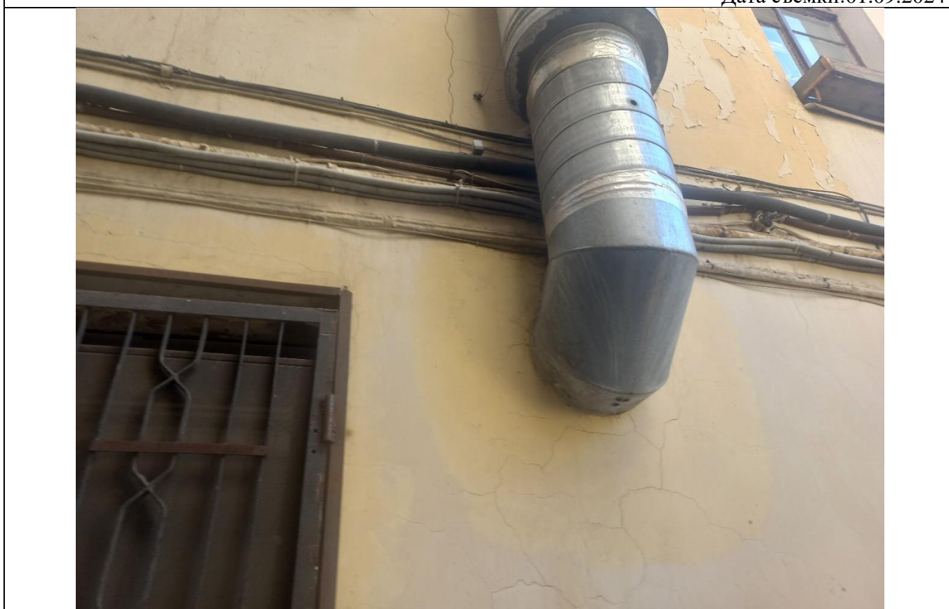
Фото № 10. Объект культурного наследия регионального значения «Дом М.Х. Усовой», расположенный по адресу г. Санкт-Петербург, линия 13-я В.О., дом 2/19, литера А.
