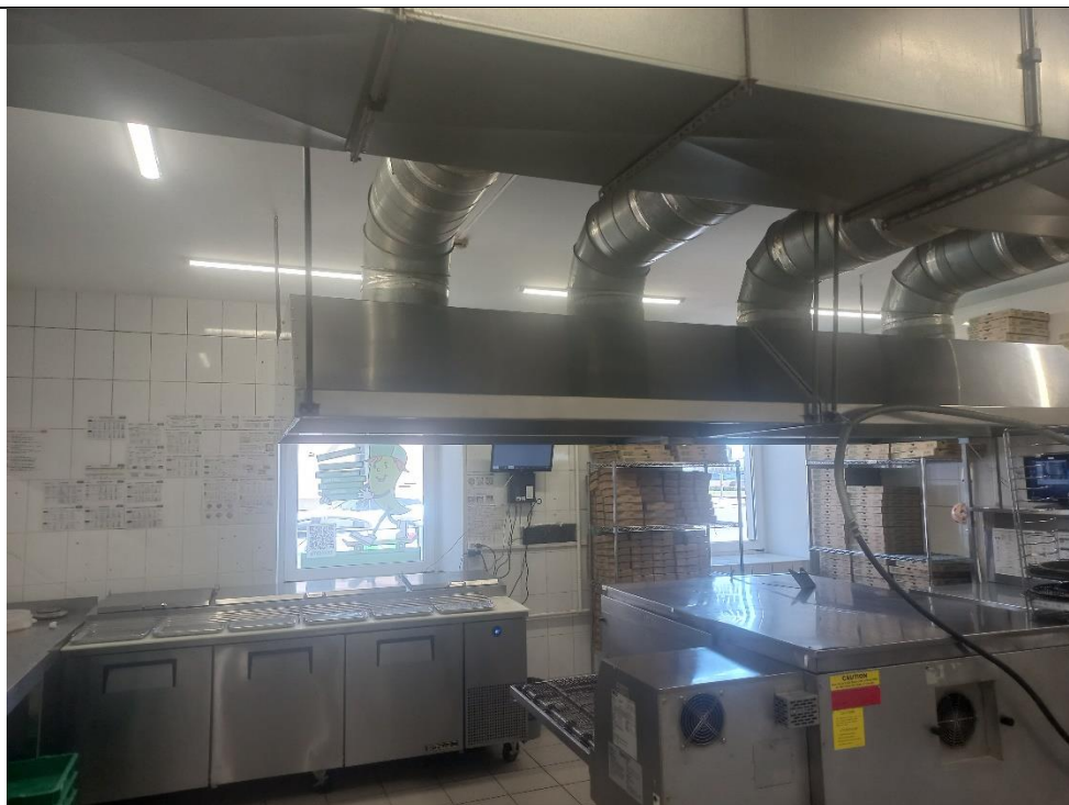
Фото №19. Объект культурного наследия регионального значения «Дом М.Х. Усовой», расположенный по адресу г. Санкт-Петербург, линия 13-я В.О., дом 2/19, литера А. Помещение кухни.
