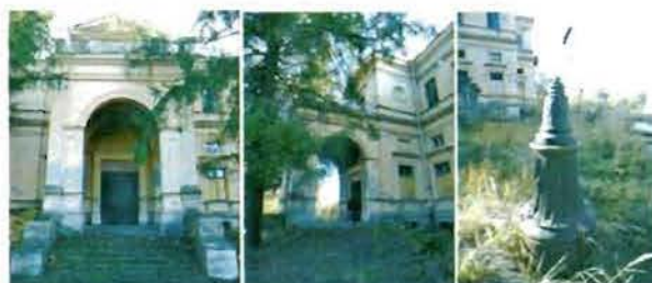
Главный подъезд Большого дворца. Тумба фонаря. Фотография. 2015
