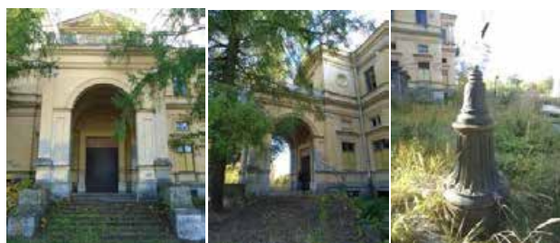
Главный подъезд Большого дворца. Тумба фонаря. Фотография. 2015
