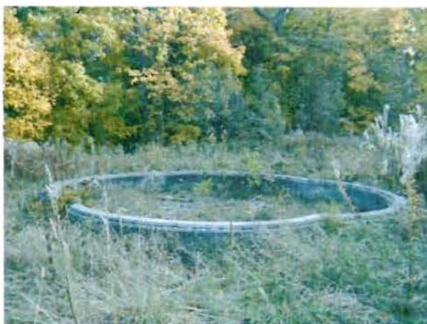
Бассейн фонтана. Фотография. 2015
